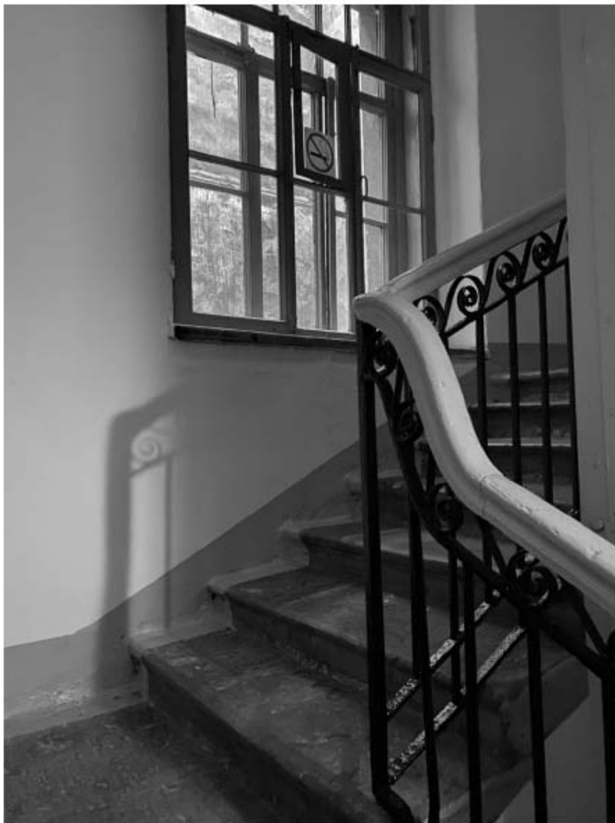
60. Общий вид лестницы 4ЛК в уровне 3-го этажа
