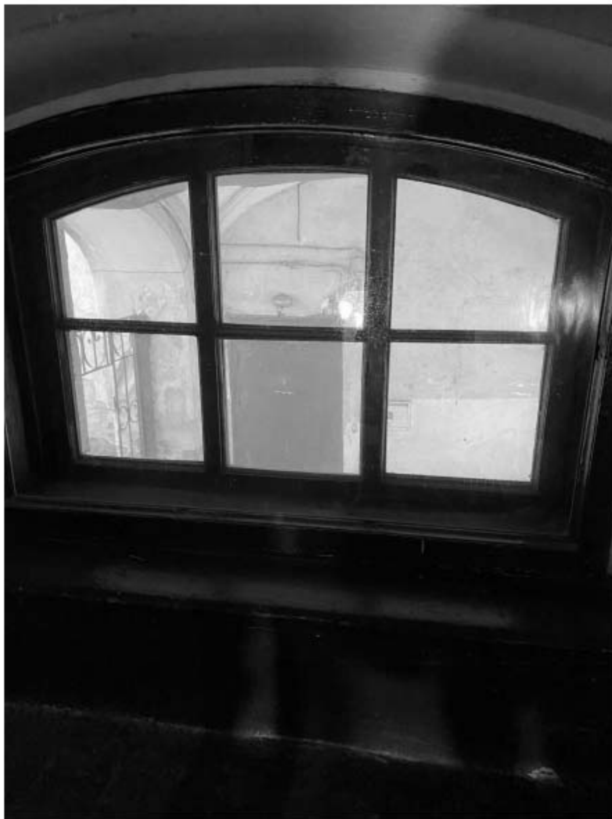
70. Оконное заполнение лестницы 5ЛК в уровне 1-го этажа
