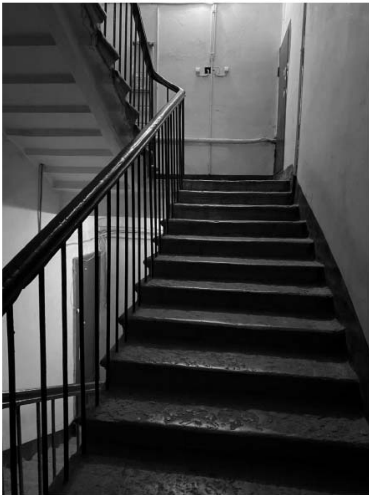
79. Общий вид лестницы 5ЛК в уровне 4-го этажа
