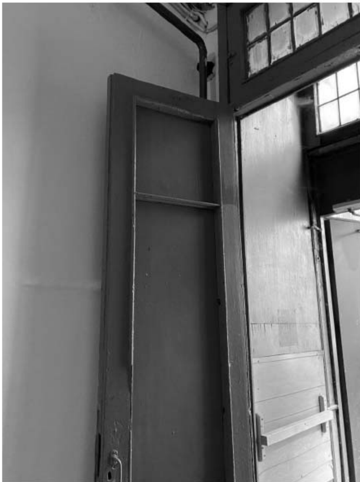
52. Фрагмент дверного заполнения тамбура лестницы 4ЛК
