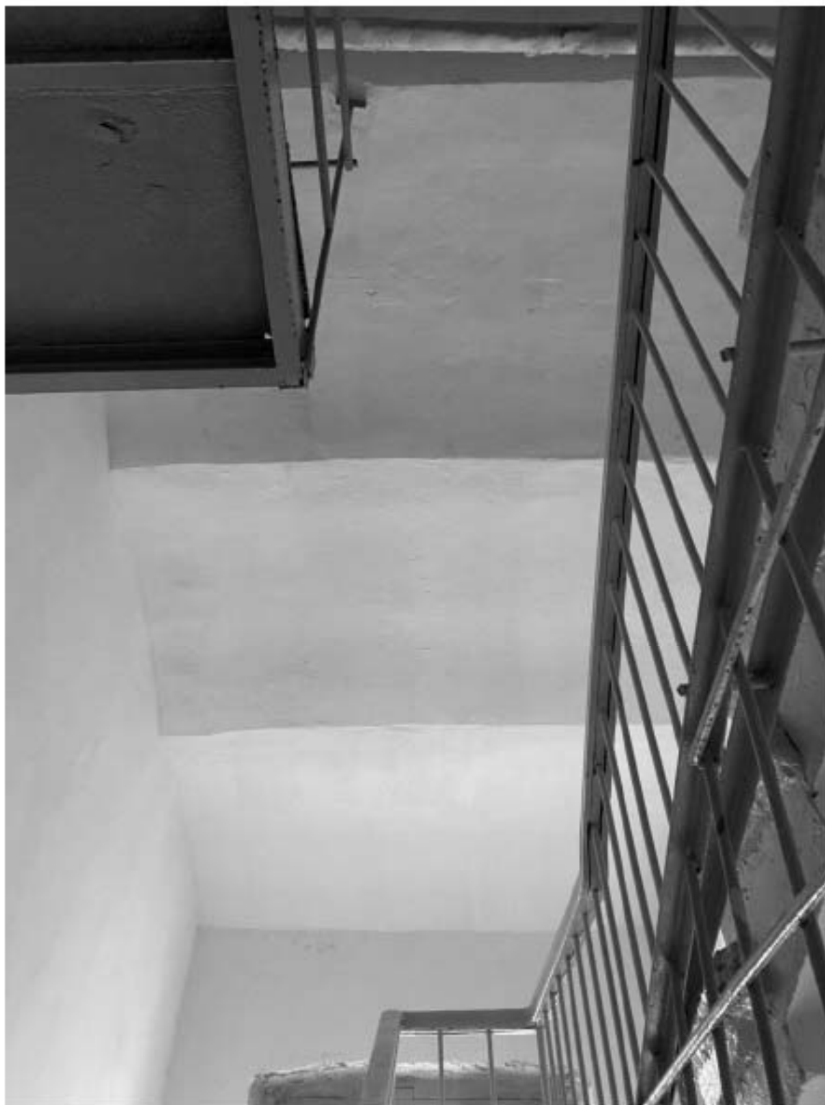
96. Перекрытие лестницы 6ЛК в уровне 5-го этажа
