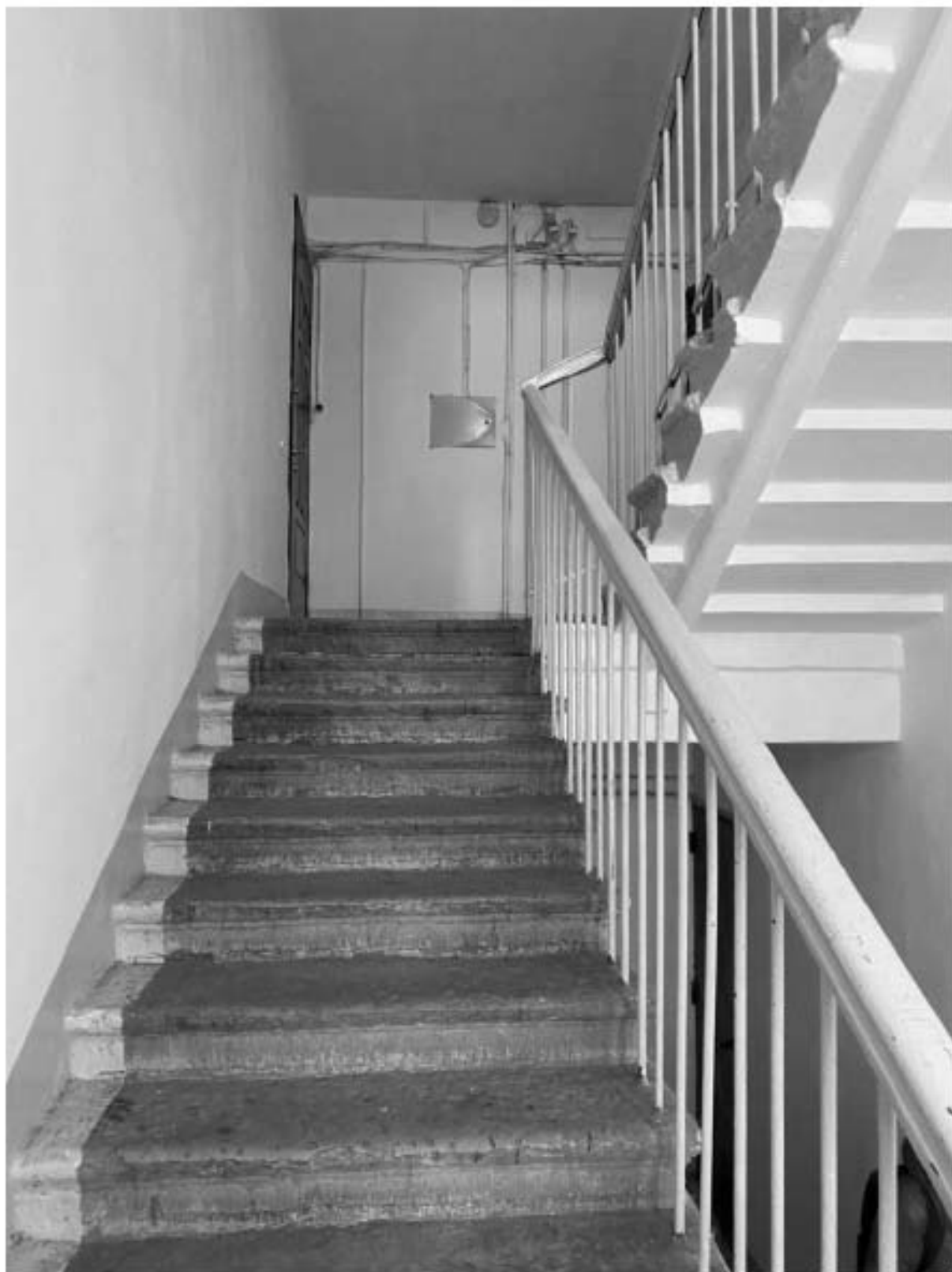
89. Общий вид лестницы 6ЛК в уровне 2-го этажа
