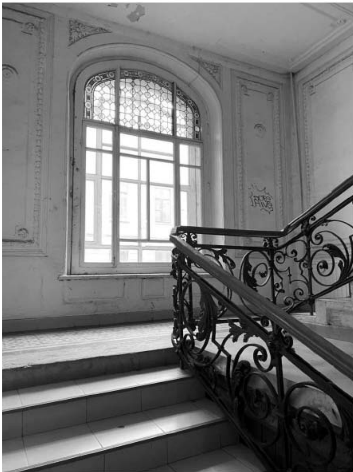
20. Общий вид лестницы 1ЛК в уровне 1-го этажа
