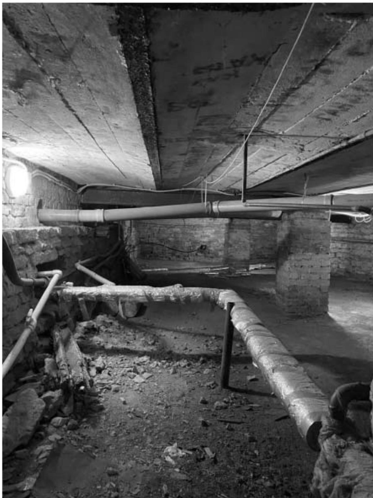
68. Общий вид подвального помещения
