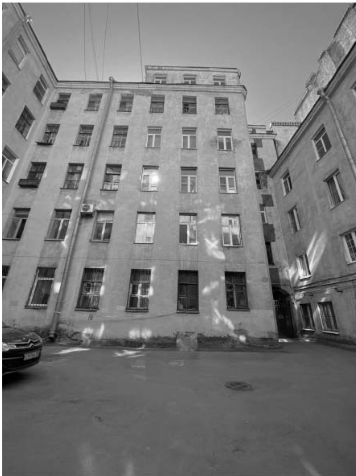
16. Фрагмент дворовых фасадов объекта культурного наследия
