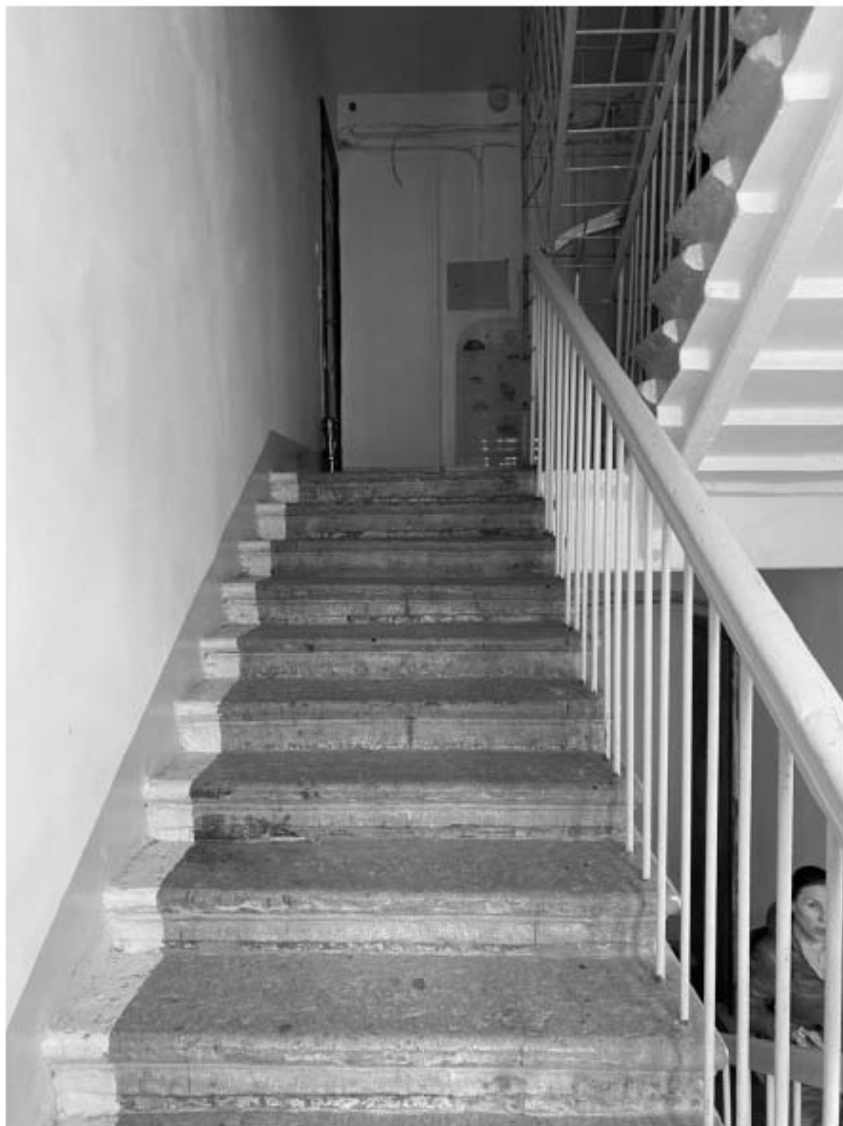
94. Общий вид лестницы 6ЛК в уровне 5-го этажа
