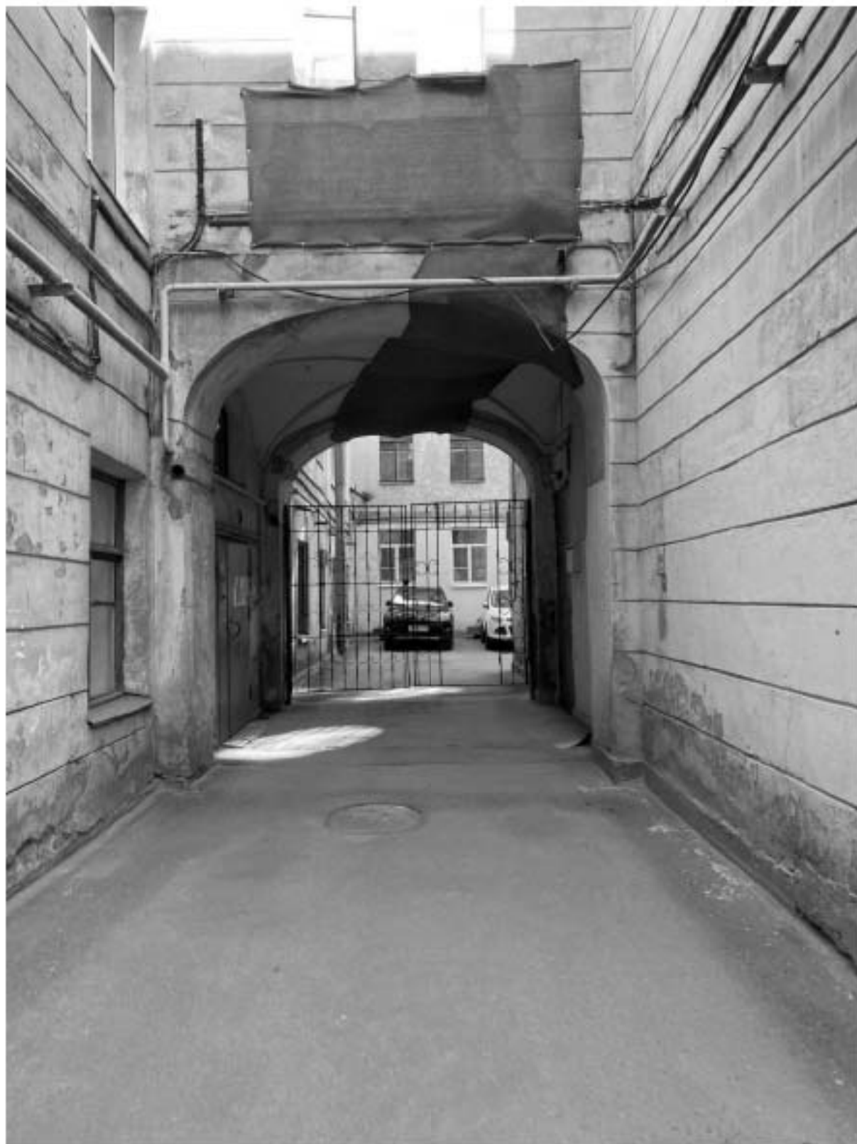
13. Фрагмент дворовых фасадов объекта культурного наследия
