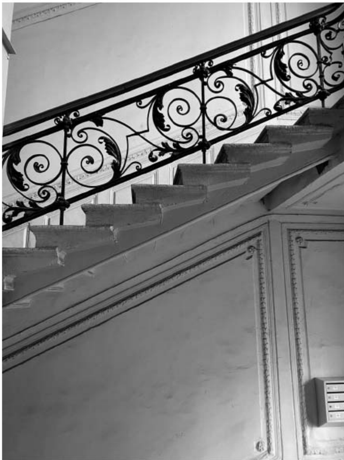
25. Ограждение лестницы 1ЛК в уровне 2-го этажа
