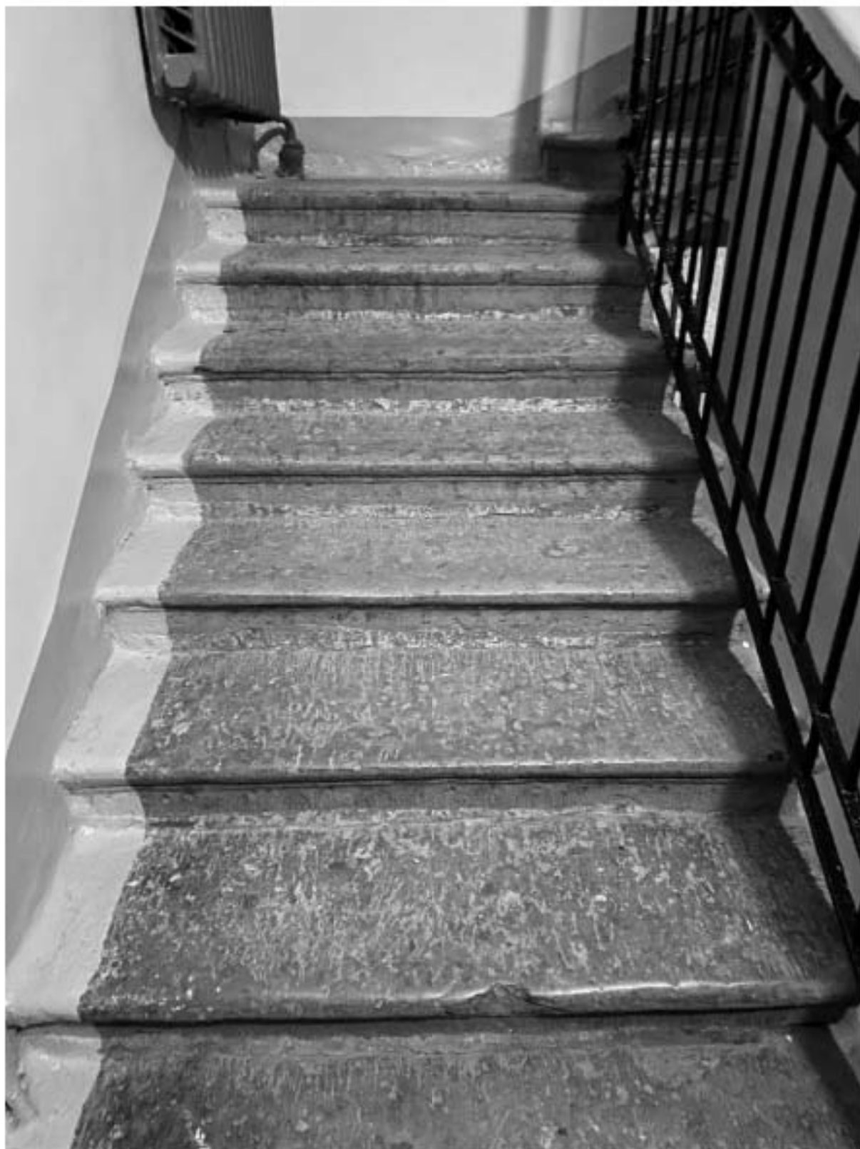
59. Общий вид лестницы 4ЛК в уровне 3-го этажа
