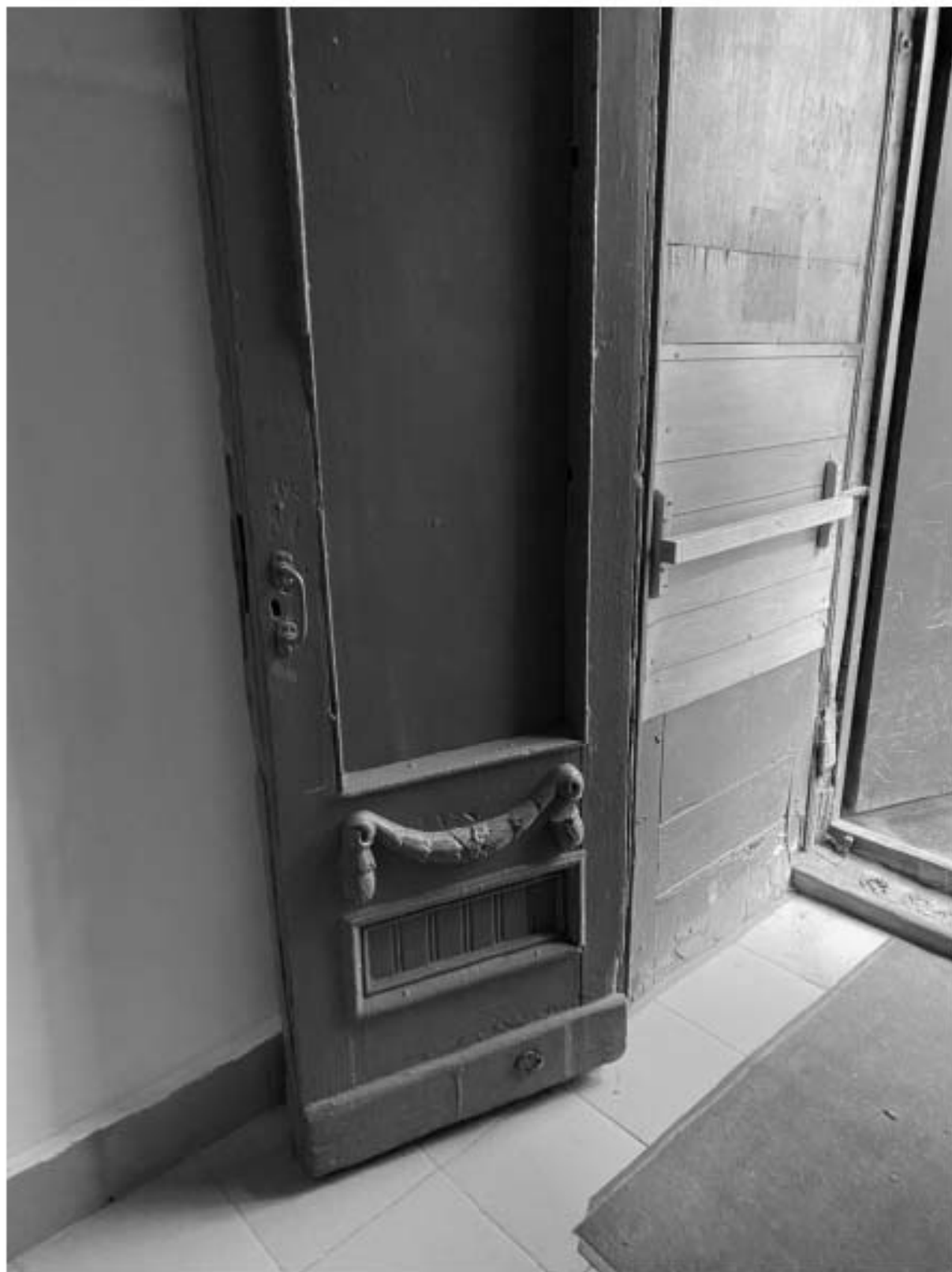
51. Фрагмент дверного заполнения тамбура лестницы 4ЛК
