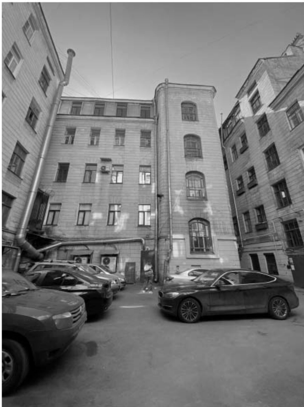
11. Фрагмент дворовых фасадов объекта культурного наследия
