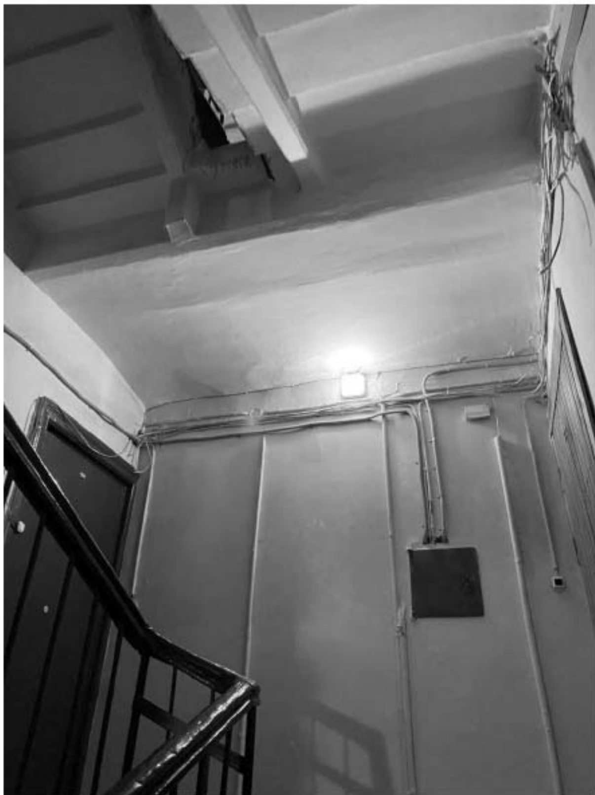
77. Перекрытие лестницы 5ЛК в уровне 3-го этажа
