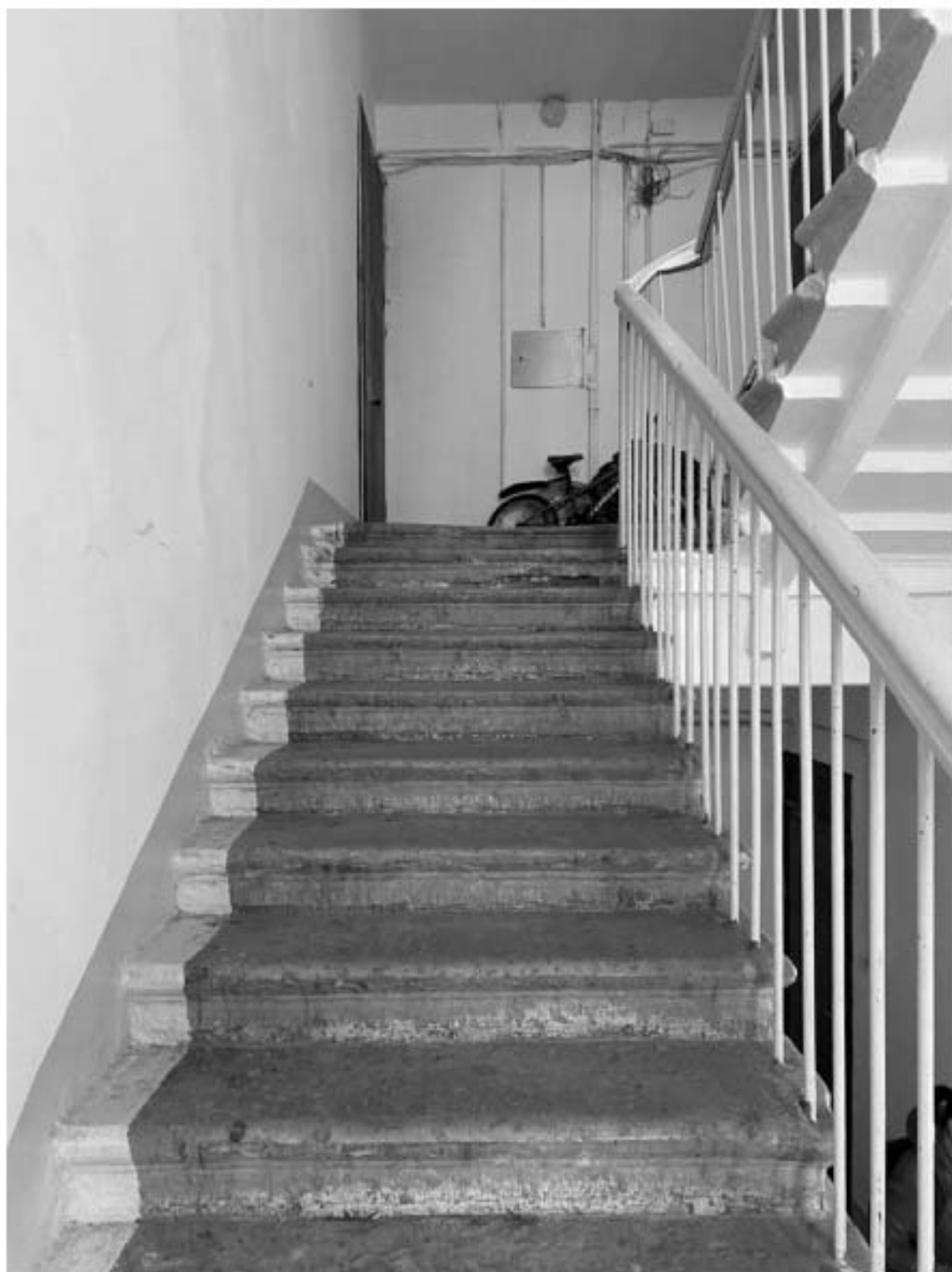
91. Общий вид лестницы БЛК в уровне 3-го этажа
