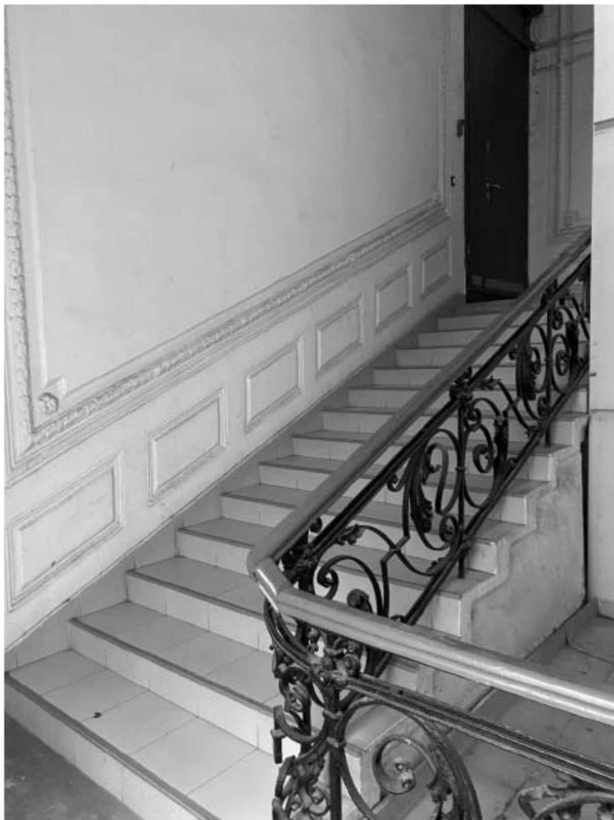
23. Общий вид лестницы 1ЛК в уровне 1-го этажа
