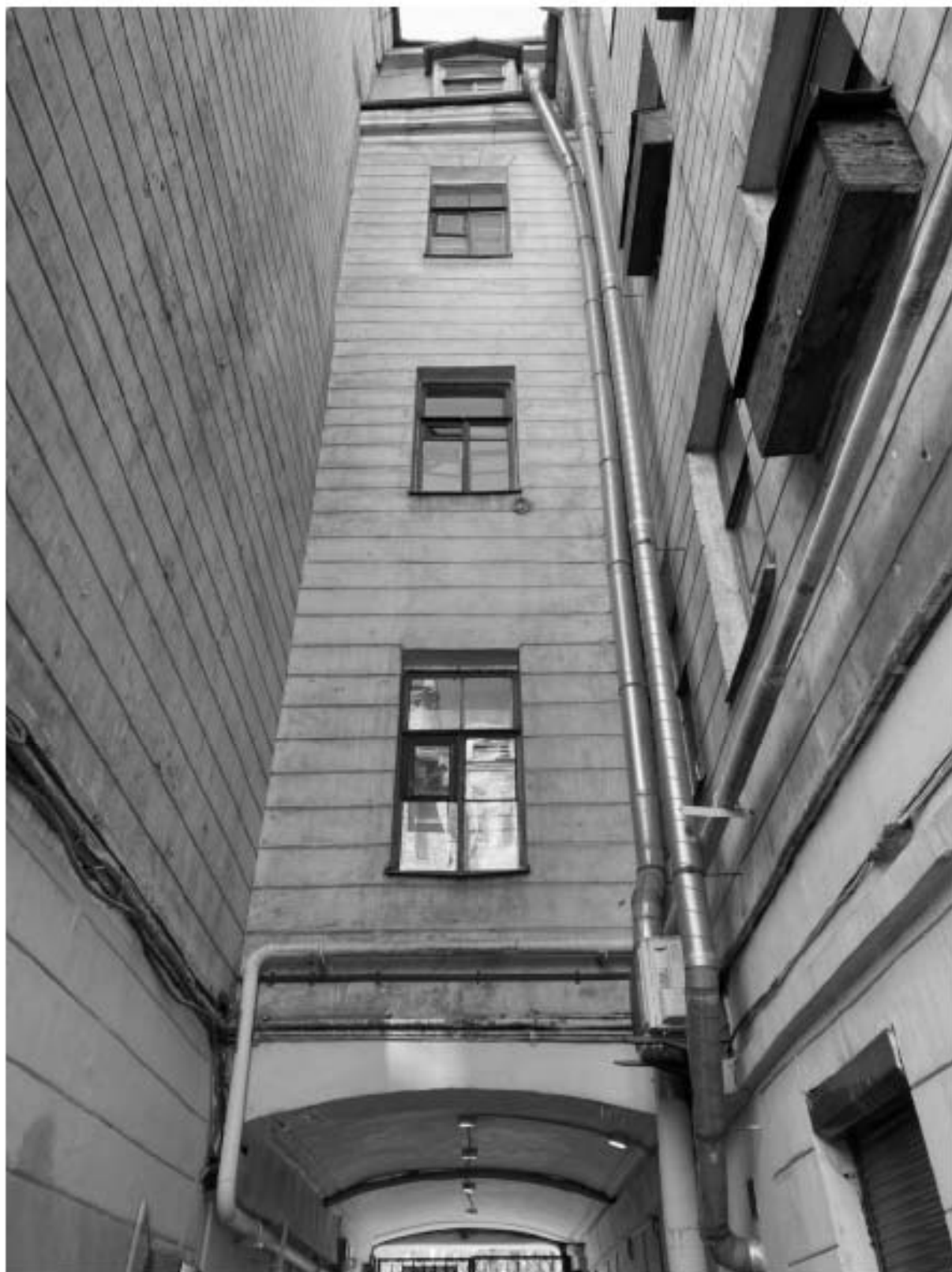
9. Фрагмент дворовых фасадов объекта культурного наследия
