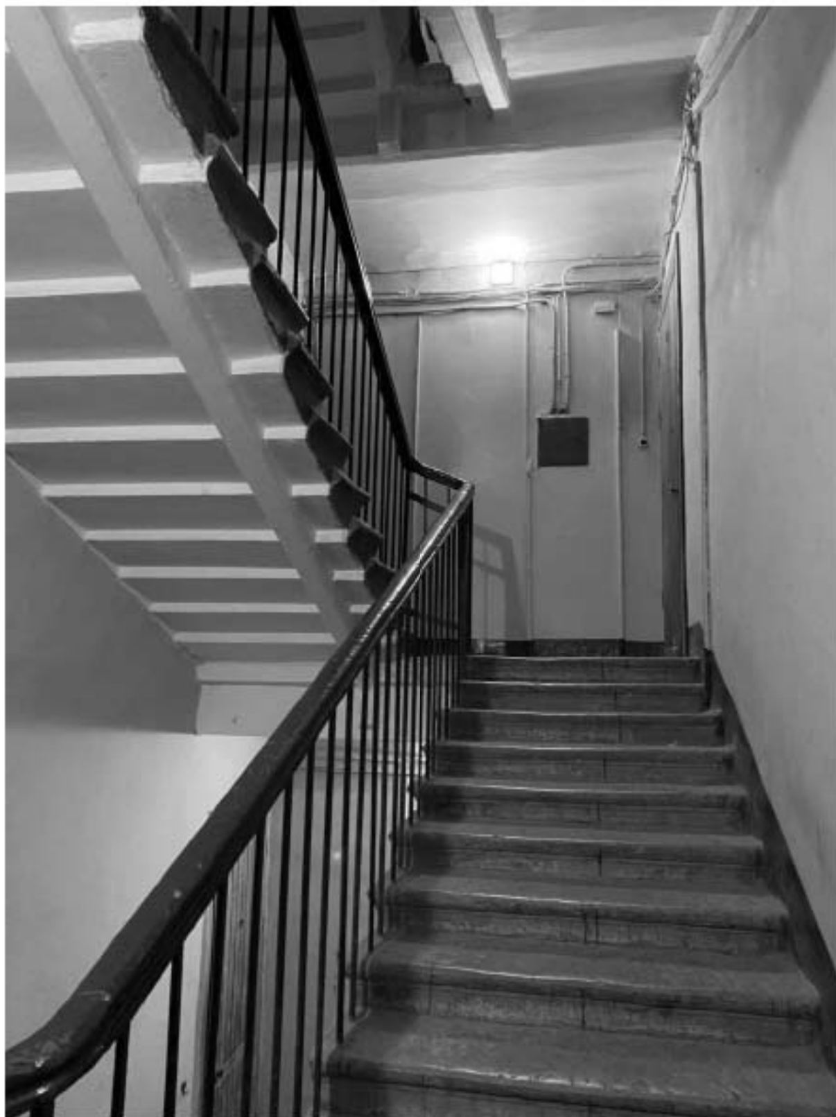
76. Общий вид лестницы 5ЛК в уровне 3-го этажа
