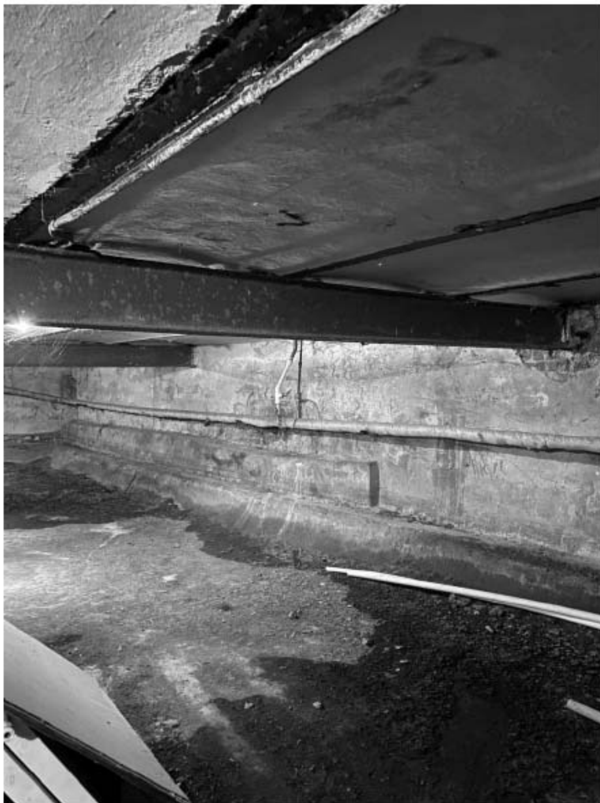
33.Общий вид подвального помещения
