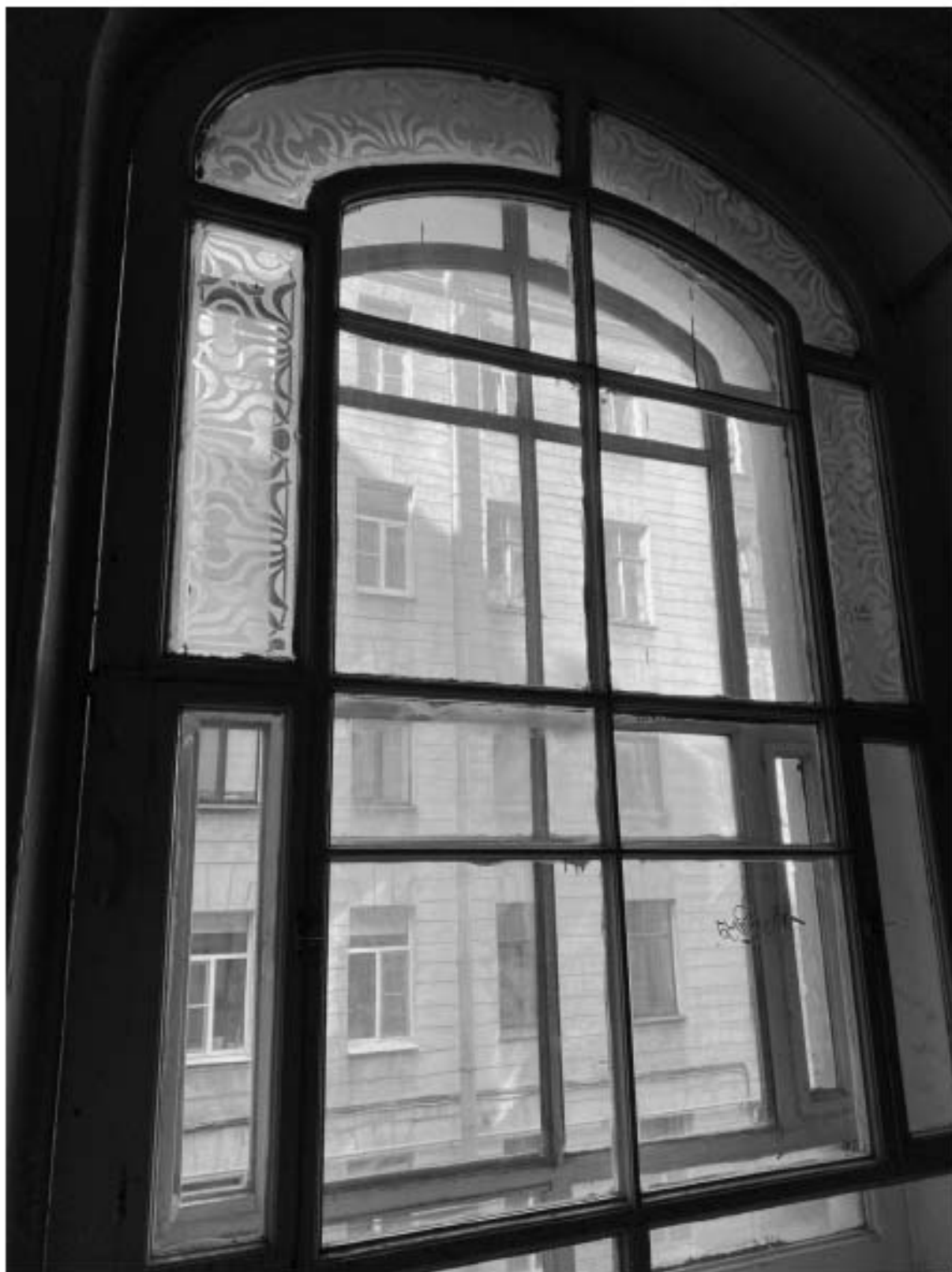
27. Оконное заполнение лестницы 1ЛК в уровне 2-го этажа
