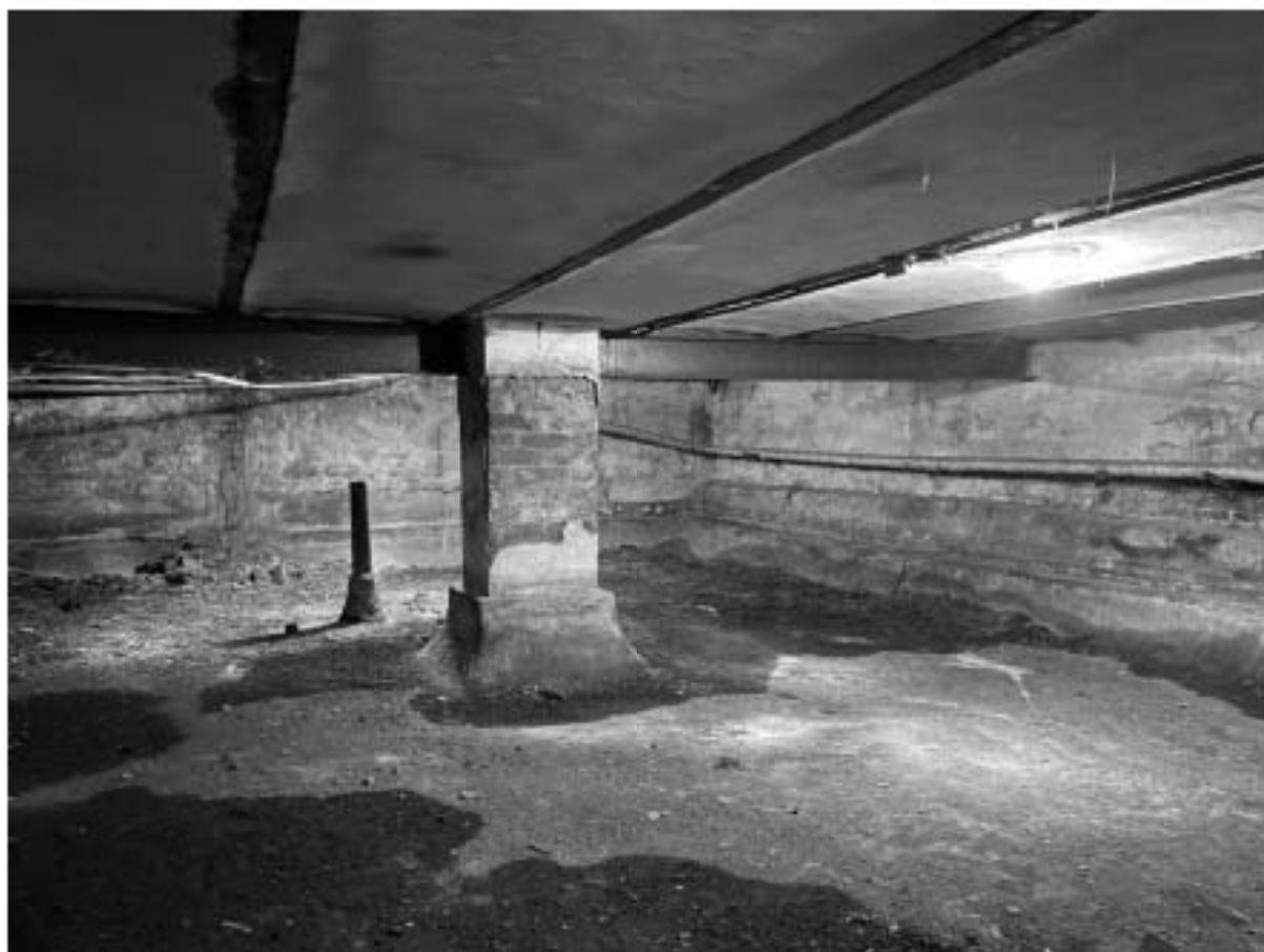
34.Общий вид подвального помещения
