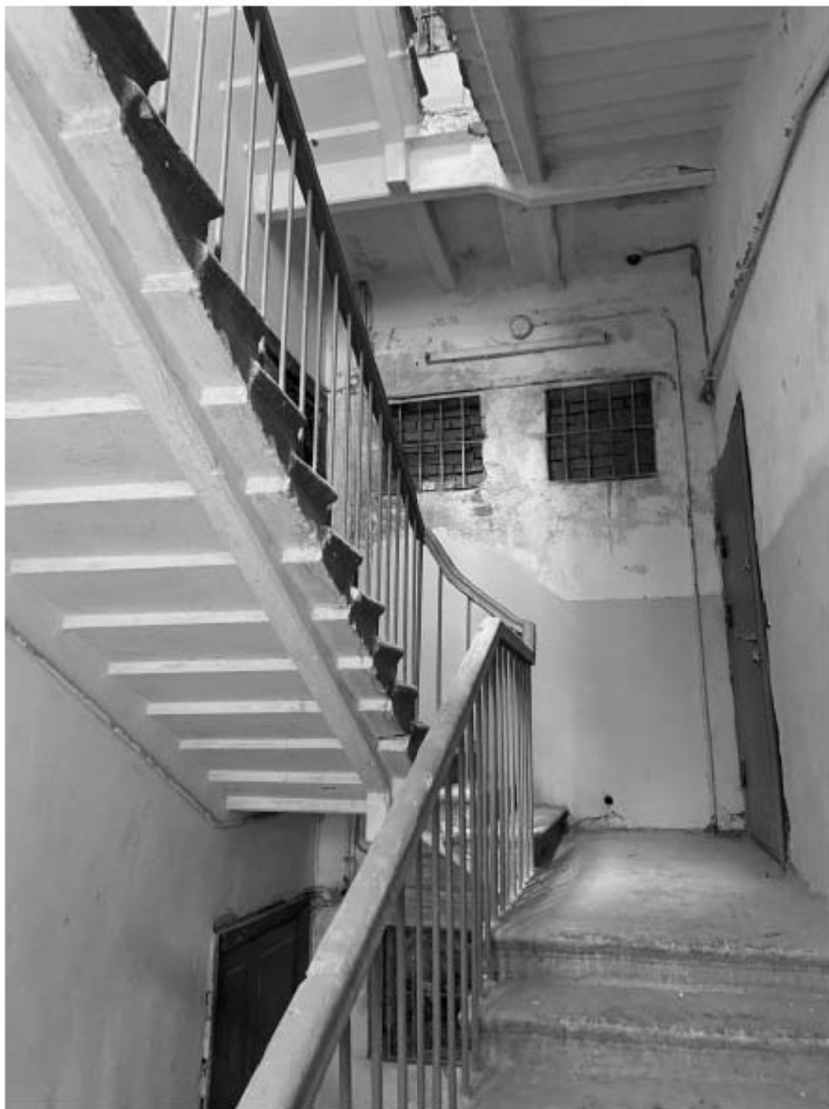
37. Общий вид лестницы ЗЛК в уровне 2-го этажа
