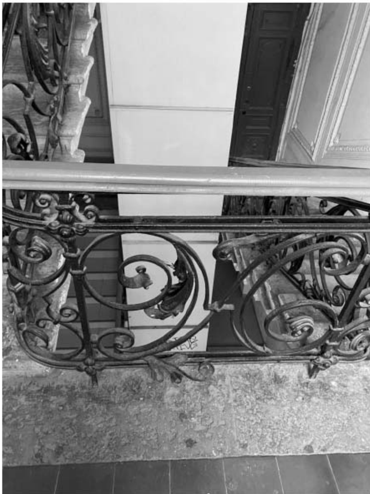
29. Фрагмент ограждения лестницы 1ЛК в уровне 3-го этажа
