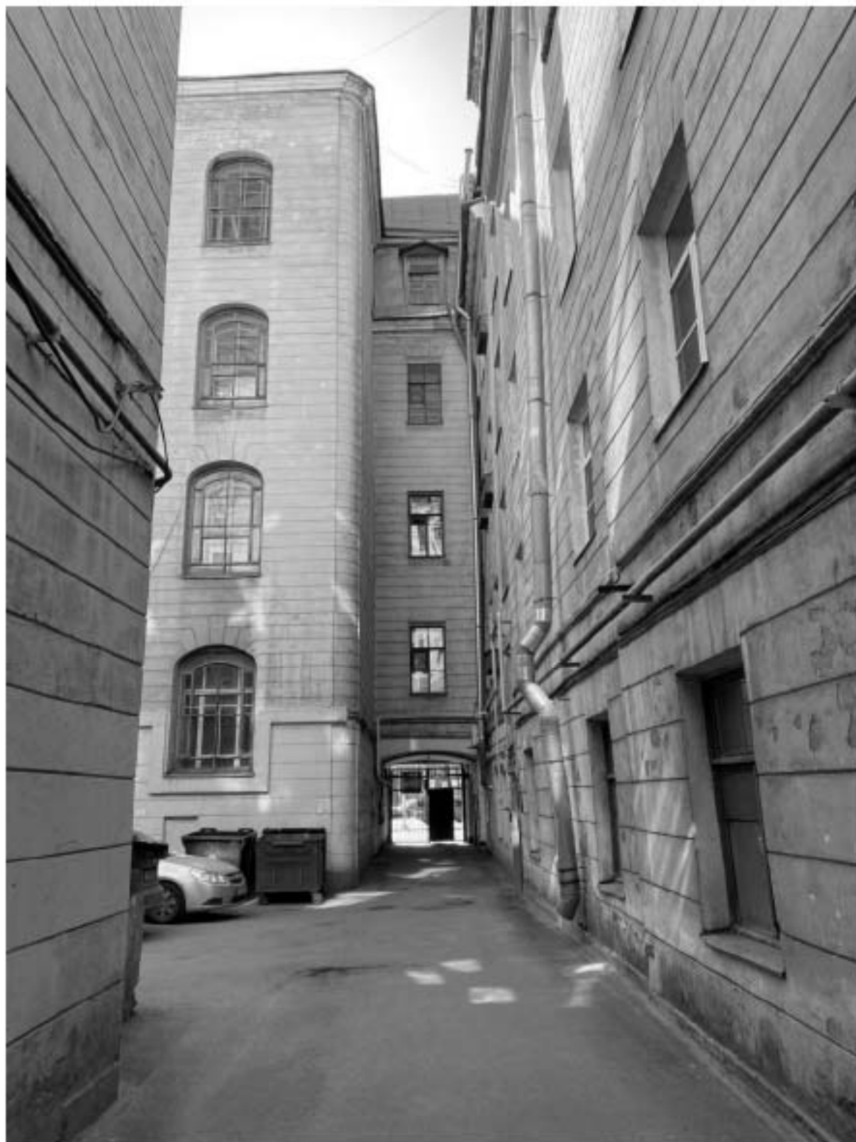
17. Фрагмент дворовых фасадов объекта культурного наследия
