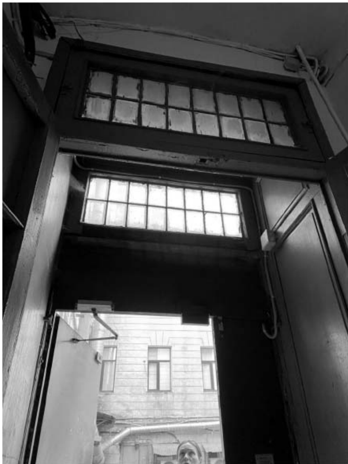
53. Фрагмент дверного заполнения тамбура лестницы 4ЛК
