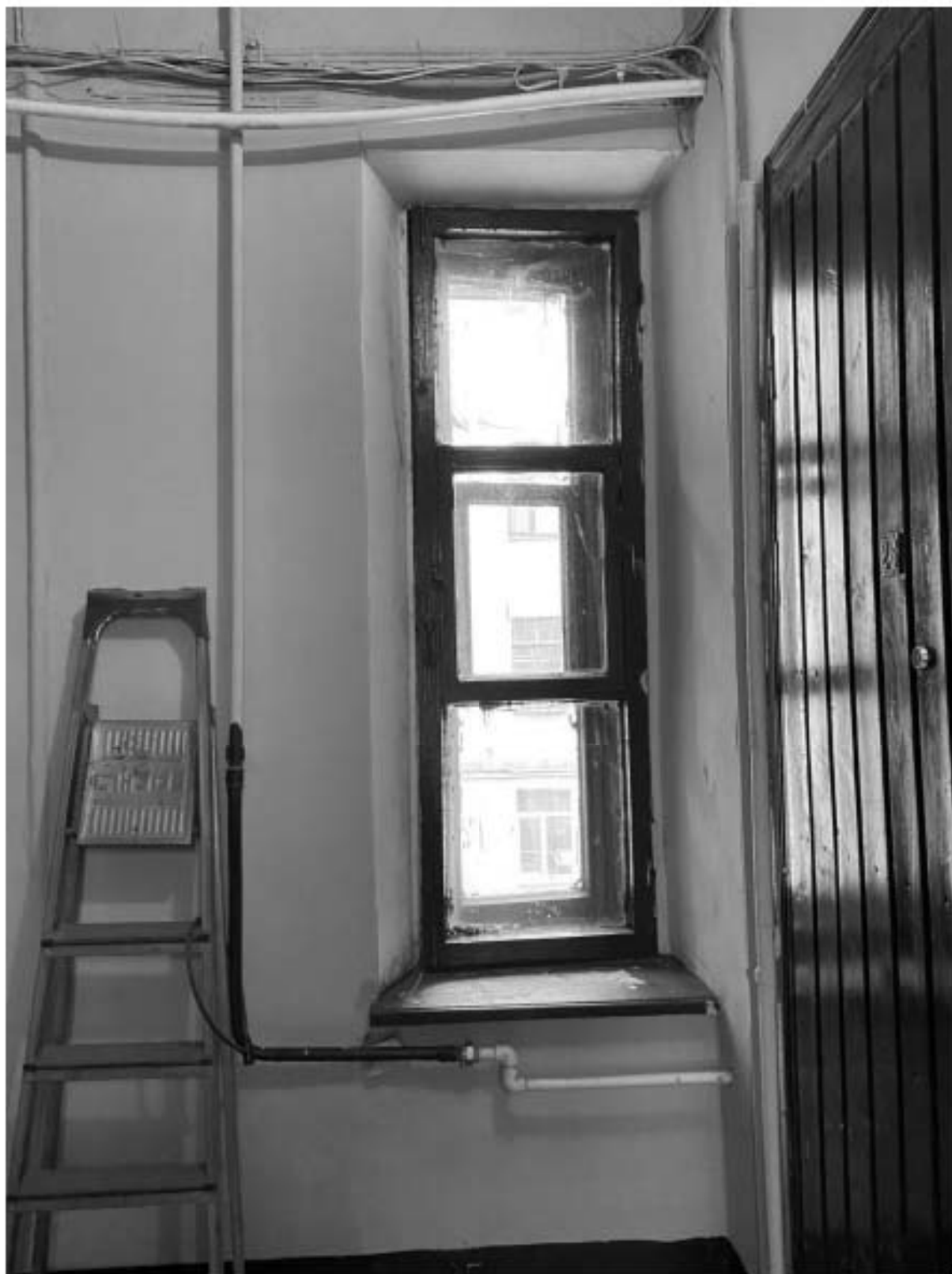
72. Оконное заполнение лестницы 5ЛК в уровне 2-го этажа
