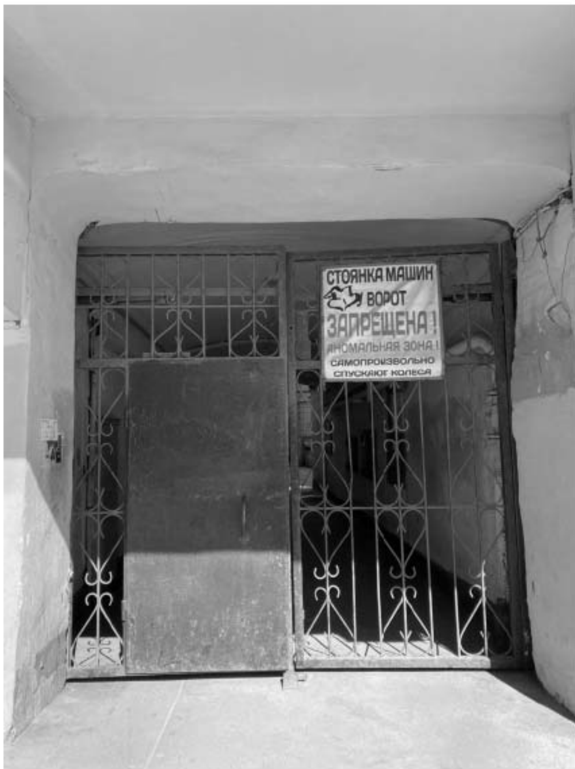
4. Воротное заполнение лицевого фасада по проспекту Римского-Корсакова
