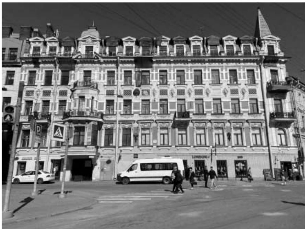
1. Общий вид лицевого фасада по проспекту Римского-Корсакова
