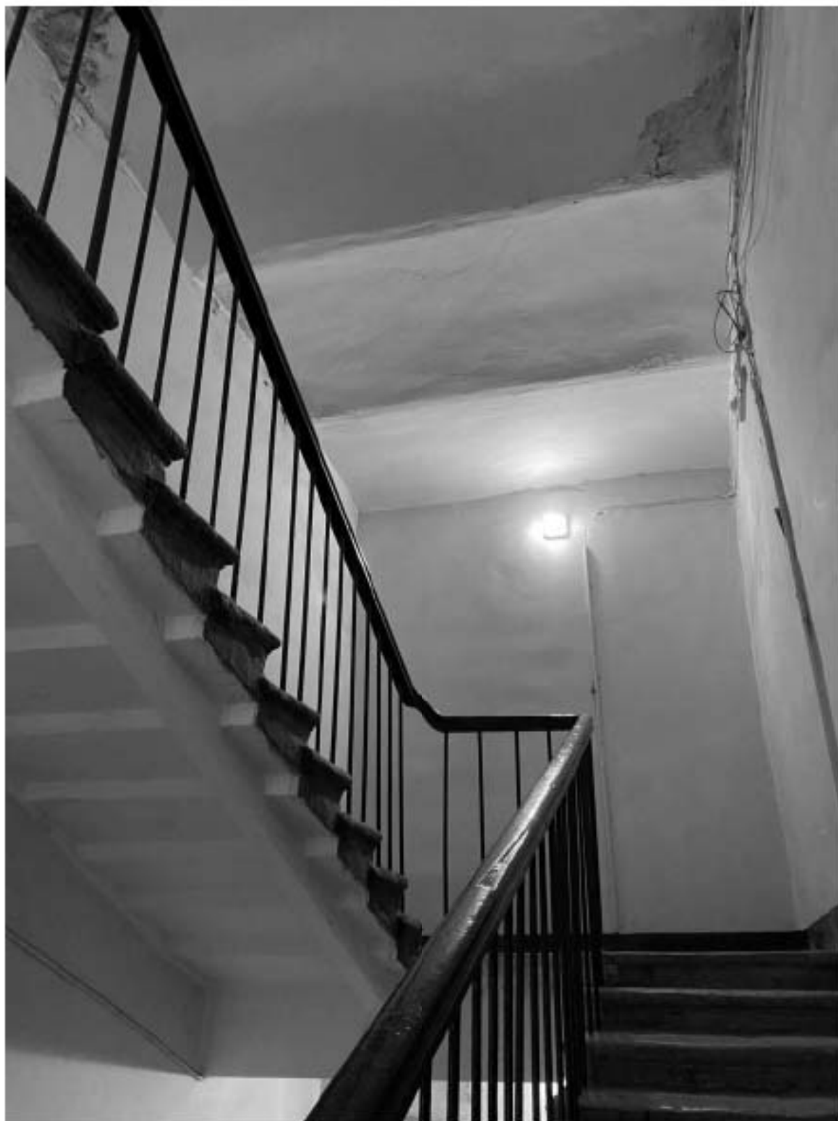
83. Перекрытие лестницы 5ЛК в уровне 5-го этажа
