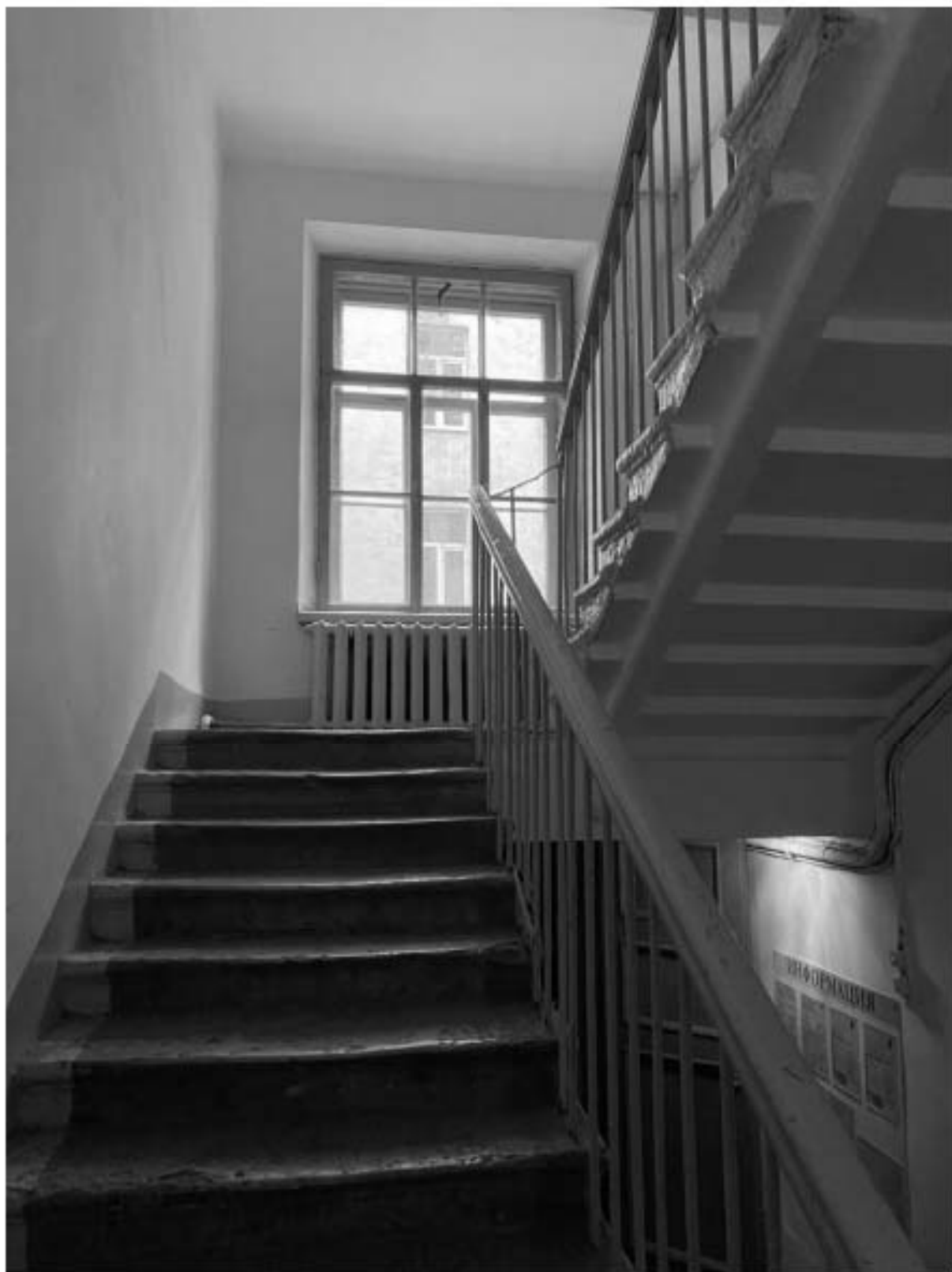
86. Общий вид лестницы 6ЛК в уровне 1-го этажа
