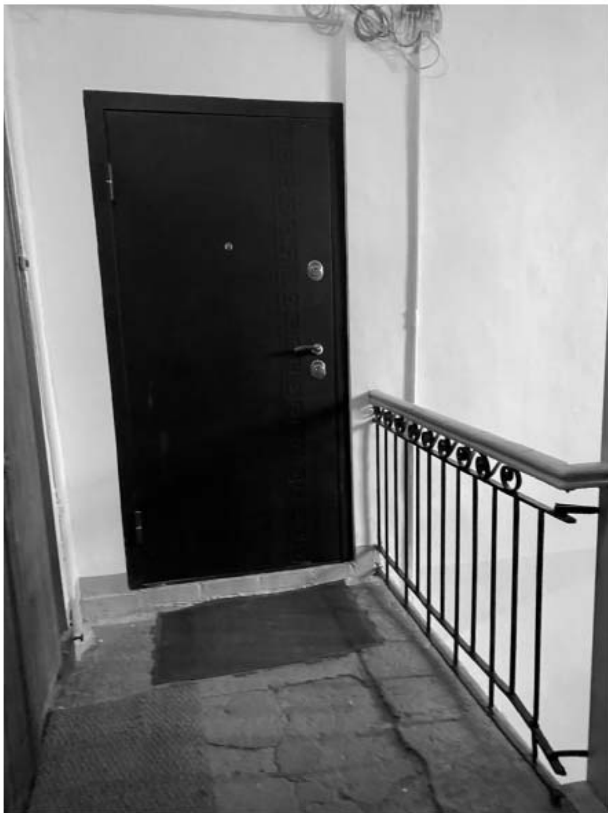
66. Площадка лестницы 4ЛК в уровне 5-го этажа
