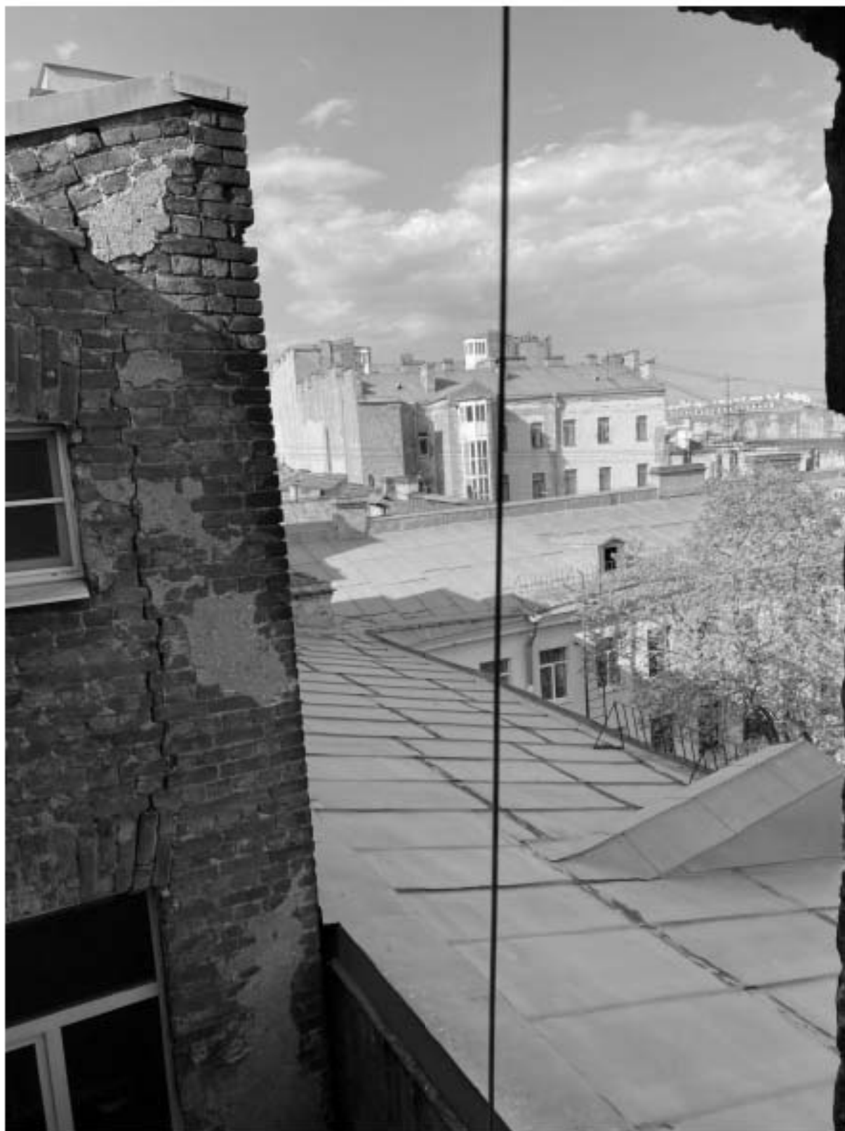
48. Вид на кровлю с чердачного помещения
