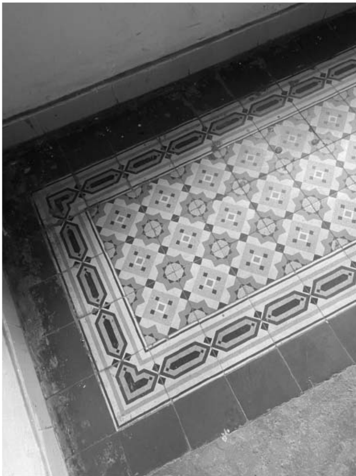
21. Метлахская плитка покрытия лестничной площадки 1ЛК в уровне 1-го этажа
