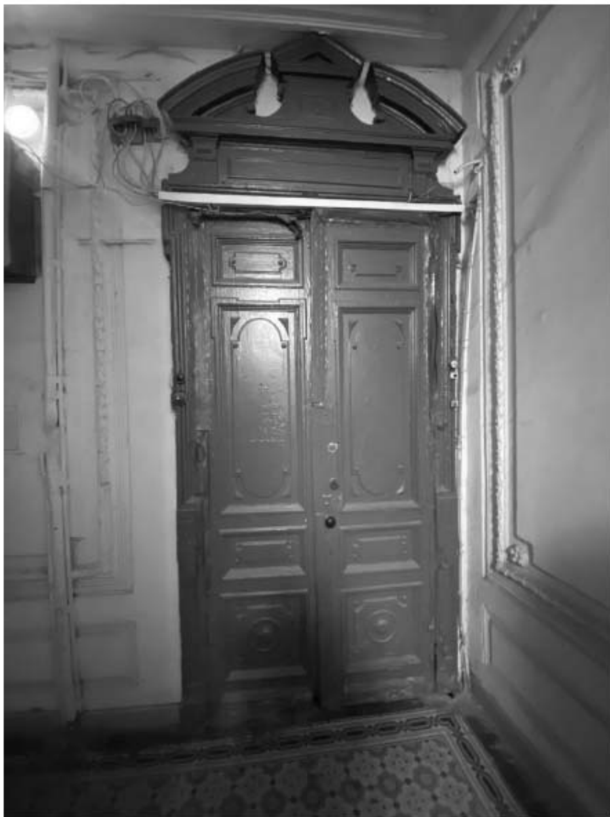
26. Общий вид дверного заполнения в части лестницы 1ЛК в уровне 2-го этажа
