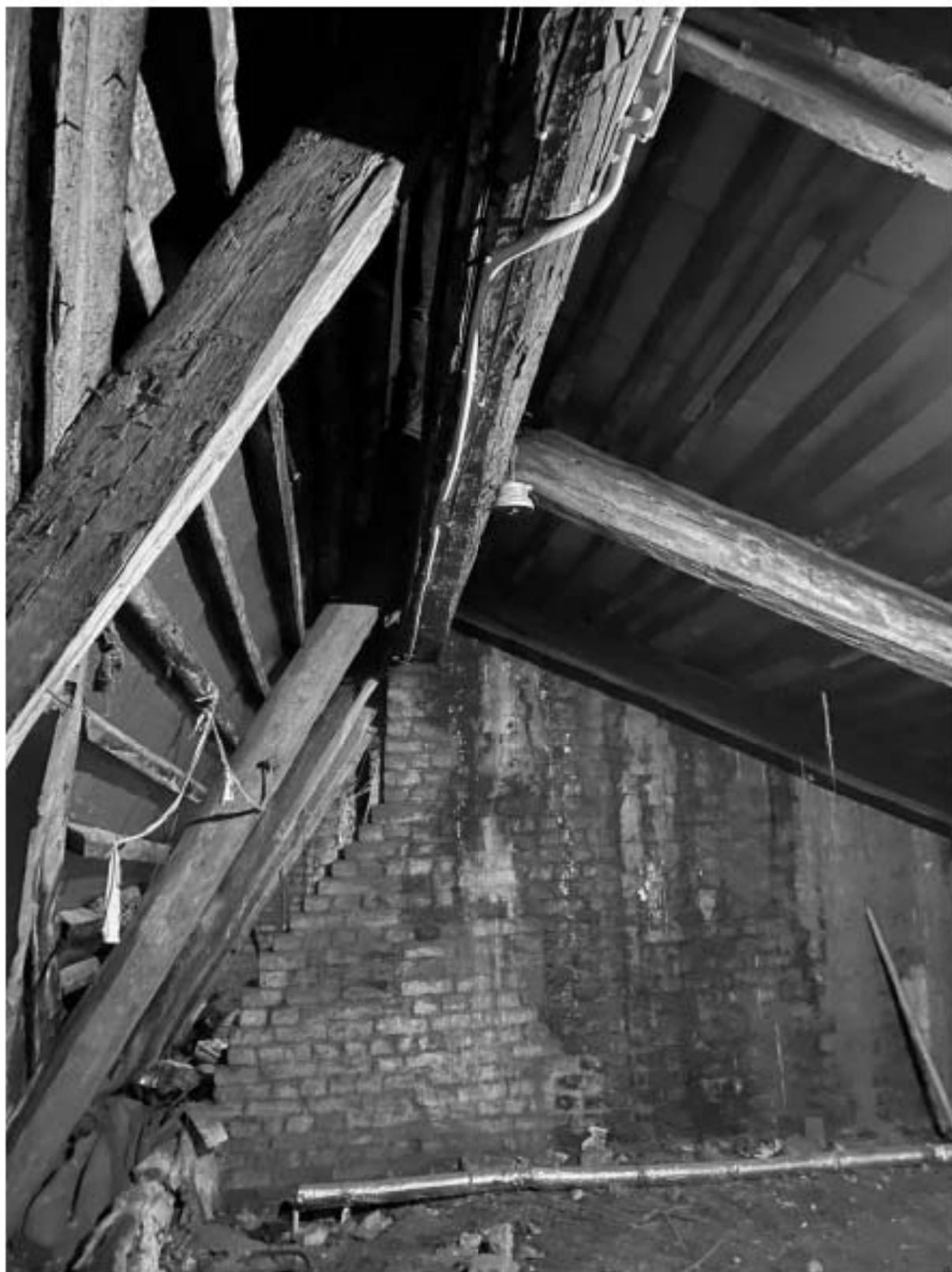
50. Общий вид чердачного помещения
