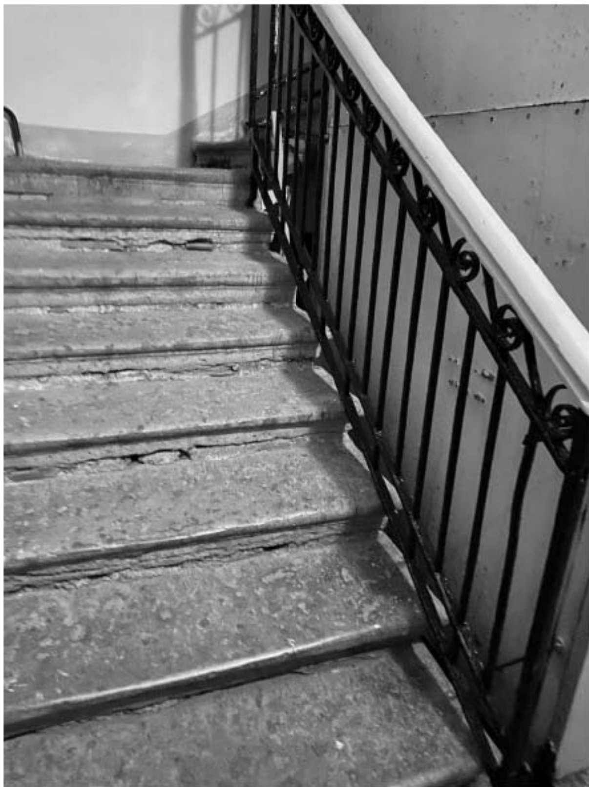
55. Общий вид лестницы 4ЛК в уровне 1-го этажа
