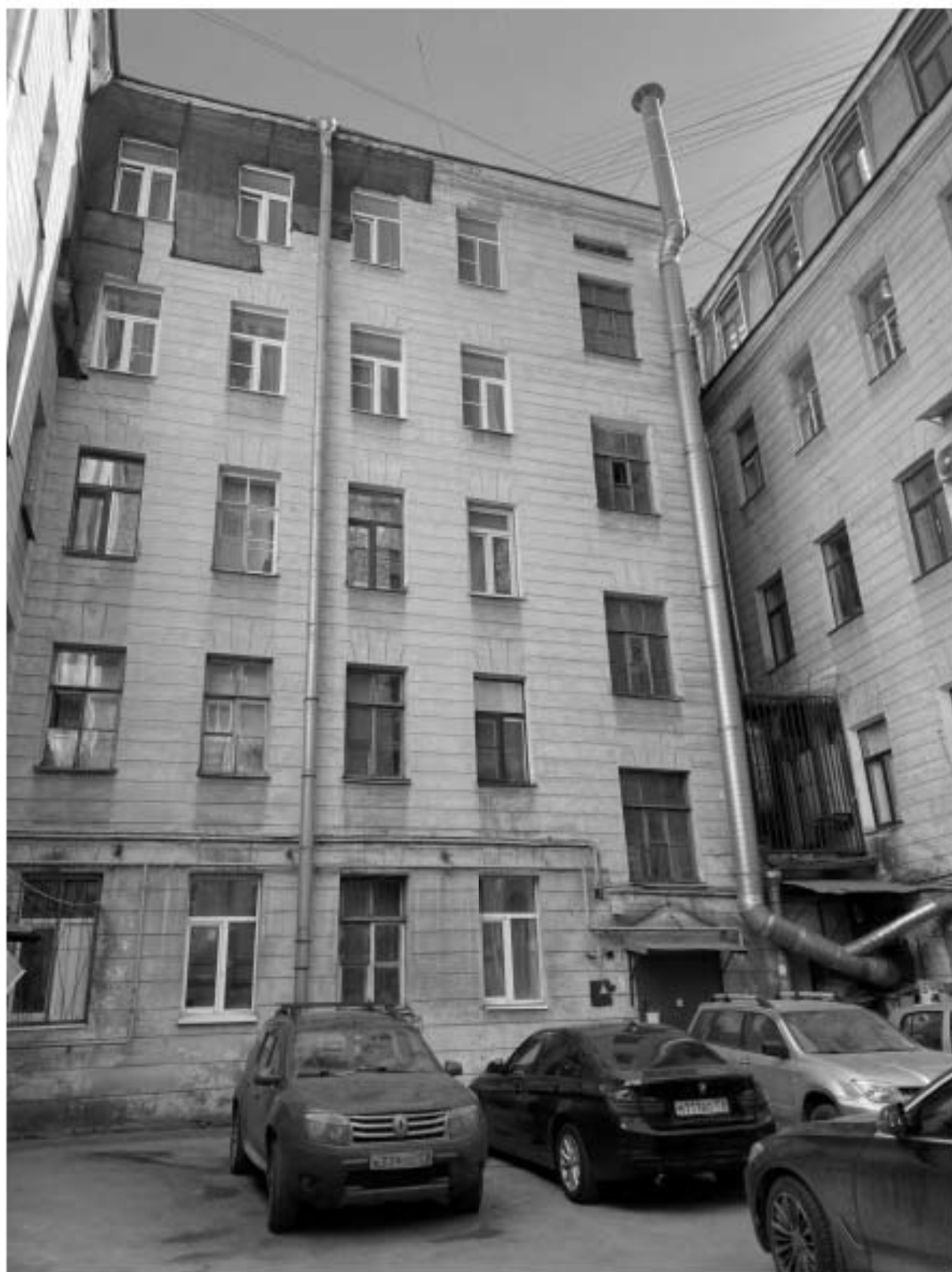
10. Фрагмент дворовых фасадов объекта культурного наследия
