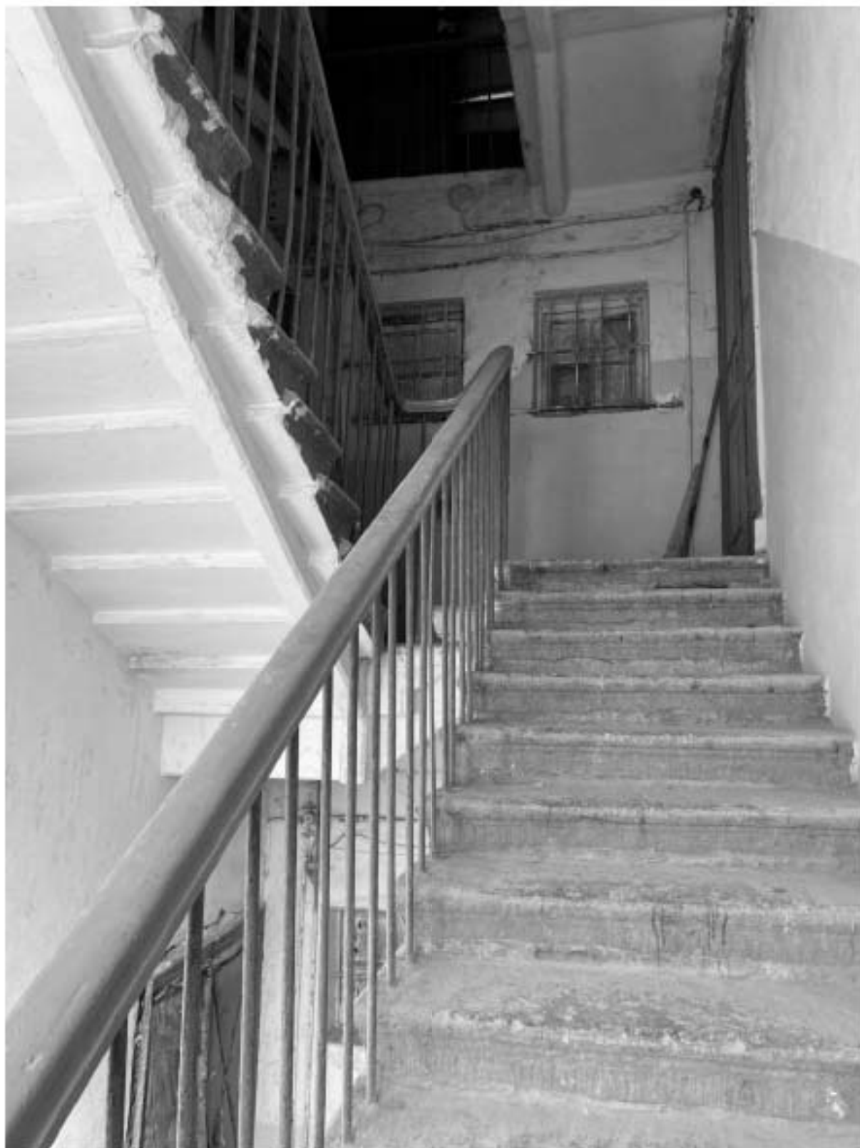
44. Общий вид лестницы ЗЛК в уровне 5-го этажа
