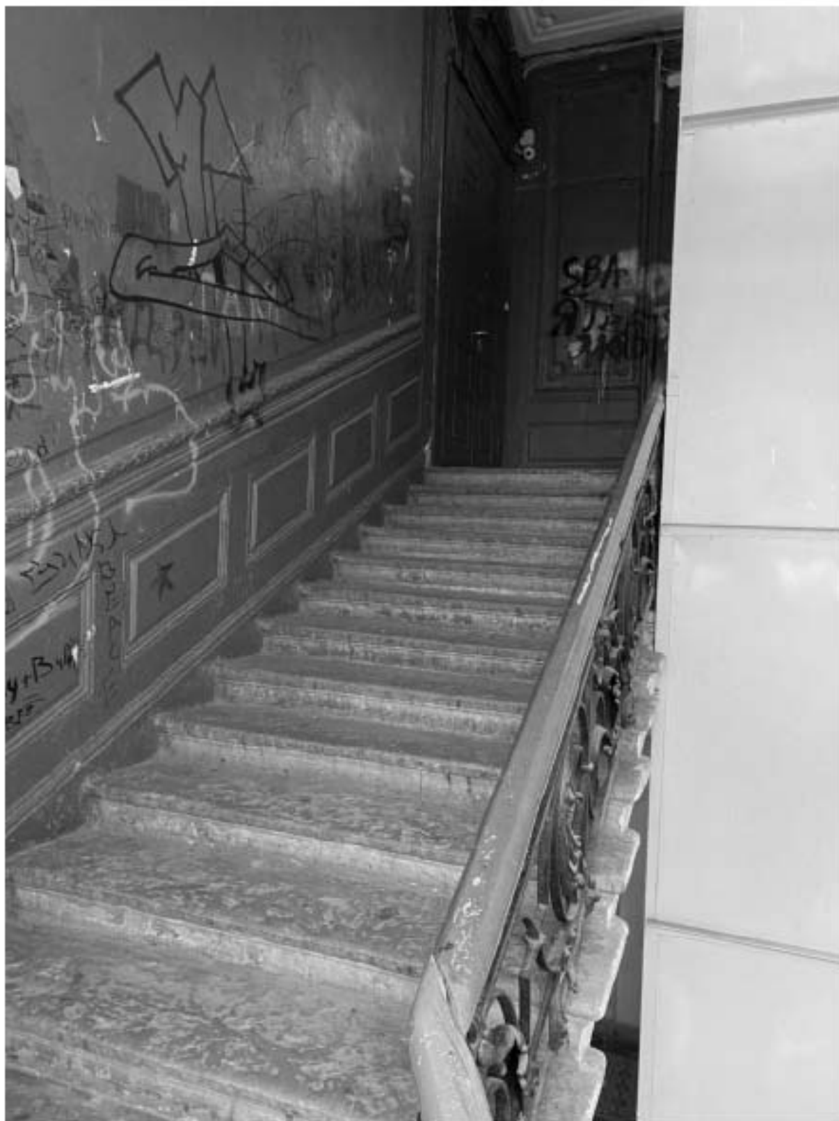
28. Общий вид лестницы 1ЛК в уровне 3-го этажа
