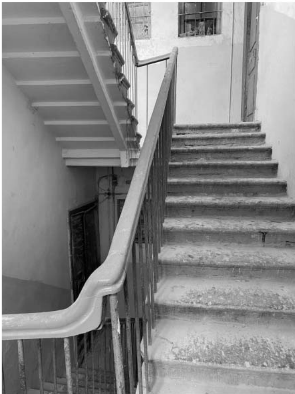
42. Общий вид лестницы ЗЛК в уровне 4-го этажа
