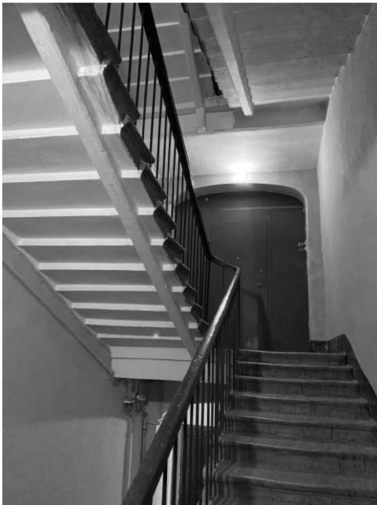
75. Общий вид лестницы 5ЛК в уровне 3-го этажа
