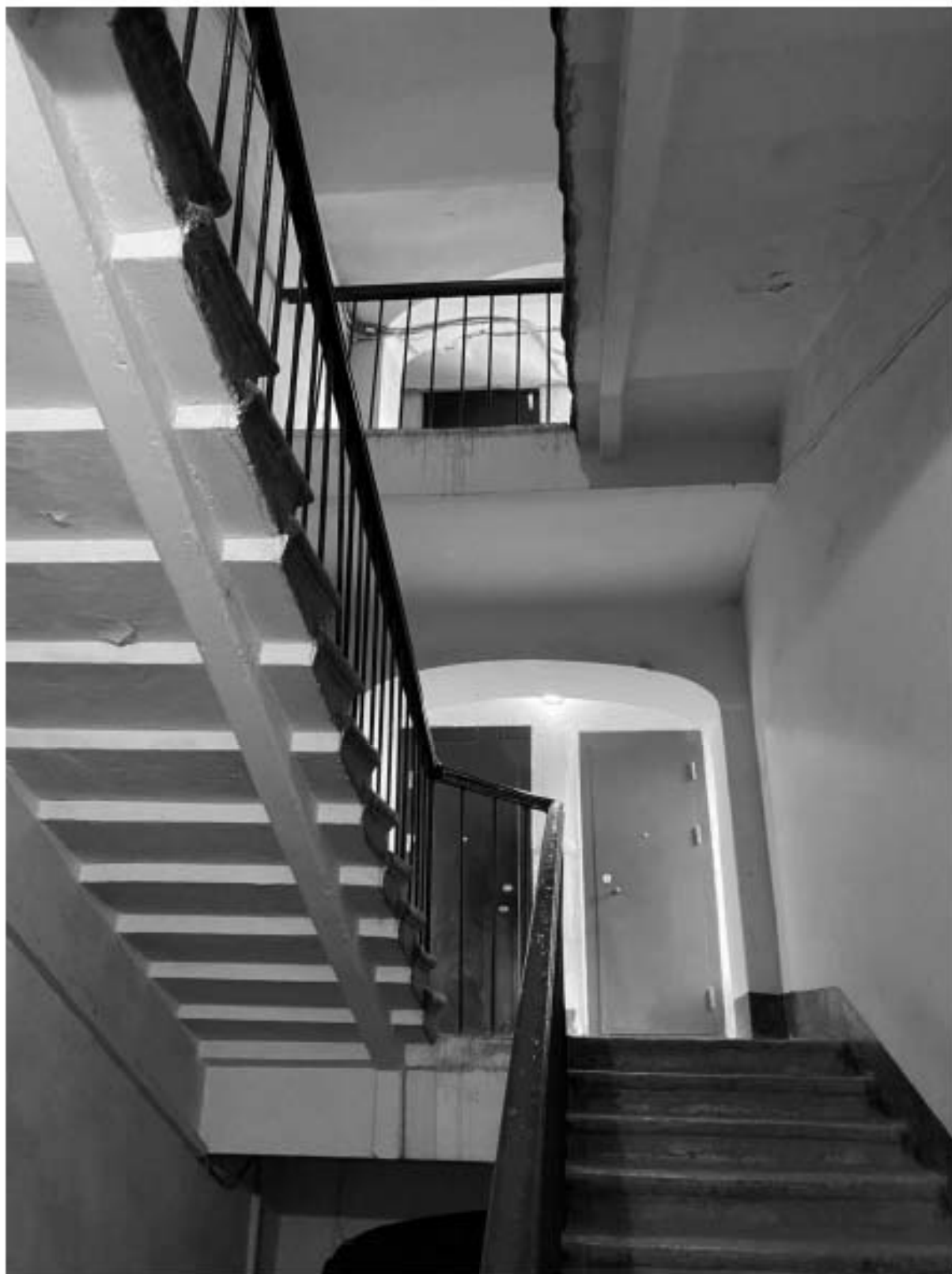
81. Общий вид лестницы 5ЛК в уровне 5-го этажа
