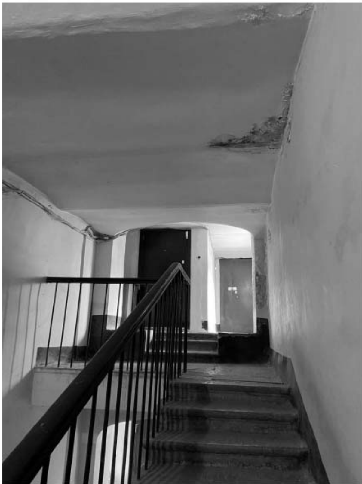
84.Перекрытые лестницы 5ЛК в уровне 5-го этажа
