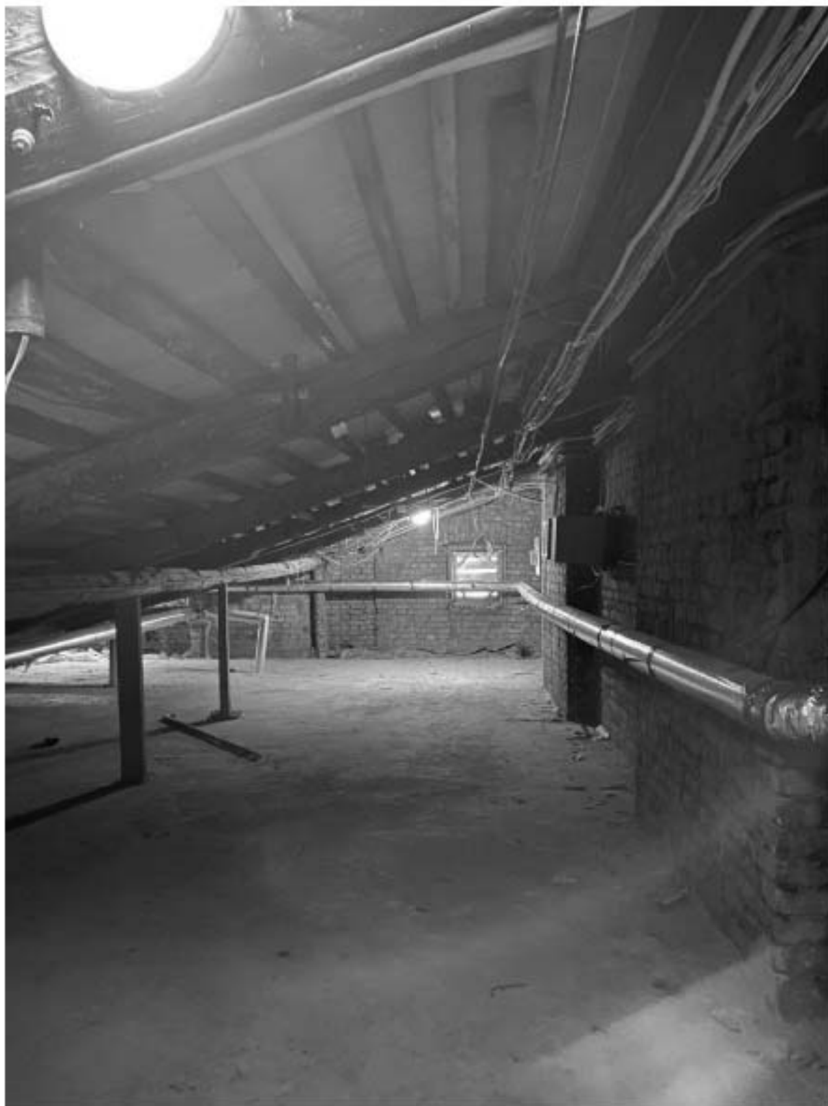
47.Общий вид чердачного помещения
