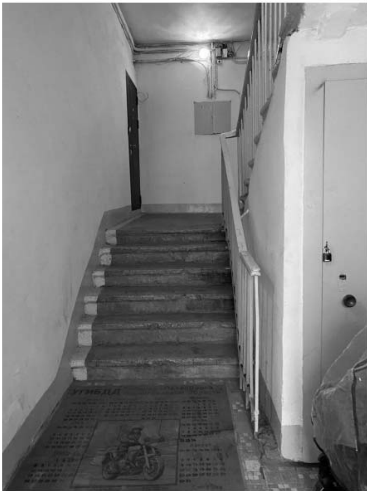
85. Общий вид лестницы БЛК в уровне 1-го этажа
