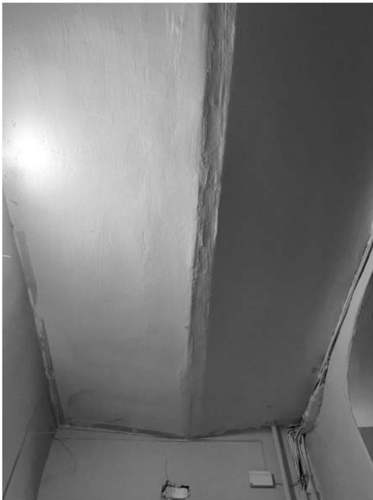
73. Перекрытие лестницы 5ЛК в уровне 2-го этажа
