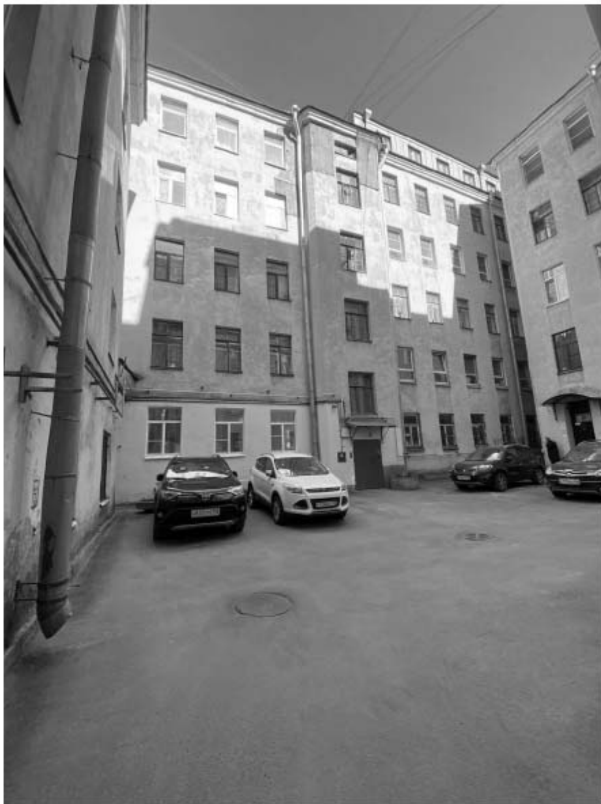
14. Фрагмент дворовых фасадов объекта культурного наследия
