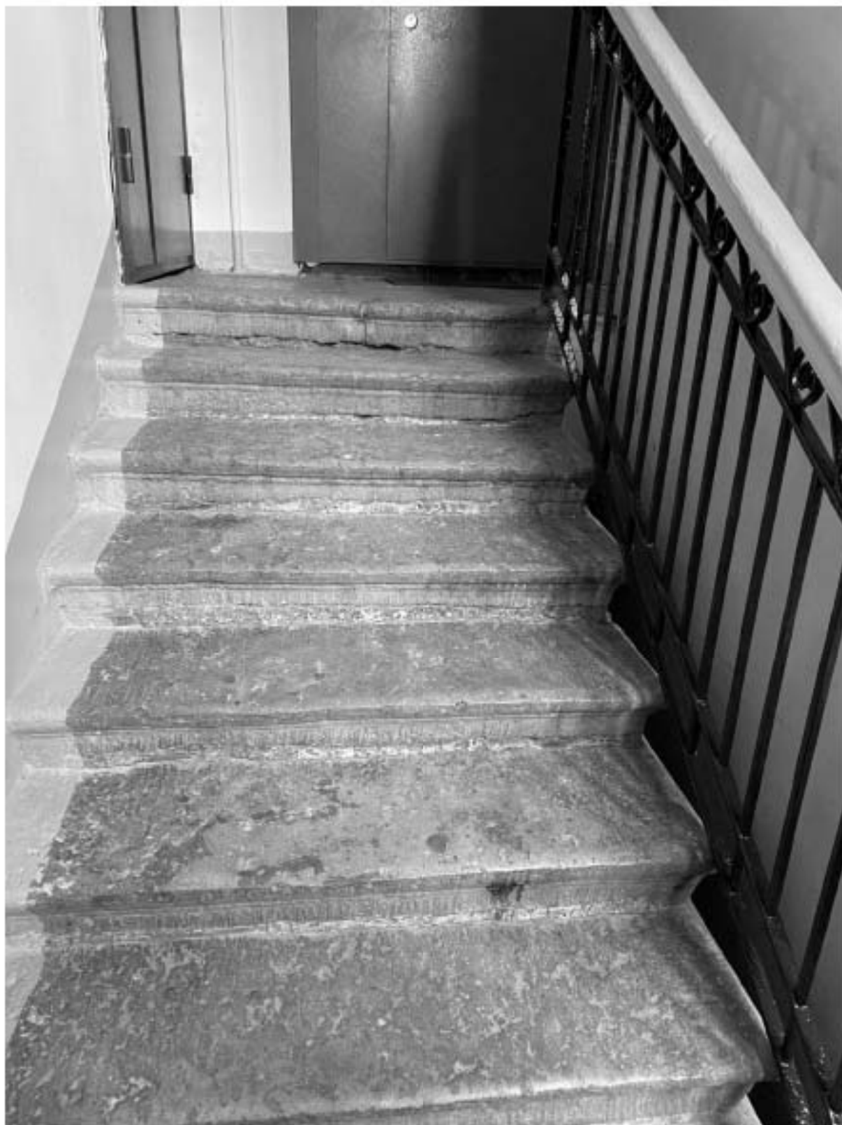
64. Общий вид лестницы 4ЛК в уровне 5-го этажа
