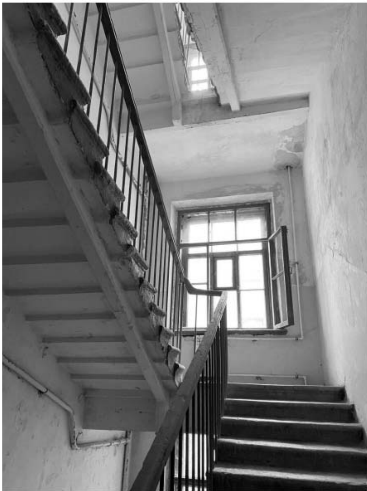
38. Общий вид лестницы ЗЛК в уровне 2-го этажа
