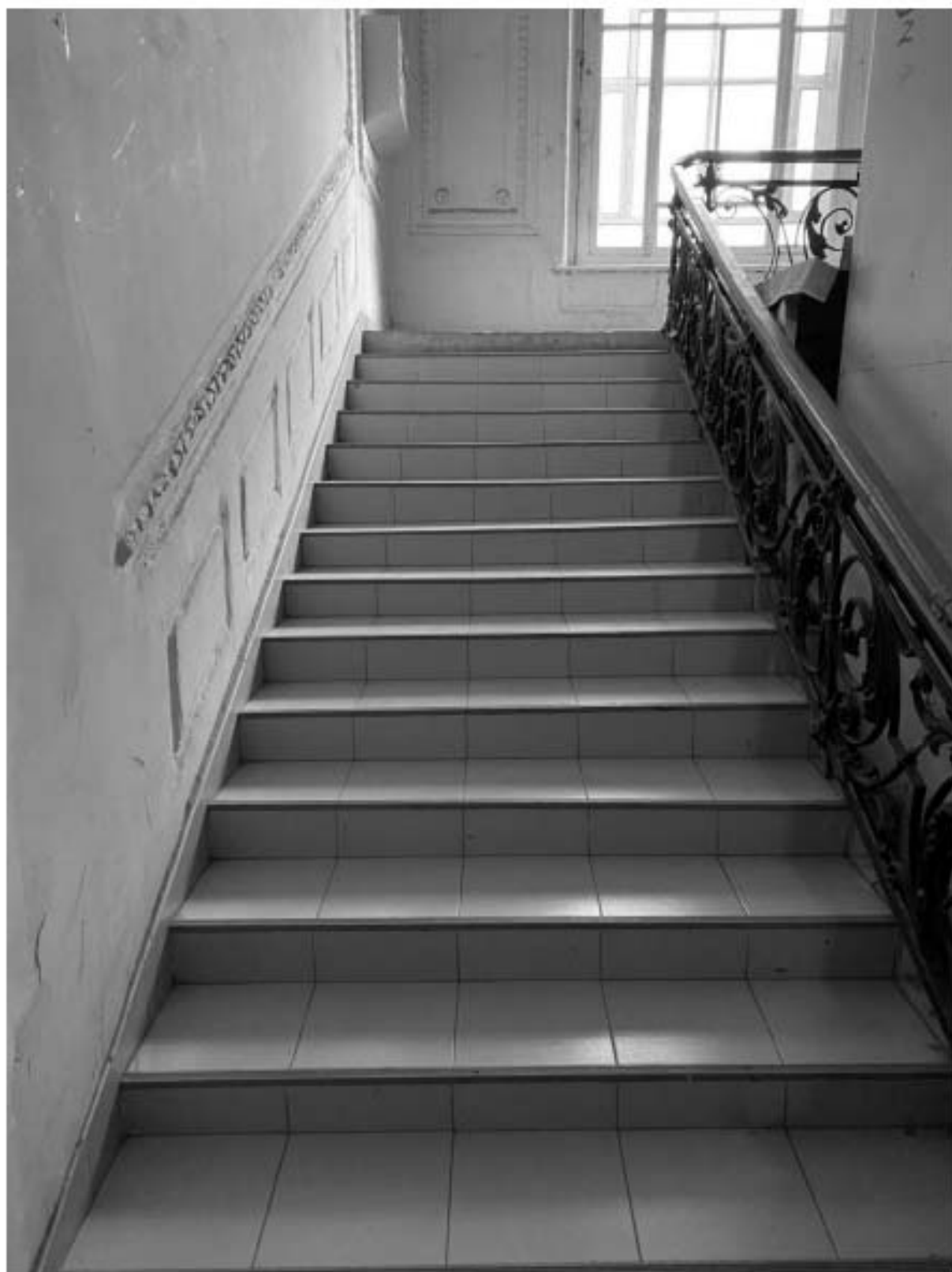
19. Фрагмент лестницы 1ЛК в уровне 1-го этажа
