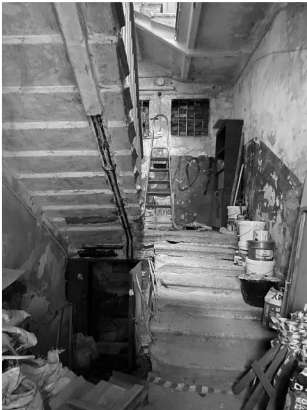
32. Общий вид лестницы ЗЛК в уровне 1-го этажа
