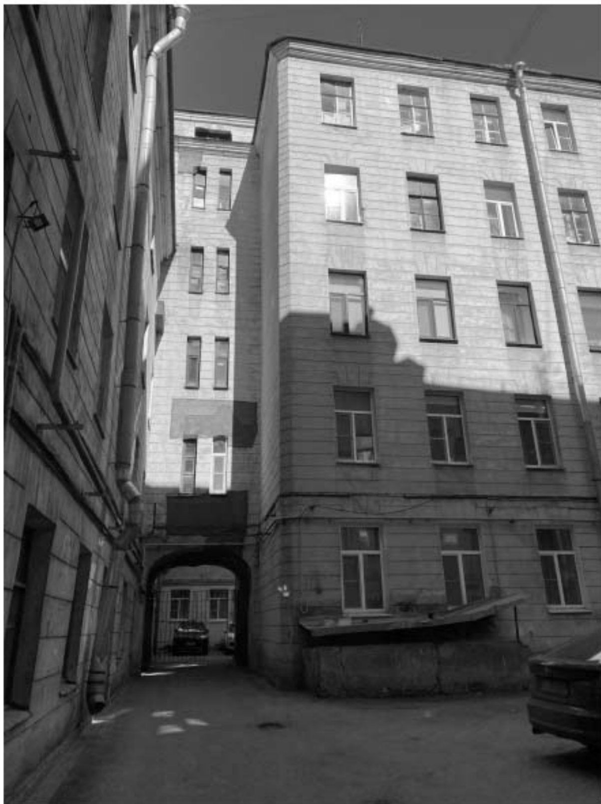
8. Фрагмент дворовых фасадов объекта культурного наследия
