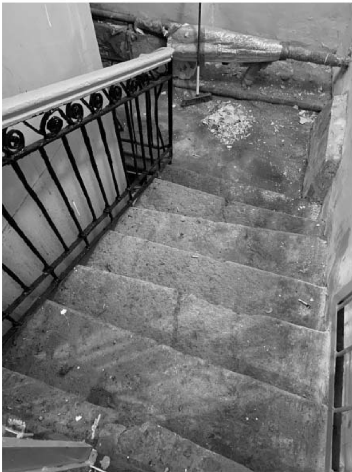
67. Площадка лестницы 4ЛК в уровне подвала
