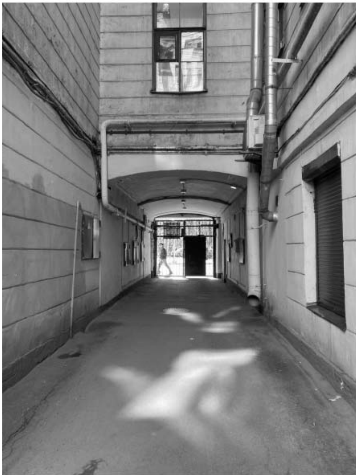
7. Фрагмент дворовых фасадов объекта культурного наследия
