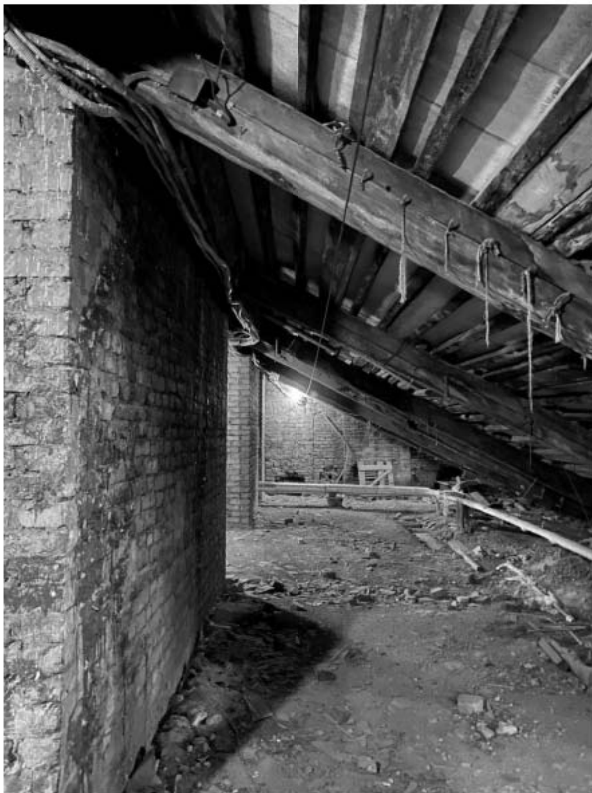
49. Общий вид чердачного помещения
