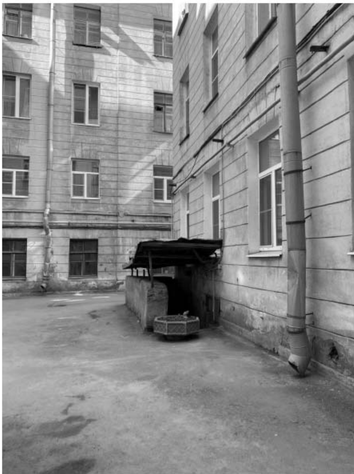
12. Фрагмент дворовых фасадов объекта культурного наследия
