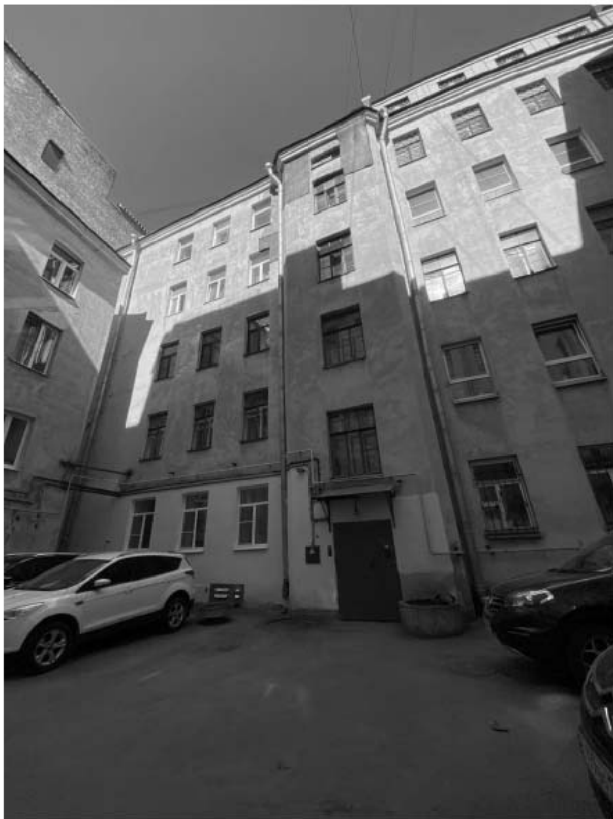
15. Фрагмент дворовых фасадов объекта культурного наследия
