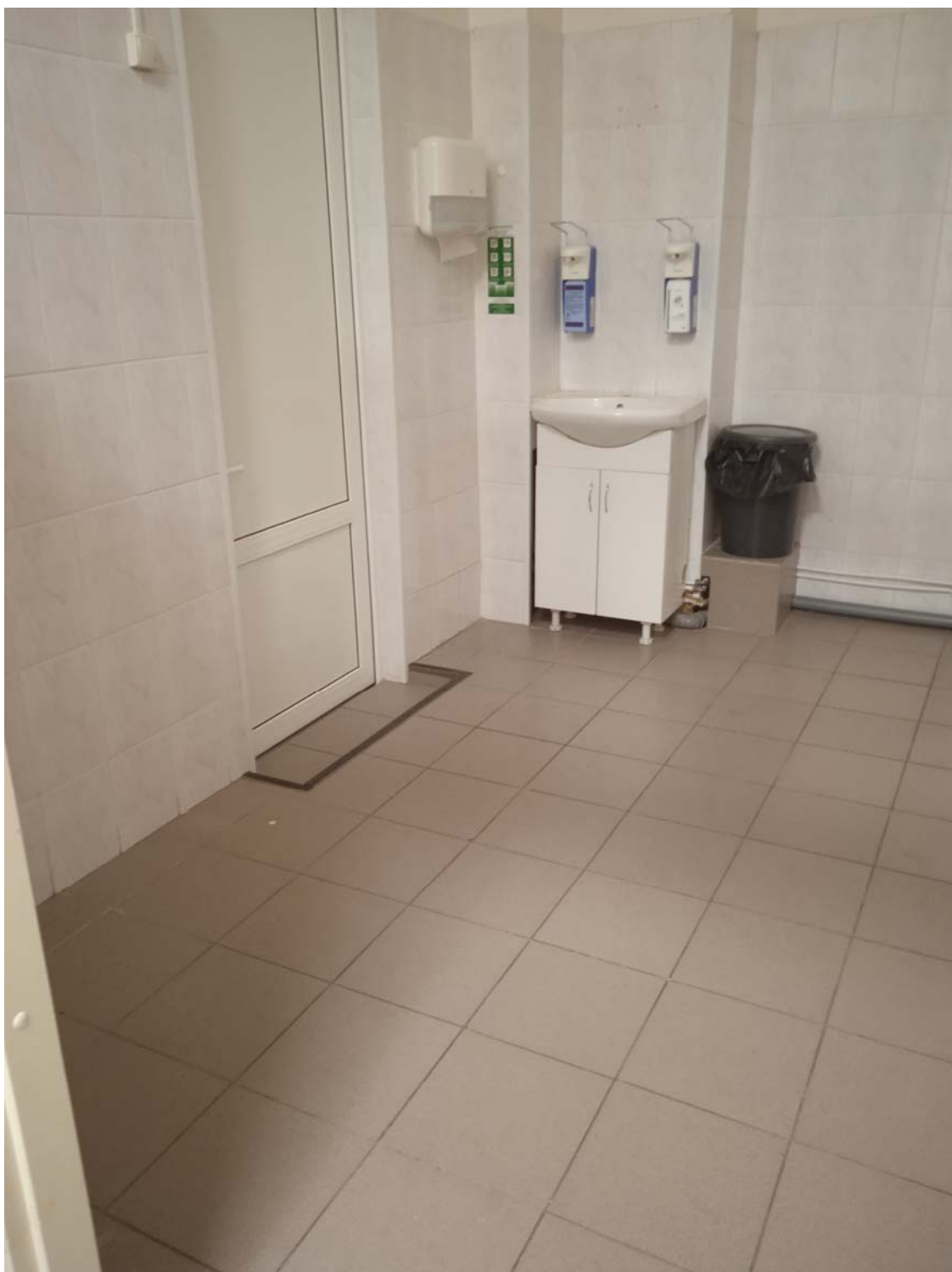
18. Помещение № 11 первого этажа.
