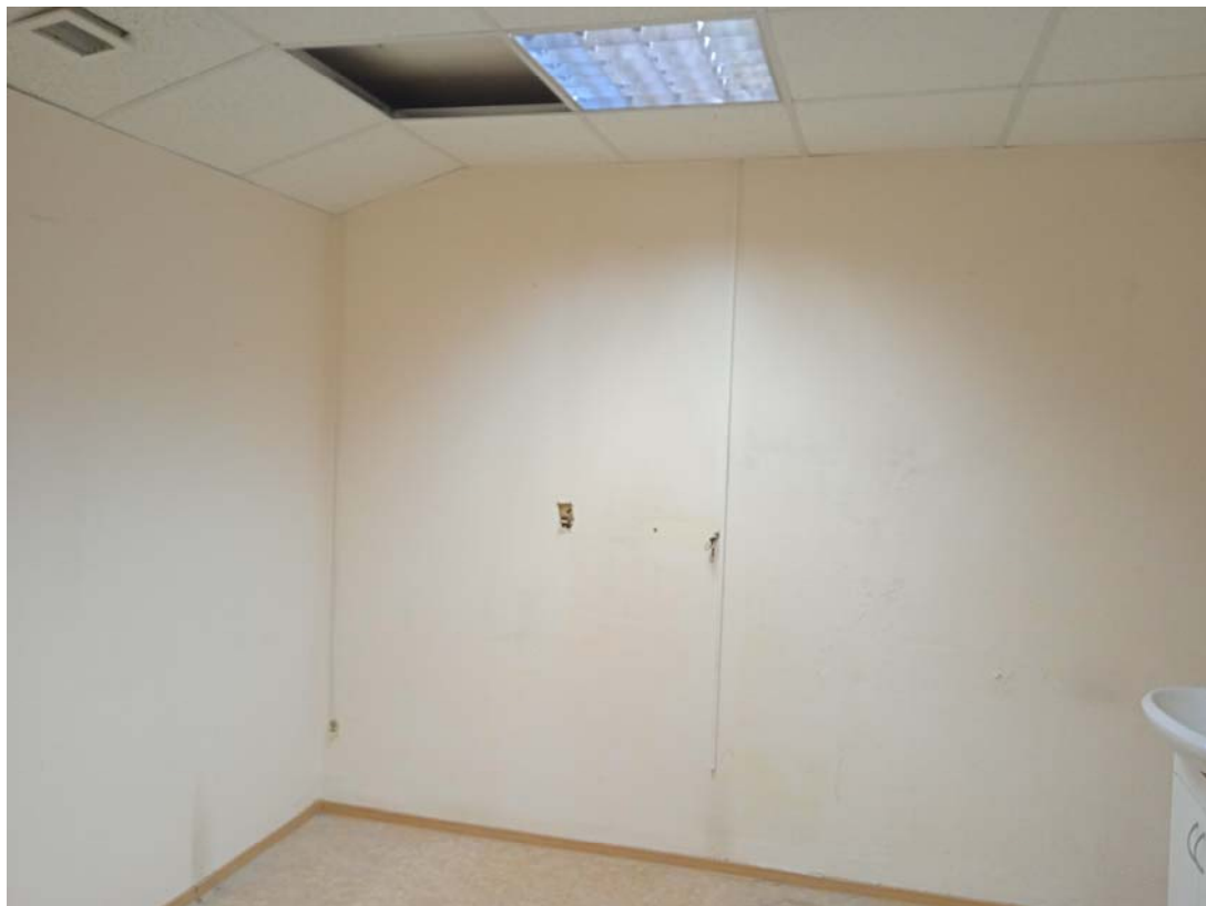
10. Помещение № 21 цокольного этажа.
