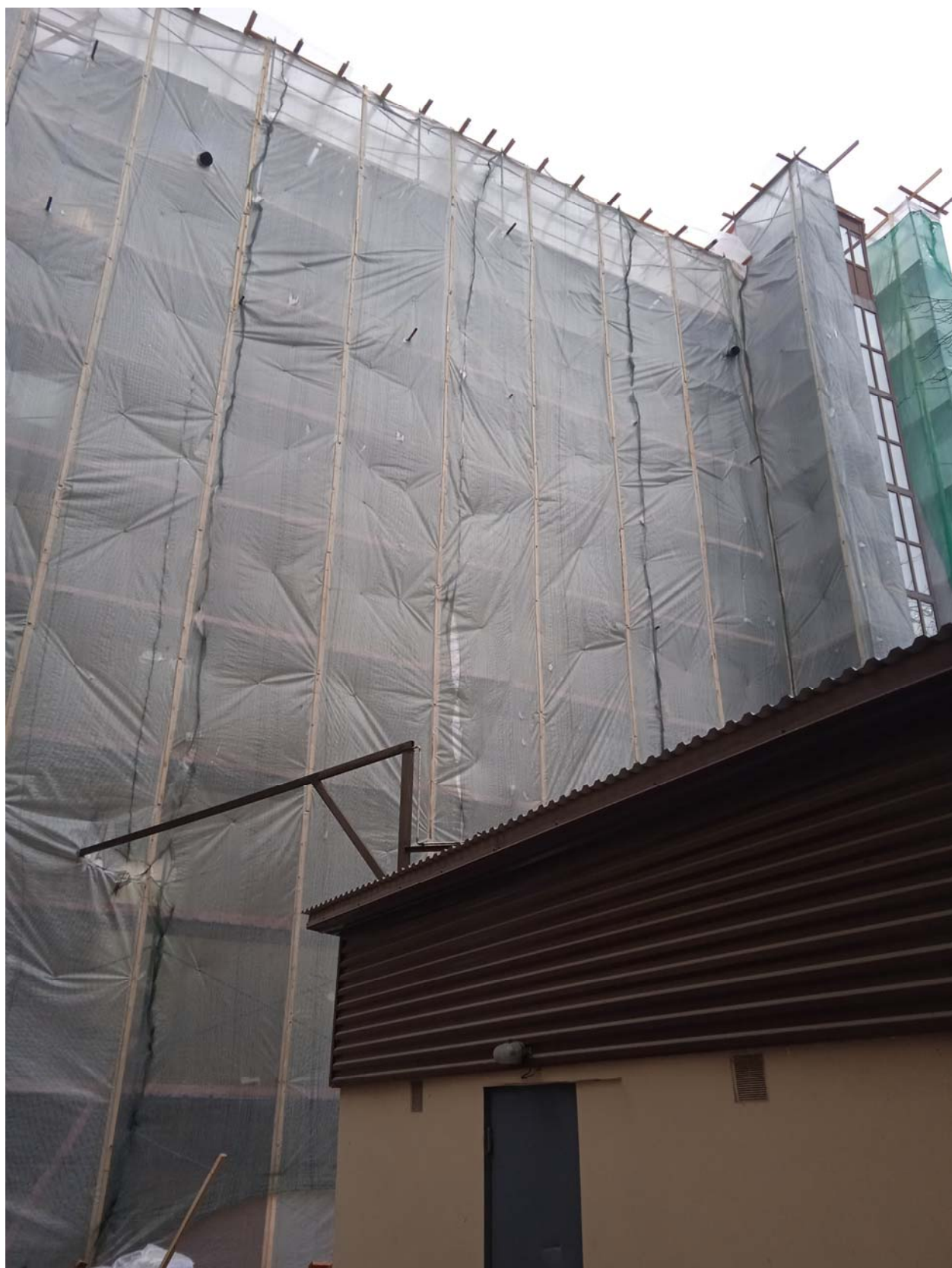
4. Юго-западный фасад здания. Общий вид.
