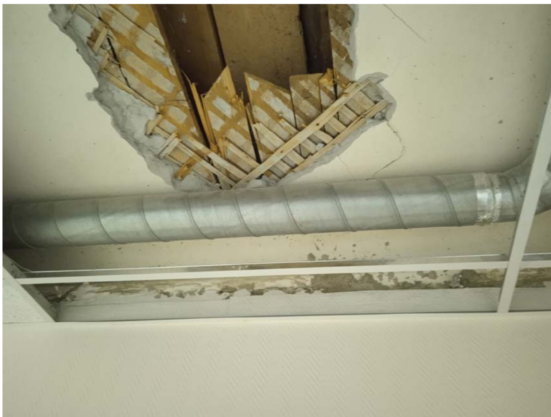
12. Помещение № 21 цокольного этажа. Вскрытие конструкций перекрытия цокольного этажа.
