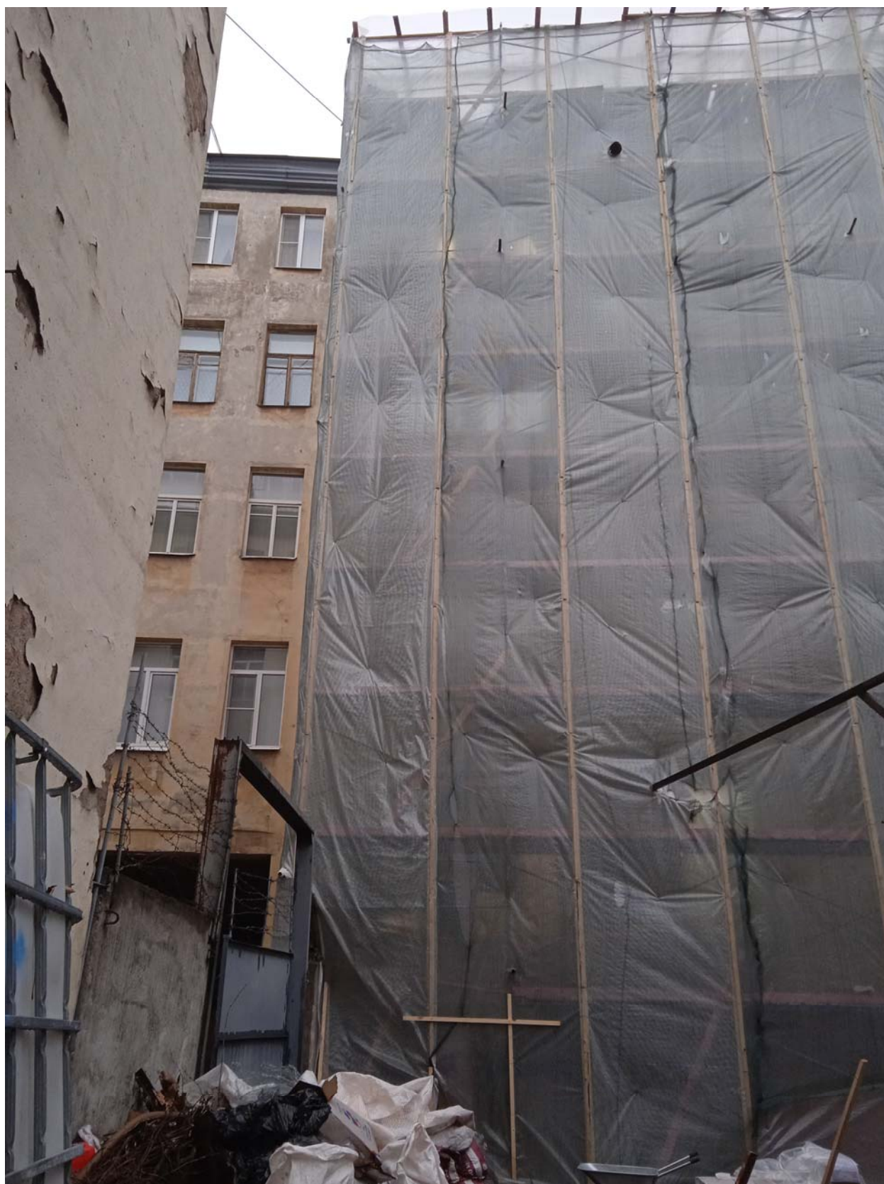
3. Юго-западный фасад здания между осями 25/В-Д.
