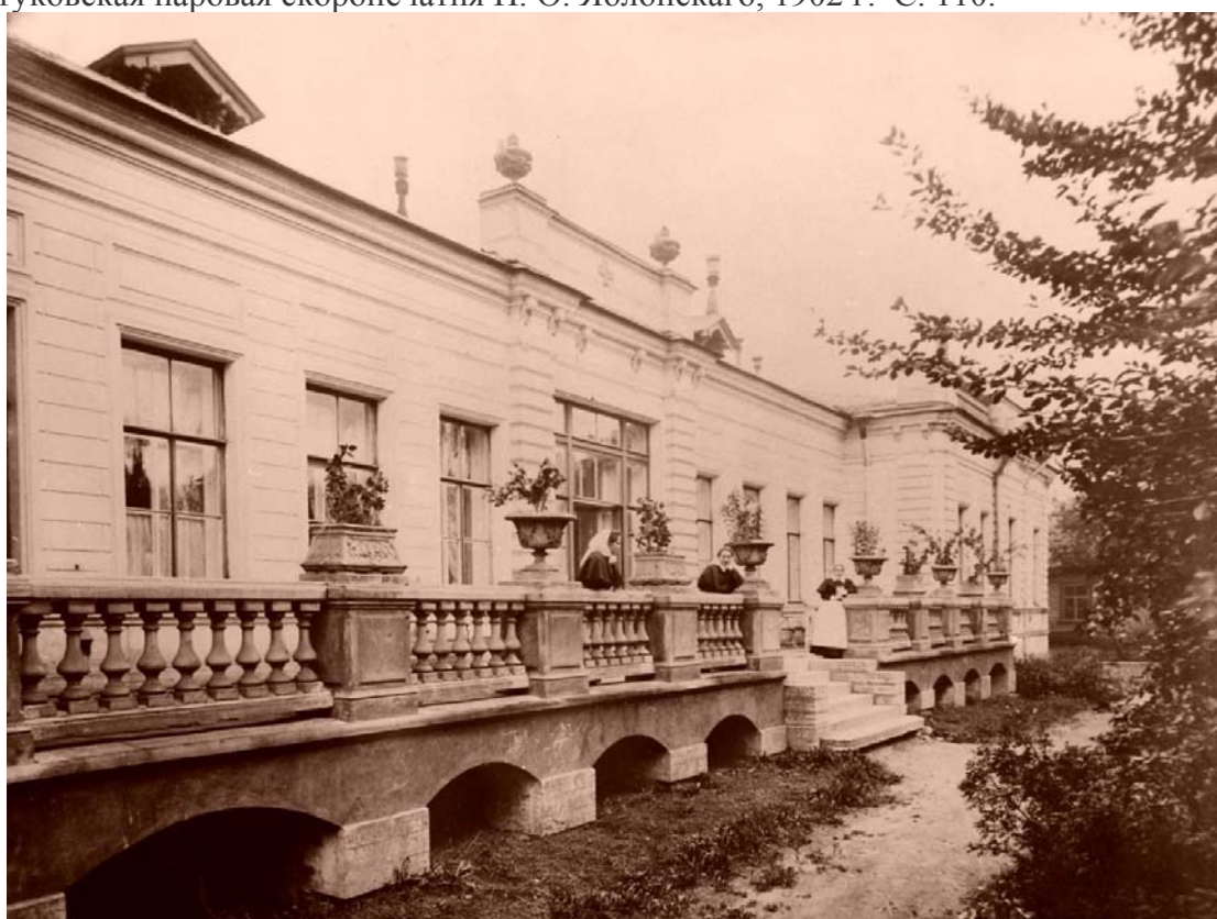
40. Западный фасад лечебницы Александровской Общины сестёр милосердия РОКК. Фото нач. 1900-х гг. из собрания научной библиотеки НИИ ЛОР.
