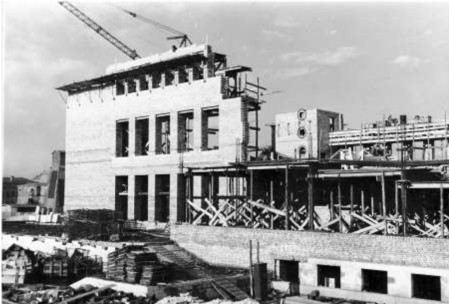
40. ЦГАКФФД СПб. Бр 71421. Вид бокового фасада здания театра юных зрителей во время возведения кирпичных стен. 1958 г.
