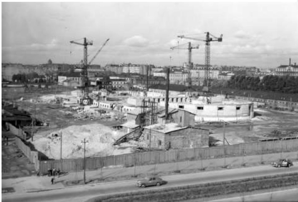
36. ЦГАКФФД СПб. Бр 71410. Вид на строящееся здание театра юных зрителей с южной стороны. 1958 г.
