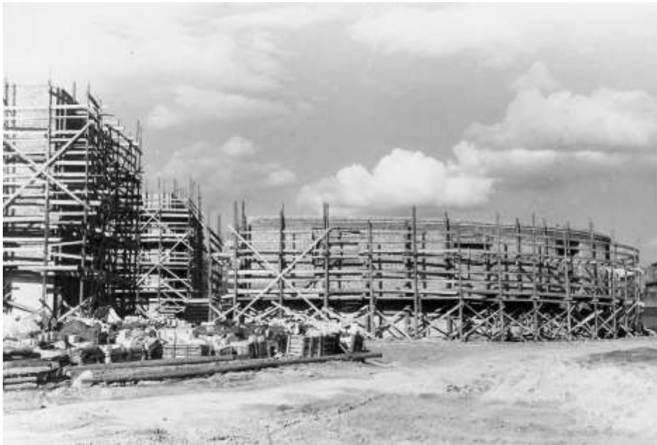
46. ЦГАКФФД СПб. Бр 71424. Вид здания хозяйственного двора театра юных зрителей во время облицовки фасадов декоративной плиткой. 1959 г.
