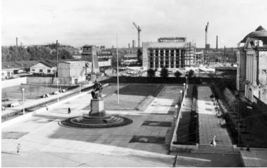
50. ЦГАКФФД СПб. Бр 71454. Вид на строящееся здание театра юных зрителей с Пионерской площади. На переднем плане, в центре, памятник А.С. Грибоедову; скульптор В.В. Лишев, архитектор В.И. Яковлев, 1959 г. 1960 г.
