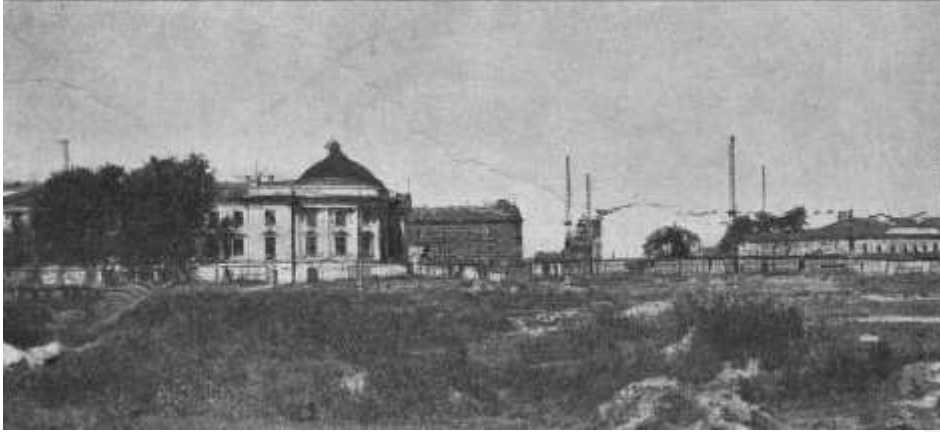
18. Начало реконструкции территории бывшего Ипподрома 1947 г. (по изд.: журнал «Архитектура и строительство Ленинграда» № 1. 1948 год).
