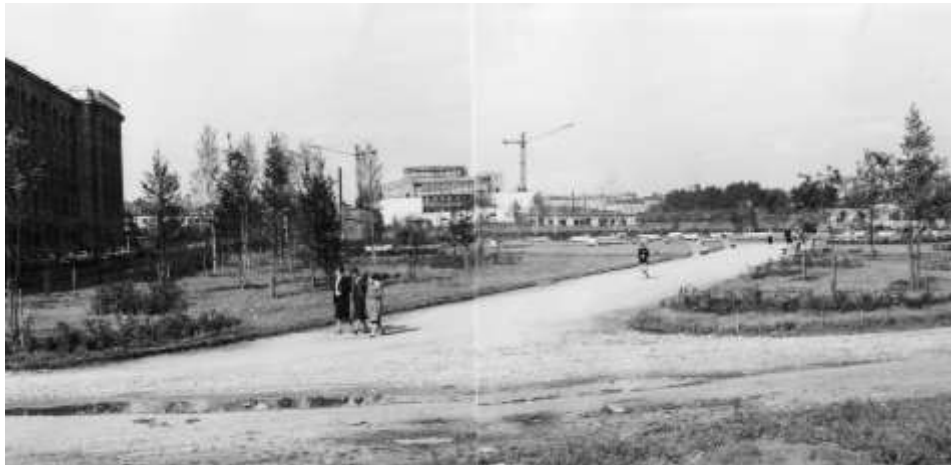
44. ЦГАКФФД. Бр 71405. Вид на строящееся здание театра юных зрителей из южной части парка. (Панорама из 2-х снимков). 1959 г.
