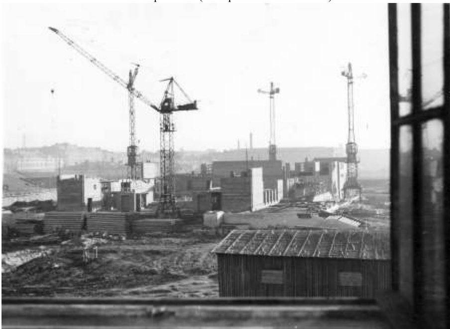
33. ЦГАКФФД СПб. Бр 71408. Вид на строительство здания театра юных зрителей. 1958 г.
