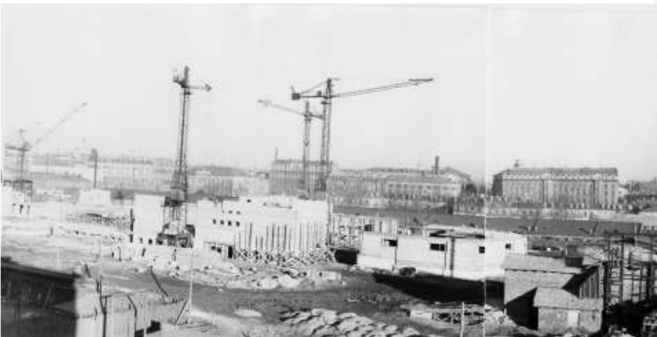
35. ЦГАКФФД СПб. Бр 71409. Вид на строительство здания театра юных зрителей с южной стороны. (Панорама из 2-х снимков). 1958 г.
