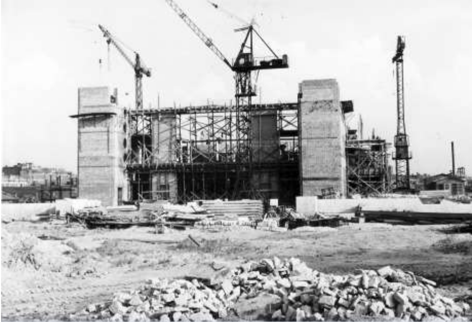
38. ЦГАКФФД СПб. Бр 71415. Строительство северного фасада здания театра юных зрителей. 1958 г.
