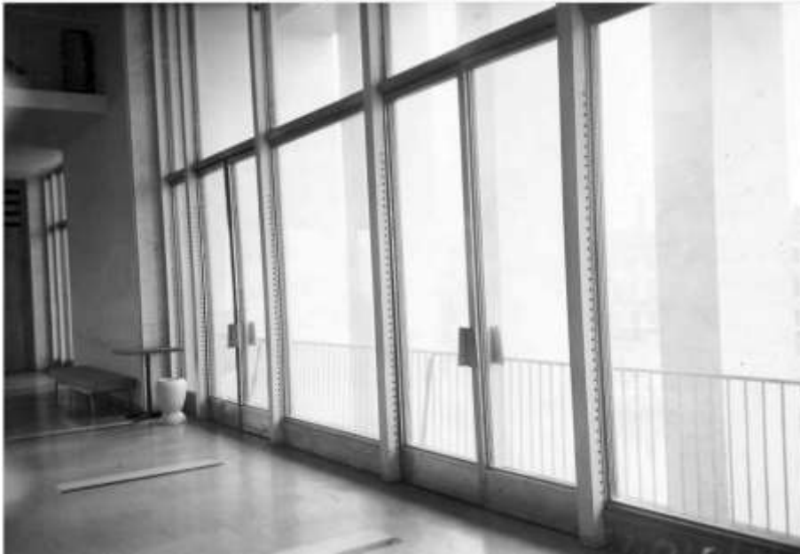
64. ЦГАКФФД СПб. Бр 71335. Вид на входные двери из фойе театра юных зрителей. Архитектор А.В. Жук, 1962 г.
