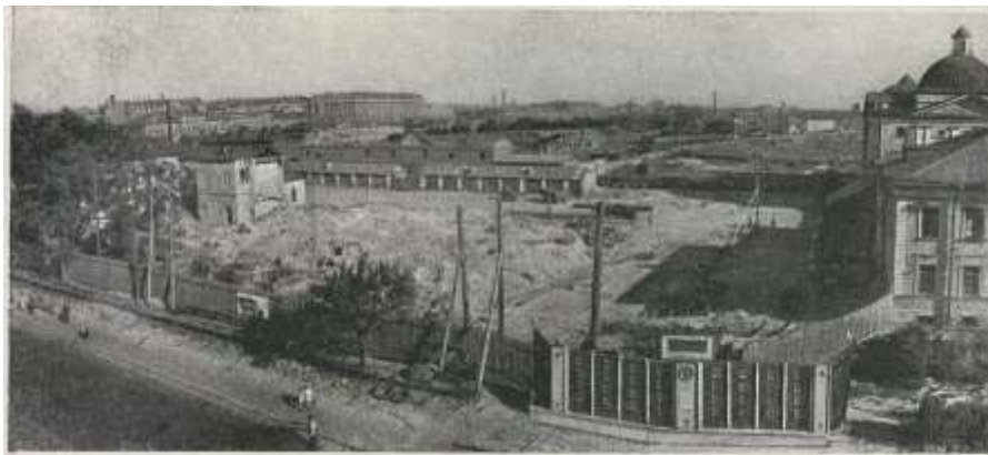
19. На бывшем ипподроме. (по изд.: журнал «Архитектура и строительство Ленинграда» № 1. 1948 год).
