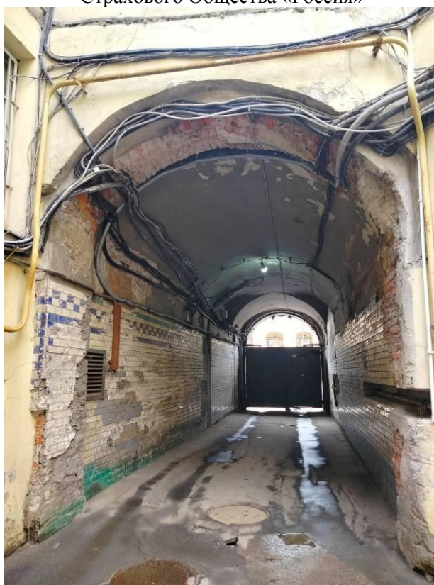
Фото 2. Фрагмент дворового фасада объекта культурного наследия регионального значения «Дом Страхового Общества «Россия», воротный проезд
