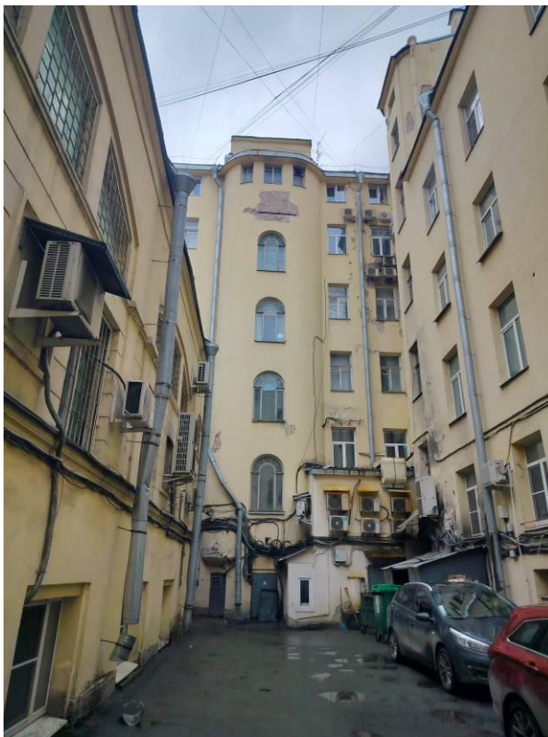
Фото 5. Фрагмент дворового фасада объекта культурного наследия регионального значения «Дом Страхового Общества «Россия»
