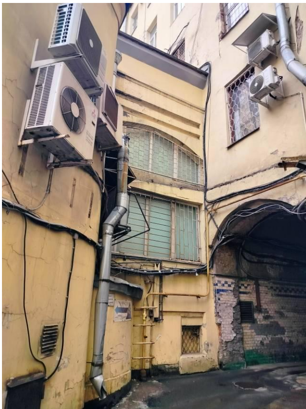
Фото 3. Фрагмент дворового фасада объекта культурного наследия регионального значения «Дом Страхового Общества «Россия»
