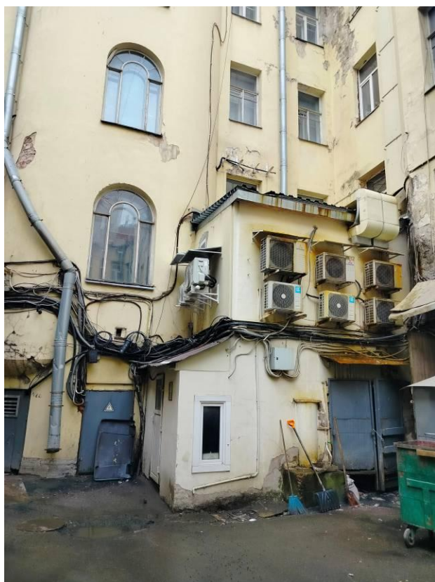
Фото 4. Фрагмент дворового фасада объекта культурного наследия регионального значения «Дом Страхового Общества «Россия»
