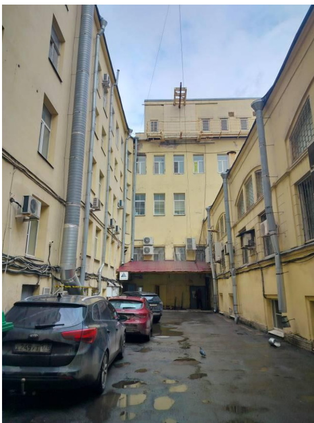
Фото 6. Фрагмент дворового фасада объекта культурного наследия регионального значения «Дом Страхового Общества «Россия»
