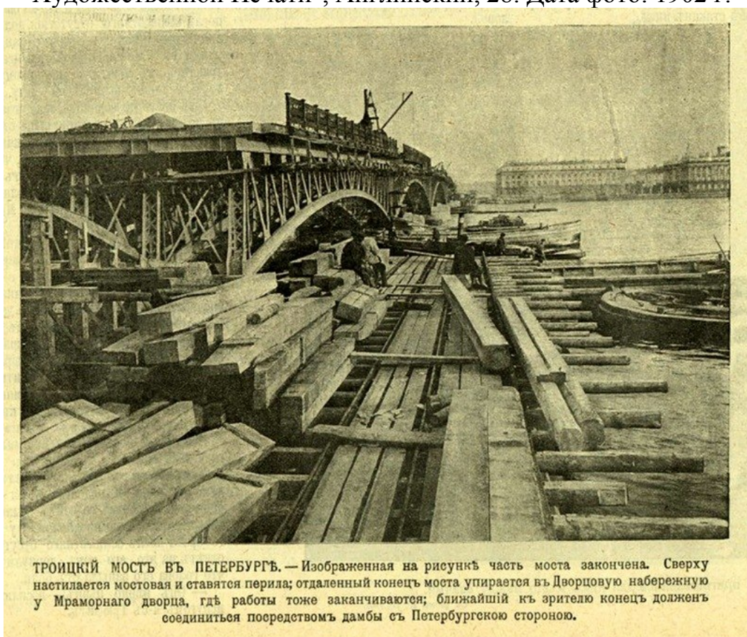
15. Строительство Троицкого моста. Газета "Новое время" 28 августа (10 сентября) 1902 г.
