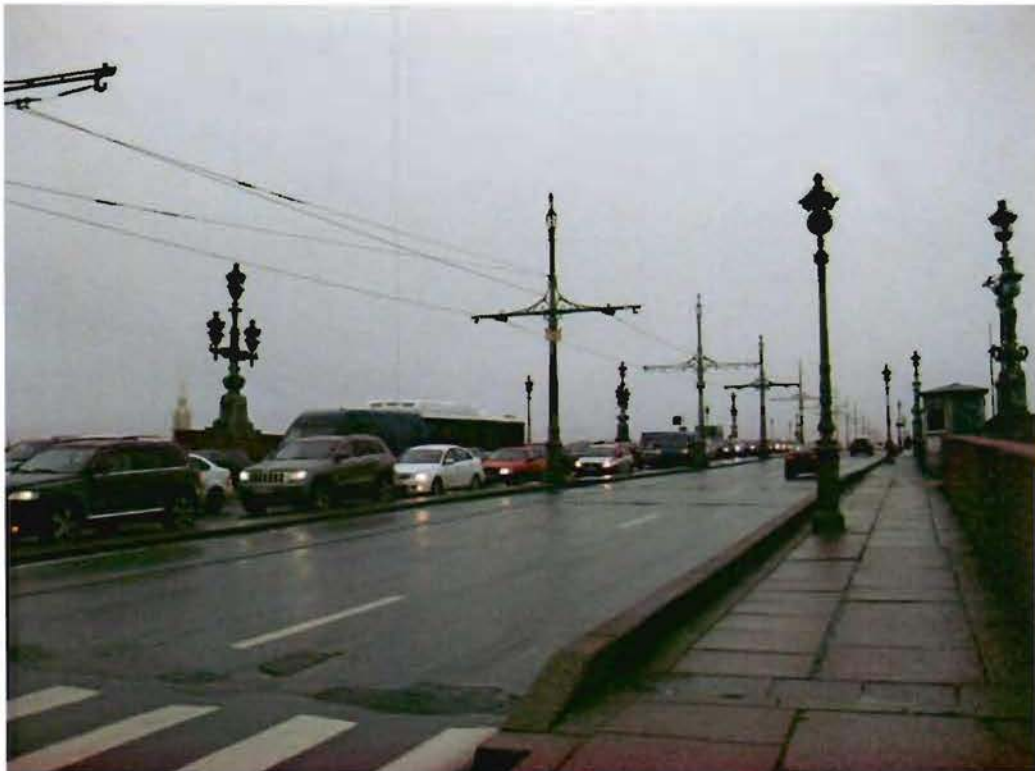
4. Вид на поверхность моста
