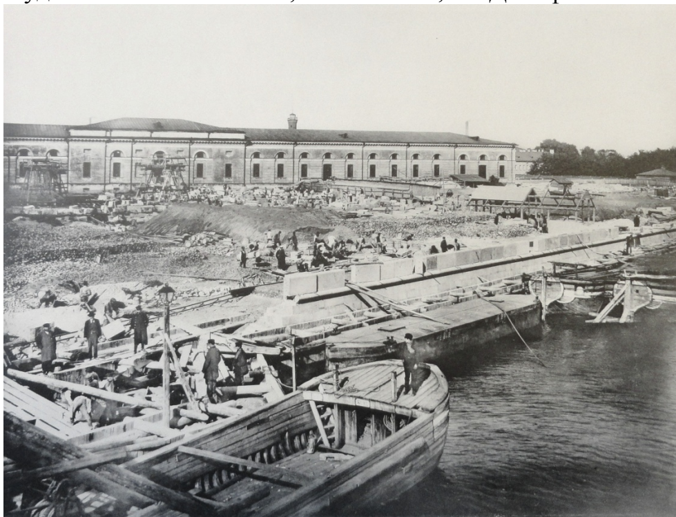
13. Строительство Петровской набережной. "Альбом работ по постройке постоянного через р. Большую Неву Троицкого моста, дамбы и набережных между Кронверкским и Сампсониевским мостами, 1897-1903", СПб, "Т-во "Художественной Печати", Английский, 28. Дата фото: 1902 г.
