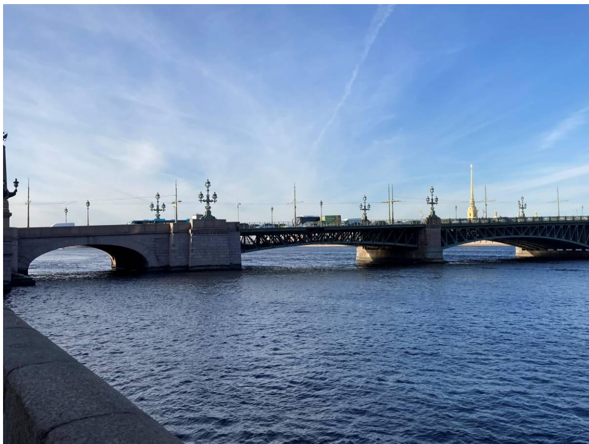
Фото 4. Вид объекта культурного наследия регионального значения «Кировский мост», вид с Дворцовой наб.
