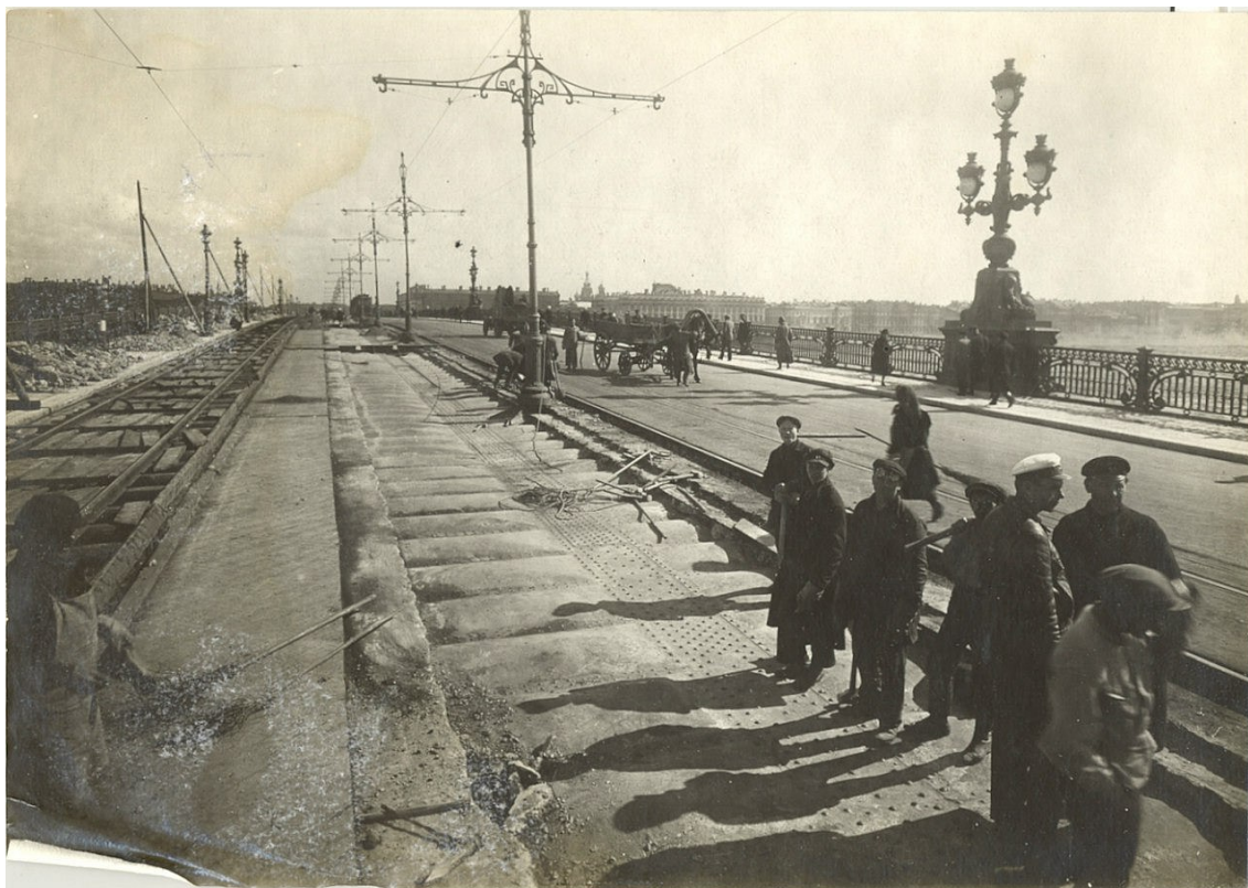
25. Ремонт покрытия на мосту Равенства. Дата фото: 1924-1931 гг. https://pastvu.com/p/479352
