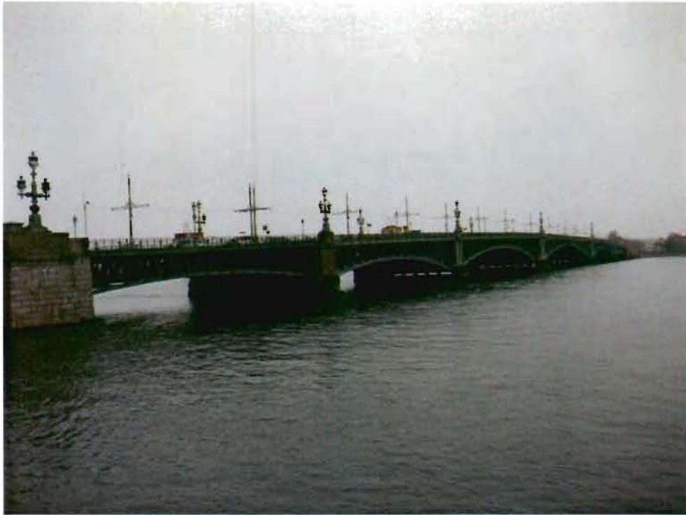
1. Вид на мост со стороны верхового фасада
