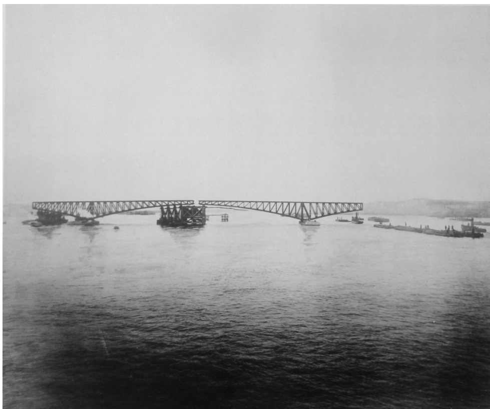
12. Строительство Троицкого моста. "Альбом работ по постройке постоянного через р. Большую Неву Троицкого моста, дамбы и набережных между Кронверкским и Сампсониевским мостами, 1897-1903", СПб, "Т-во "Художественной Печати", Английский, 28. Дата фото: 1900 г.
