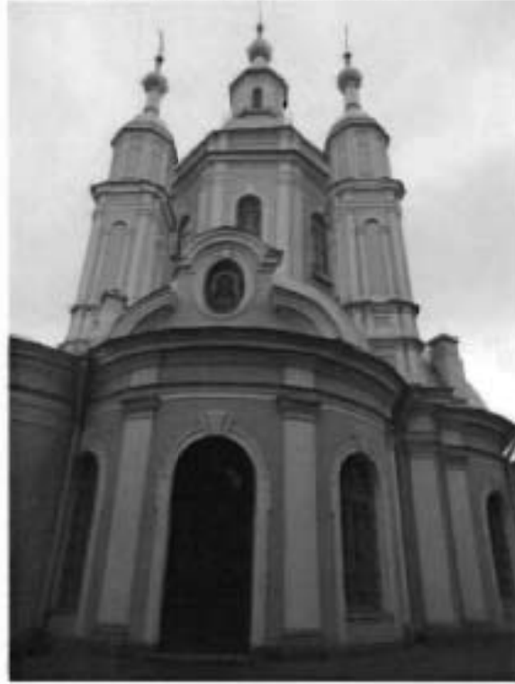
3. Фрагмент южной части фасада
