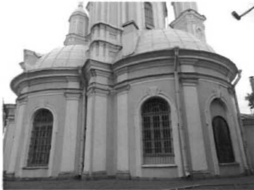
4. Фрагмент восточной части фасада
