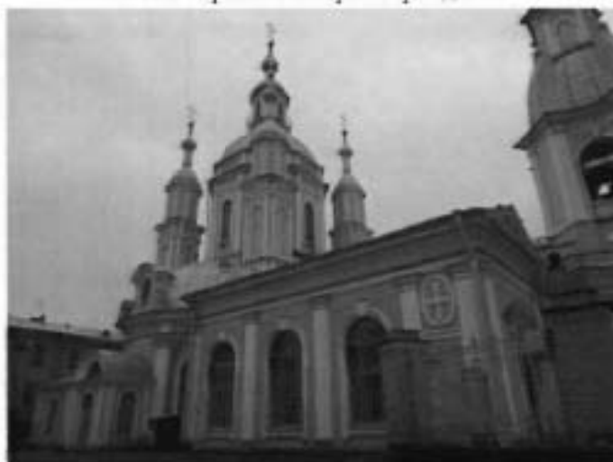
2. Фрагмент северного фасада
