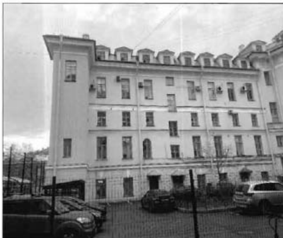
17. Юго-западный дворовый фасад со стороны Торгового переулка. Общий вид. Фото от 19.11.2021 г.
