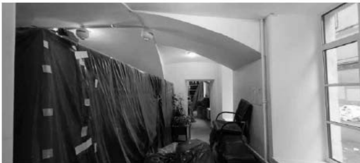
Фото 1.69. 1 этаж, помещение 2Н (17).
