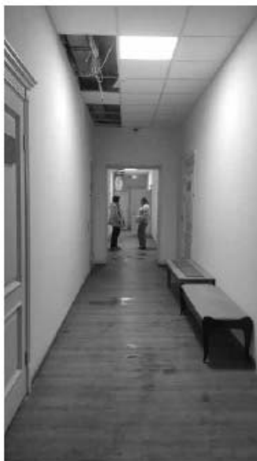
Фото 5.30. 5 этаж, помещение 79Н (7).
