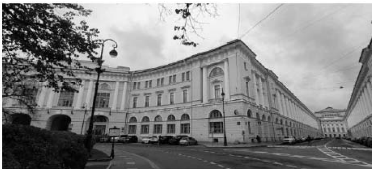
Фото 24. Южный фасад со стороны пл. Ломоносова. Фрагмент.
