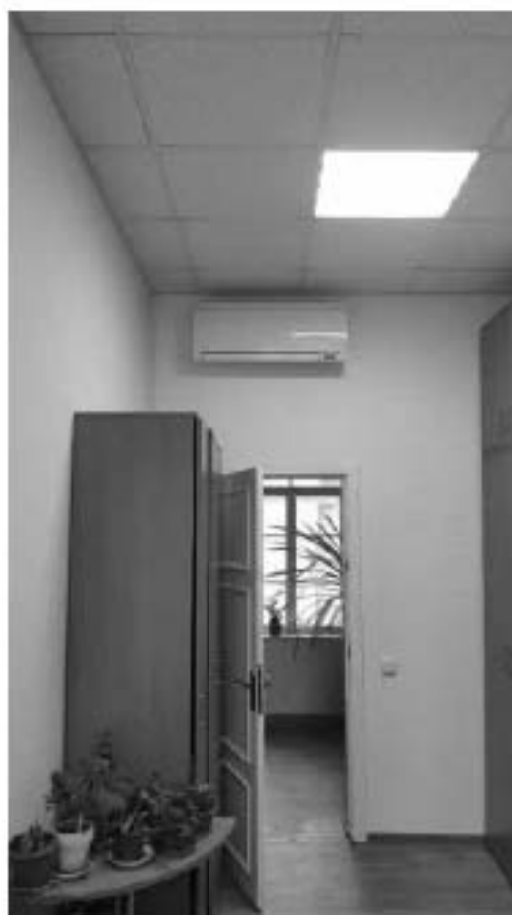
Фото 5.4. 5 этаж, помещение 62Н (7).
