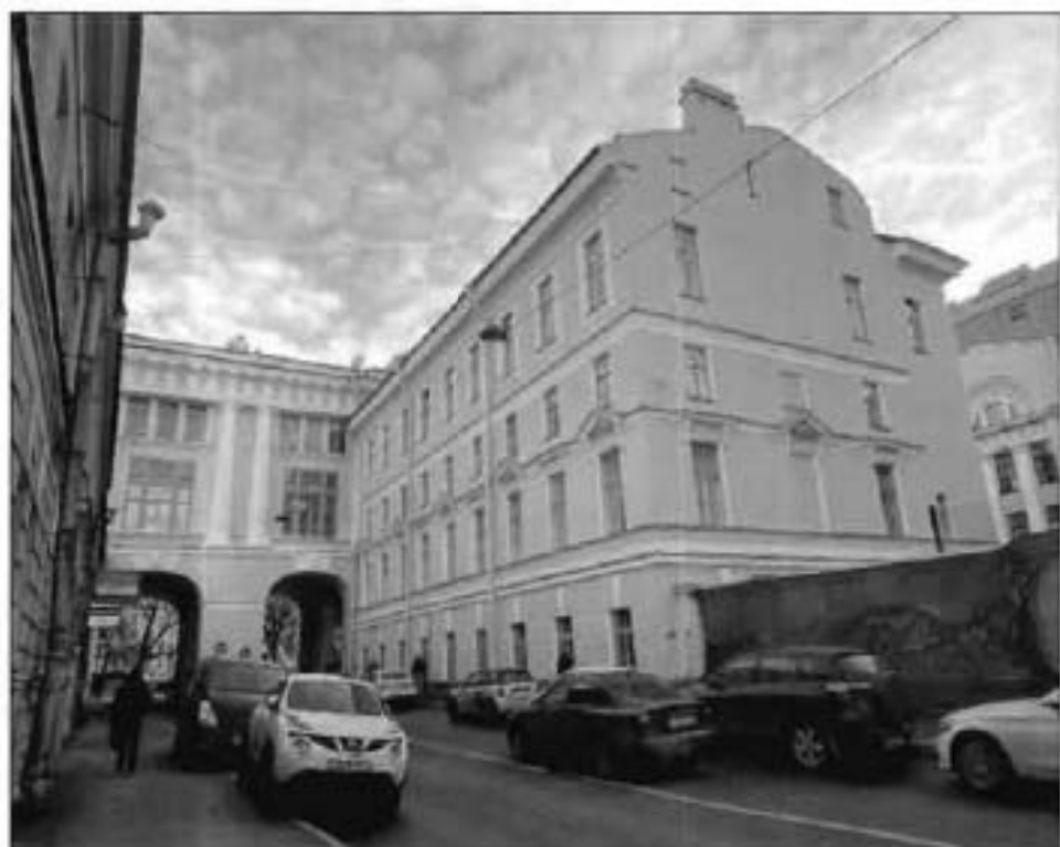
6. Северо-западный фасад центрального флигеля объекта культурного наследия, обращенного на улицу Ломоносова. Фото от 19.11.2021 г.
