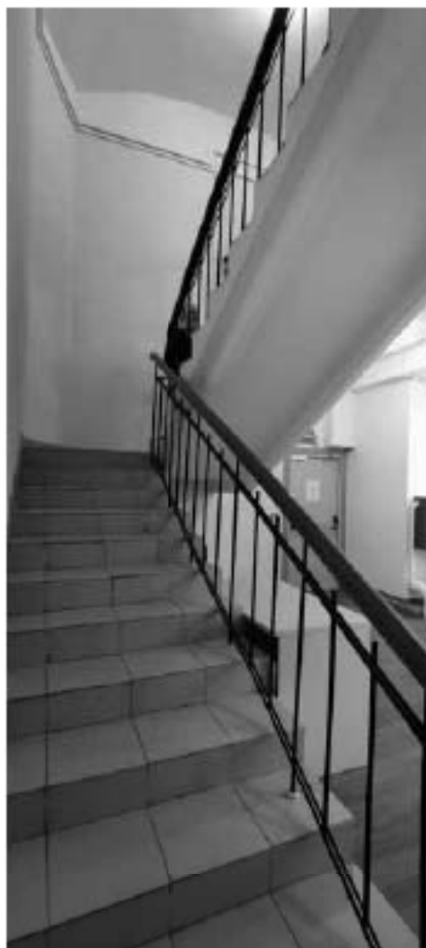
Фото 1.55. 1 этаж, лестница, помещение 2Н (15).
