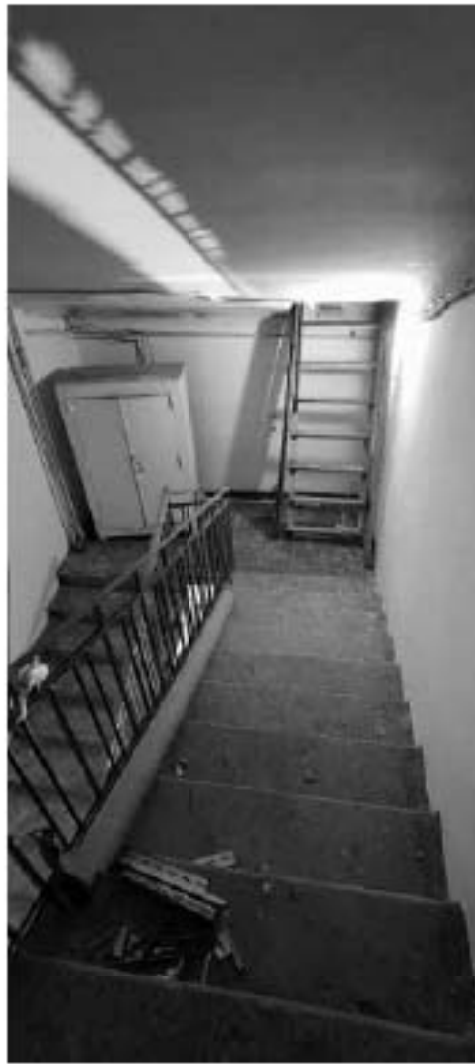
Фото ч.2. чердак, служебная лестница в северо-западной части здания.
