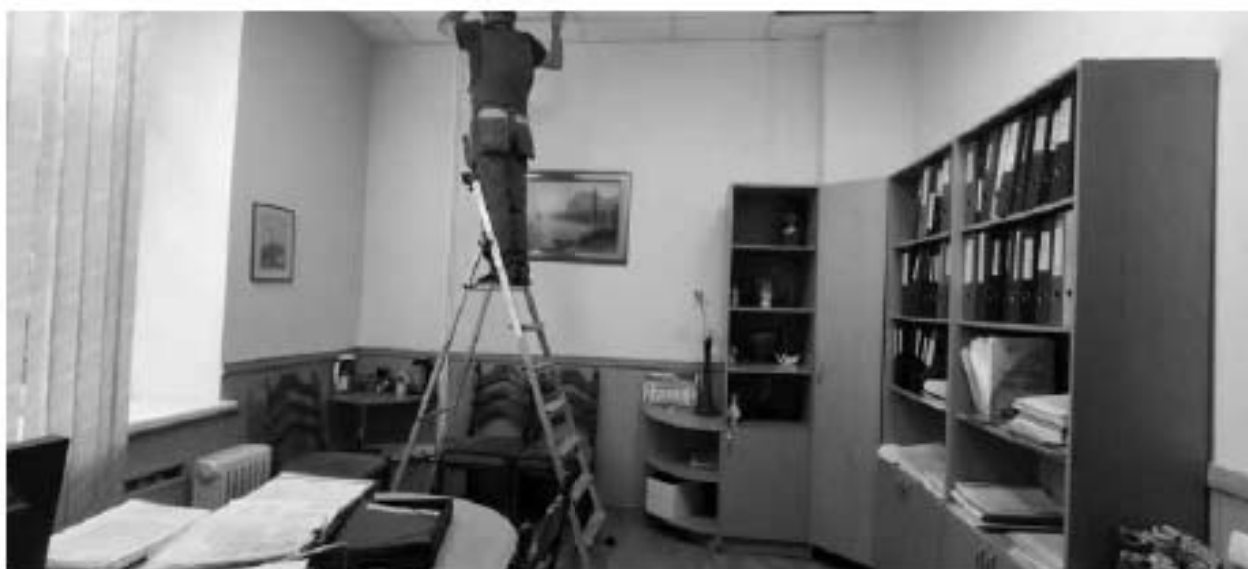
Фото 3.11. 3 этаж, помещение 60Н (7).
