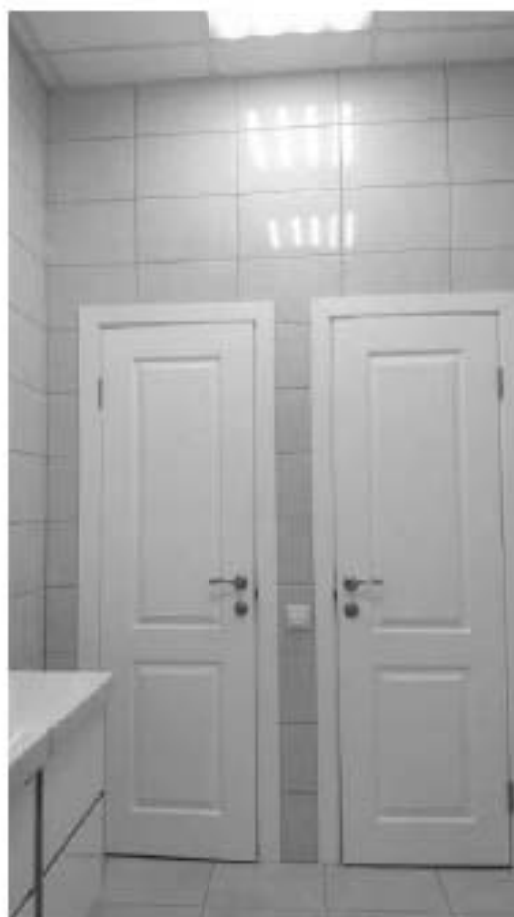
Фото 4.4. 4 этаж, помещение 72Н (21).
