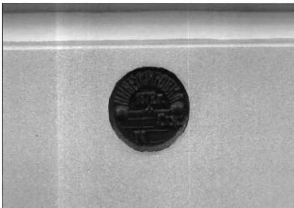
12. Исторический геодезический знак (металл, изображение, нивелировка, 1872 г.) размещенный со стороны лицевого фасада по улице Зодчего Росси. Фото от 19.11.2021 г.
