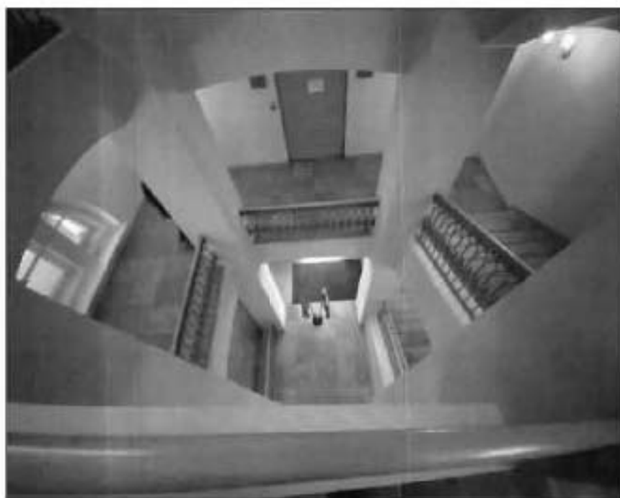
29. Парадная лестница (ЗЛК) со стороны пл. Ломоносова, многомаршевая, на пилонах по ползучим с распалубками и крестовым сводам на подпружных арках. Фото от 16.11.2021 г.
