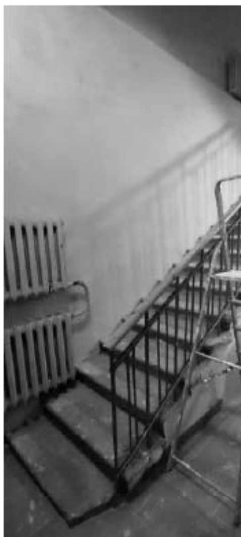
Фото 1.72. 1 этаж, служебная лестница в северо-западной части здания, помещение 15Н (1).
