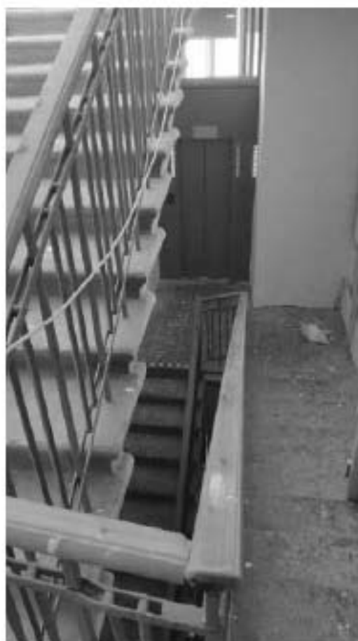
Фото 5.59. 5 этаж, служебная лестница в северо-западной части здания.
