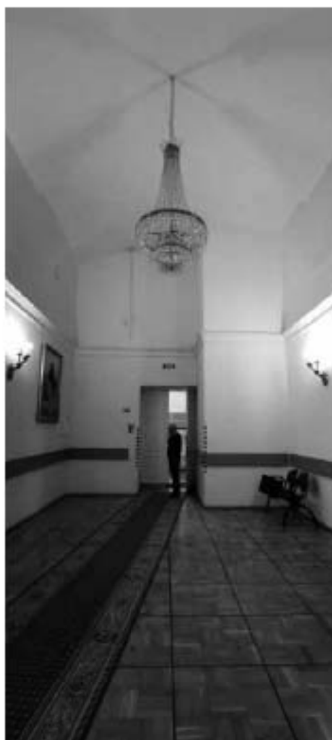
Фото 1.30. 1 этаж, помещение 1Н (1).
