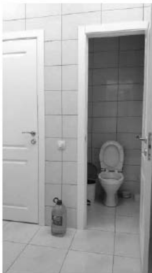
Фото 6.21. 6 этаж, помещение 86Н (19).
