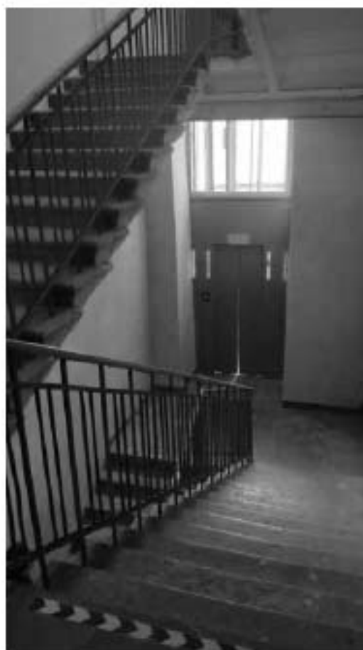
Фото 4.32. 4 этаж, служебная лестница в северо-западной части здания.
