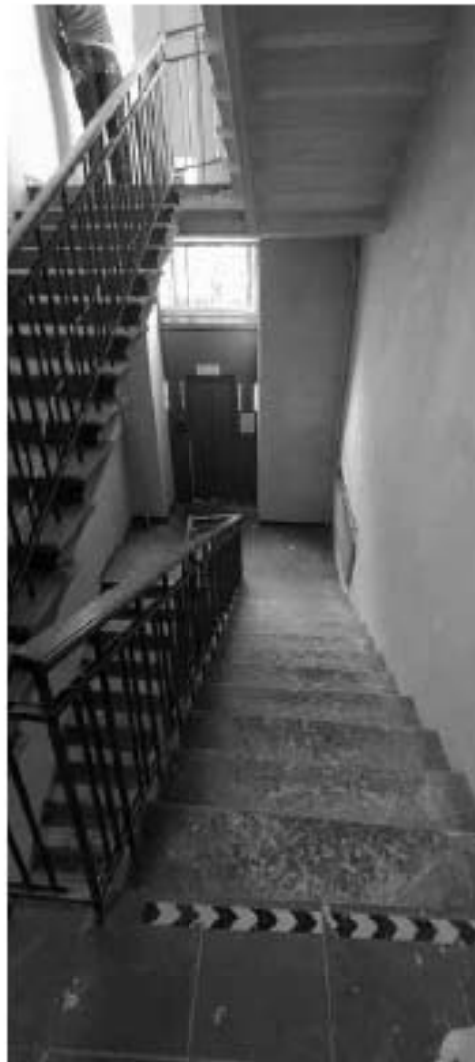
Фото 3.16. 3 этаж, служебная лестница в северо-западной части здания.
