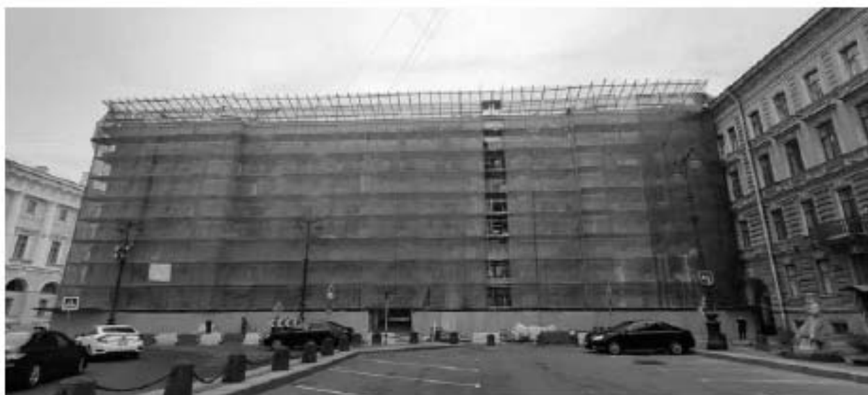
Фото 16. Северный фасад со стороны пл. Островского.
