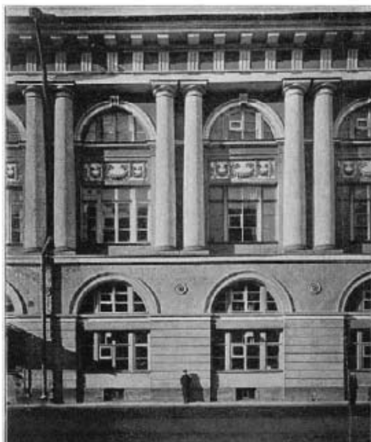
Илл. 35. Часть фасада здания на Театральной улице. Дата съёмки: [начало 1900-х гг.]. Автор съёмки не установлен // ЦГАКФФД СПб. Фотодокумент А 10908
