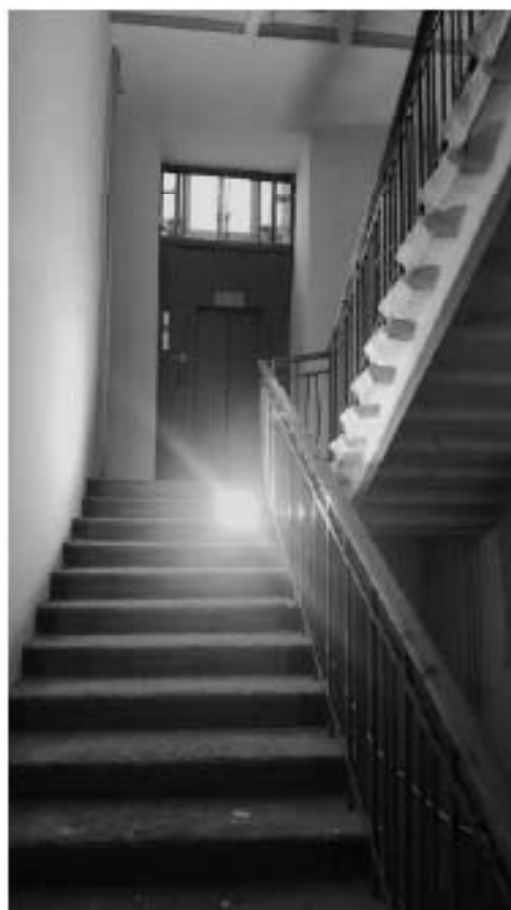
Фото 5.58. 5 этаж, служебная лестница в северо-западной части здания.
