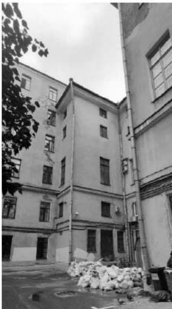
Фото 6. Дворовый фасад, вид на запад. Фрагмент.
