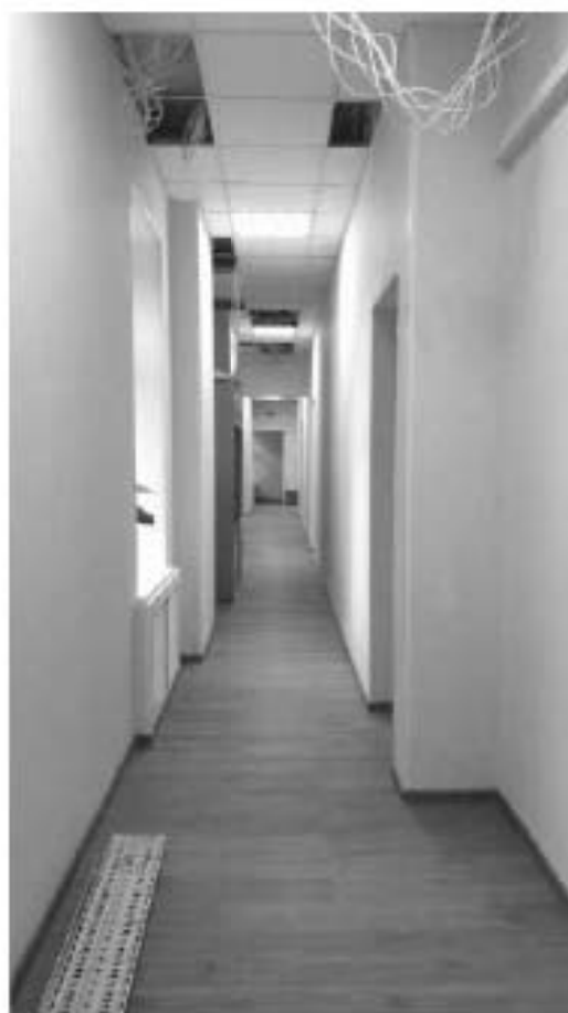
Фото 4.34. 4 этаж, помещение 61Н (7).
