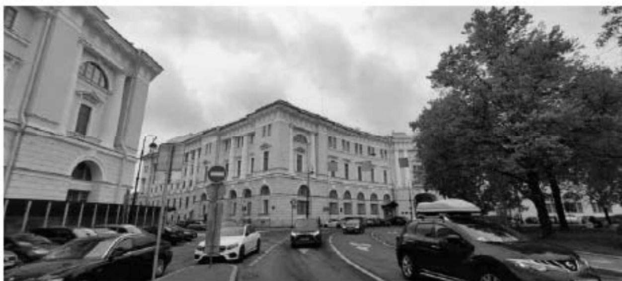
Фото 26. Южный фасад со стороны пл. Ломоносова. Фрагмент.
