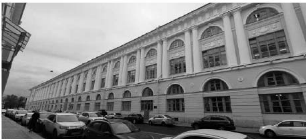
Фото 19. Лицевой фасад с ул. Зодчего Росси. Фрагмент.
