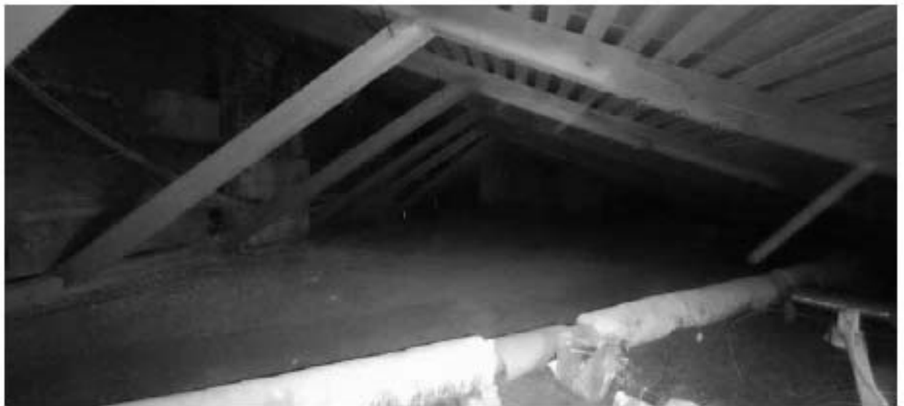
Фото ч.3. Чердак, общий вид.
