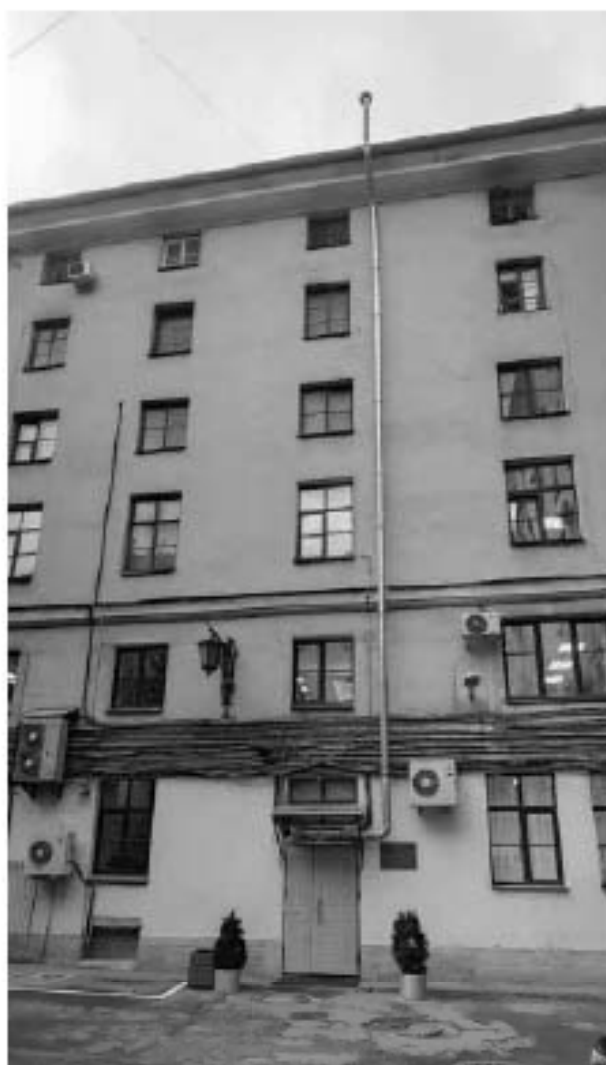
Фото 12. Дворовый фасад, вид на восток. Фрагмент.
