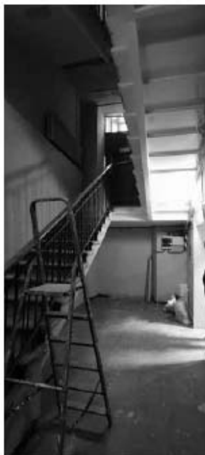
Фото 1.71. 1 этаж, служебная лестница в северо-западной части здания, помещение 15Н (1).
