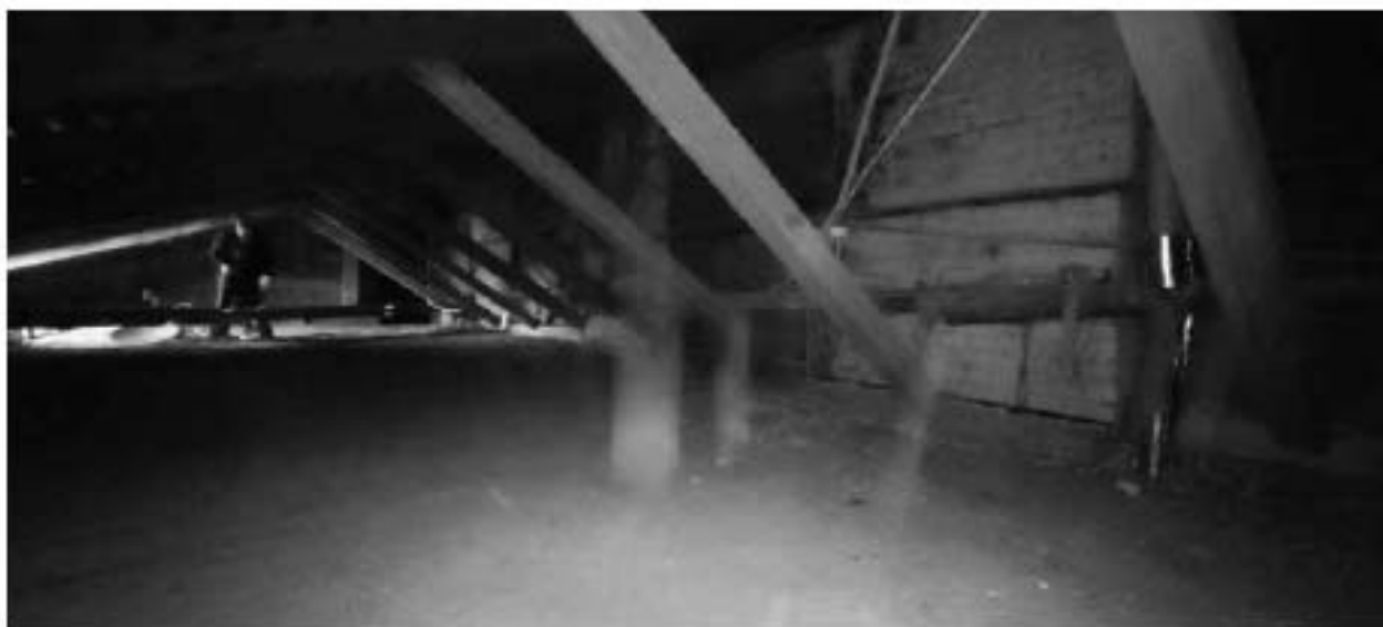
Фото ч.11. Чердак, общий вид.
