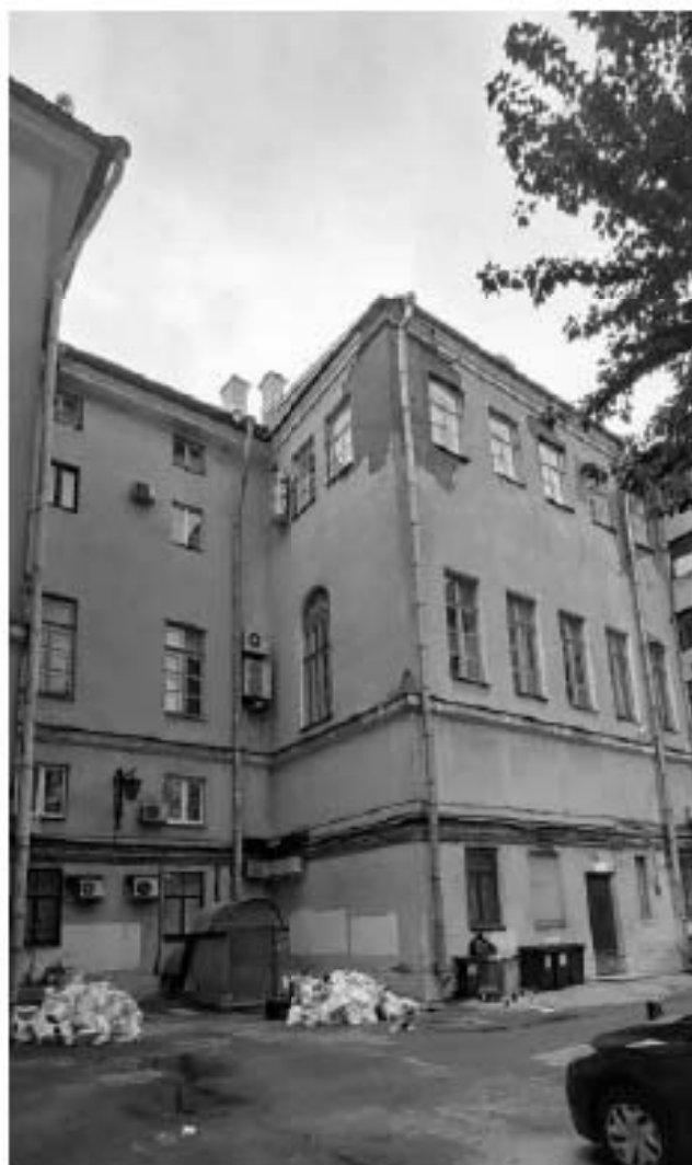
Фото 2. Дворовый фасад, вид на северо-восток. Фрагмент.
