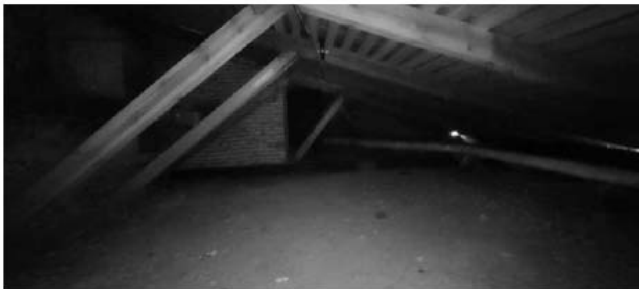
Фото ч.6. Чердак, общий вид.
