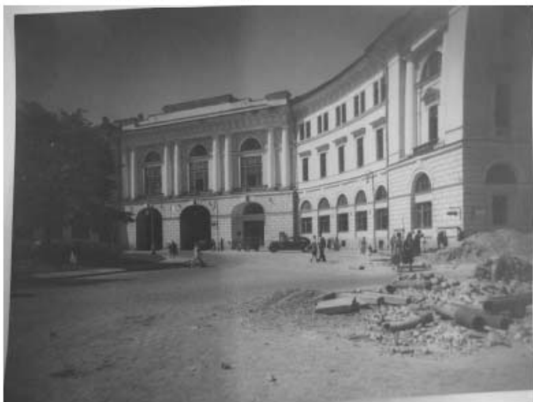
Илл. 48. Площадь Ломоносова (Чернышёва). 1828-1834 гг. г. Санкт-Петербург (Ленинград). Площадь Ломоносова, 1828-1834 гг. Росси Карл Иванович. Административное здание с арочным проездом. Фрагмент. Период создания: 1947 г. // https://goskatalog.ru/portal/#/collections?id=8328771
