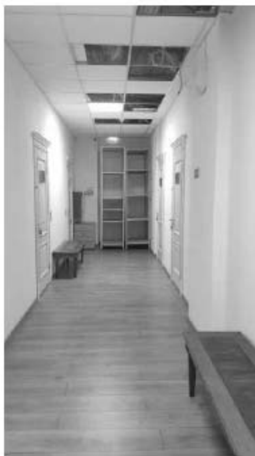
Фото 4.30. 4 этаж, помещение 72Н (8).
