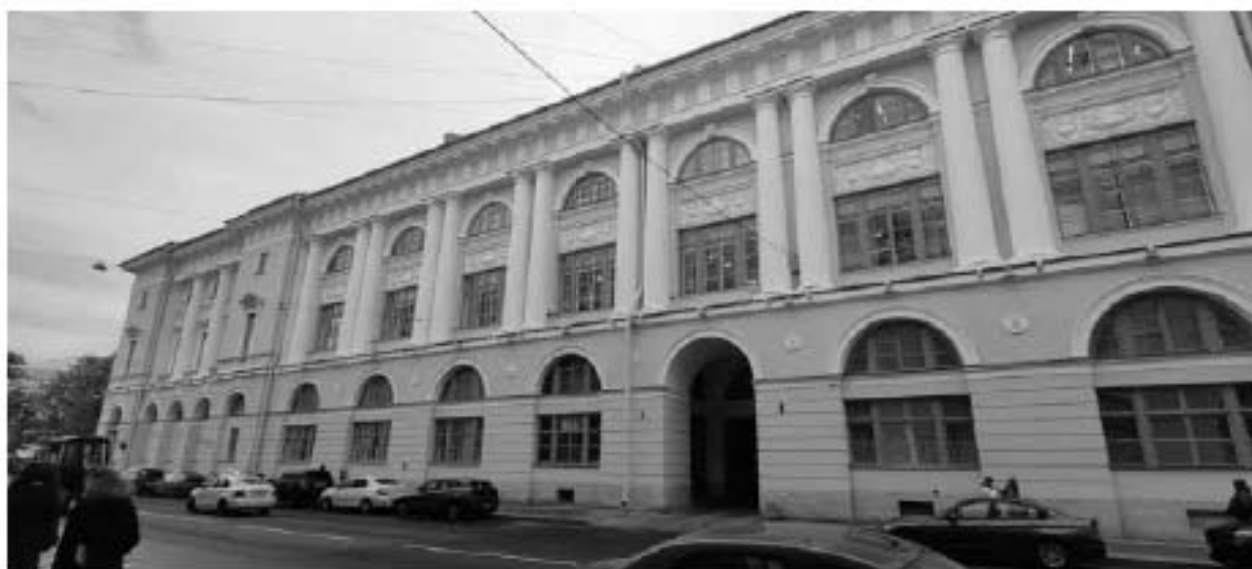
Фото 21. Лицевой фасад с ул. Зодчего Росси. Фрагмент.
