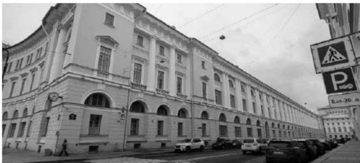
Фото 23. Лицевой фасад с ул. Зодчего Росси. Фрагмент.
