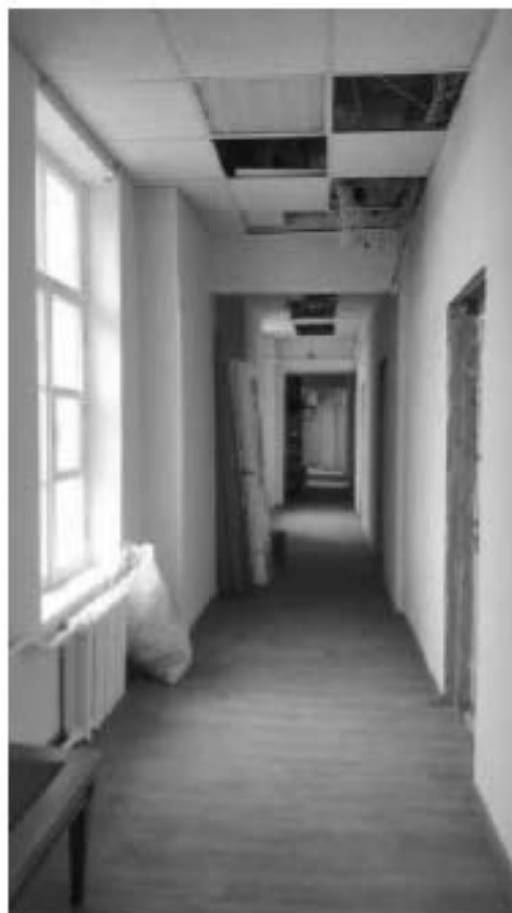
Фото 6.1. 6 этаж, помещение 75Н (1).
