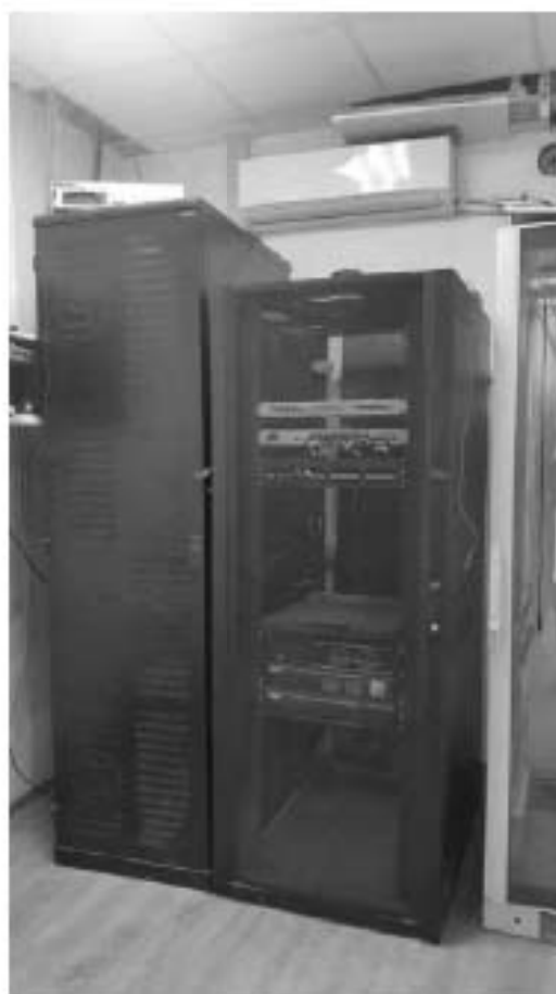
Фото 4.8. 4 этаж, помещение 72Н (3).
