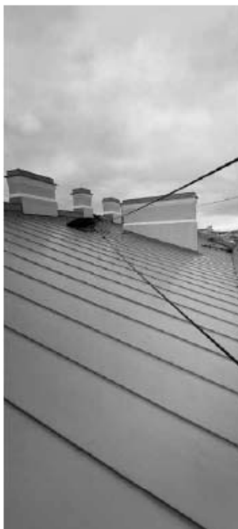
Фото ч.14. Кровля, общий вид.
