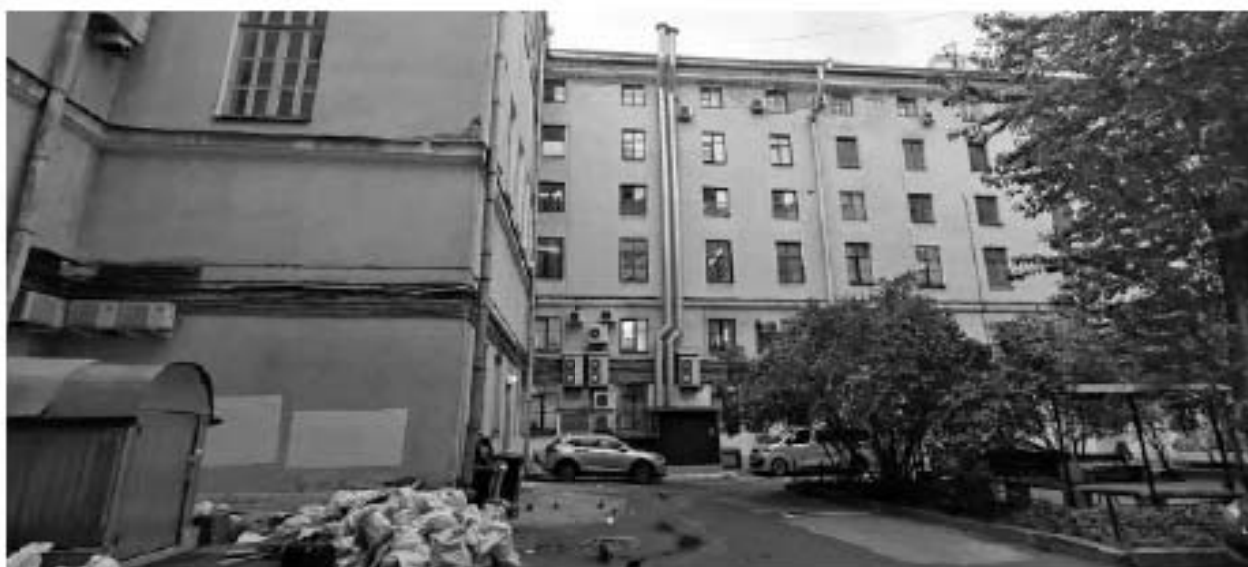
Фото 3. Дворовый фасад, вид на восток. Фрагмент.
