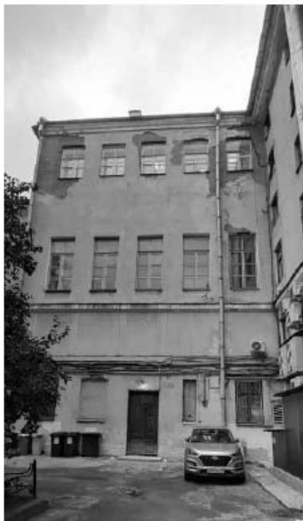
Фото 8. Дворовый фасад, вид на северо-восток. Фрагмент.
