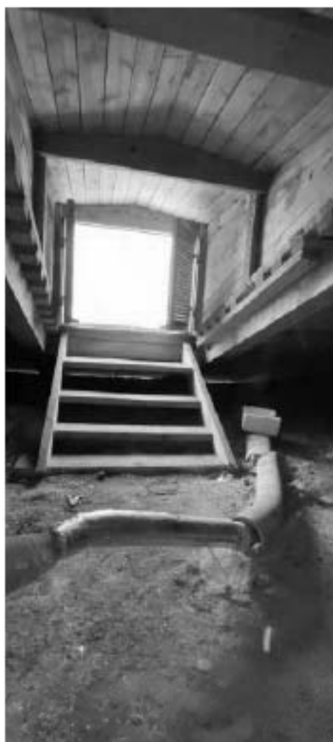
Фото ч.12. Чердак, слуховое окно.
