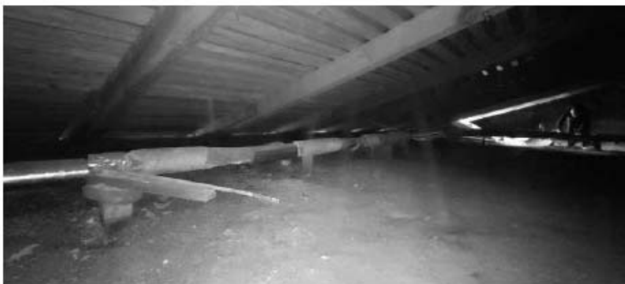
Фото ч.10. Чердак, общий вид.
