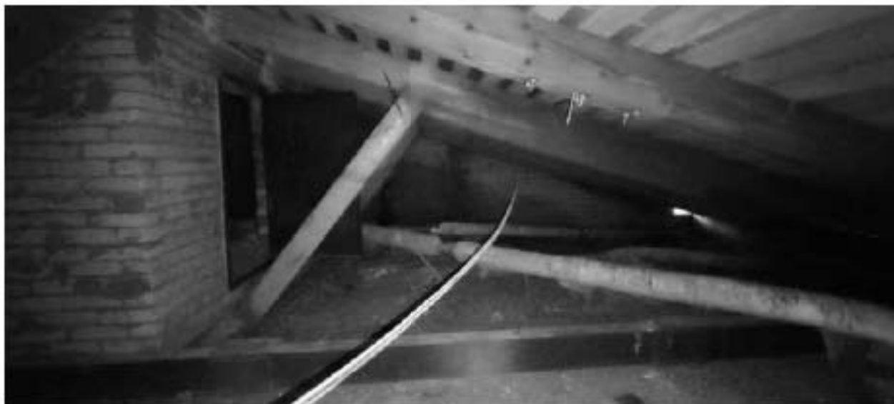
Фото ч.7. Чердак, общий вид.
