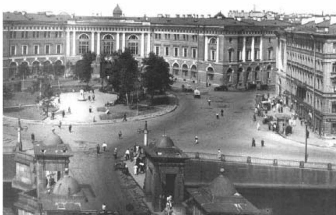
Илл. 46. Вид площади Чернышева и части моста через реку Фонтанку. Дата съёмки: 1939 г. Автор съёмки не установлен. // ЦГАКФФД СПб. Фотодокумент Гр 50063
