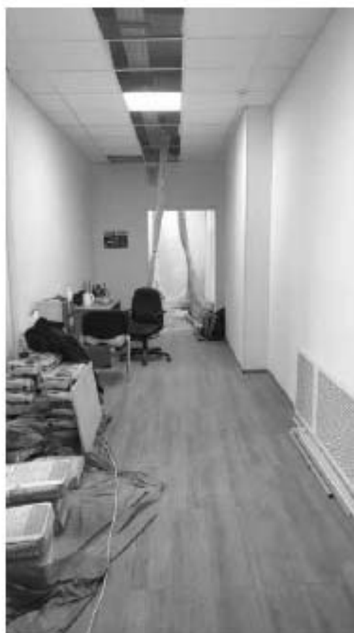
Фото 5.23. 5 этаж, помещение 79Н (1).
