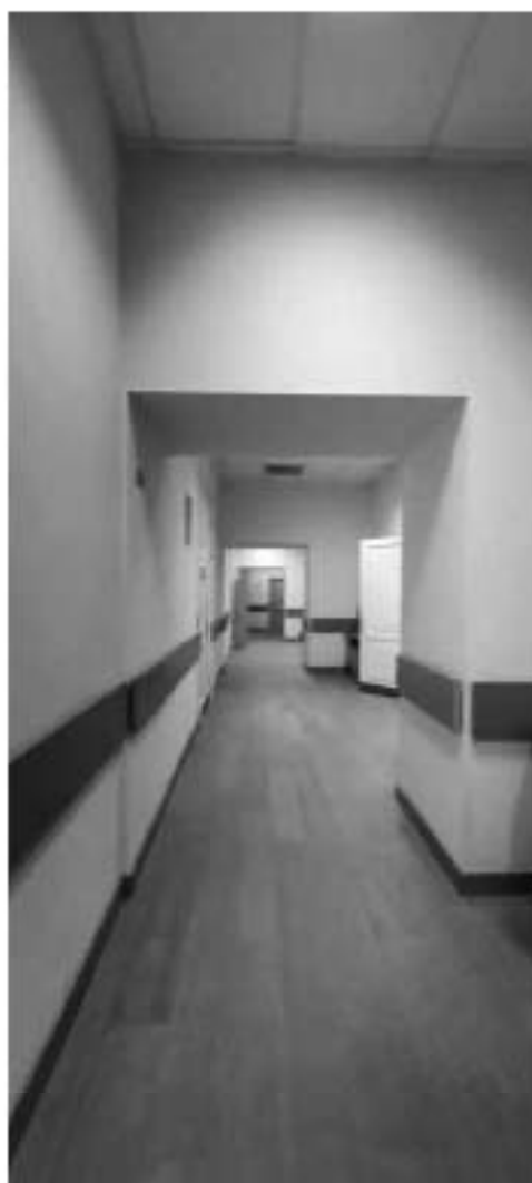
Фото 1.21. 1 этаж, помещение 1Н (13).
