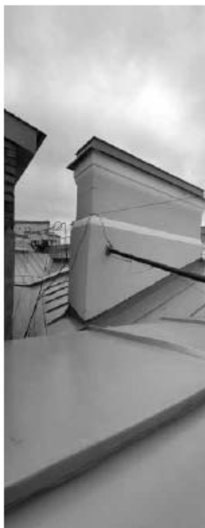
Фото ч.15. Кровля, общий вид.
