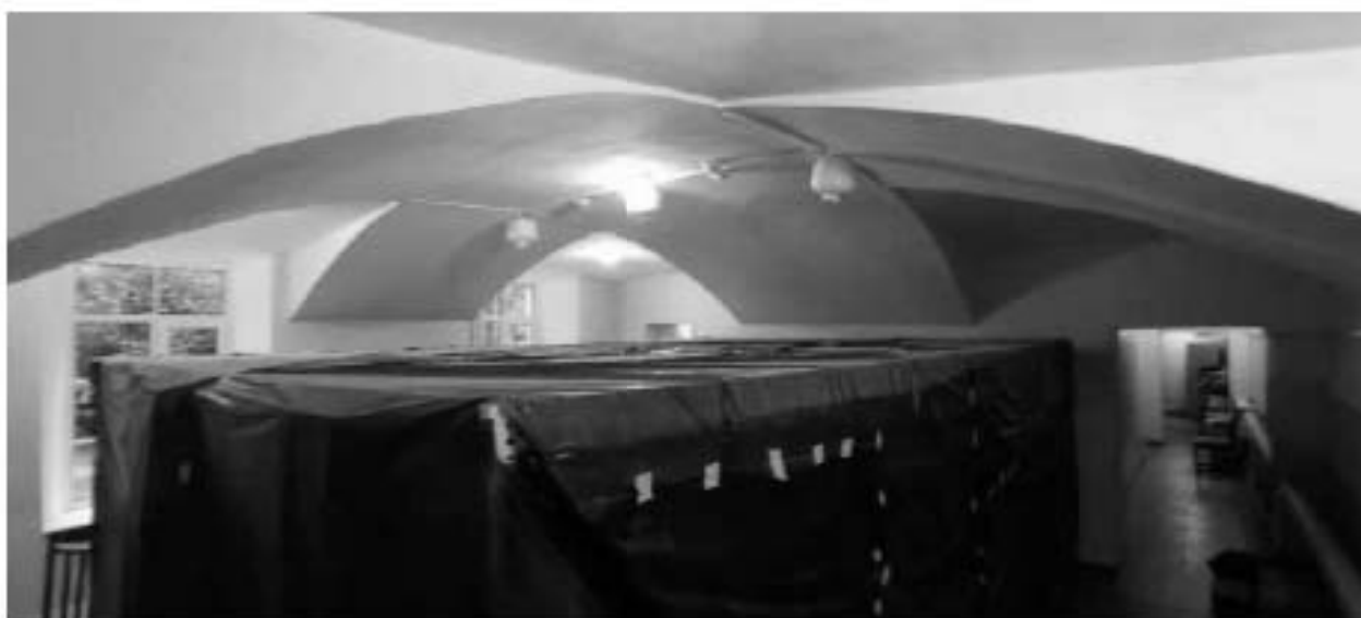
Фото 1.63. 1 этаж, помещение 2Н (17).
