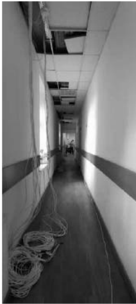
Фото 3.3. 3 этаж, помещение 60Н (1).
