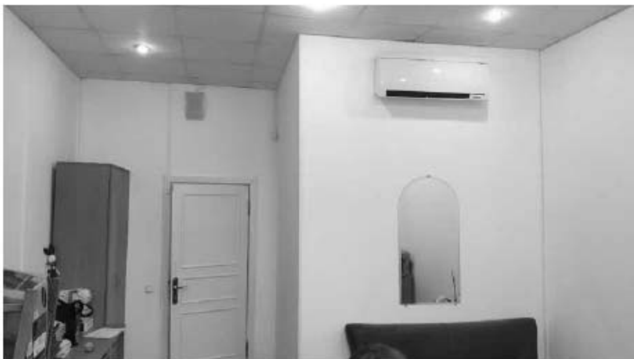
Фото 6.11. 6 этаж, помещение 75Н (7).
