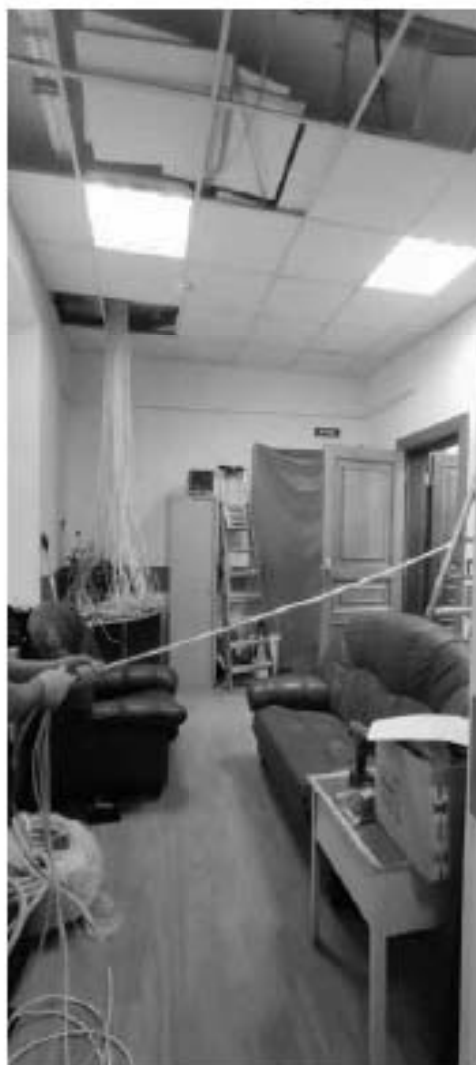
Фото 3.14. 3 этаж, помещение 60Н (3).
