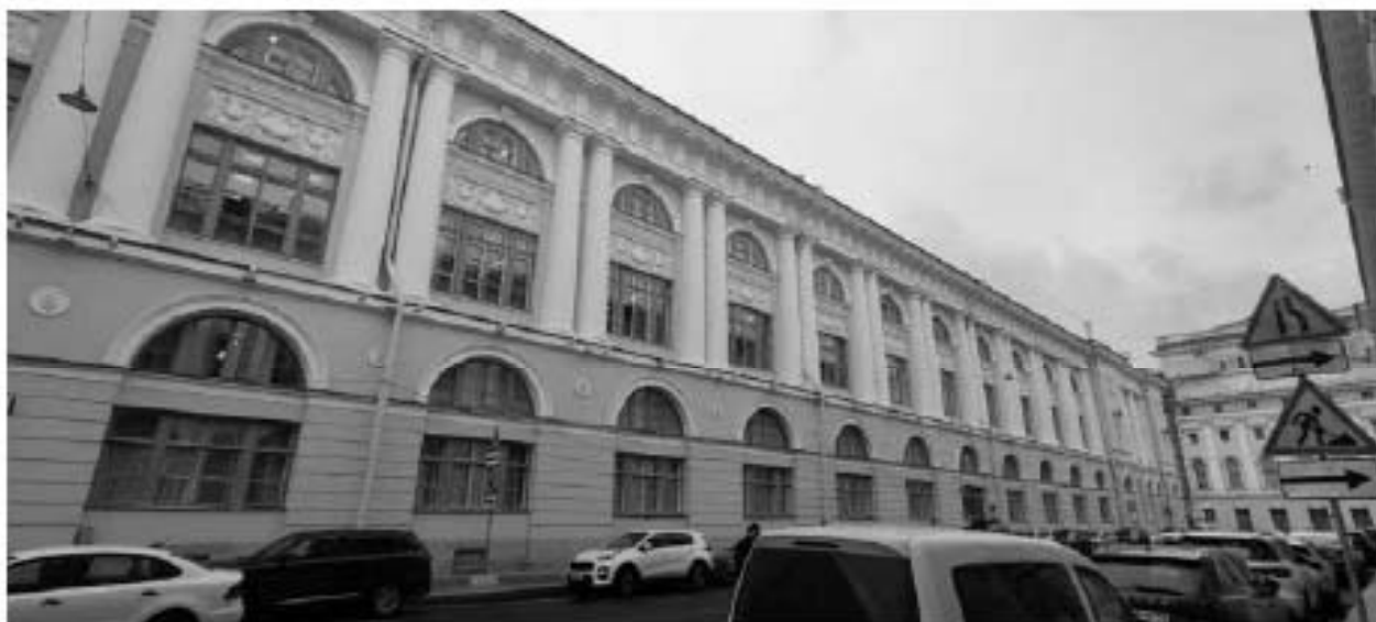
Фото 20. Лицевой фасад с ул. Зодчего Росси. Фрагмент.
