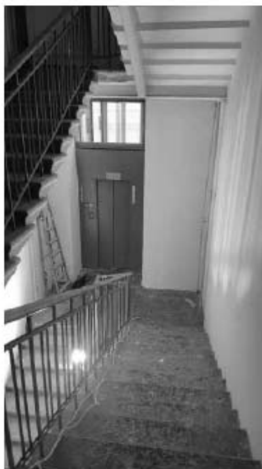
Фото 6.15. 6 этаж, служебная лестница в северо-западной части здания.
