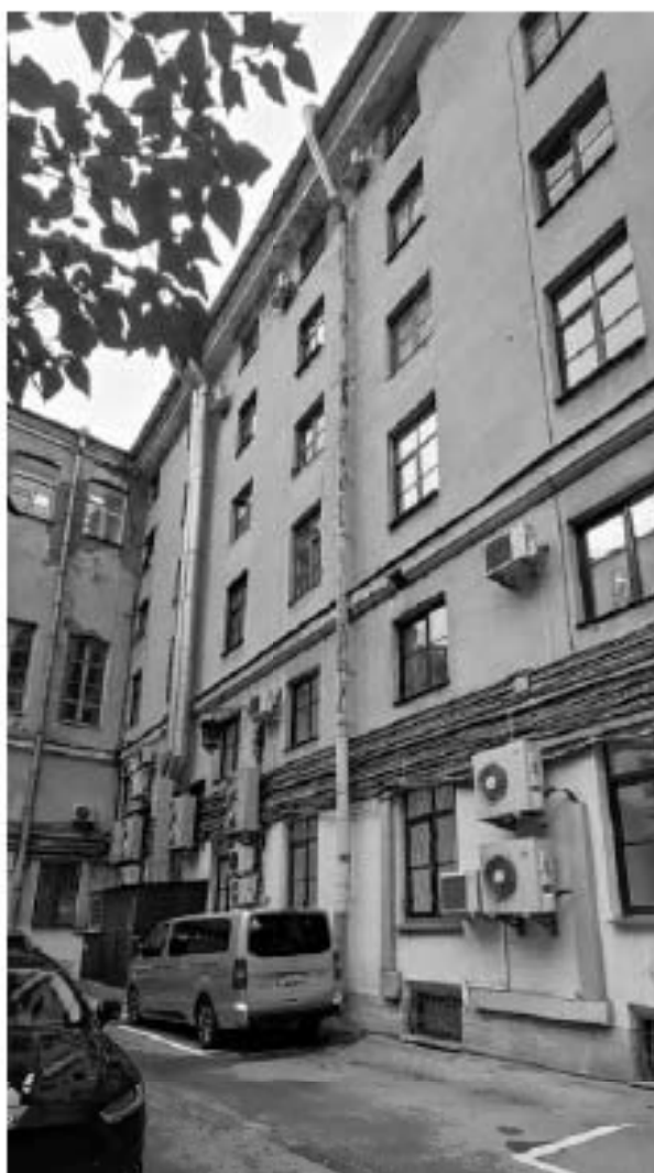
Фото 9. Дворовый фасад, вид на северо-восток. Фрагмент.
