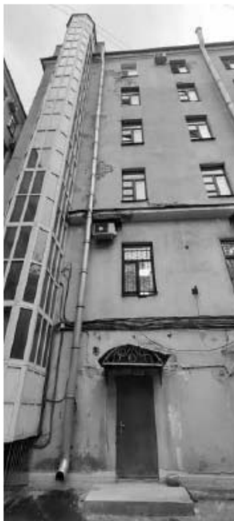
Фото 15. Дворовый фасад, вид на запад. Фрагмент.
