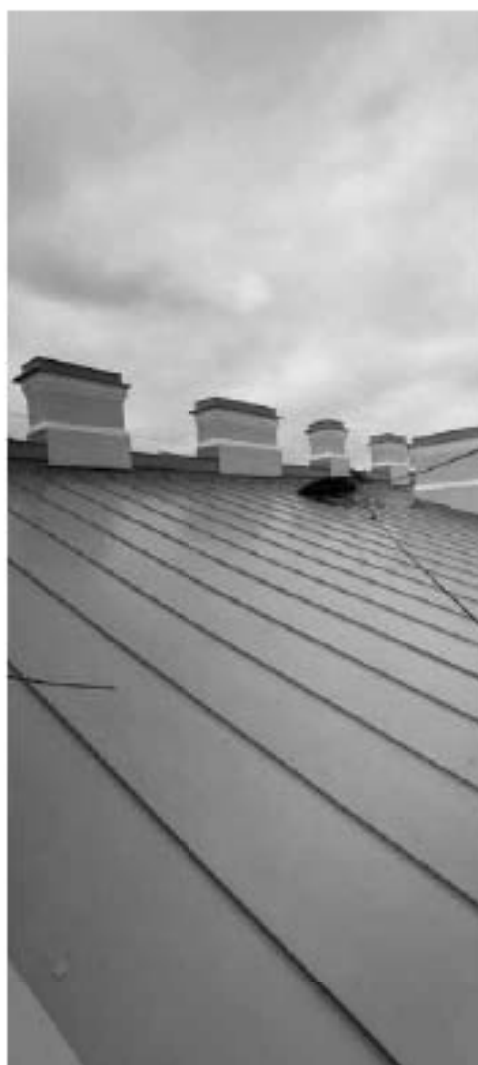
Фото ч.16. Кровля, общий вид.
