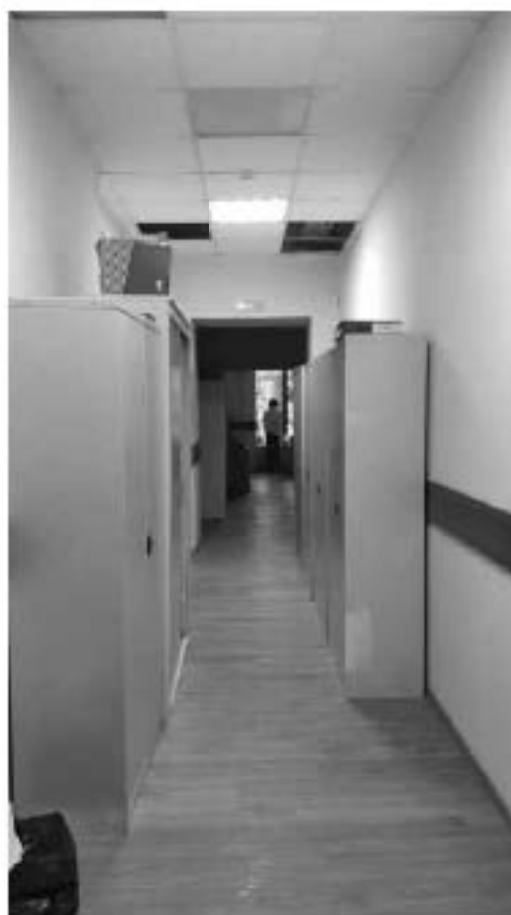
Фото 6.32. 6 этаж, помещение 86Н (8).
