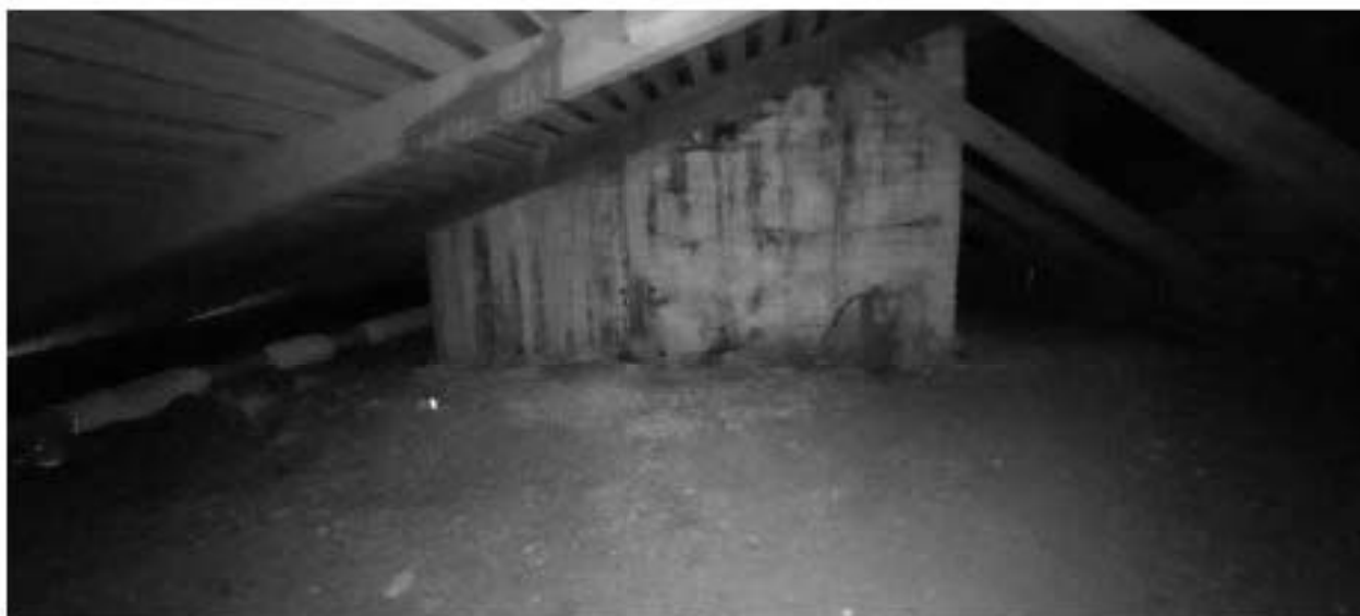
Фото ч.9. Чердак, общий вид.
