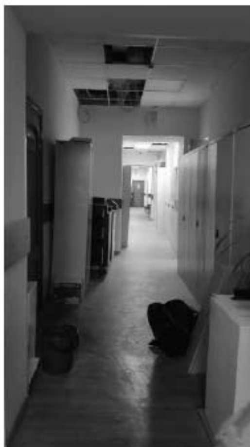
Фото 6.19. 6 этаж, помещение 86Н (1).
