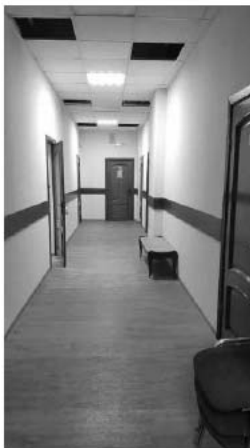
Фото 6.33. 6 этаж, помещение 86Н (8).
