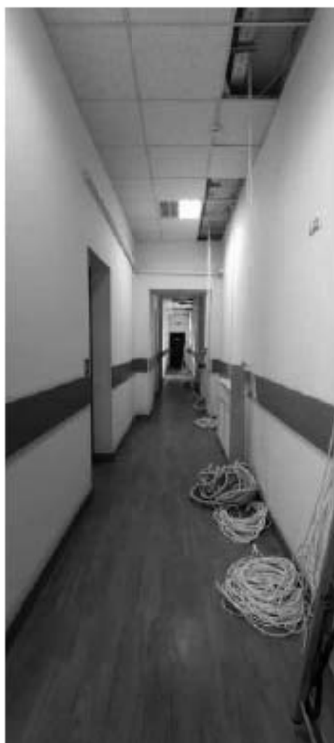
Фото 3.15. 3 этаж, помещение 60Н (2).
