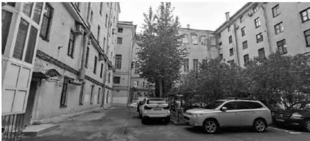
Фото 1. Дворовый фасад, вид на север.
