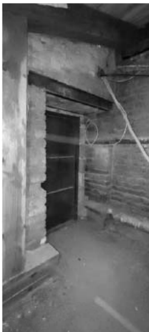
Фото ч.13. Чердак, общий вид.
