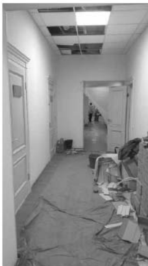
Фото 5.25. 5 этаж, помещение 79Н (7).
