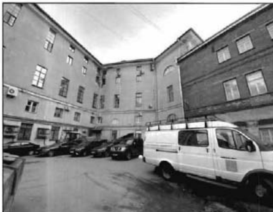
18. Дворовые фасады (южный двор по ул. Зодчего Росси). Фото от 09.11.2021 г.
