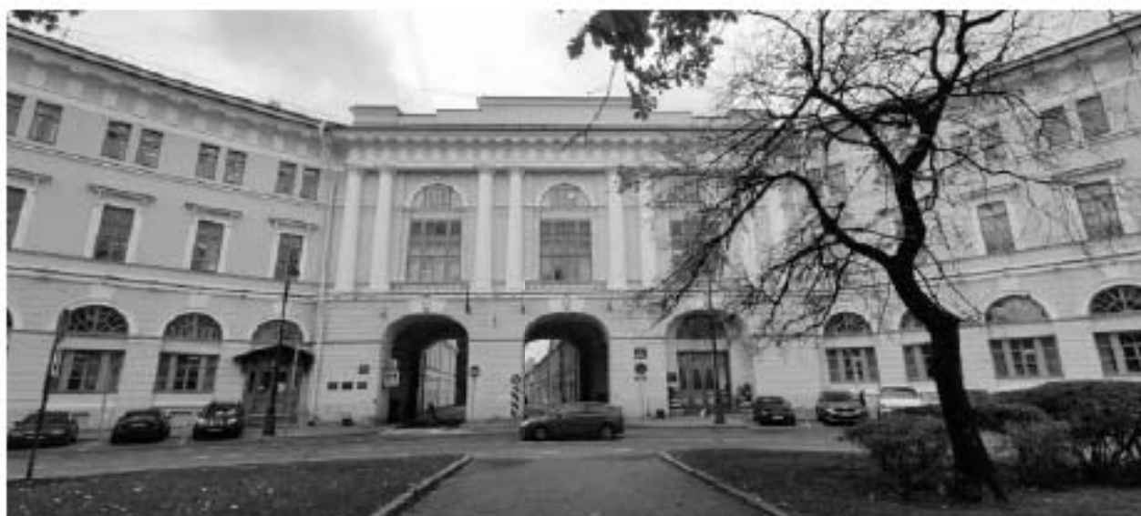
Фото 25. Южный фасад со стороны пл. Ломоносова. Фрагмент.
