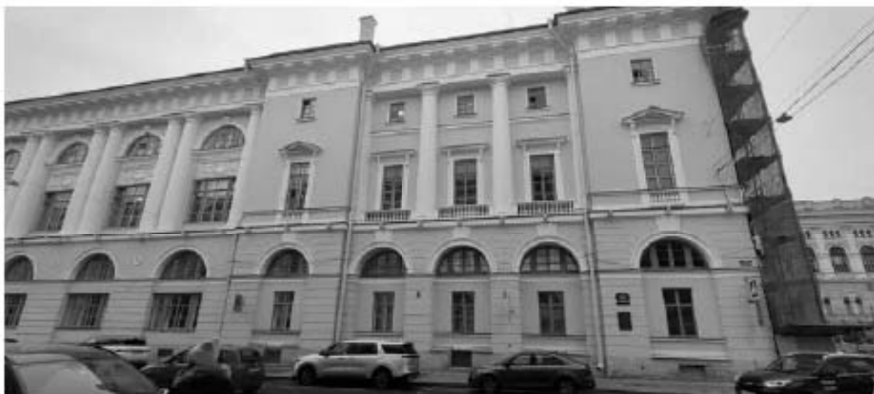
Фото 18. Лицевой фасад с ул. Зодчего Росси. Фрагмент.
