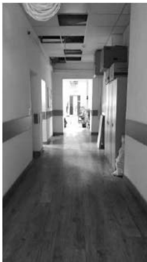
Фото 5.19. 5 этаж, помещение 62Н (9).
