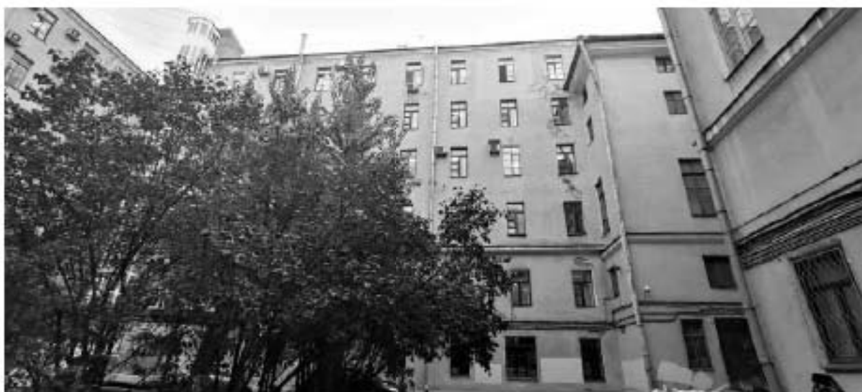
Фото 5. Дворовый фасад, вид на запад. Фрагмент.
