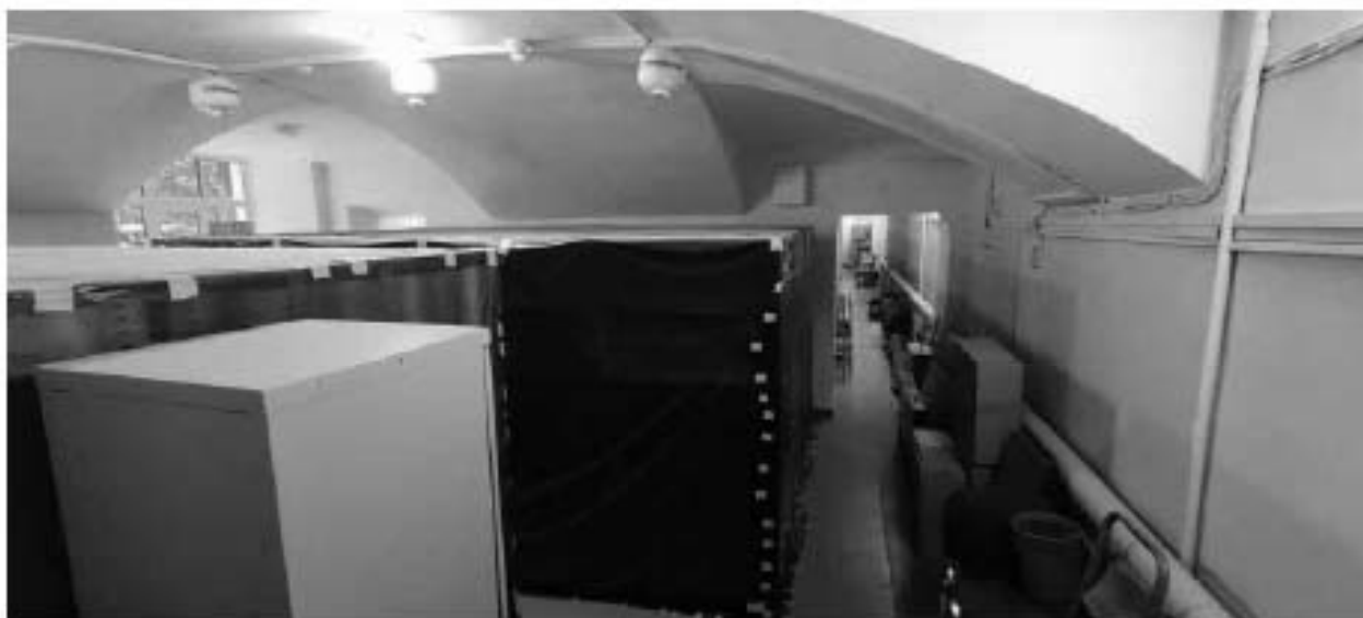
Фото 1.62. 1 этаж, помещение 2Н (16).
