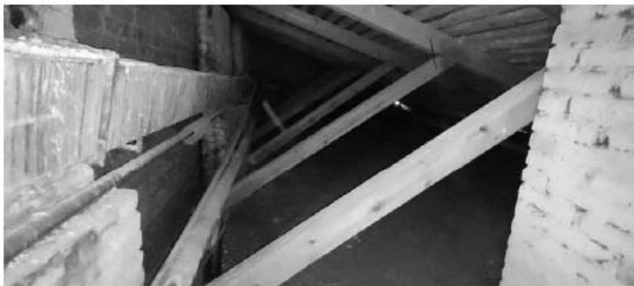
Фото ч.5. Чердак, общий вид.
