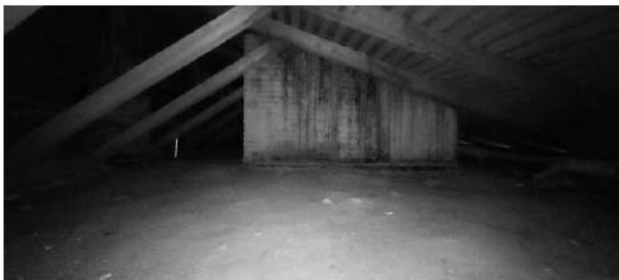
Фото ч.4. Чердак, общий вид.
