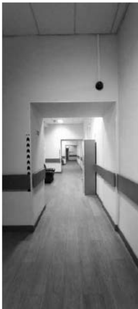
Фото 1.15. 1 этаж, помещение 1Н (22).
