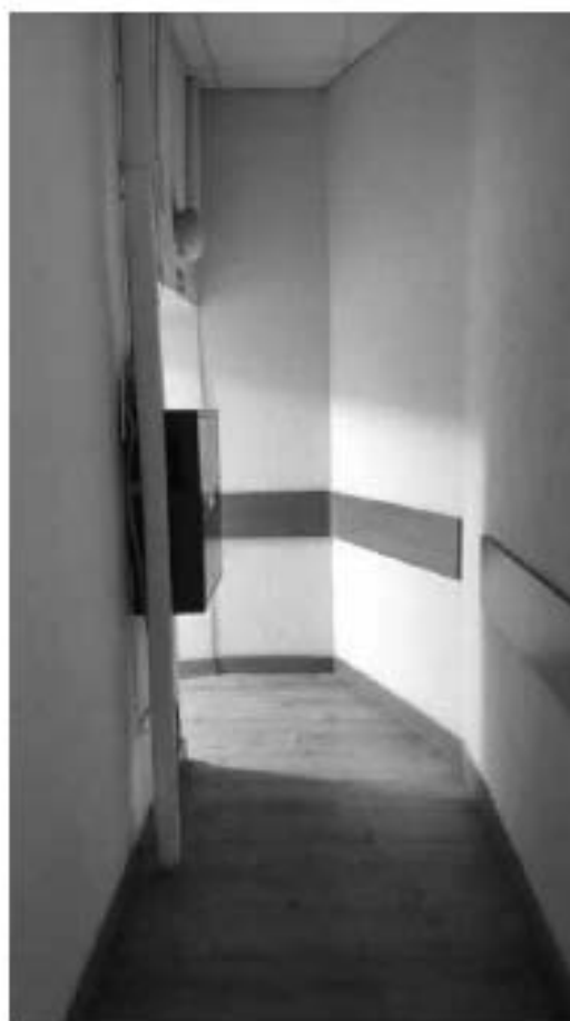
Фото 5.21. 5 этаж, помещение 62Н (10).
