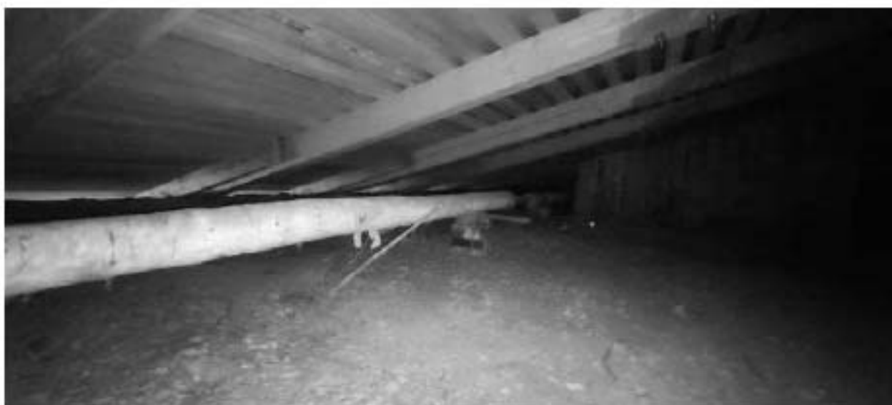
Фото ч.8. Чердак, общий вид.
