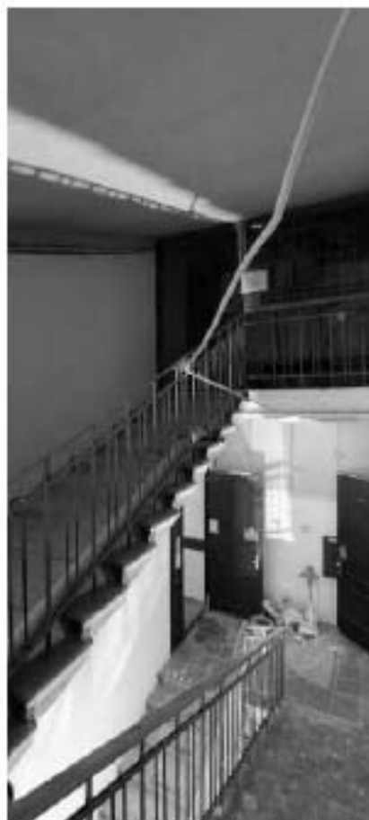
Фото ч.1. чердак, служебная лестница в северо-западной части здания.
