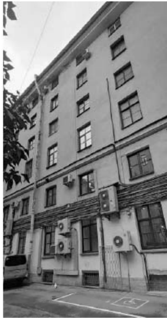
Фото 10. Дворовый фасад, вид на северо-восток. Фрагмент.
