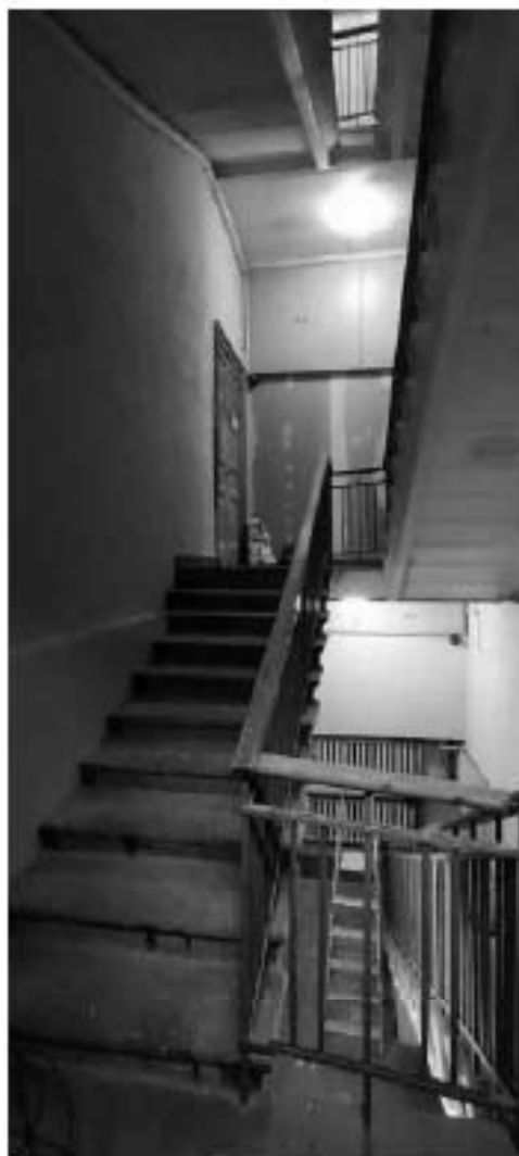
Фото 2.1. 2 этаж, служебная лестница в северо-западной части здания.
