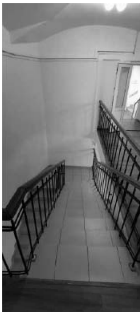
Фото 2.10. 2 этаж, лестница, помещение 2Н (24).
