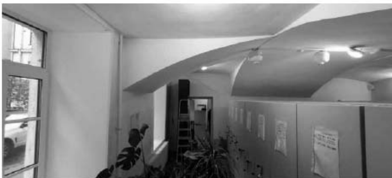
Фото 1.68. 1 этаж, помещение 2Н (18).
