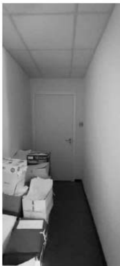
Фото 6.56. 6 этаж, помещение 63Н (5).
