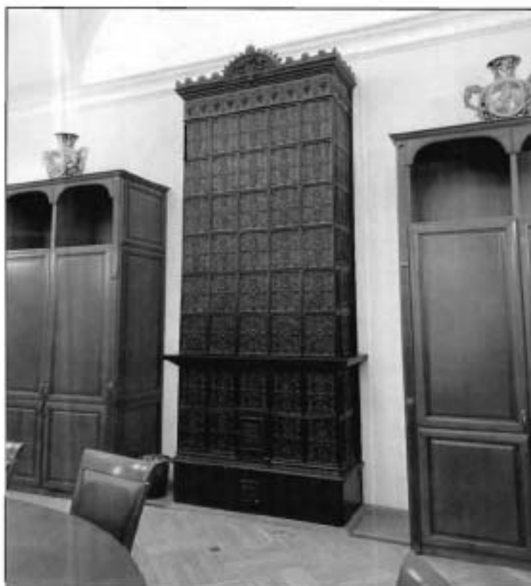
49. Печь средистенная, двухъярусная, облицована темно-коричневым рельефным изразцом (пом. (27-Н (3)). Фото от 16.11.2021 г.
