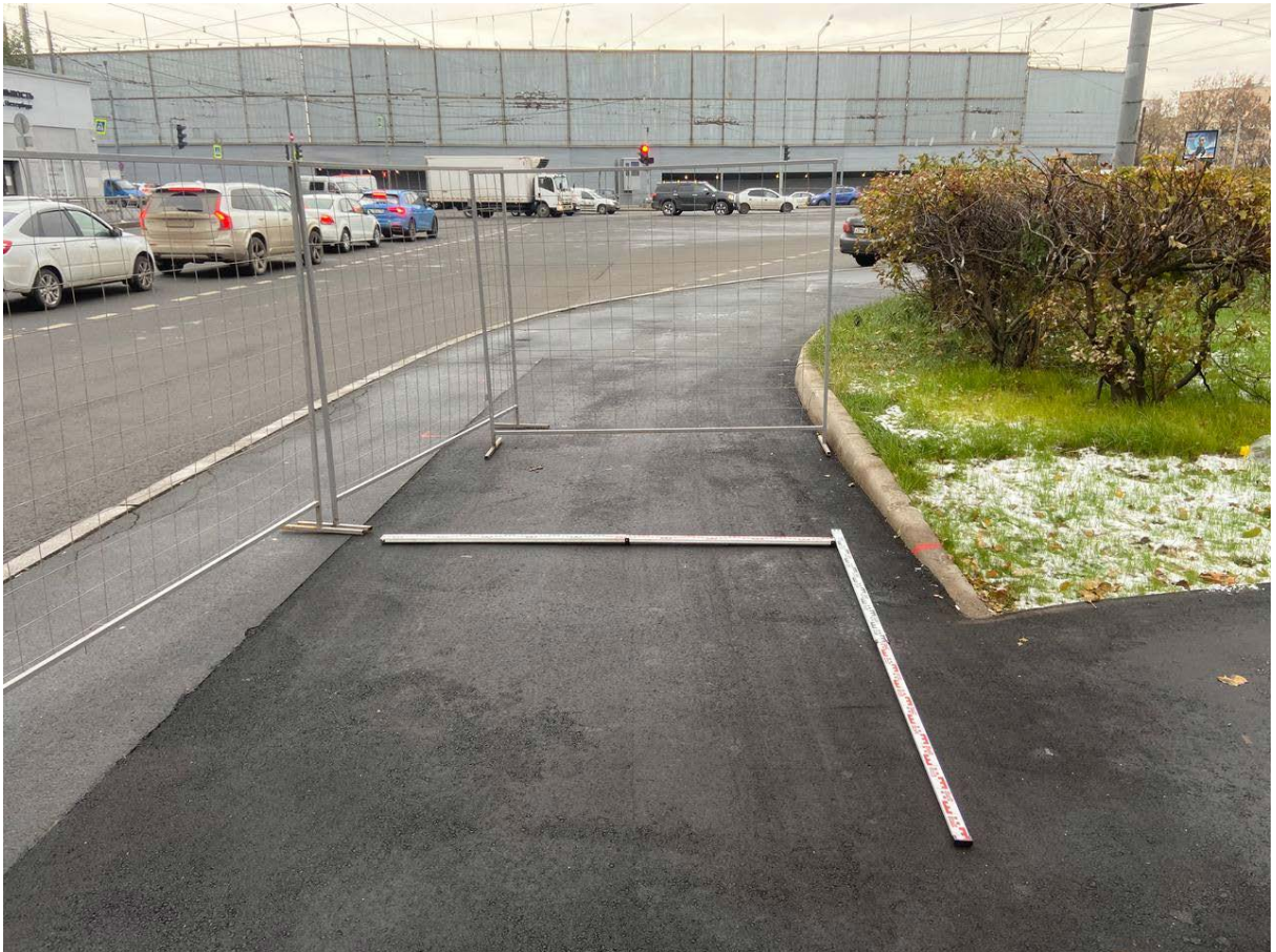
Рис. 49. Санкт-Петербург, Красногвардейский район, Красногвардейская площадь. Шурф 2. Вид до начала работ. Вид с запада
