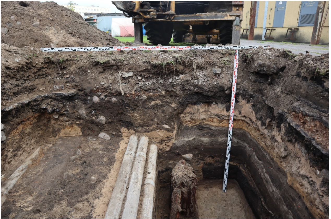
Рис. 45. Санкт-Петербург, Красногвардейский район, Красногвардейская площадь. Шурф 1. Восточная стенка. Вид с запада
