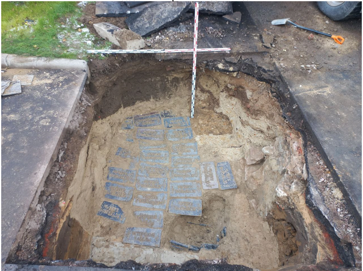
Рис. 50. Санкт-Петербург, Красногвардейский район, Красногвардейская площадь. Шурф 2. Фиксация по окончанию работ на уровне сетей действующих коммуникация. Вид с востока
