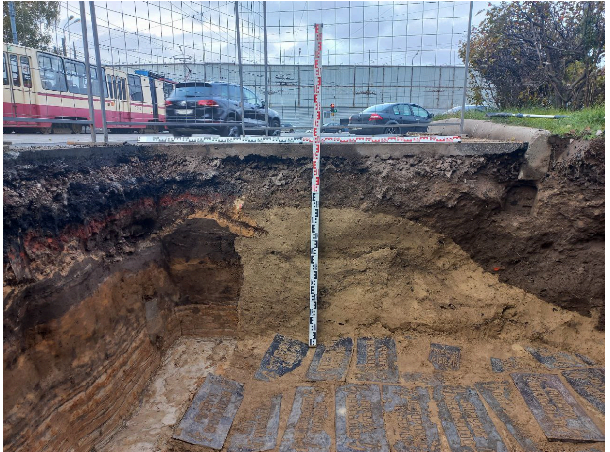
Рис. 53. Санкт-Петербург, Красногвардейский район, Красногвардейская площадь Шурф 2. Северная стенка. Вид с юга
