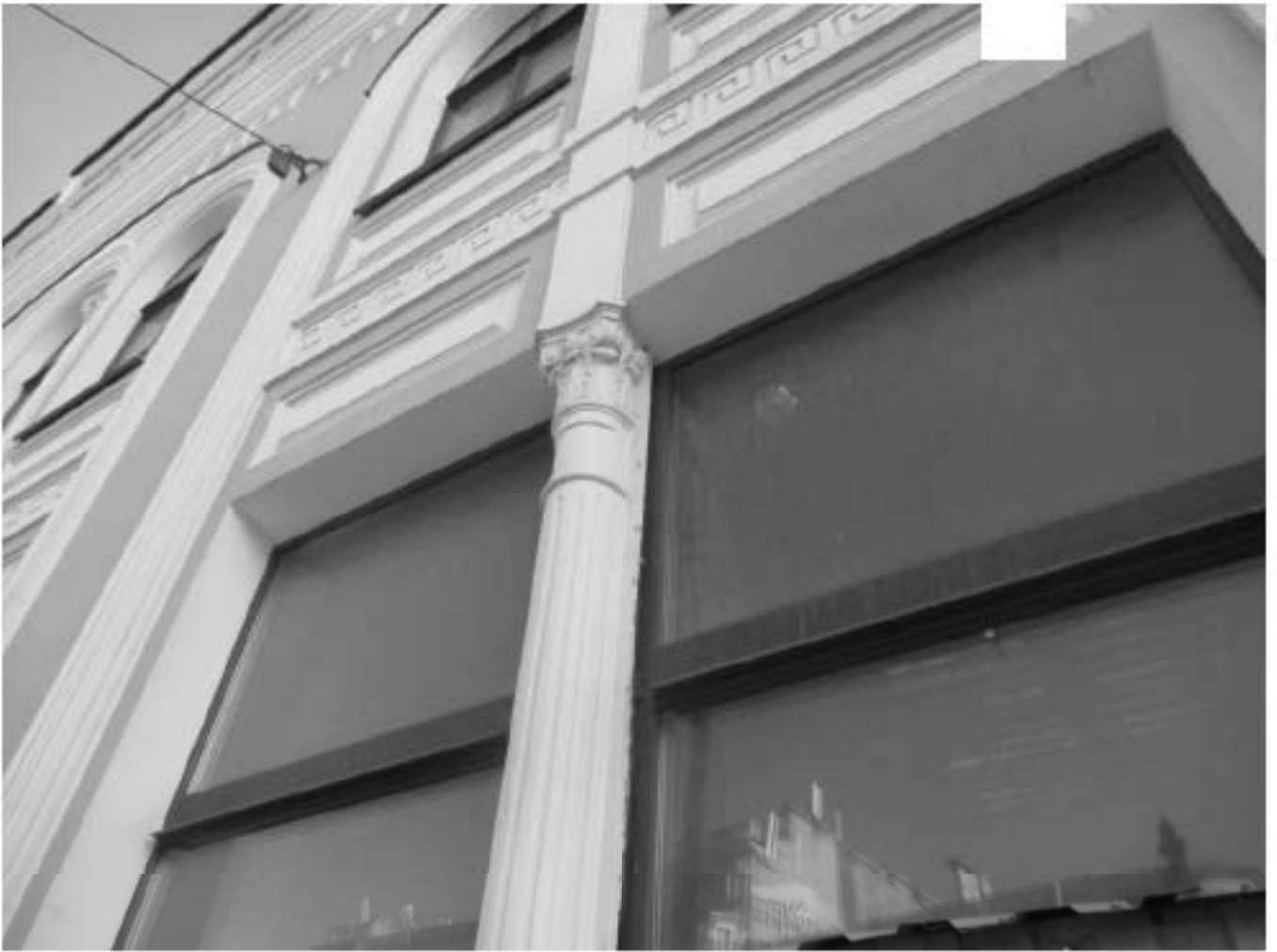
5. Чугунная деталь оформления лицевого фасада здания Заводоуправления.
