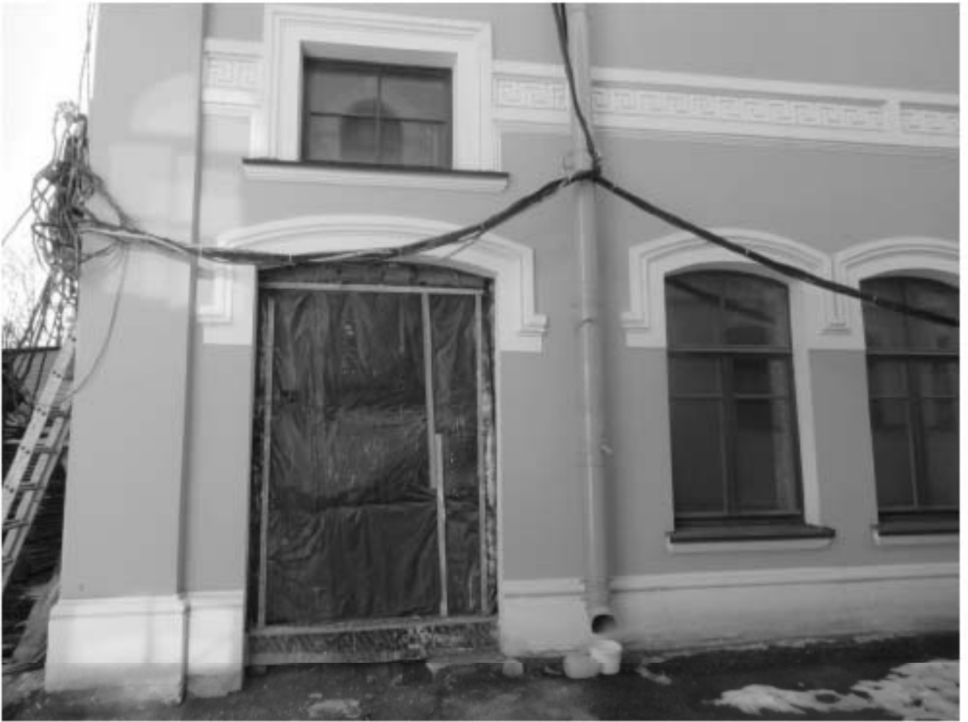
7. Северо-восточный фасад здания Заводоуправления. Фрагмент. Вид с дворовой территории.
