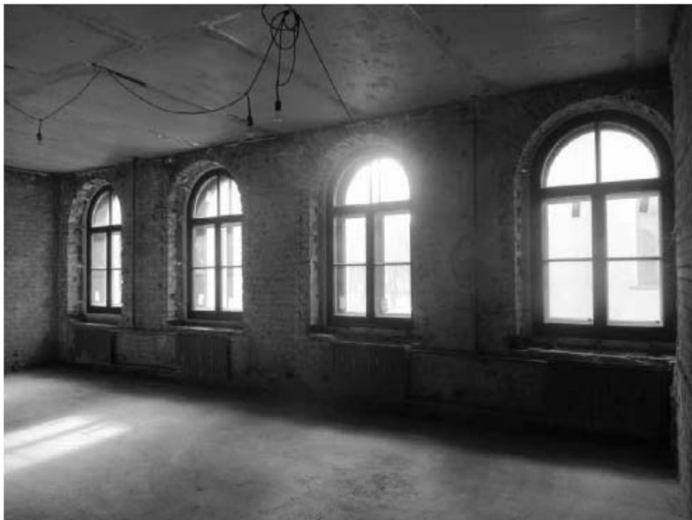
23. Помещение второго этажа здания Проходной, обращенного на дворовую территорию.
