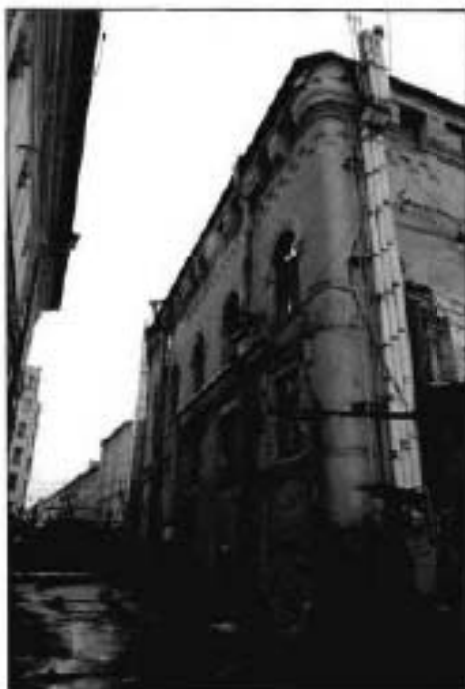
2. Общий вид юго-западного фасада объекта культурного наследия.
