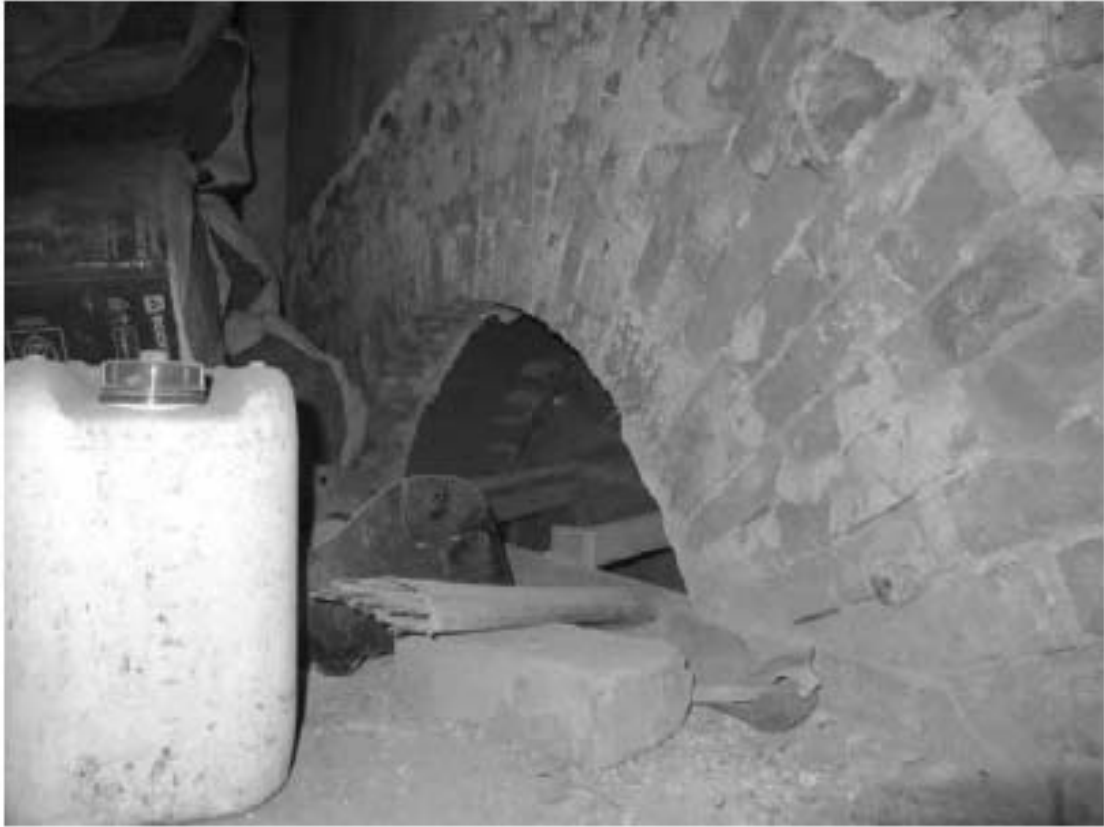
47. Помещение северо-восточной пристройки здания Конторы. Фрагмент.
