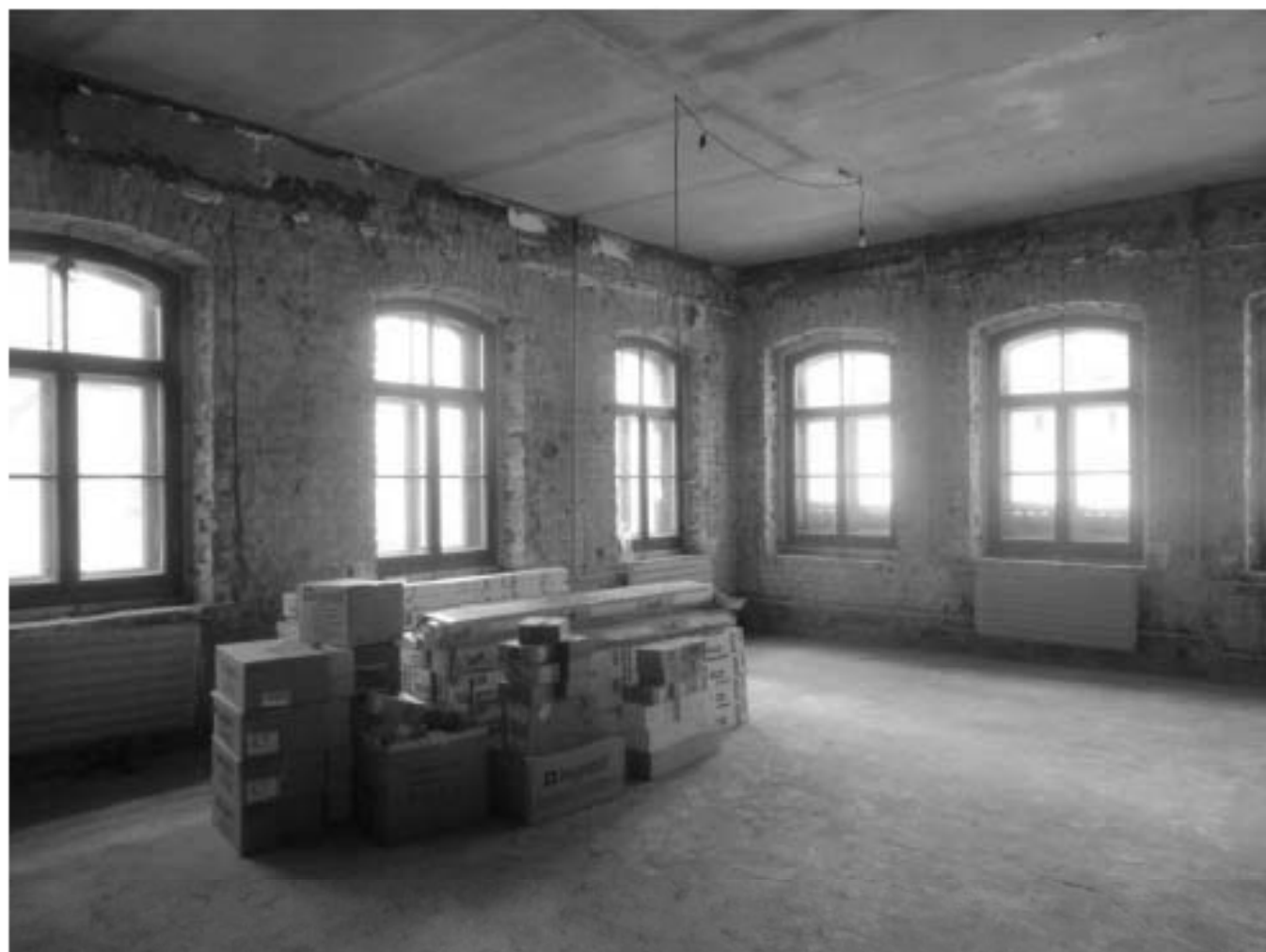
18. Помещение первого этажа здания Проходной, обращенного в сторону Лиговского проспекта.
