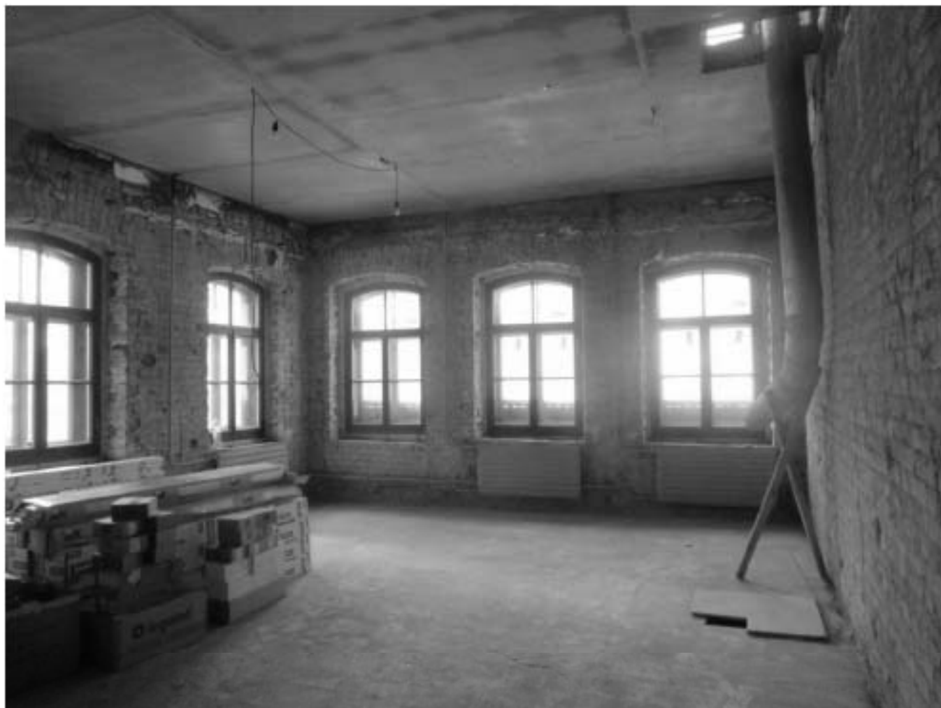
19. Помещение первого этажа здания Проходной, обращенного в сторону Лиговского проспекта.
