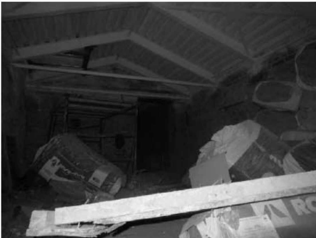
48. Помещение северо-восточной пристройки здания Конторы. Фрагмент.
