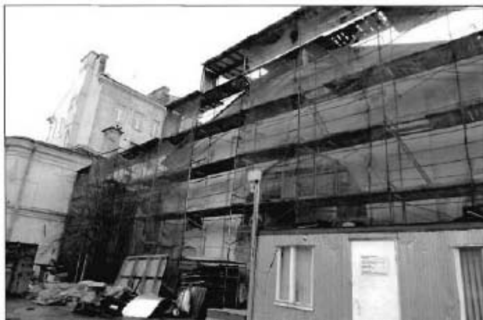
6. Общий вид юго-западного фасада объекта культурного наследия
