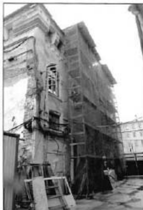
3. Общий вид северо-восточного фасада объекта культурного наследия.
