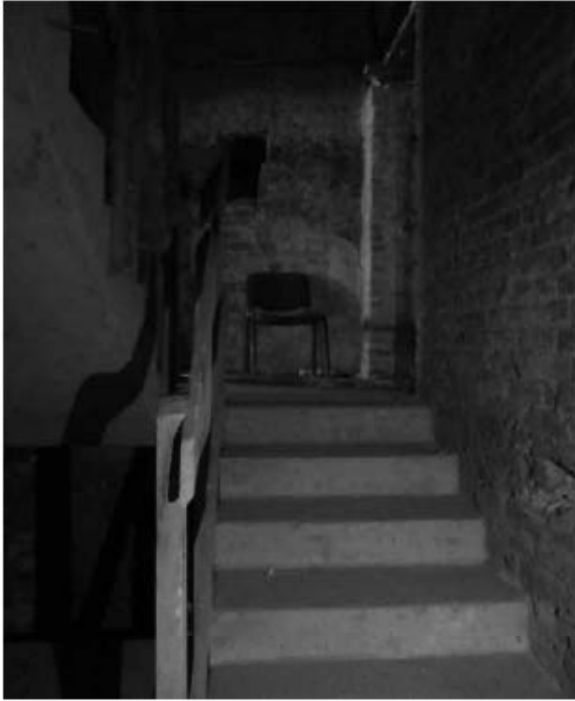
17. Лестничный марш на площадку первого этажа в здании Проходной.
