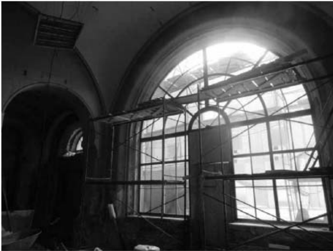
41. Витражный оконный проем с входом в центральном пролете здания Конторы.
