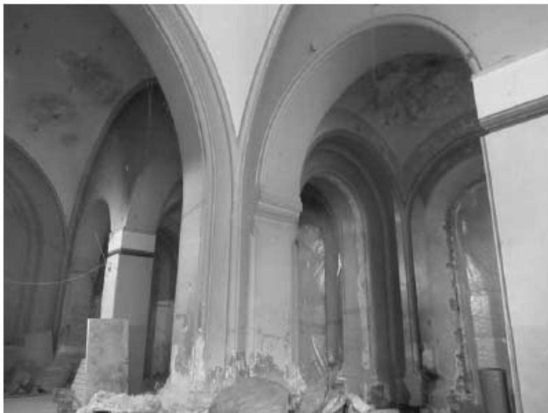
36. Парусные своды центрального пролета здания Конторы.
