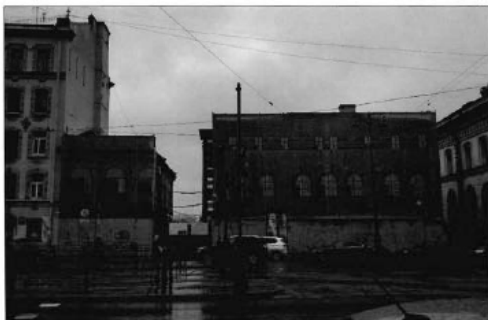
1. Общий вид лицевых фасадов объекта культурного наследия по Лиговскому пр.
