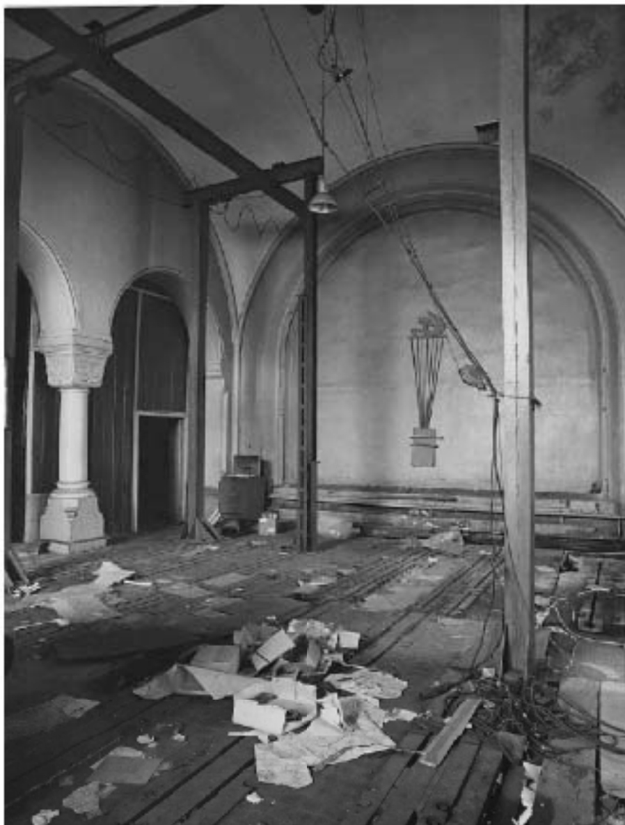
Илл. 77. Здание конторы. Интерьер. Фото 1999 г. КГИОП. Паспорт. Завод Чугуно-литейный и механический Ф.К. Сан-Галли. Контора. 294-3. Инв. № 880п. Составитель Луцко Е.И.
