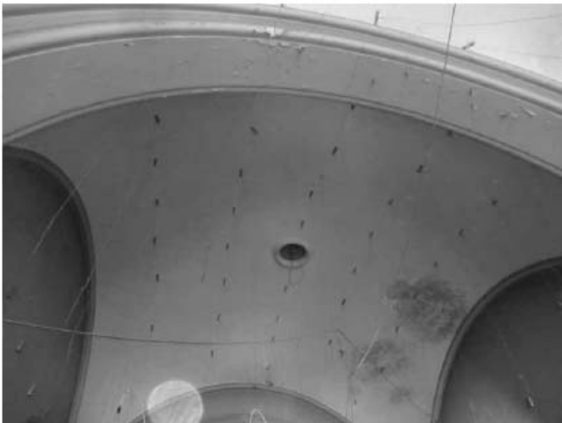
42. Декоративная чугунная решетка воздуховода в центральном пролете зала здания Конторы.
