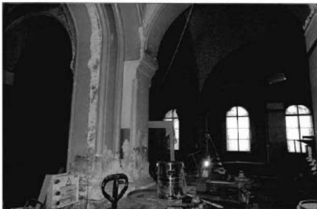
7. Интерьер. Фрагмент. Пом. 2-Н (1).
