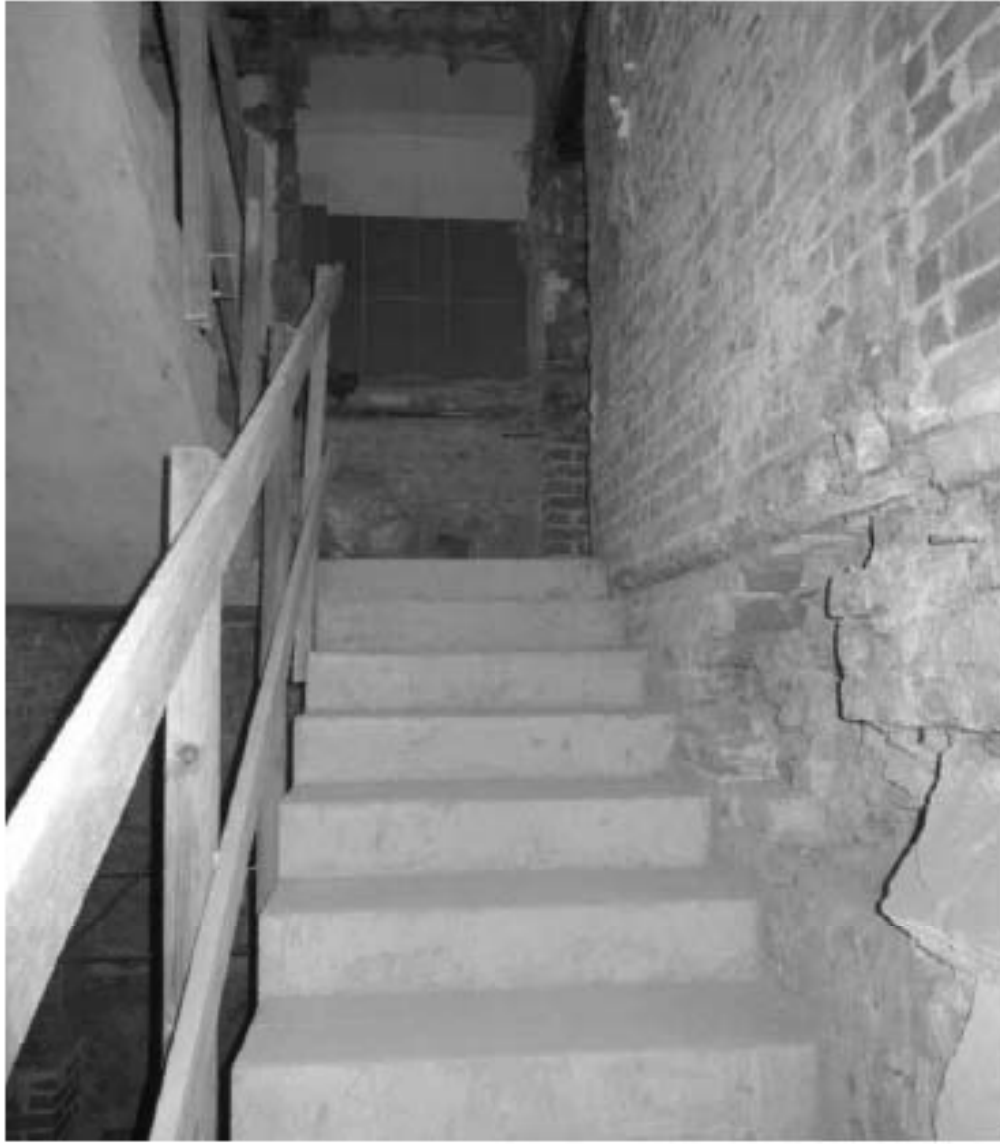
21. Марш лестницы на второй этаж.
