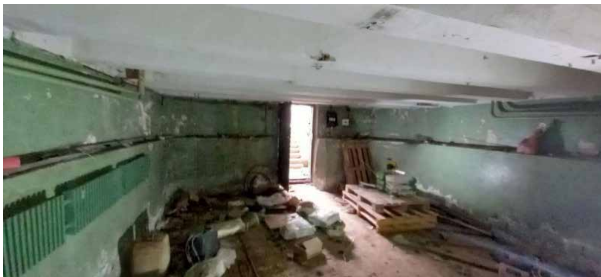
1. Фрагмент инеръера подвала;
