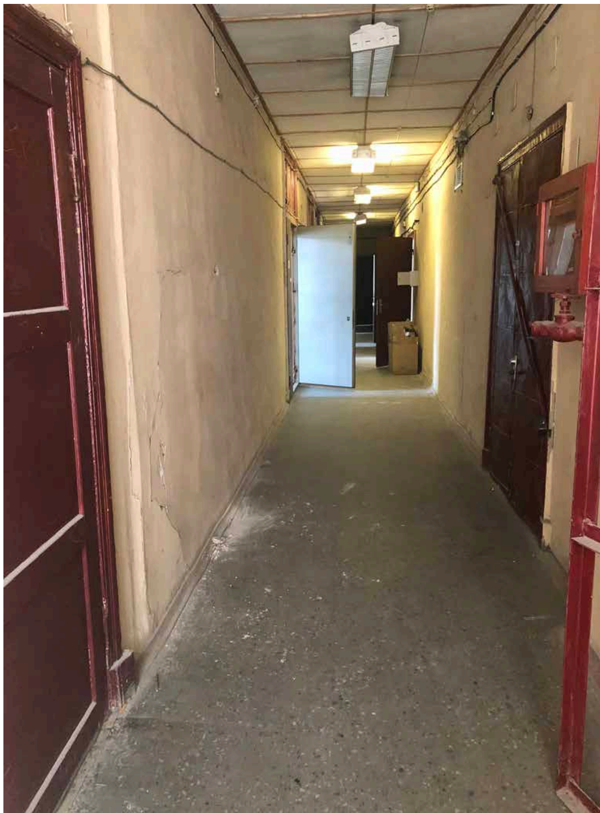
18. Фрагмент интерьера коридора на втором этаже;
