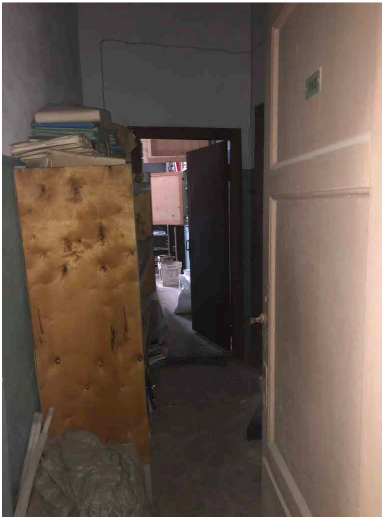
13. Фрагмент интерьера коридора на первом этаже;
