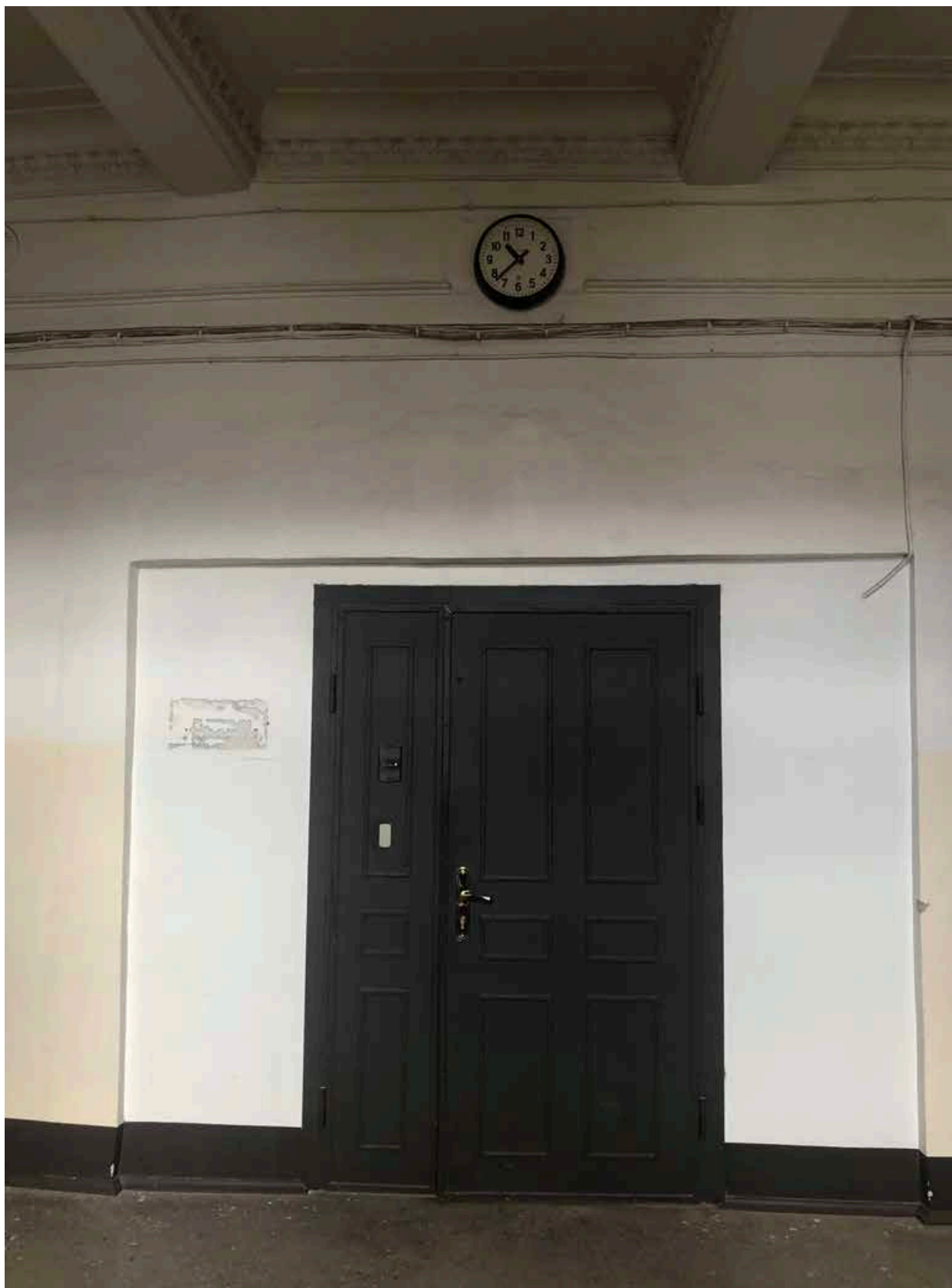
4. Фрагмент интерьера коридора на втором этаже;
