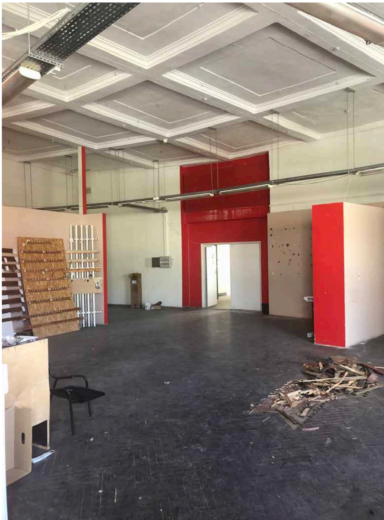
8. Фрагмент интерьера помещения на третьем этаже;
