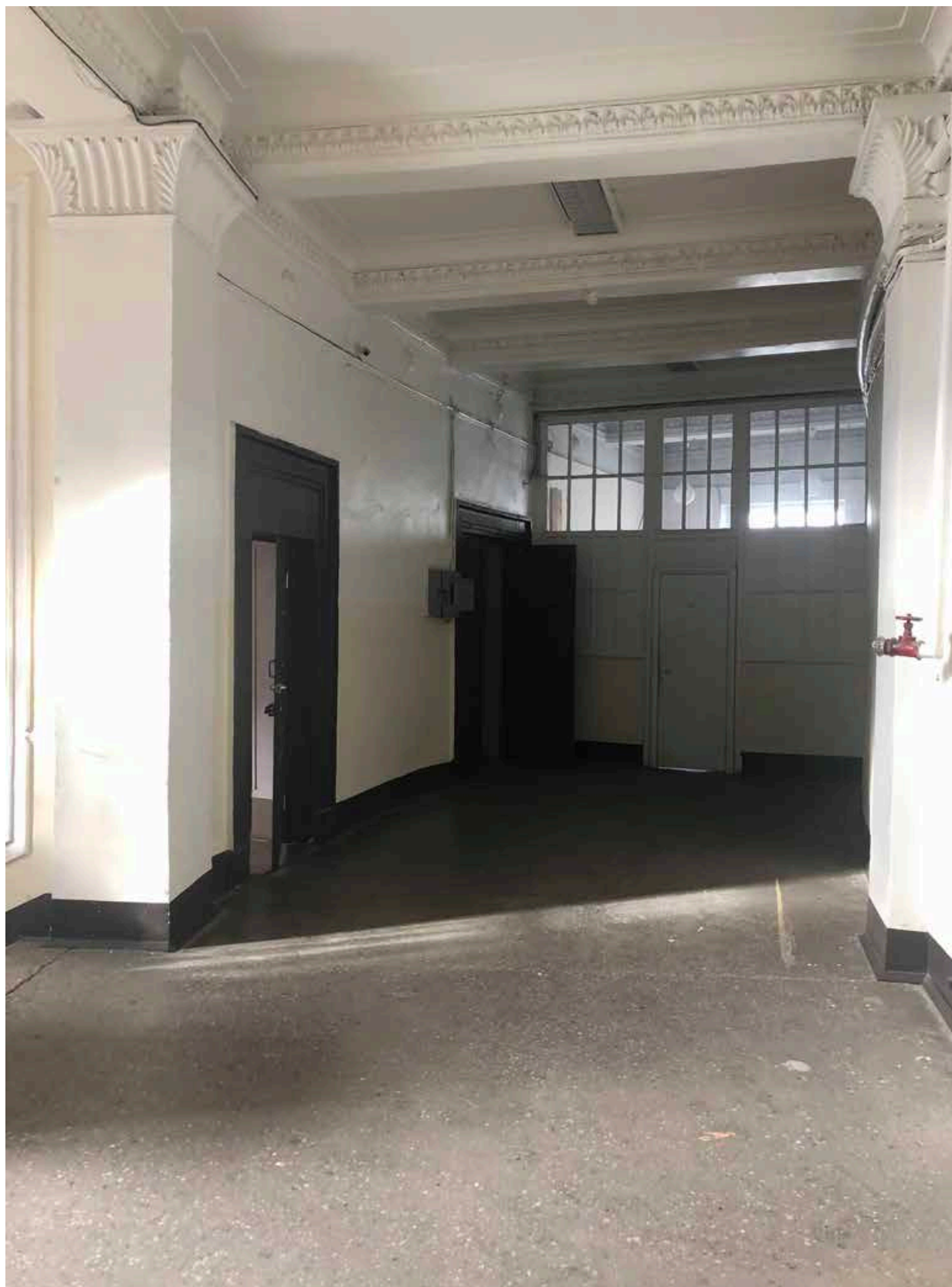
5. Фрагмент интерьера коридора на втором этаже;
