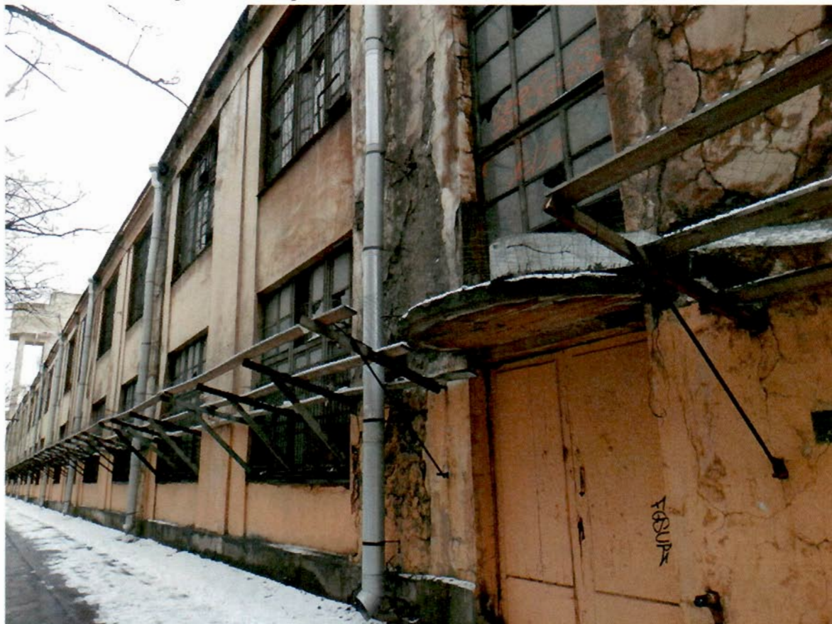
3. Лицевой фасад со стороны 25 линии В.О.
