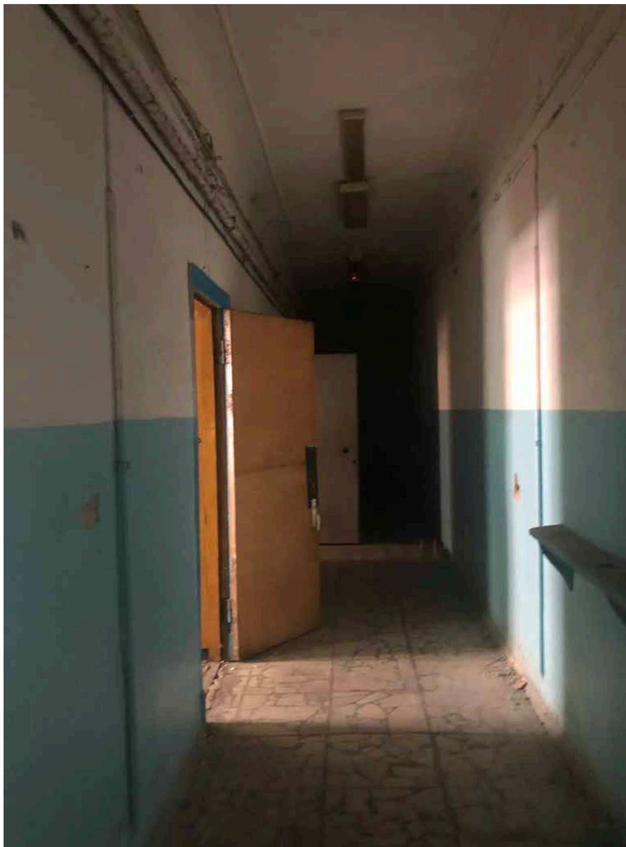
7. Фрагмент интерьера коридора на первом этаже;
