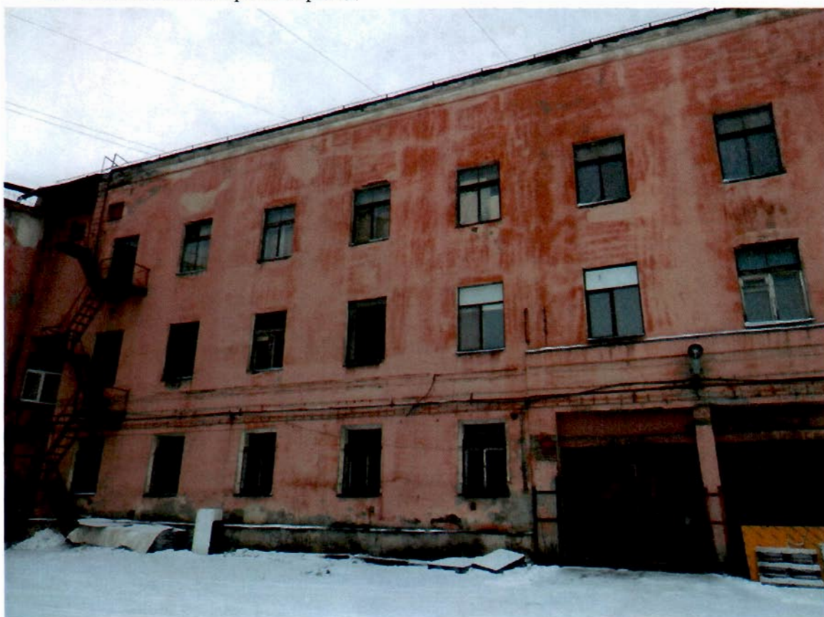
4. Восточный дворовый фасад
