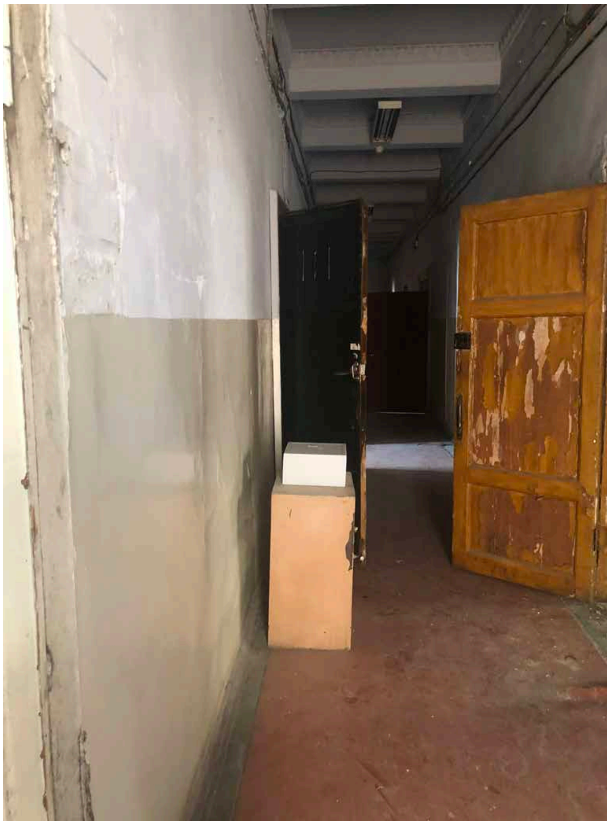
13. Фрагмент интерьера коридора на третьем этаже;
