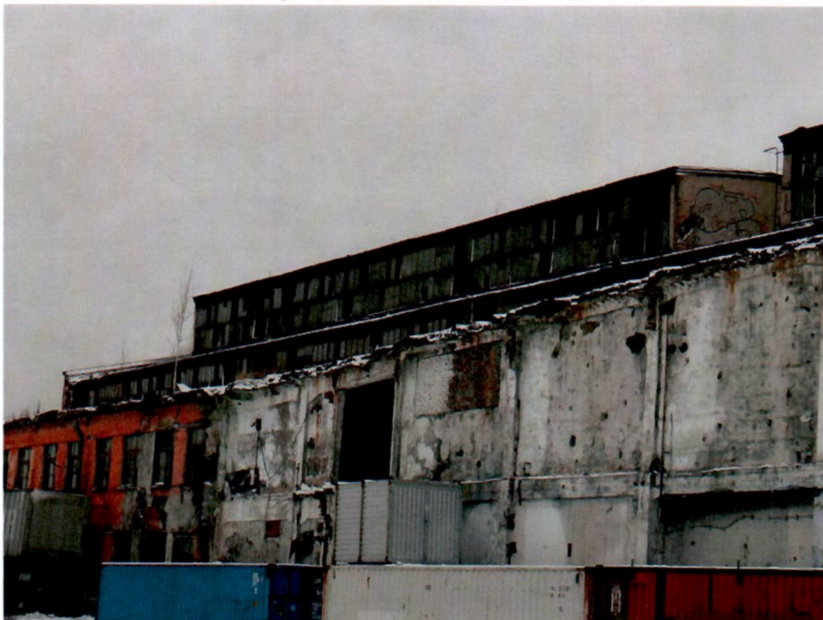
5. Западный дворовый фасад
