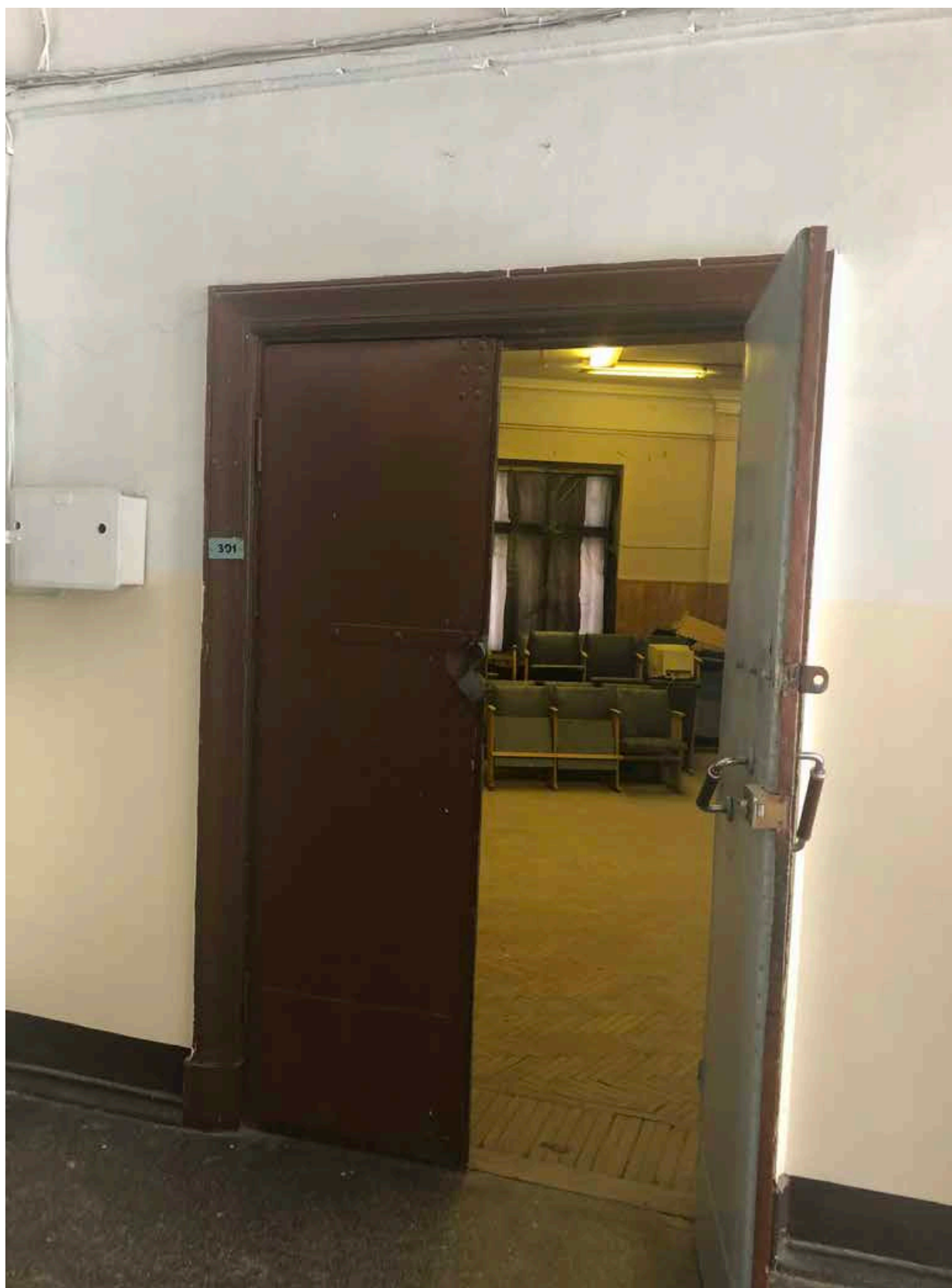
3. Фрагмент интерьера коридора на третьем этаже;
