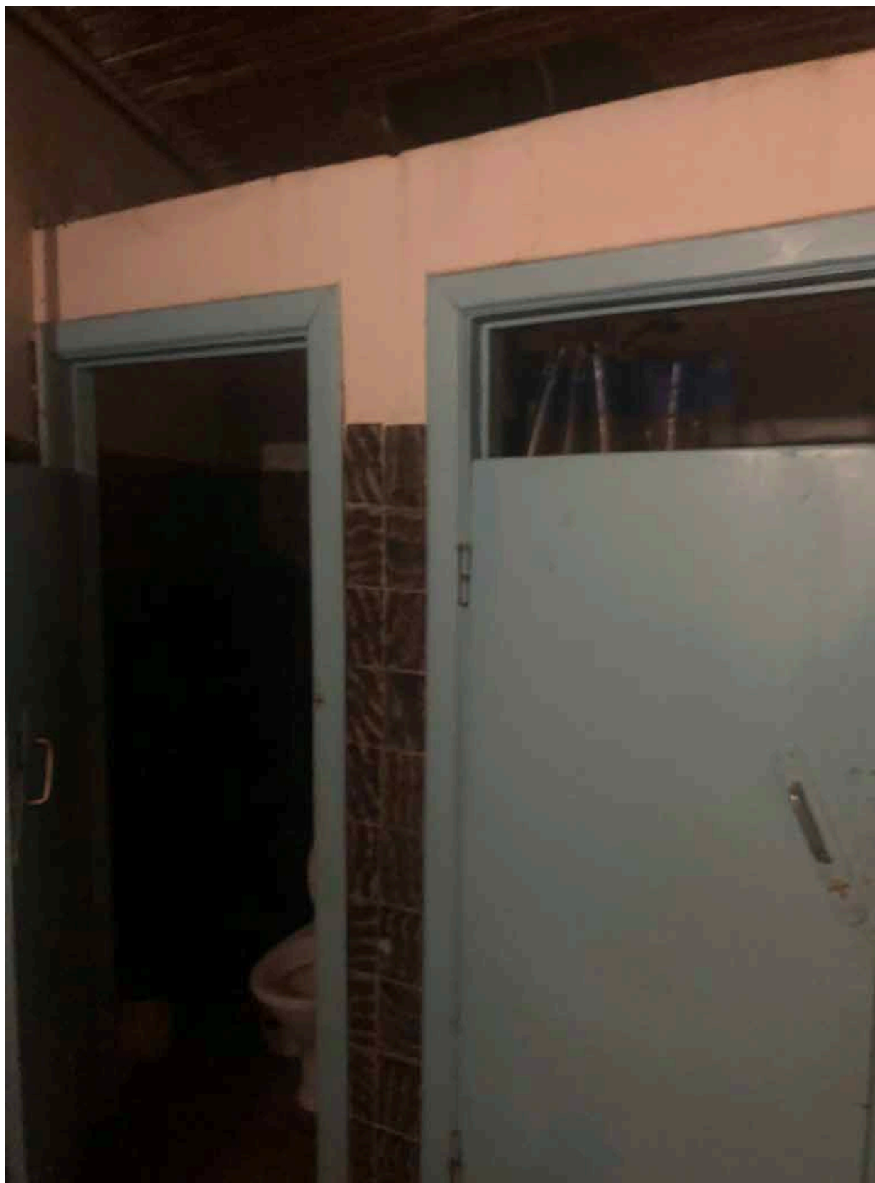
6. Фрагмент интерьера санузла на первом этаже;
