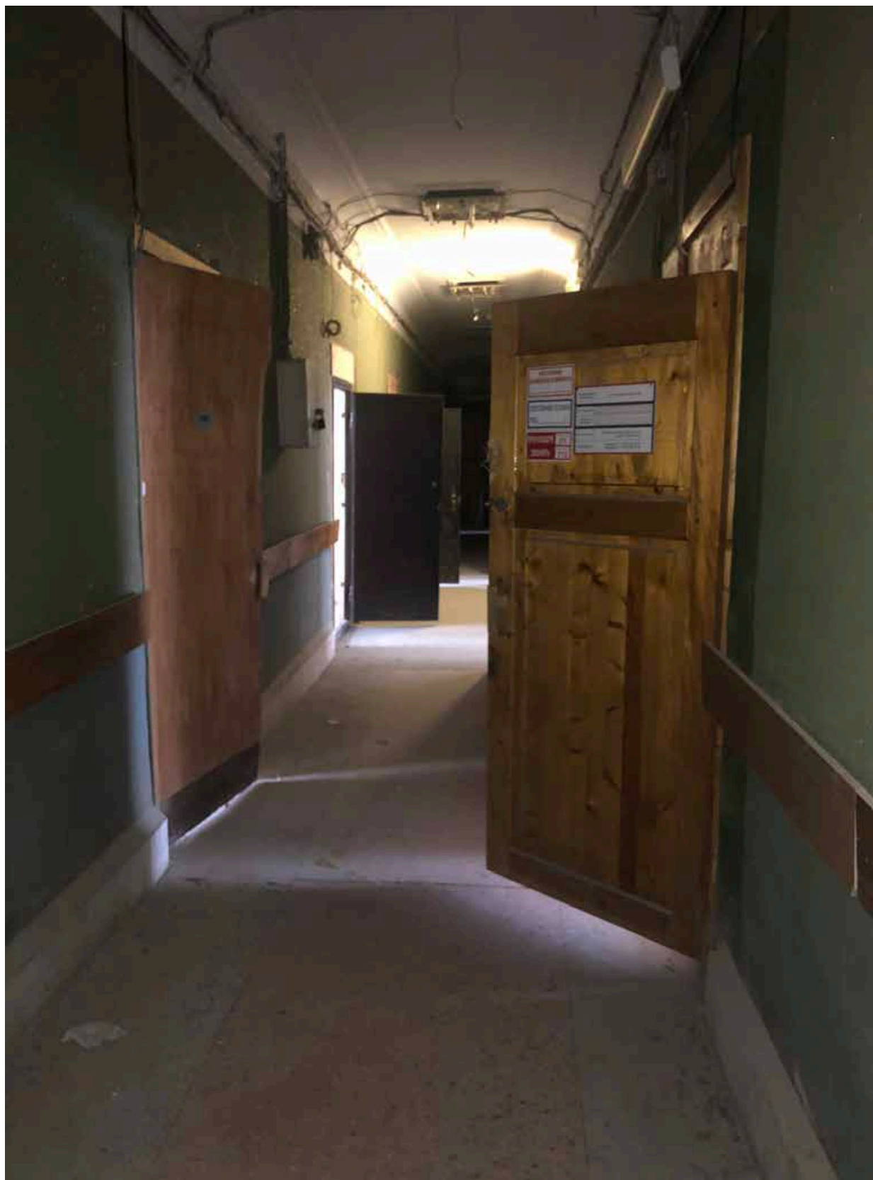
12. Фрагмент интерьера коридора на втором этаже;
