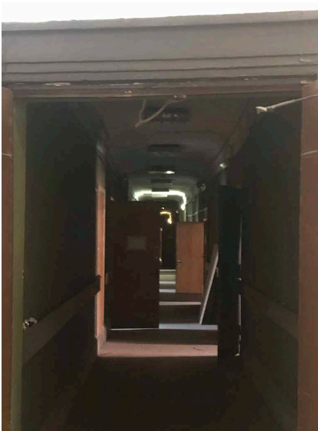
10. Фрагмент интерьера коридора на втором этаже;
