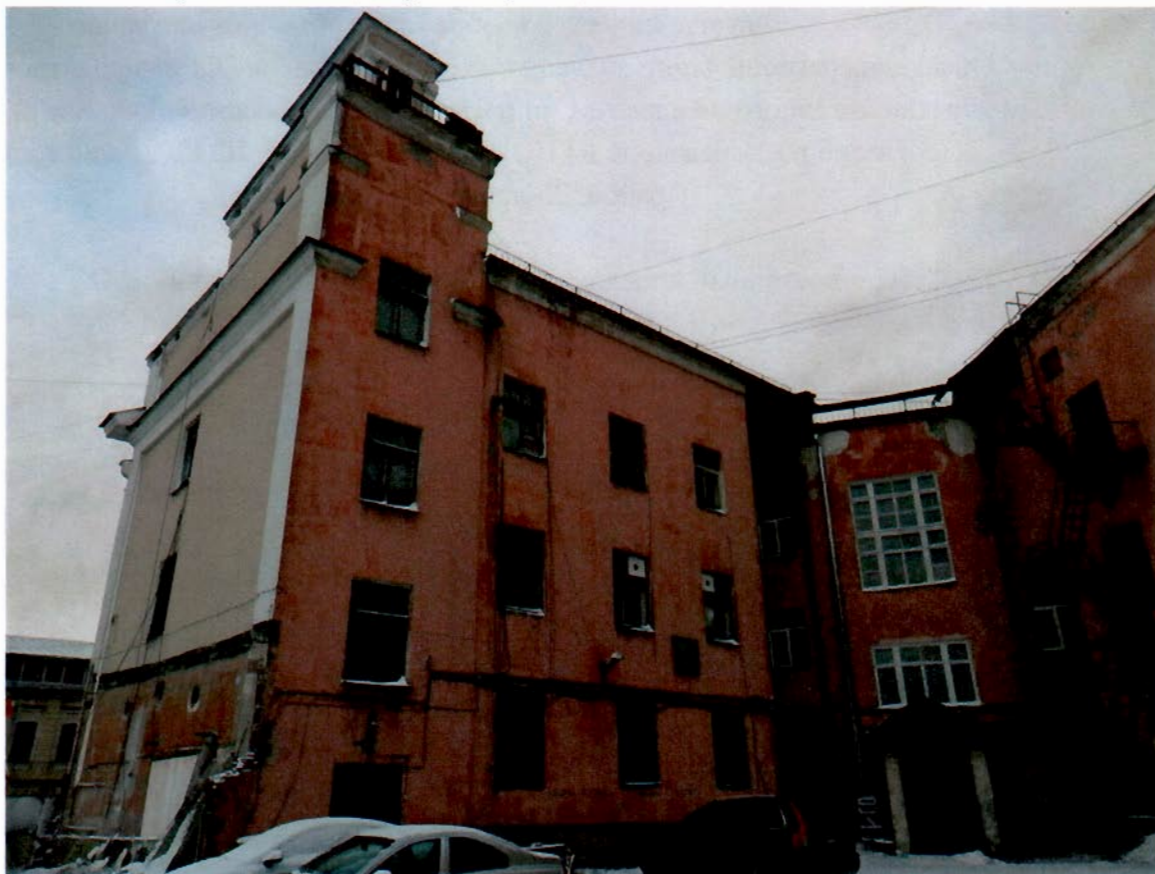
3. Северо-западный дворовый фасад
