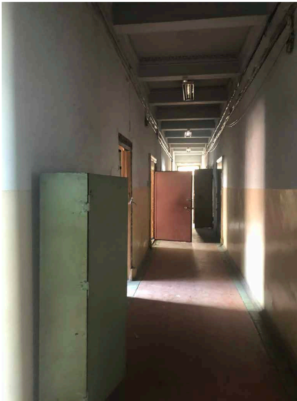
11.Фрагмент интерьера коридора на третьем этаже;
