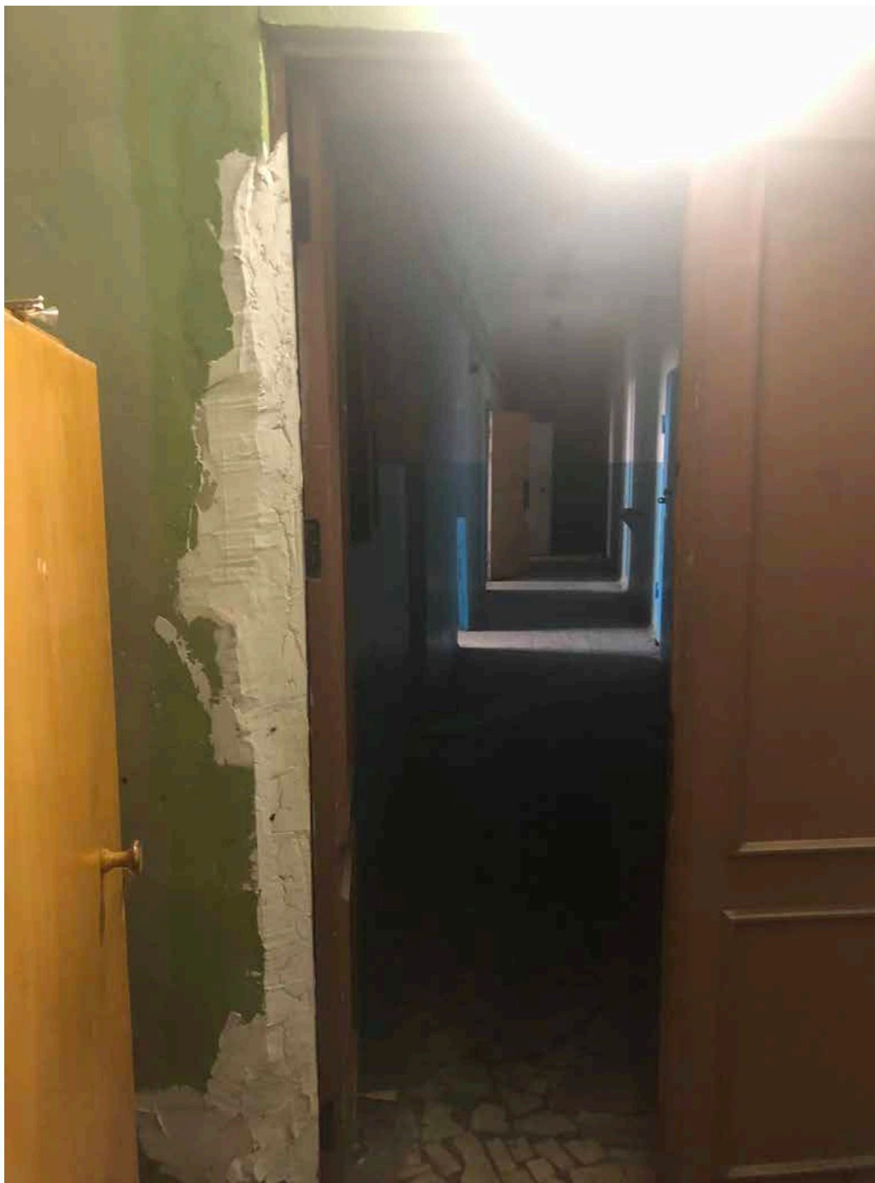
4. Фрагмент интерьера коридора на первом этаже;
