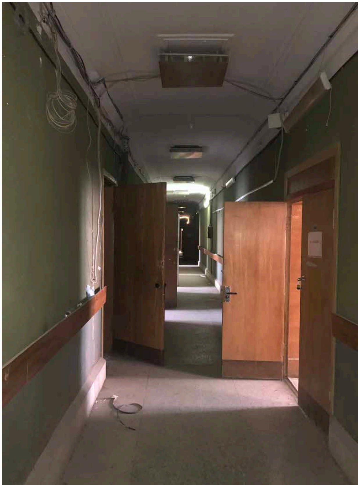
11. Фрагмент интерьера коридора на втором этаже;
