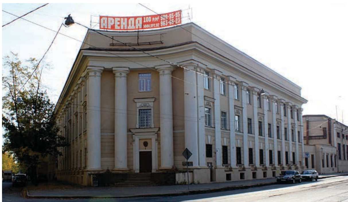
6. Заводское управление Сталепрокатного завода, фото 2010 г. https://www.citywalls.ru/house16217.html
