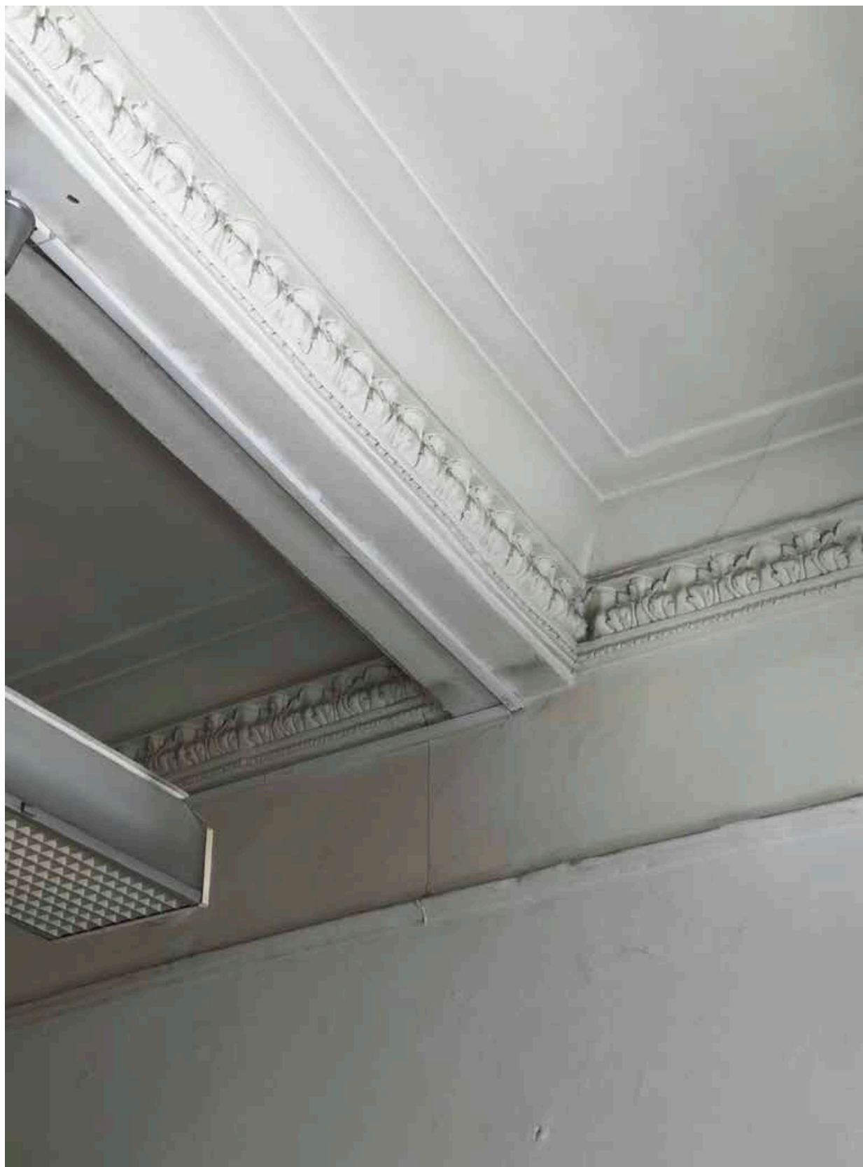
9. Фрагмент интерьера помещения на втором этаже;
