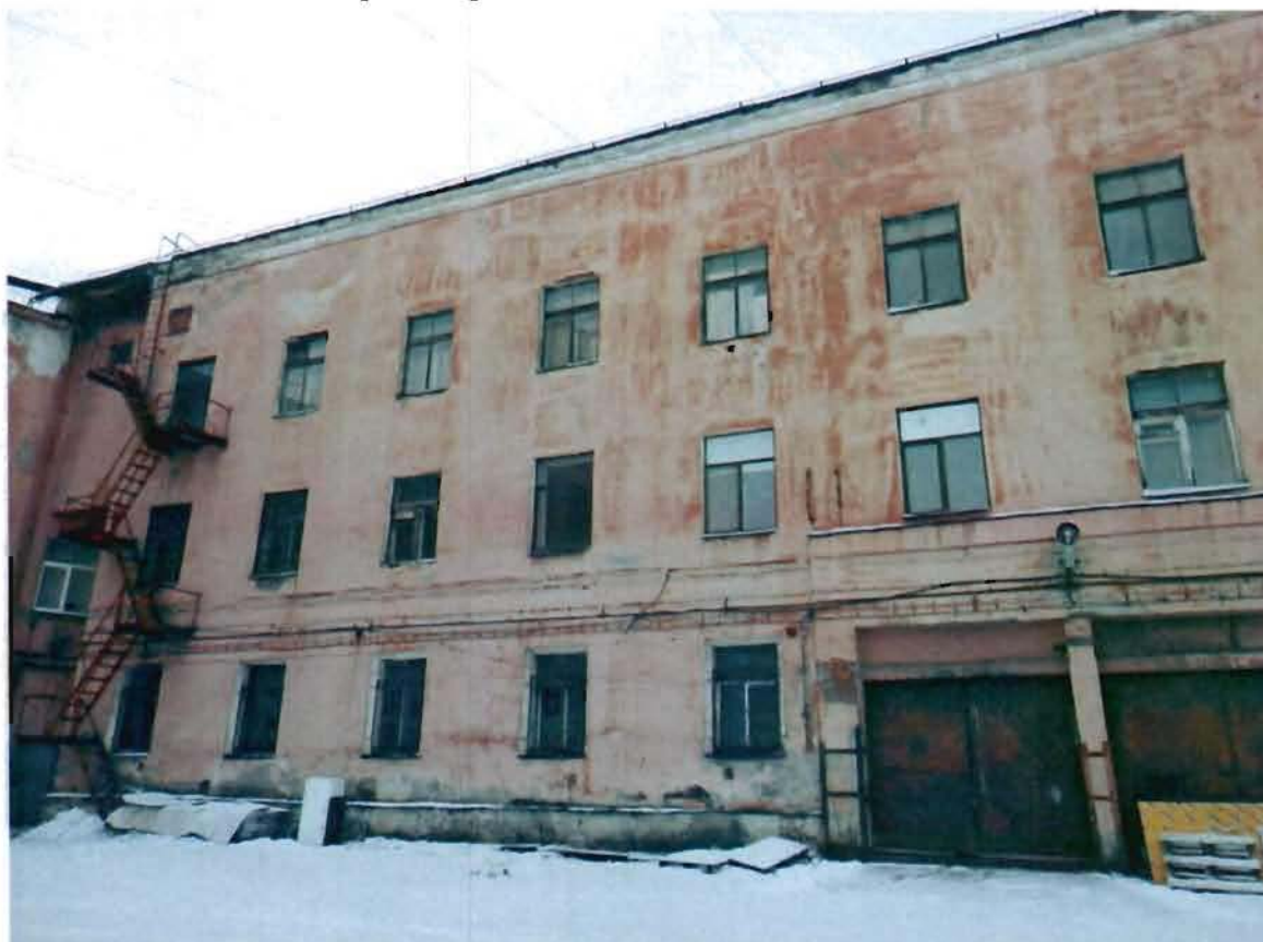
4. Восточный дворовый фасад
