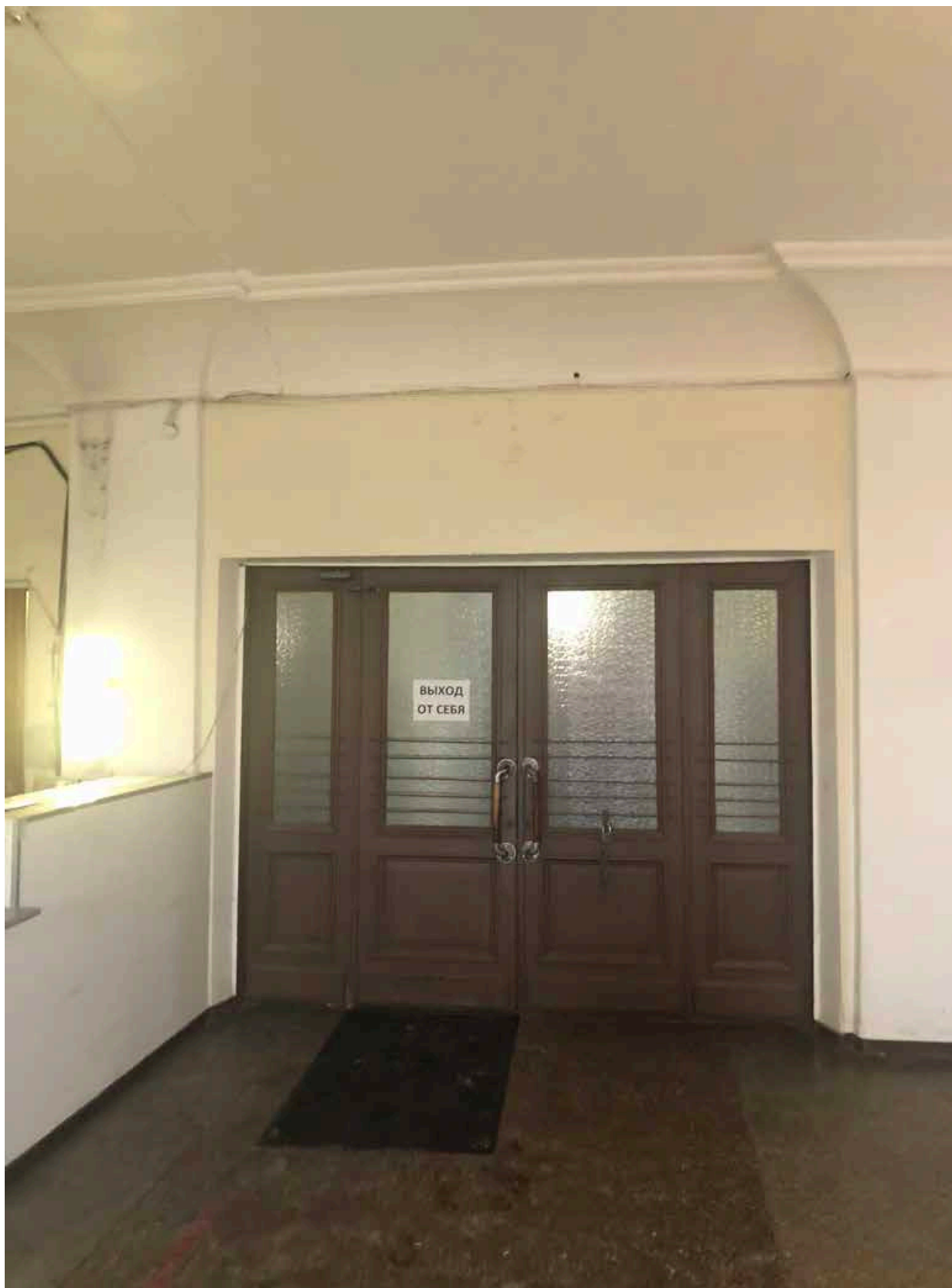
2. Вид на входную дверь;
