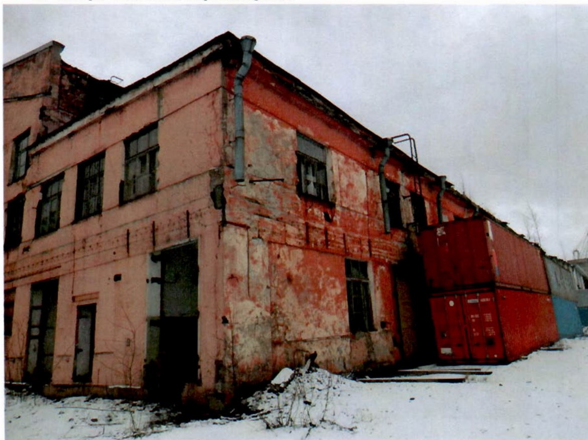
6. Северо-западный дворовый фасад
