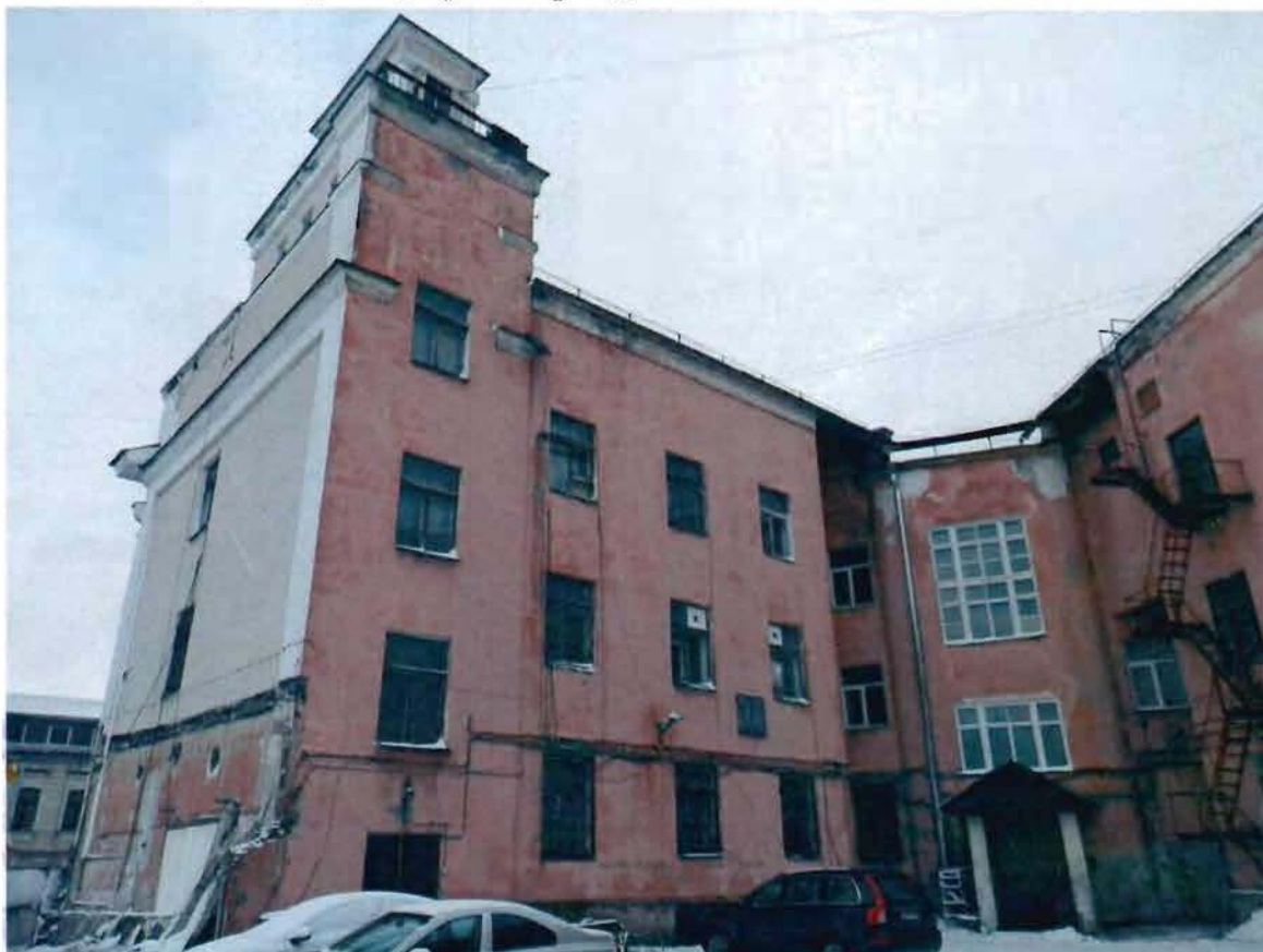
3. Северо-западный дворовый фасад
