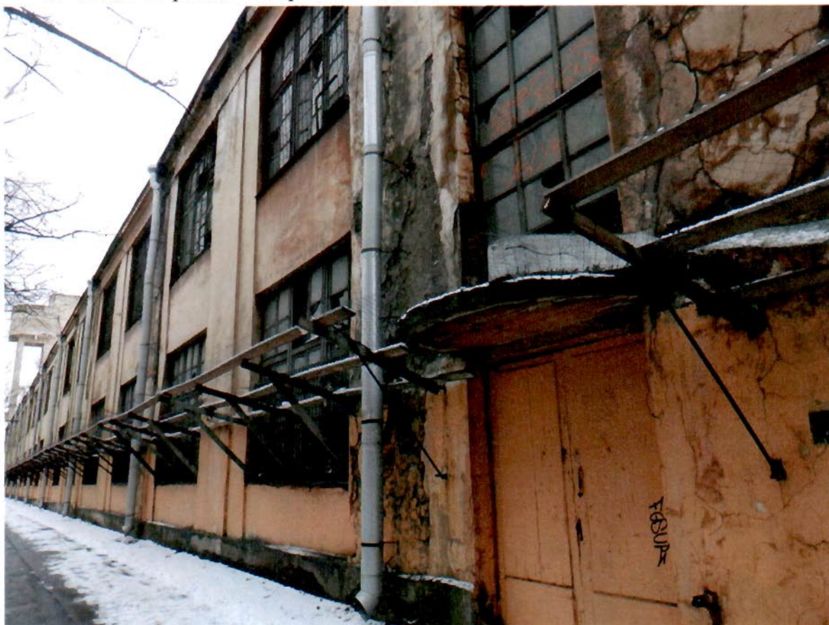
3. Лицевой фасад со стороны 25 линии В.О.
