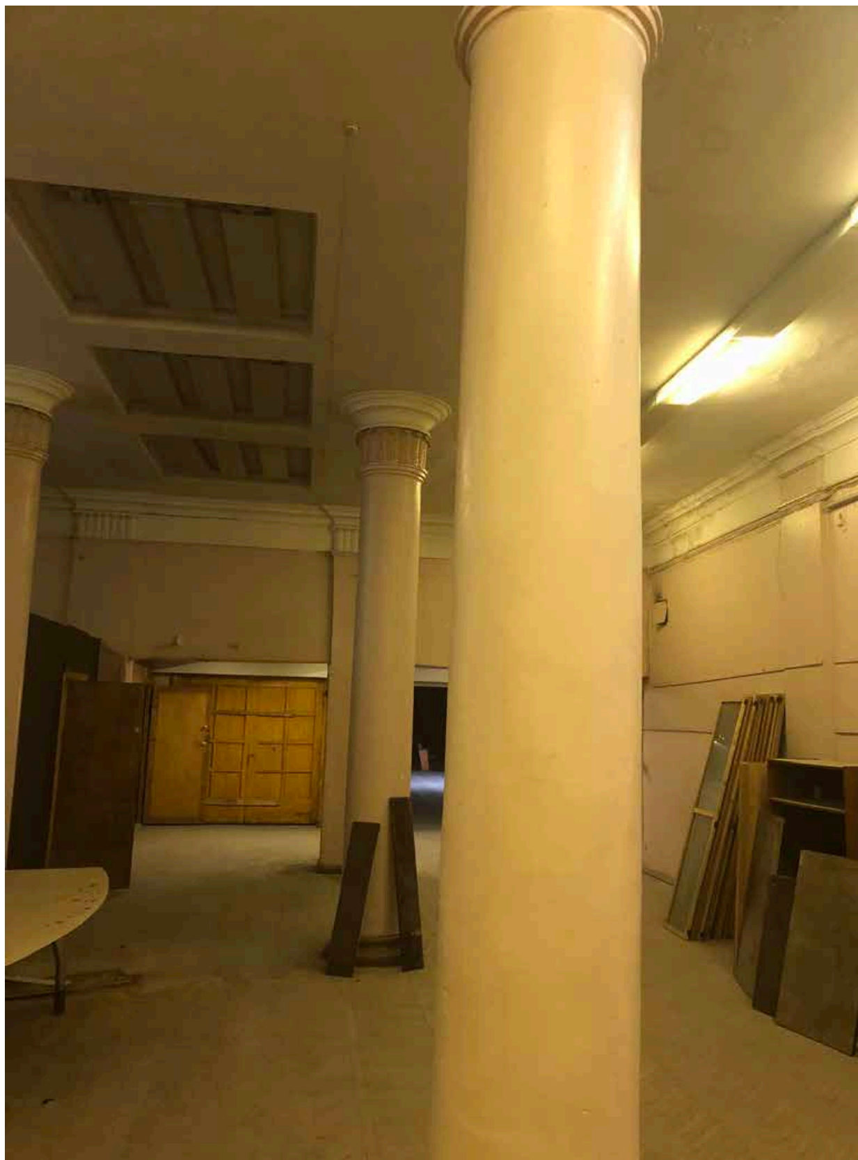
4. Фрагмент интерьера помещения на третьем этаже;
