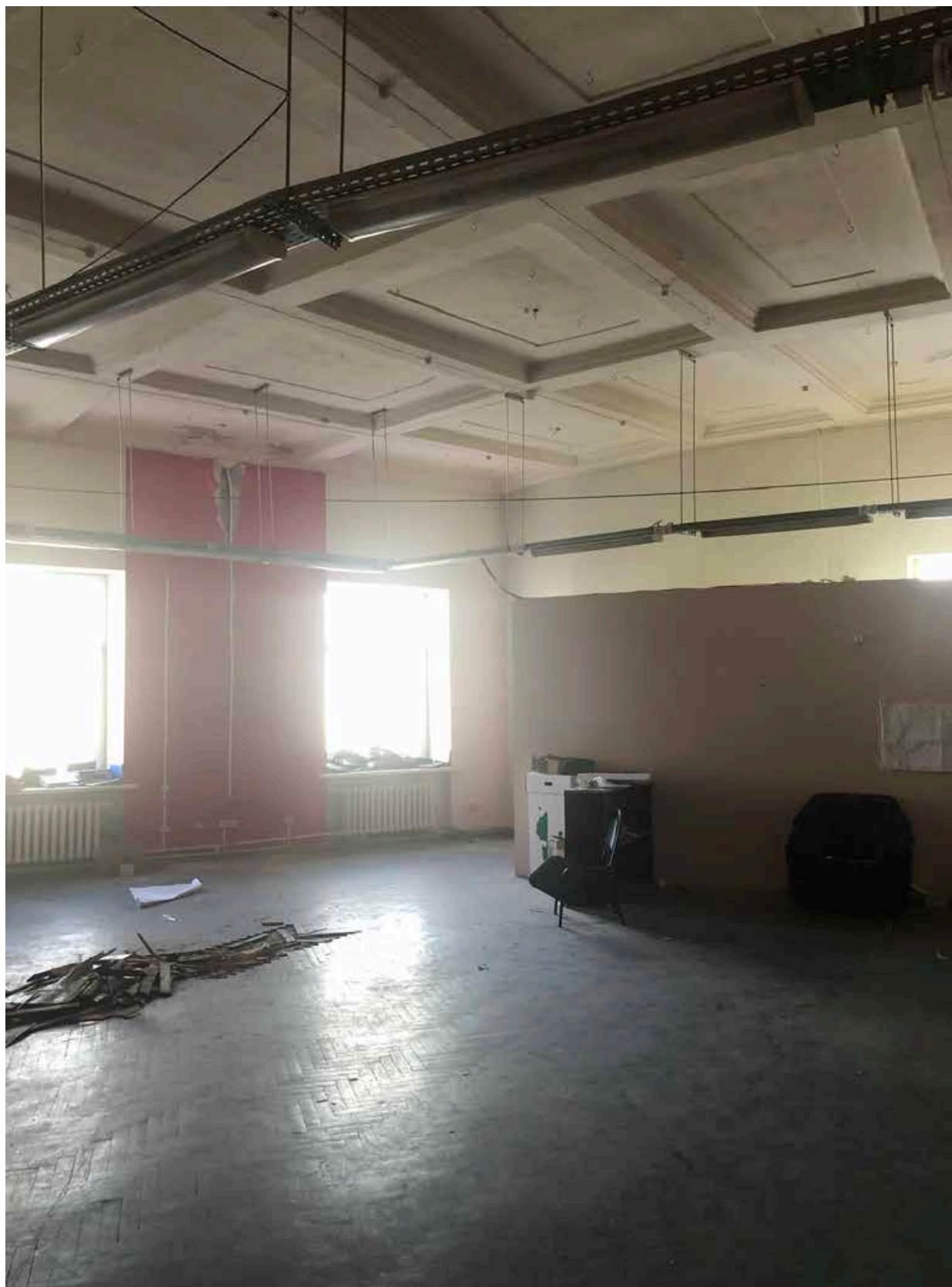
7. Фрагмент интерьера помещения на третьем этаже;
