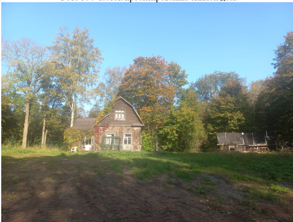
Фото 10. Участок проектирования. Жилой дом. Сарай.
