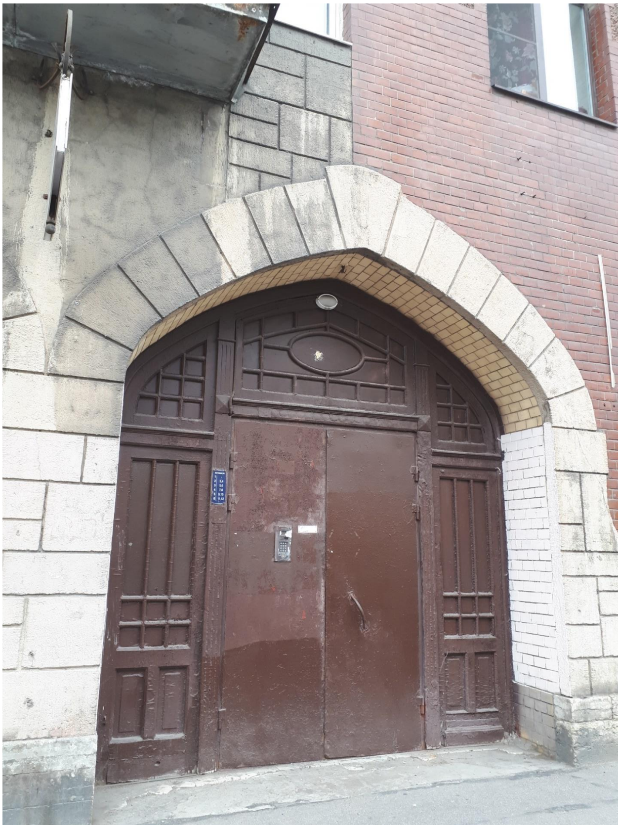
5. Дом Ф. В. Шеффера. Лицевой фасад. Фрагмент. Петухова Н.М. 18.08.2023.
