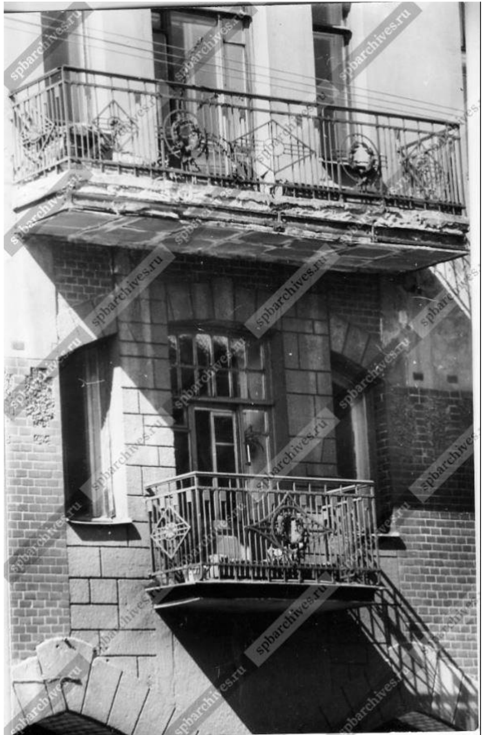
19. Дом Ф. В. Шеффера. Вид декоративных решеток балконов на центральном фасаде жилого дома № 58 по 9-й линии Васильевского острова. 12 июня 1987 г. ЦГАКФФД СПб Ар 225808.
