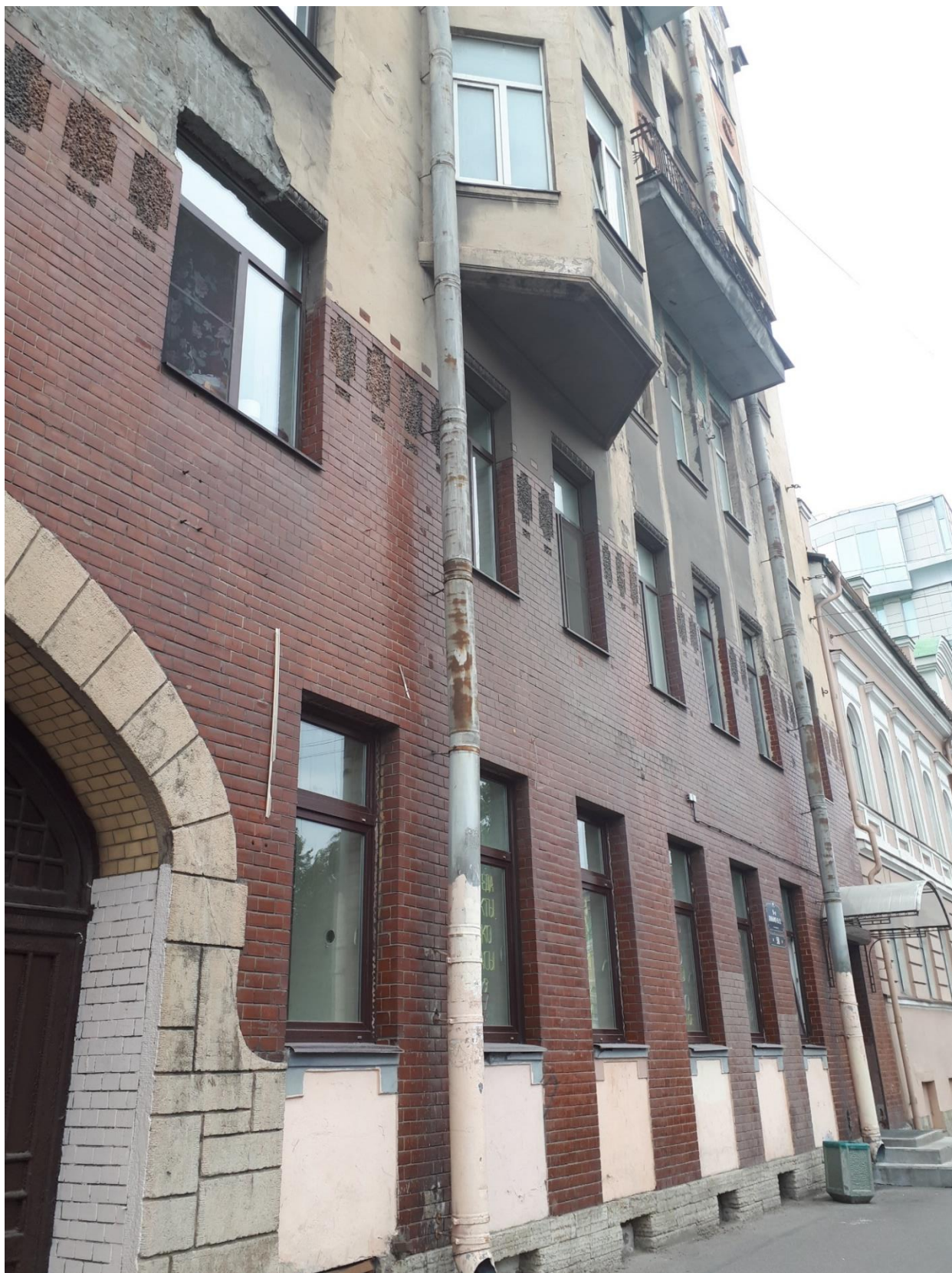
6. Дом Ф. В. Шеффера. Лицевой фасад. Фрагмент. Петухова Н.М. 18.08.2023.
