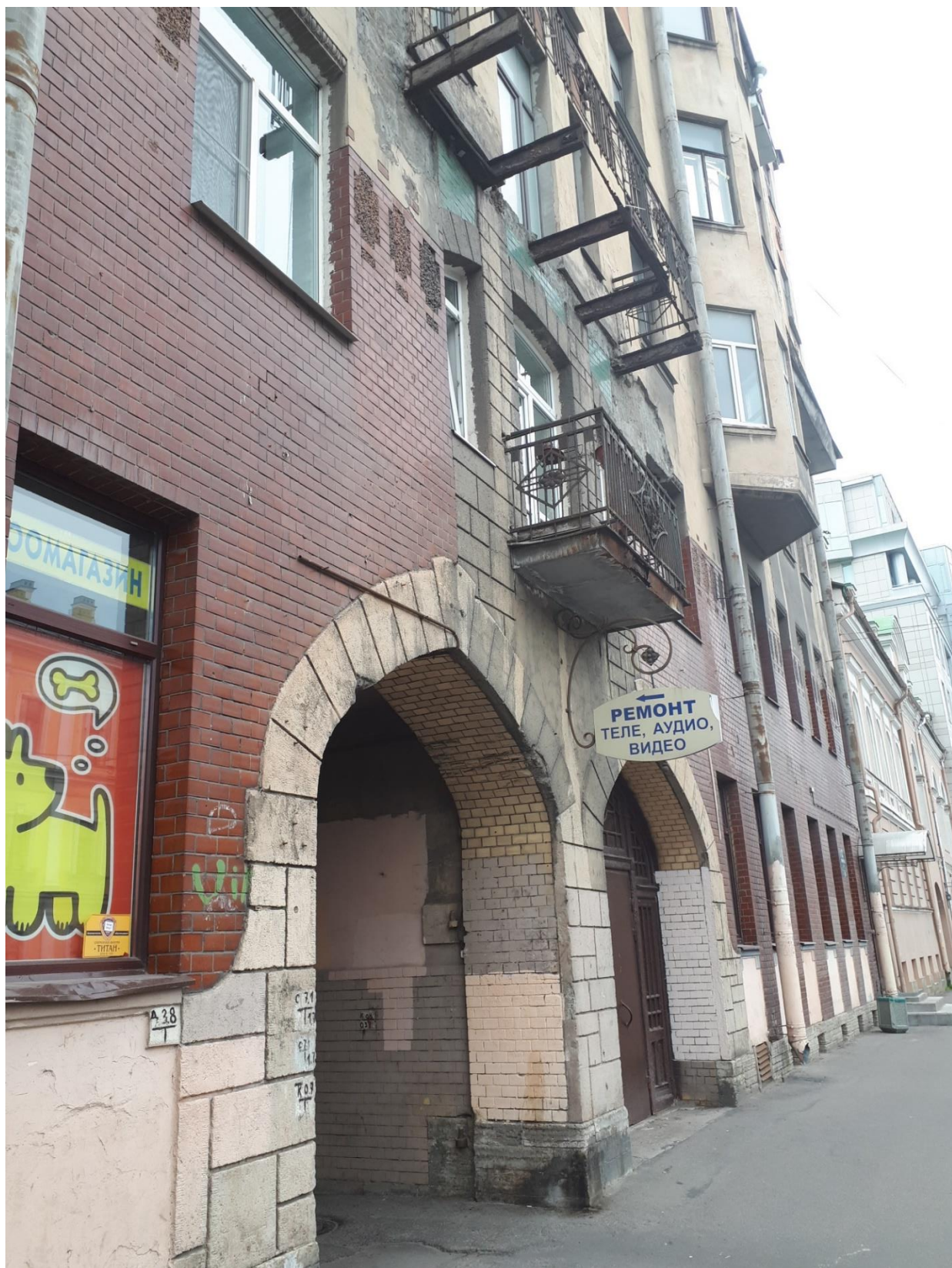
4. Дом Ф. В. Шеффера. Лицевой фасад. Фрагмент. Петухова Н.М. 18.08.2023.
