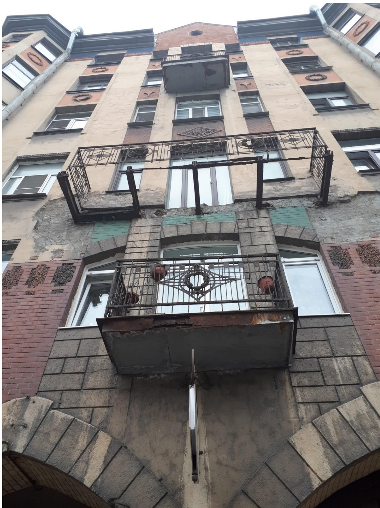
7. Дом Ф. В. Шеффера. Лицевой фасад. Фрагмент. Петухова Н.М. 18.08.2023.
