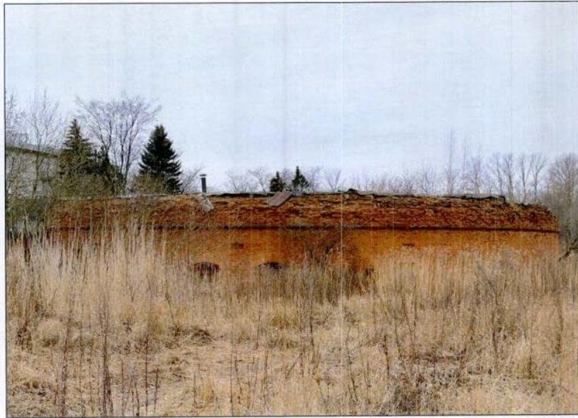
3. Вид на оборонительную стену с северной стороны.
