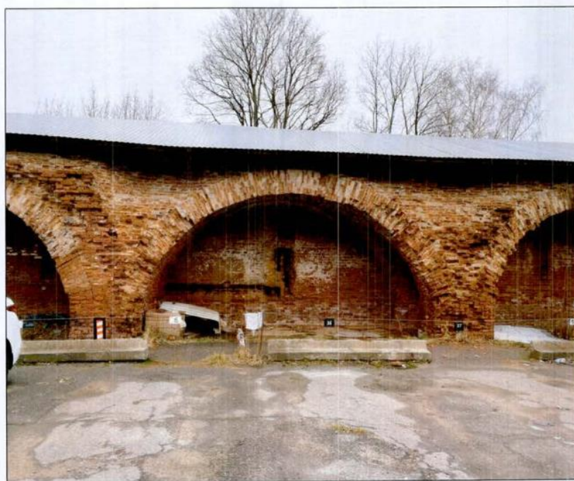
6. Фрагмент оборонительной стены. Коробовый свод каземата.
