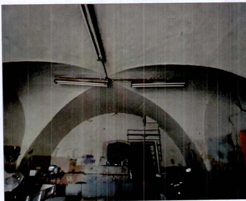
10. Крестовые на распалубках своды казематов южного участка восточного фаса.
