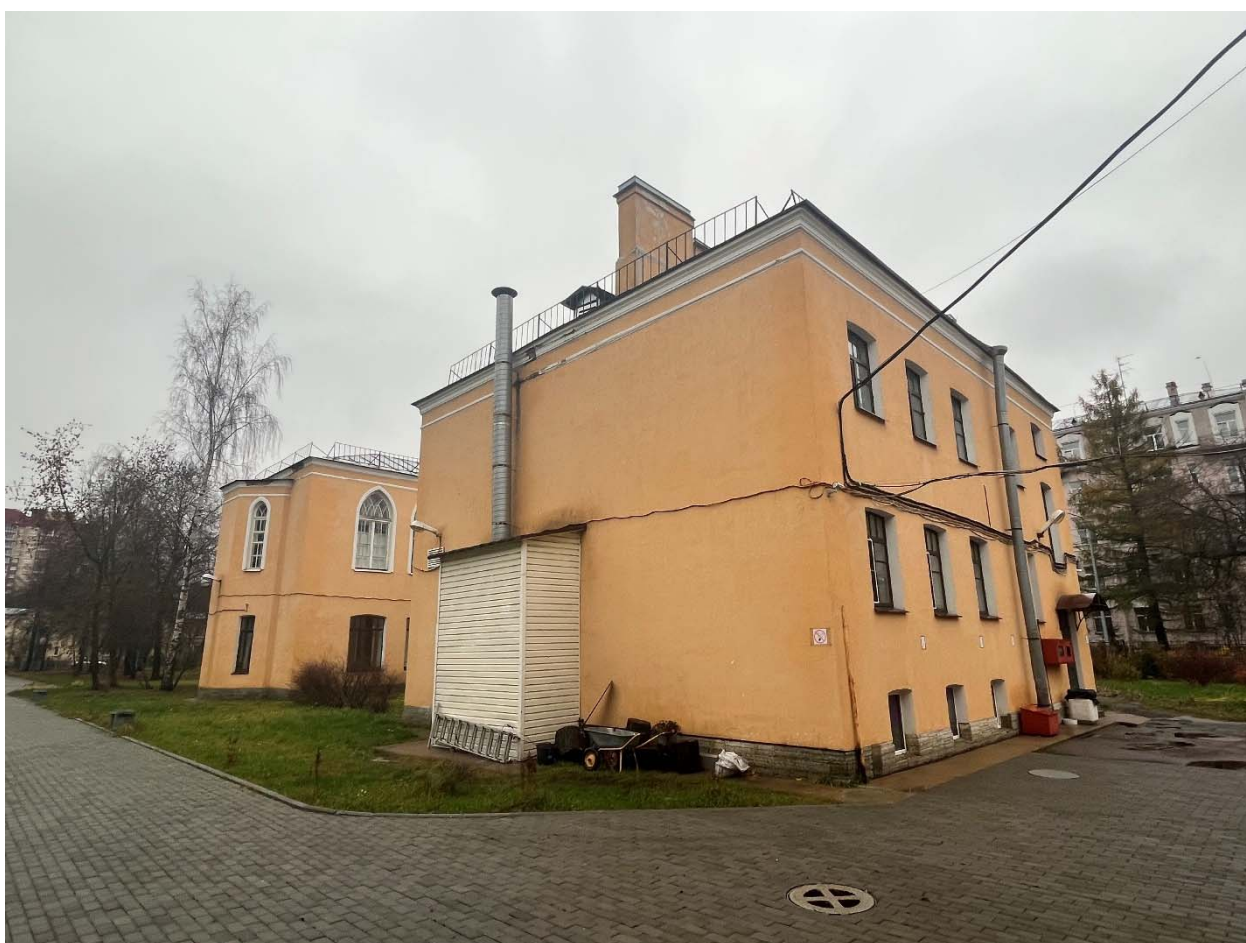
Фото.№12. Северный и западный фасады.
