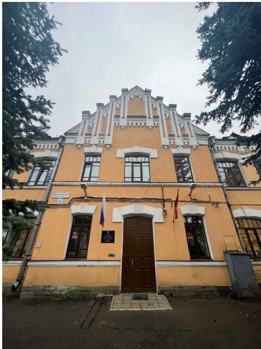
Фото №1. Северный лицевой фасад, фрагмент, главный вход.
