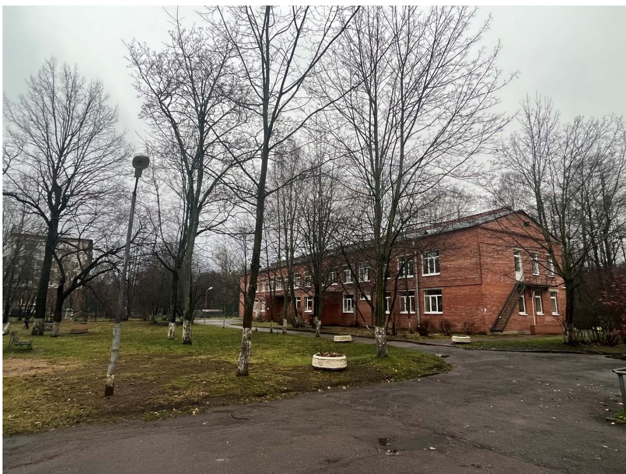
Фото №13. Западная часть участка, вид на северо-запад.
