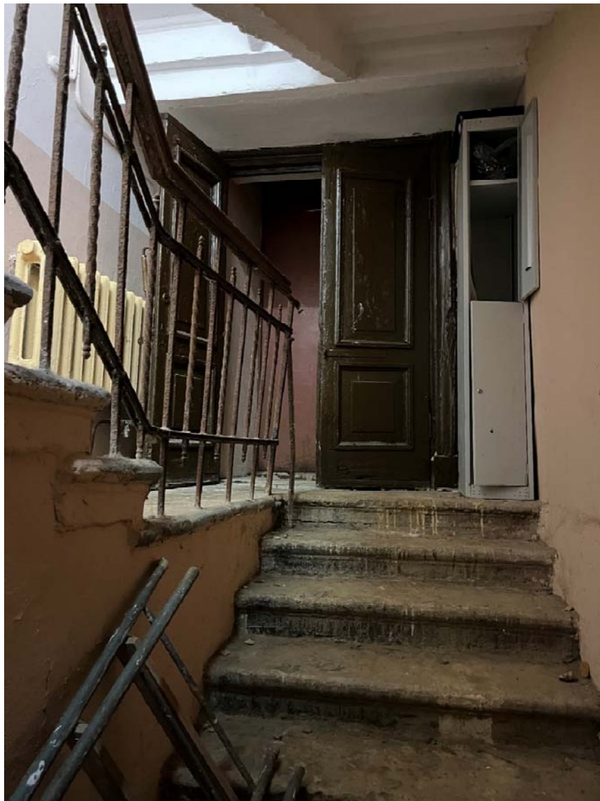
Фото №2. Вход в подвал со стороны северного фасада, лестничная клетка.
