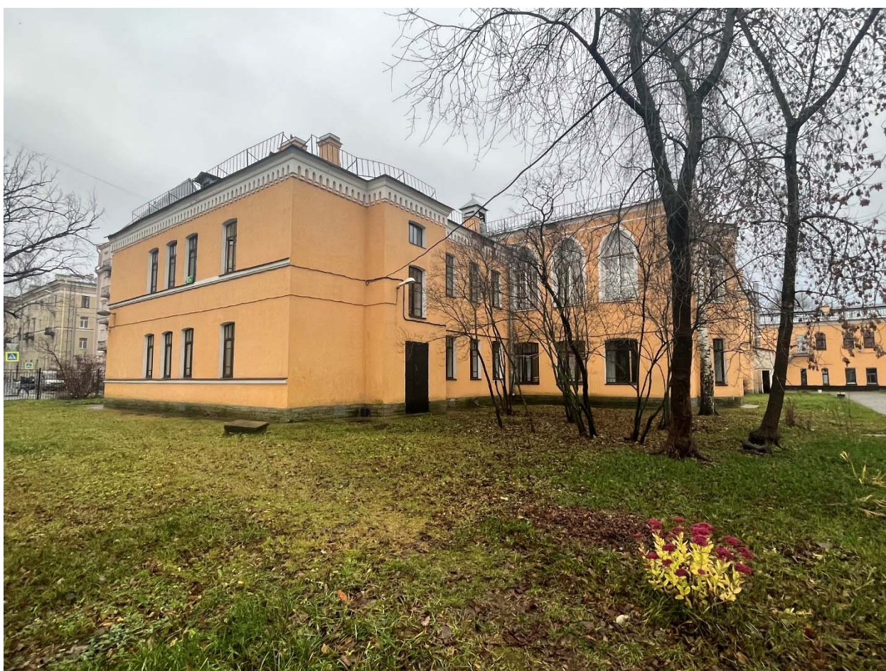
Фото№7. Восточный фасад, общий вид.
