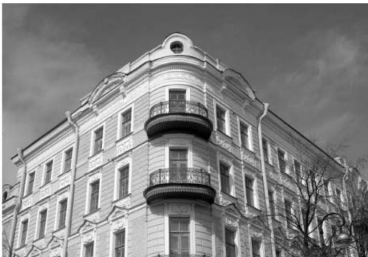
Илл. 40. Дом Никитина. Кронштадт, Ленина пр., 39; Велищинского ул., 1. Вид углового фасада. 2008г. URL: https://www.citywalls.ru/ .
