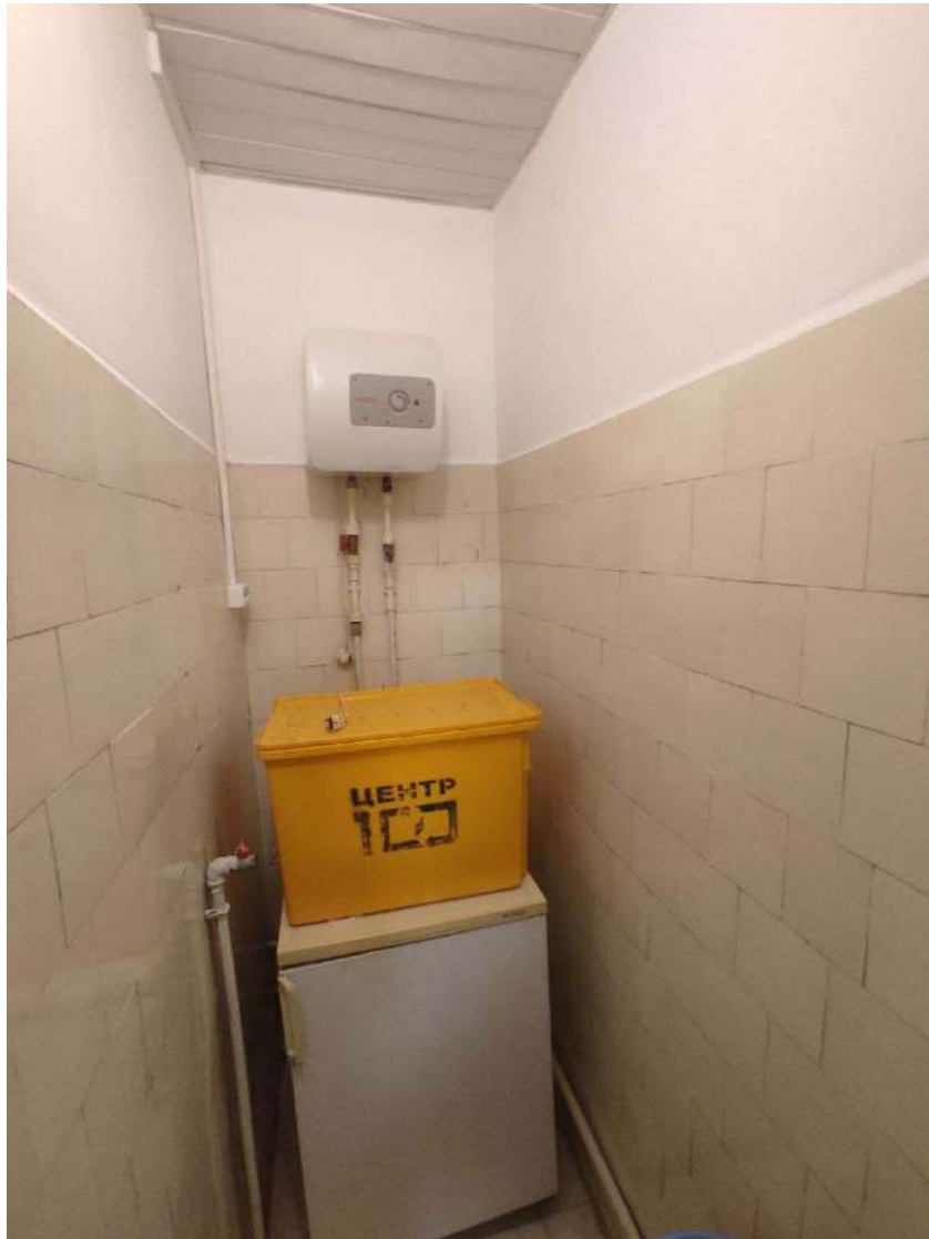
Фото 351. Цокольный – 1 этаж. Помещение №34
