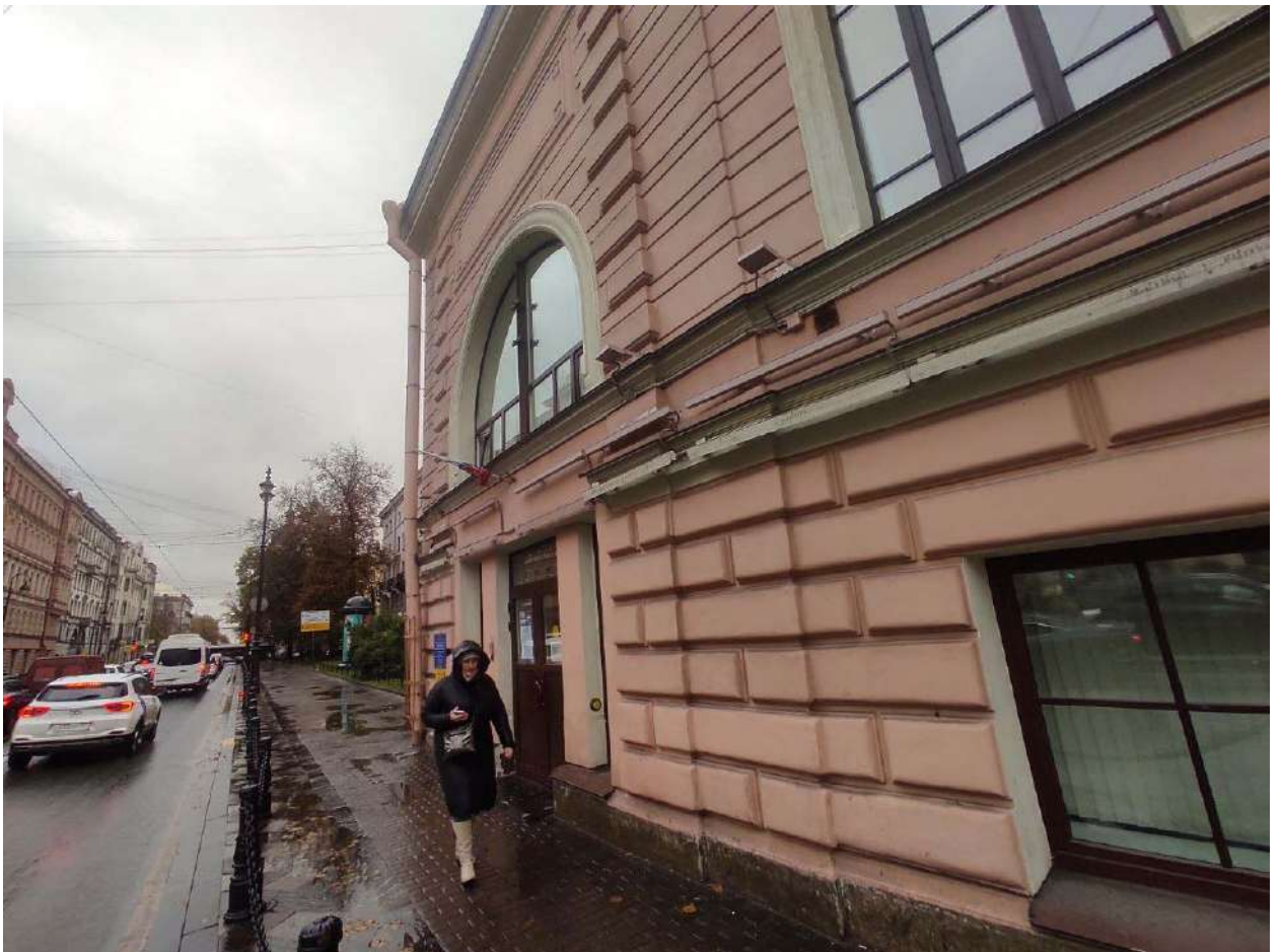
Фото 2. Северо-западный лицевой фасад флигеля по Каменноостровскому пр.
