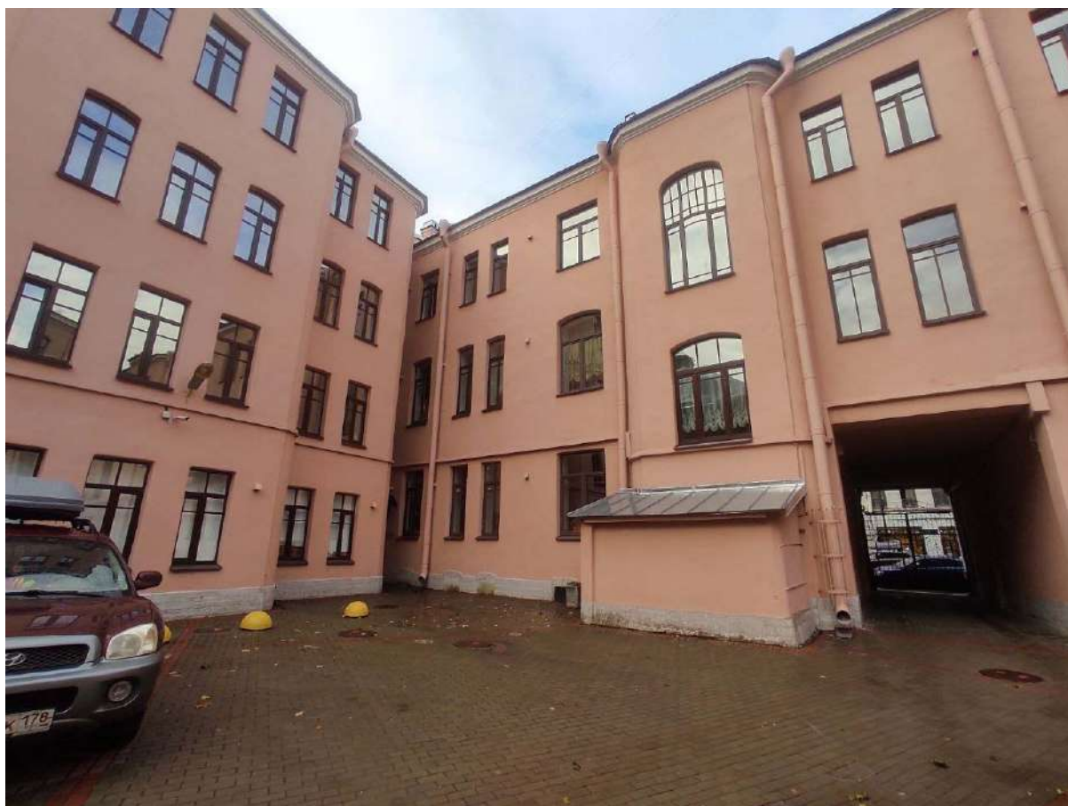
Фото 9. Юго-восточный дворовый фасад флигелей по Большому пр. П.С.
