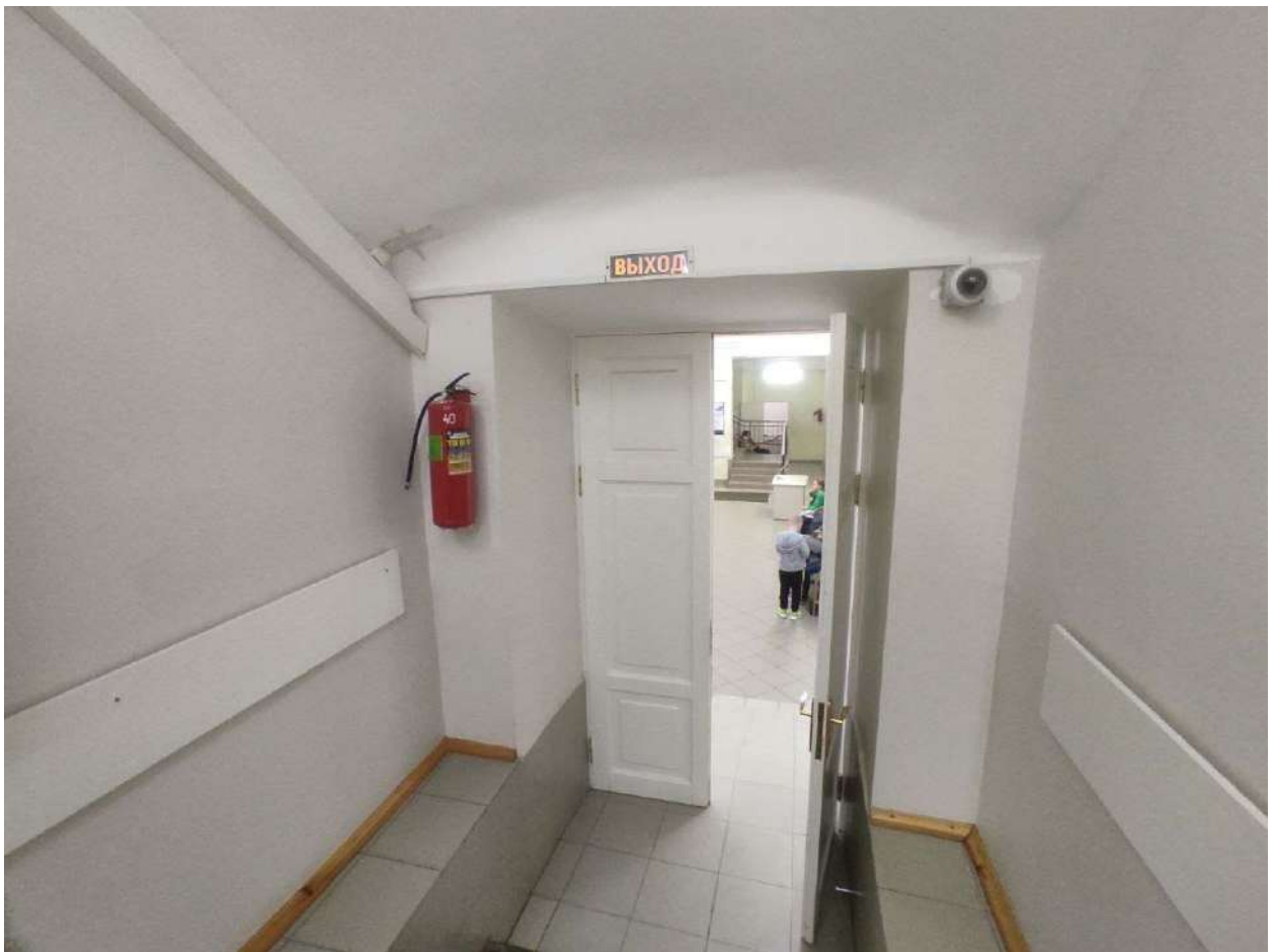
Фото 310. Цокольный – 1 этаж. Помещение №63
