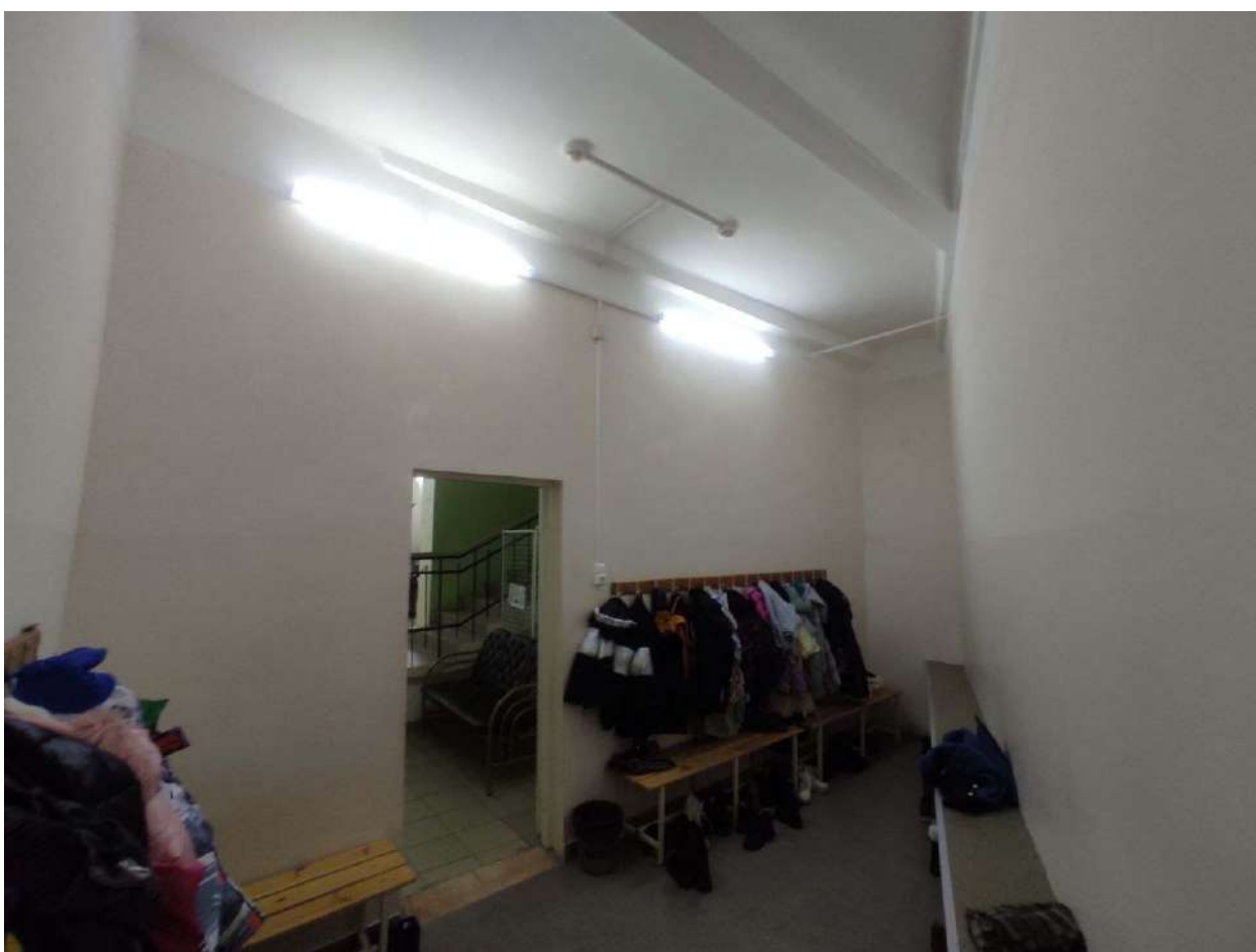
Фото 320. Цокольный – 1 этаж. Помещение № 78
