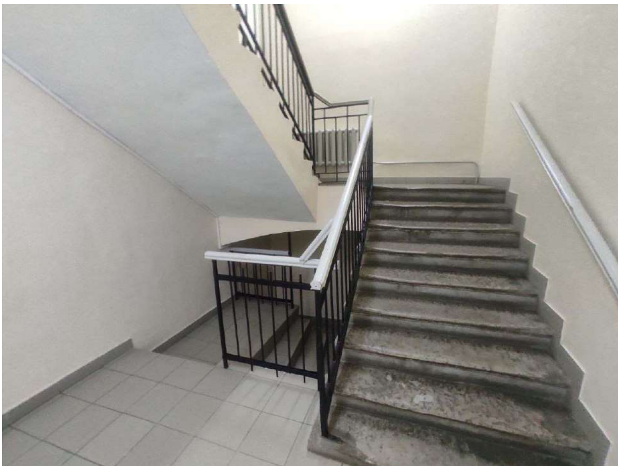
Фото 289. Помещение №131, лестница на цокольный-1 этаж
