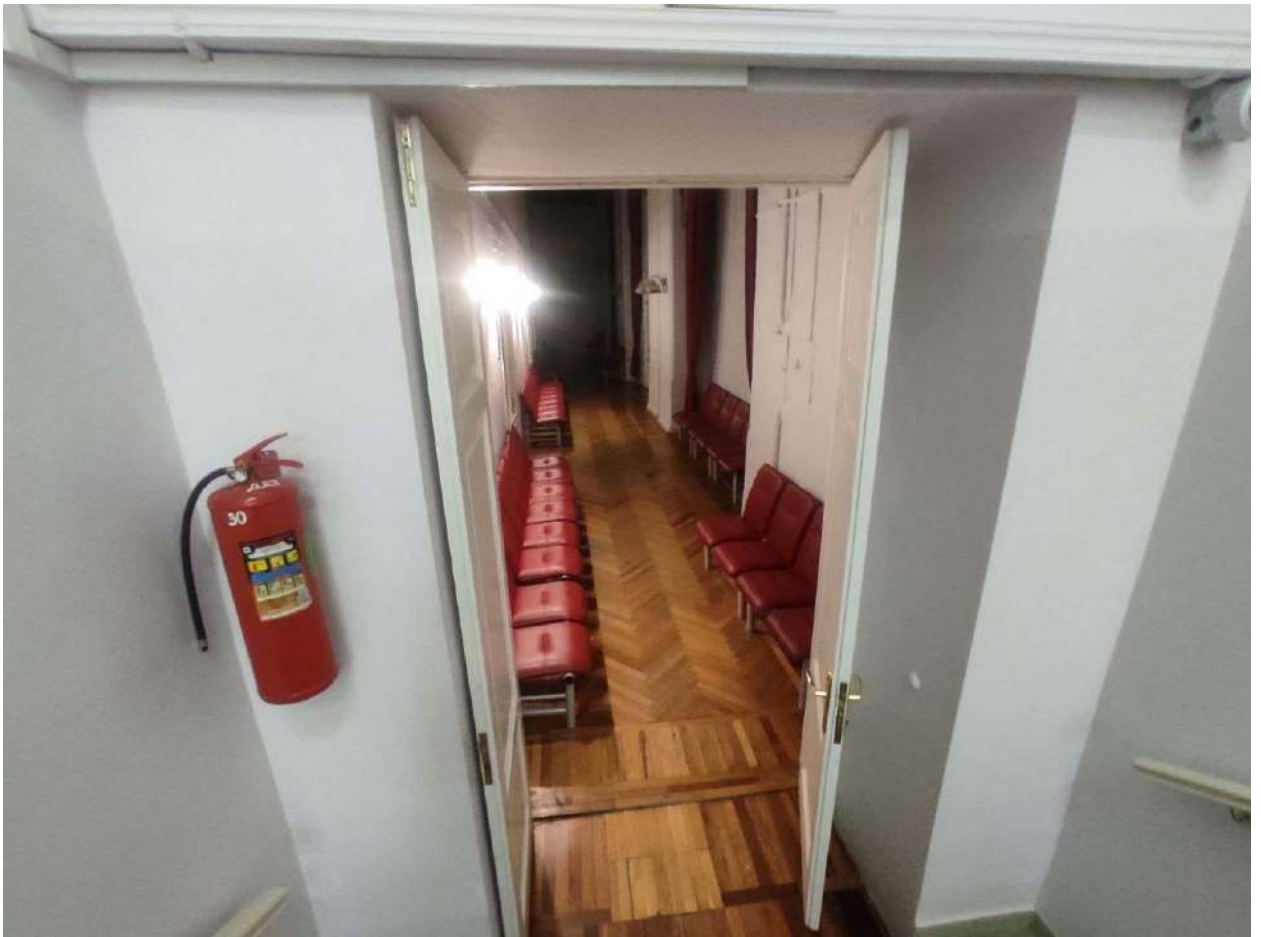
Фото 267. 2 этаж. Помещение №128. Коридор.
