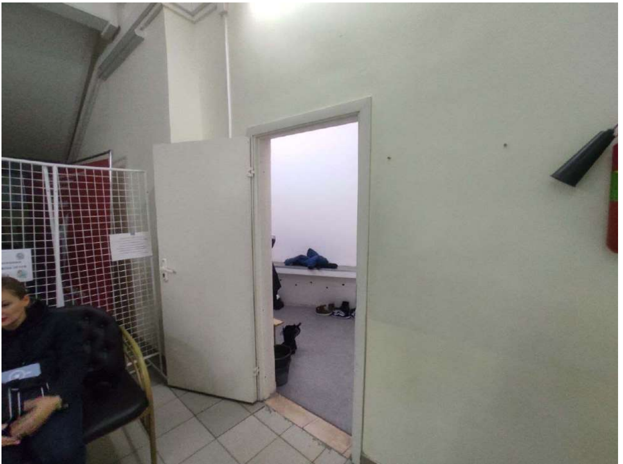
Фото 319. Цокольный – 1 этаж. Часть помещения № 75-122.8
