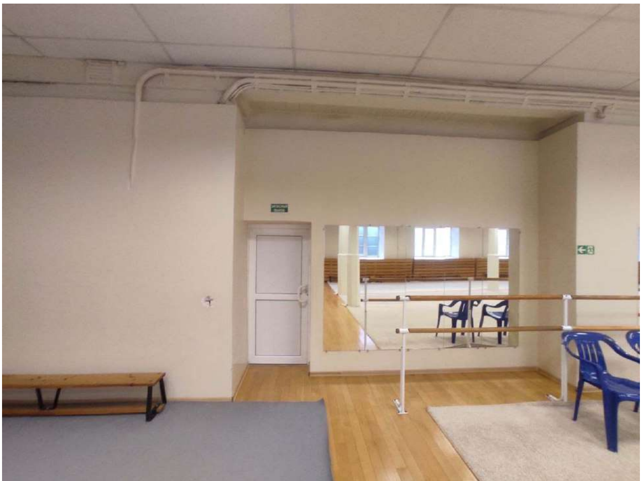
Фото 354. Цокольный – 1 этаж. Помещение №58-226.0
