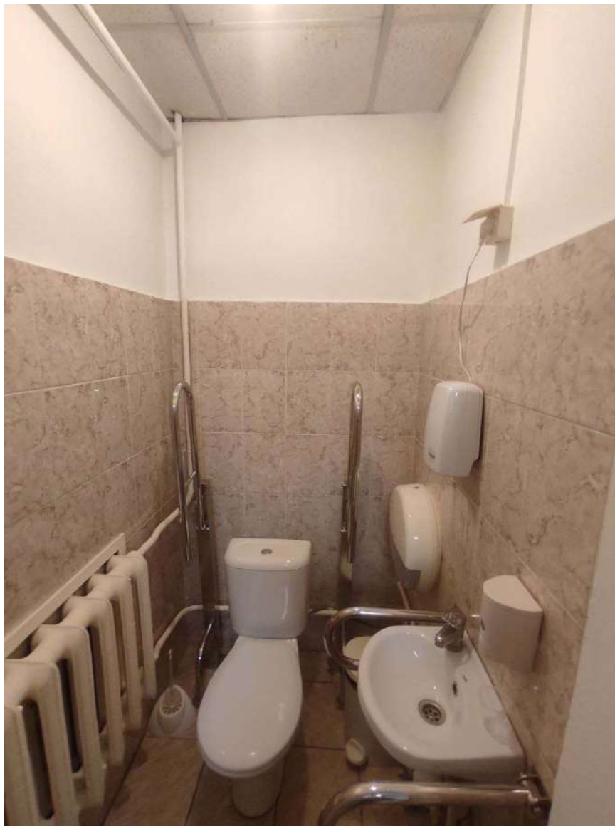
Фото 350. Цокольный – 1 этаж. Помещение №33
