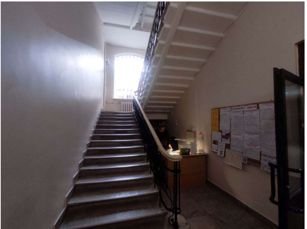
Фото 88. Цокольный – 1 этаж. Помещение №3
