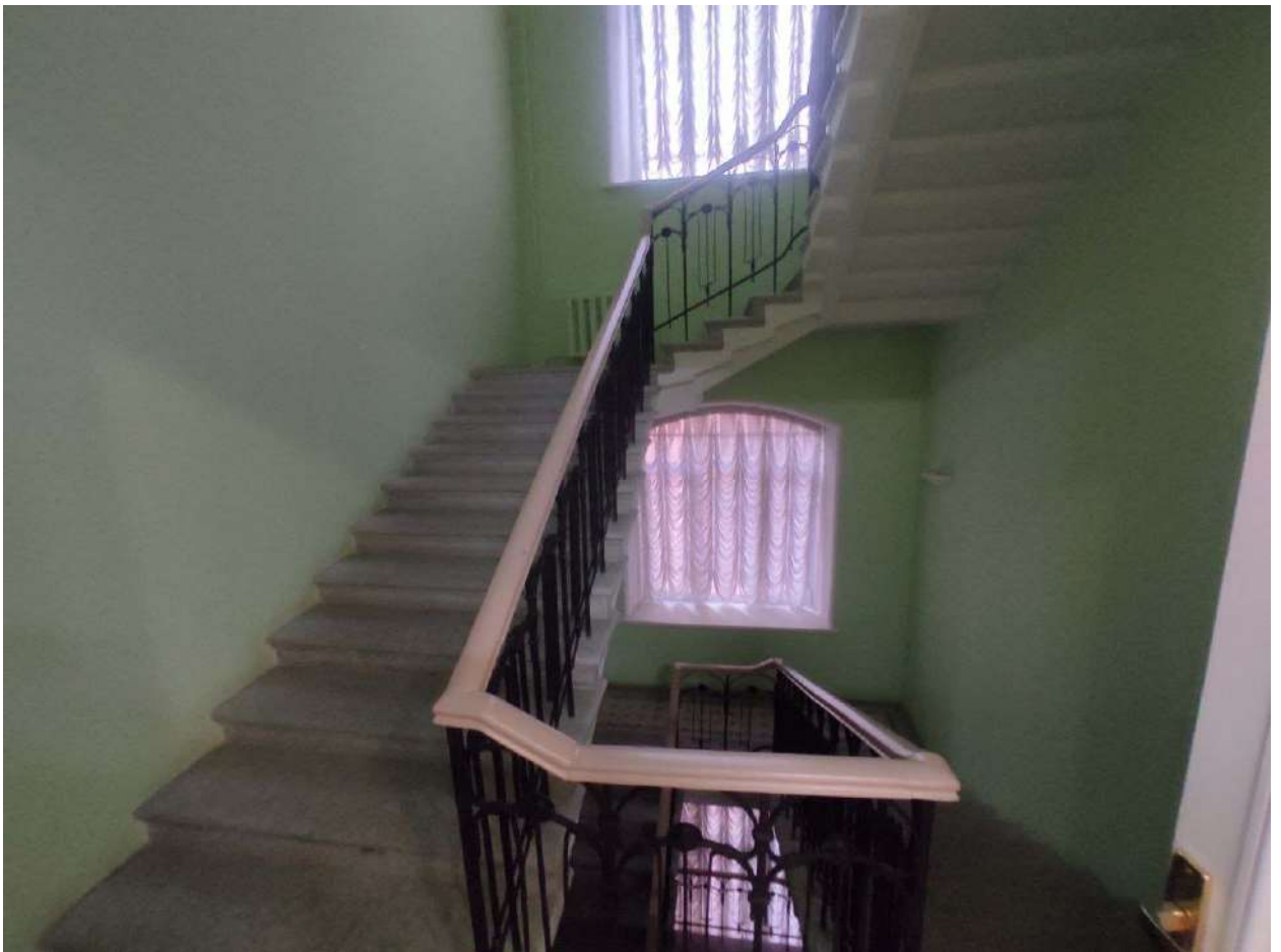
Фото 171. 3 этаж. Помещение №358. Лестница.
