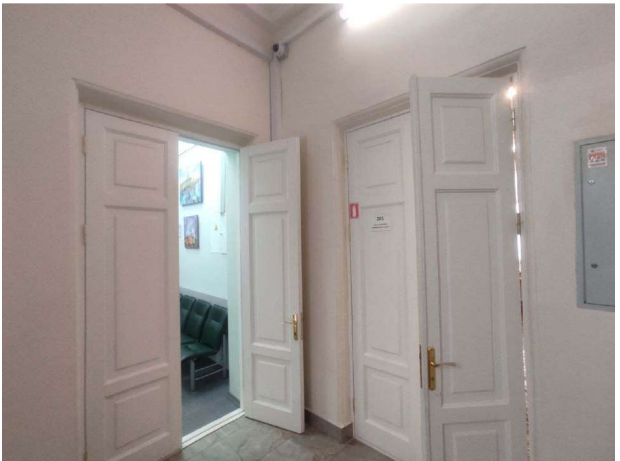
Фото 107. 2 этаж. Помещение №33. Коридор
