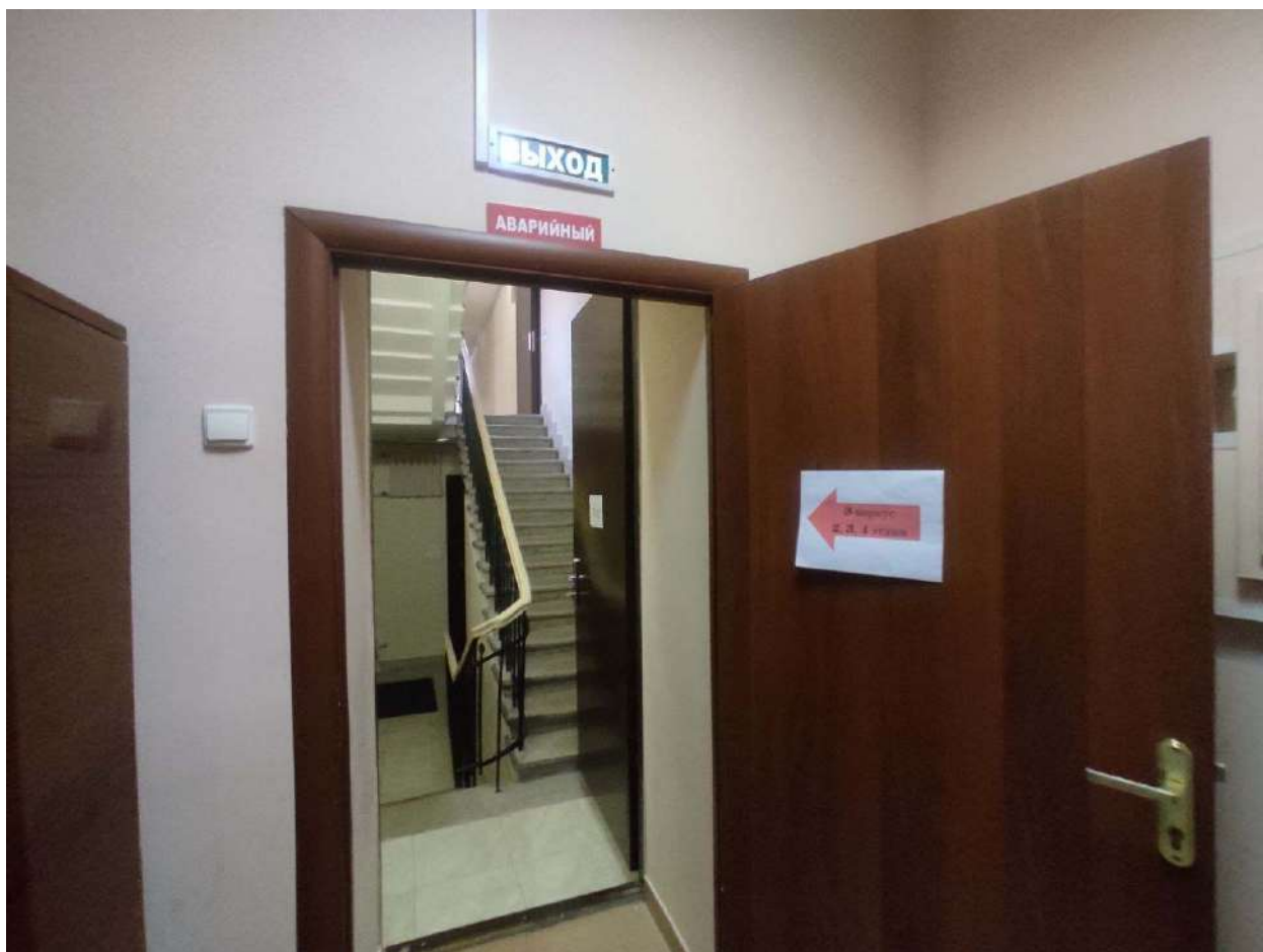
Фото 99. Цокольный – 1 этаж. Аварийный выход на лестницу.
