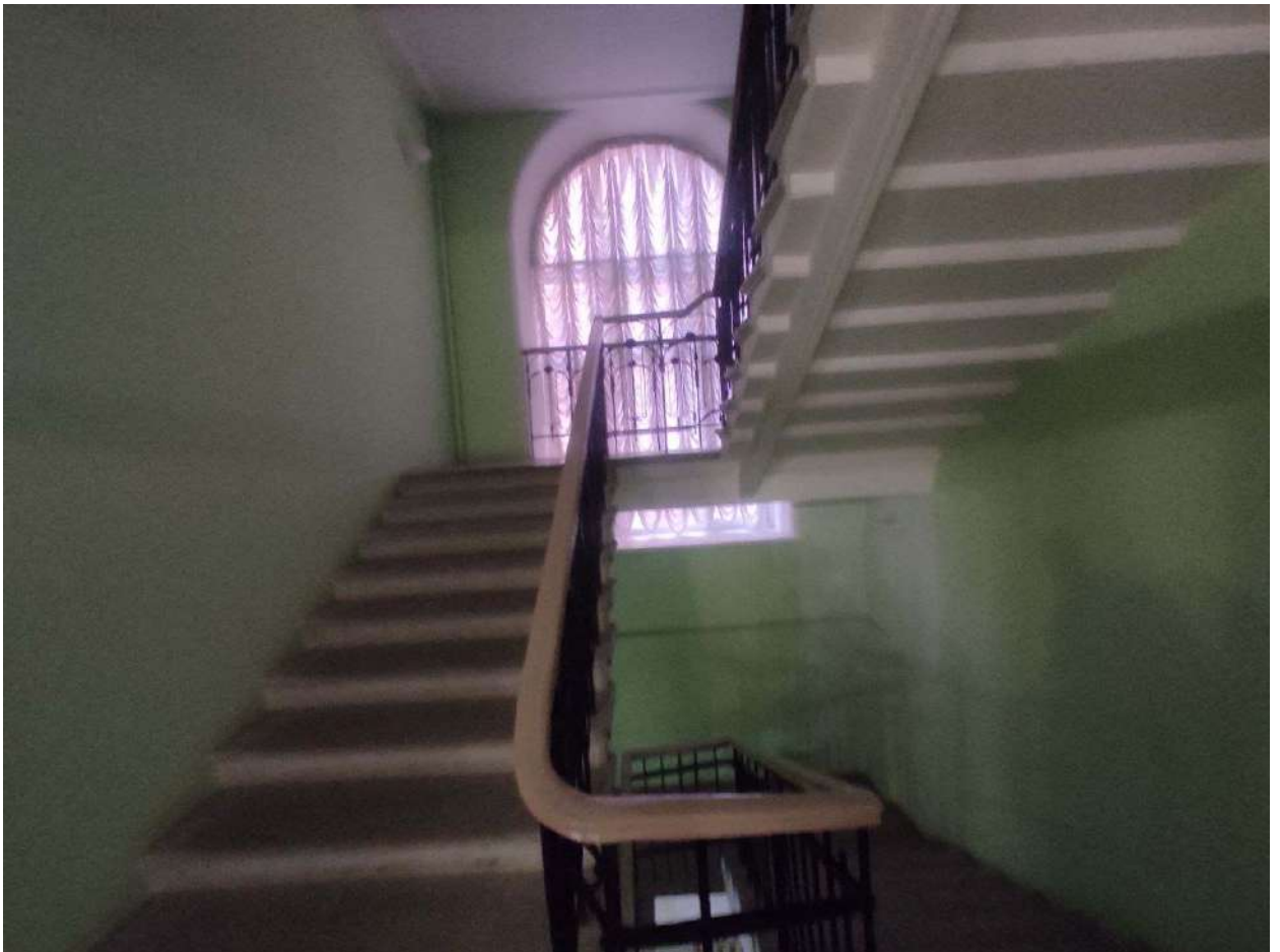
Фото 273. 2 этаж. Помещение №350, Лестница на 3 этаж.
