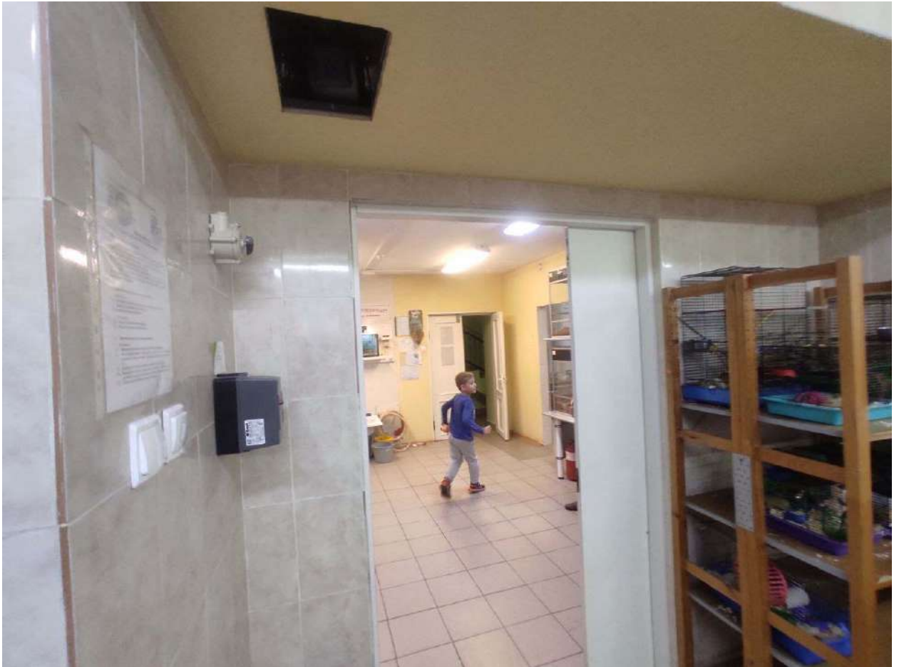
Фото 161. Цокольный – 1 этаж. Часть помещения №24-26
