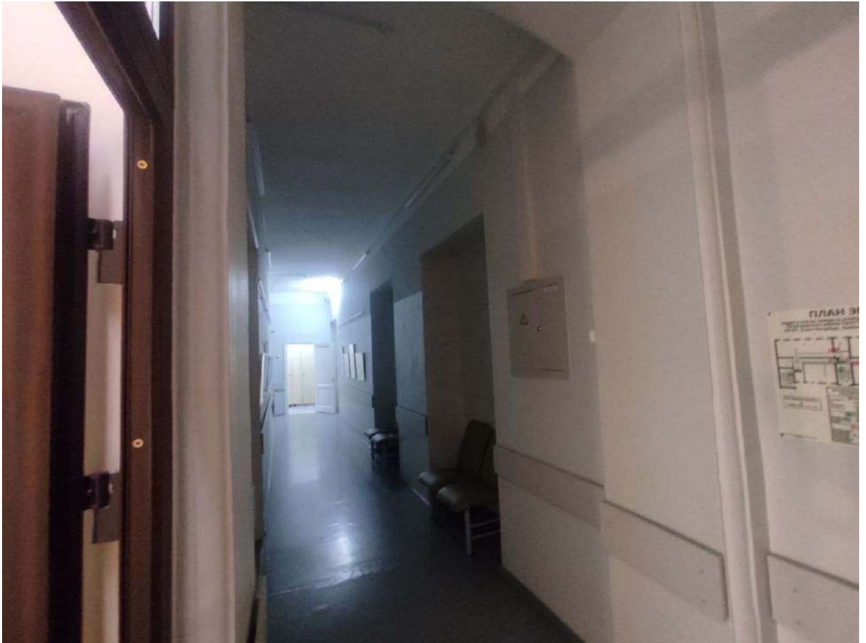
Фото 125. 3 этаж. Помещение №292. Коридор.
