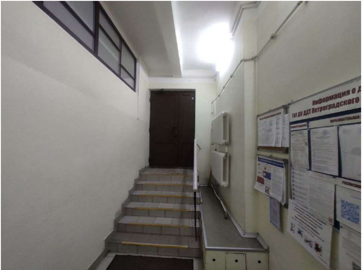
Фото 321. Цокольный – 1 этаж. Помещение № 77
