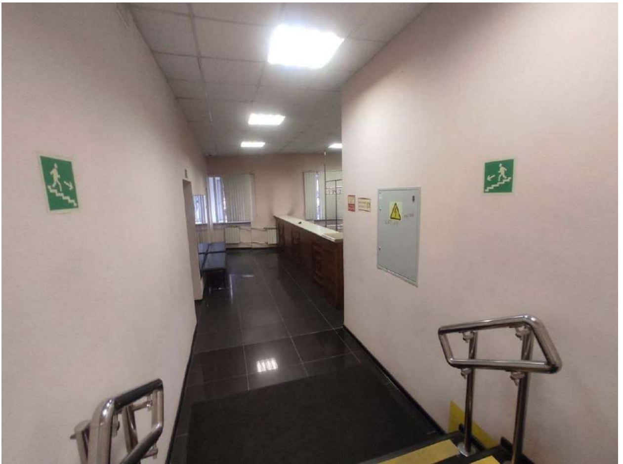
Фото 376. Цокольный – 1 этаж. Помещение №7
