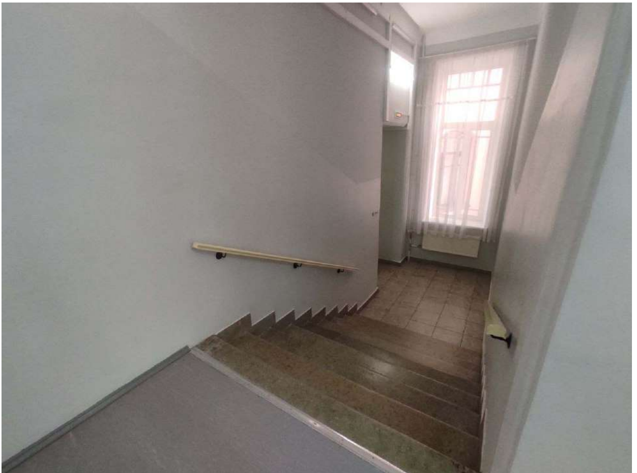
Фото 147. Лестница с 3 на 2 этаж. Помещение №141
