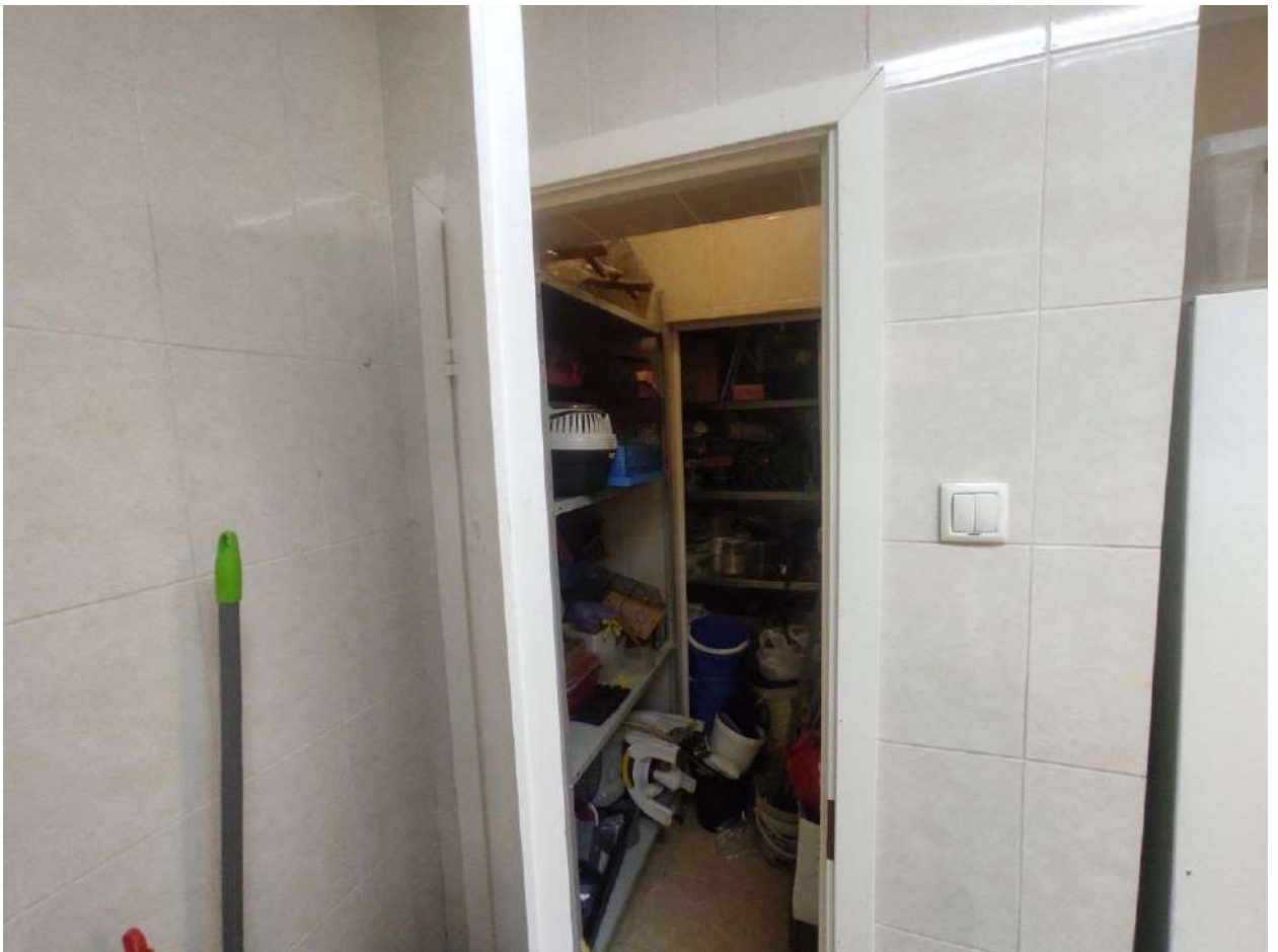
Фото 156. Цокольный – 1 этаж. Часть помещения №28-33.4
