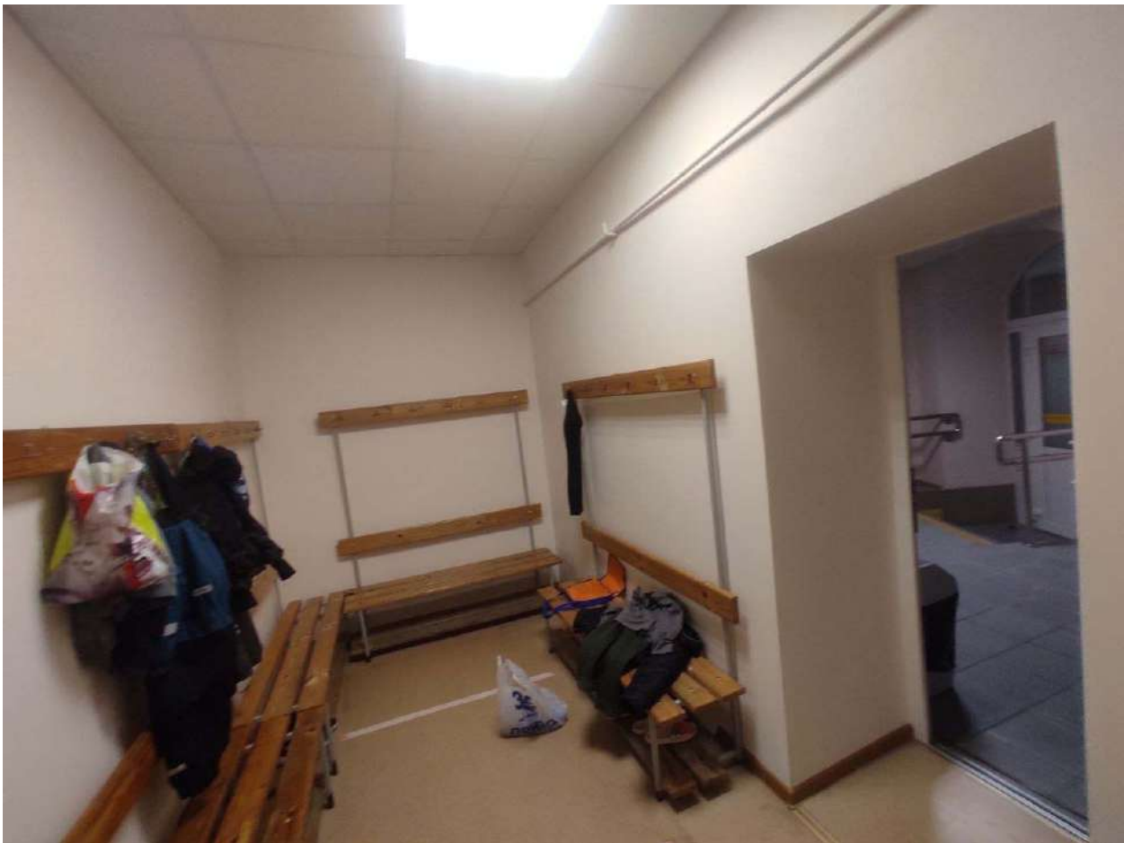
Фото 348. Цокольный – 1 этаж. Помещение №36
