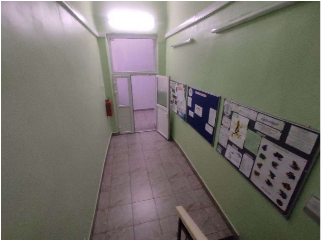
Фото 162. Цокольный – 1 этаж. Часть помещения №23
