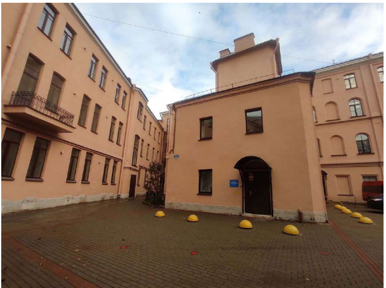
Фото 10. Дворовые фасады флигелей по Большому пр. П.С и Каменноостровскому пр.
