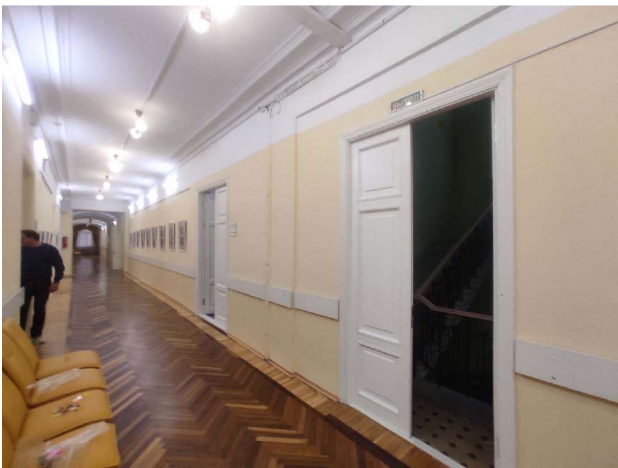
Фото 170. 3 этаж. Помещение №180-92.9. Коридор.
