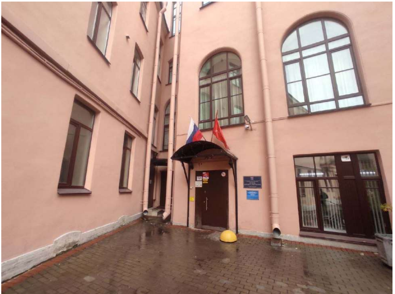
Фото 7. Юго-восточный дворовый фасад флигелей по Большому пр. П.С.
