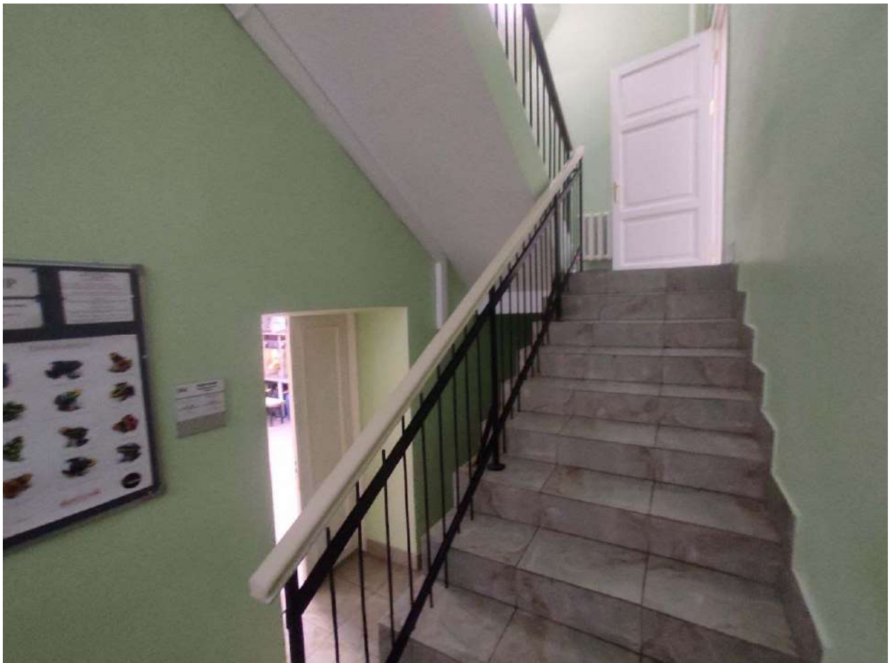
Фото 153. Помещение №202, лестница со 2 этажа на 1.
