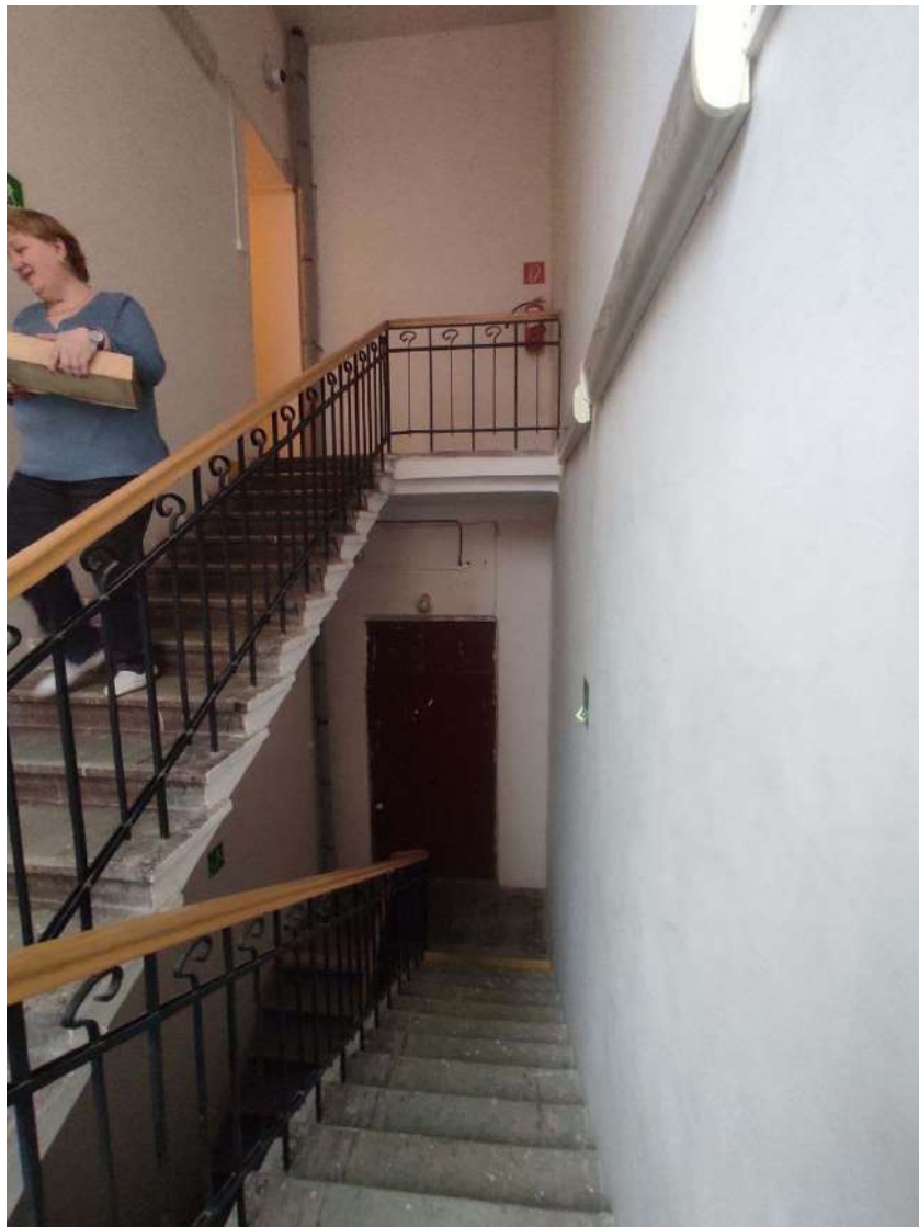
Фото 443. 2 этаж. Помещение №225, лестница на 1 этаж
