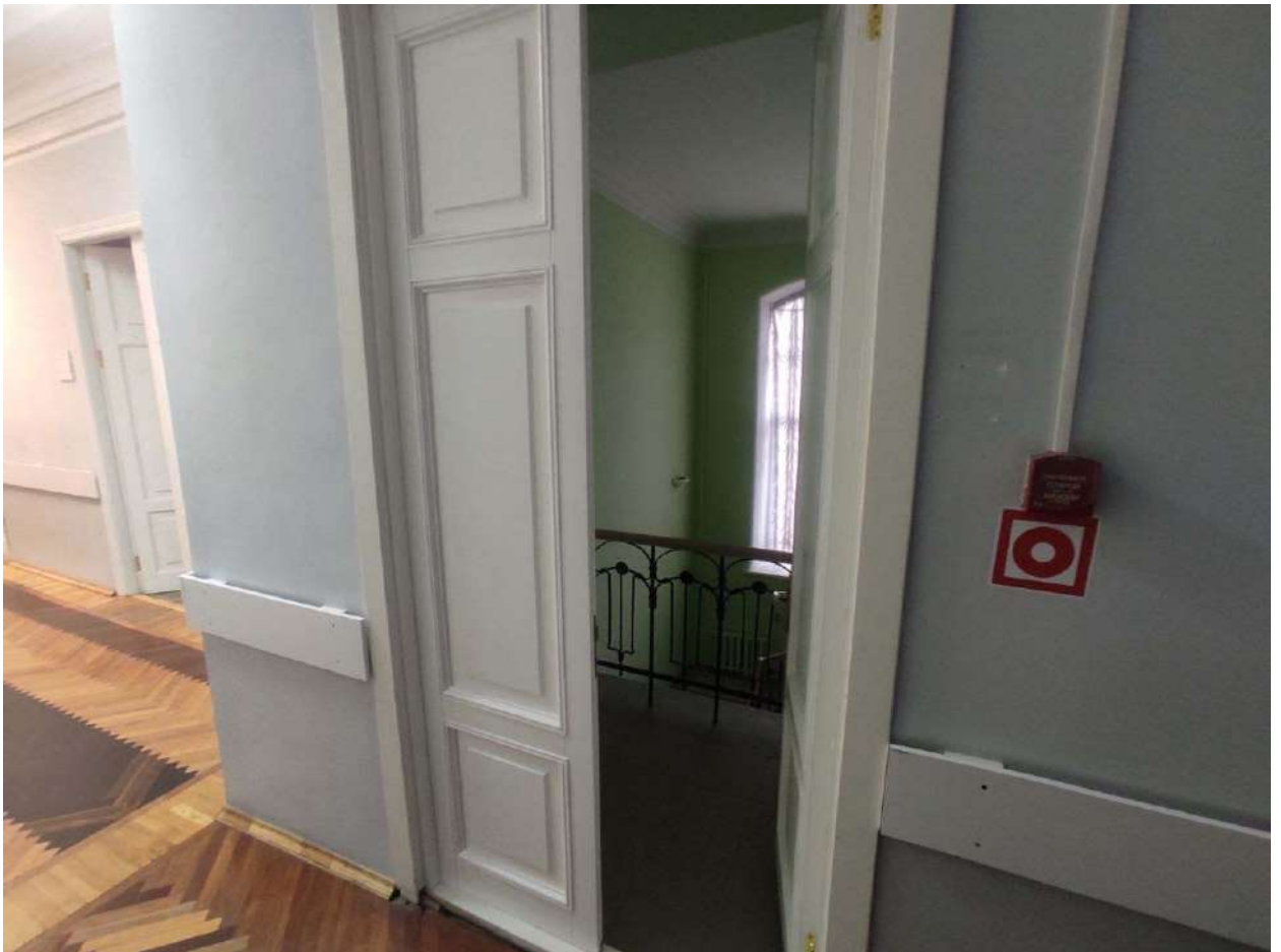
Фото 241. 4 этаж. Помещение №214, лестница
