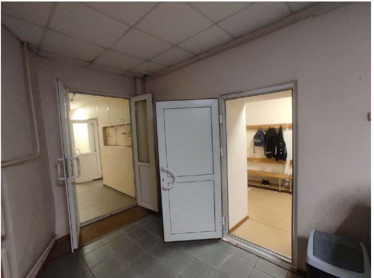
Фото 346. Цокольный – 1 этаж. Помещение №37
