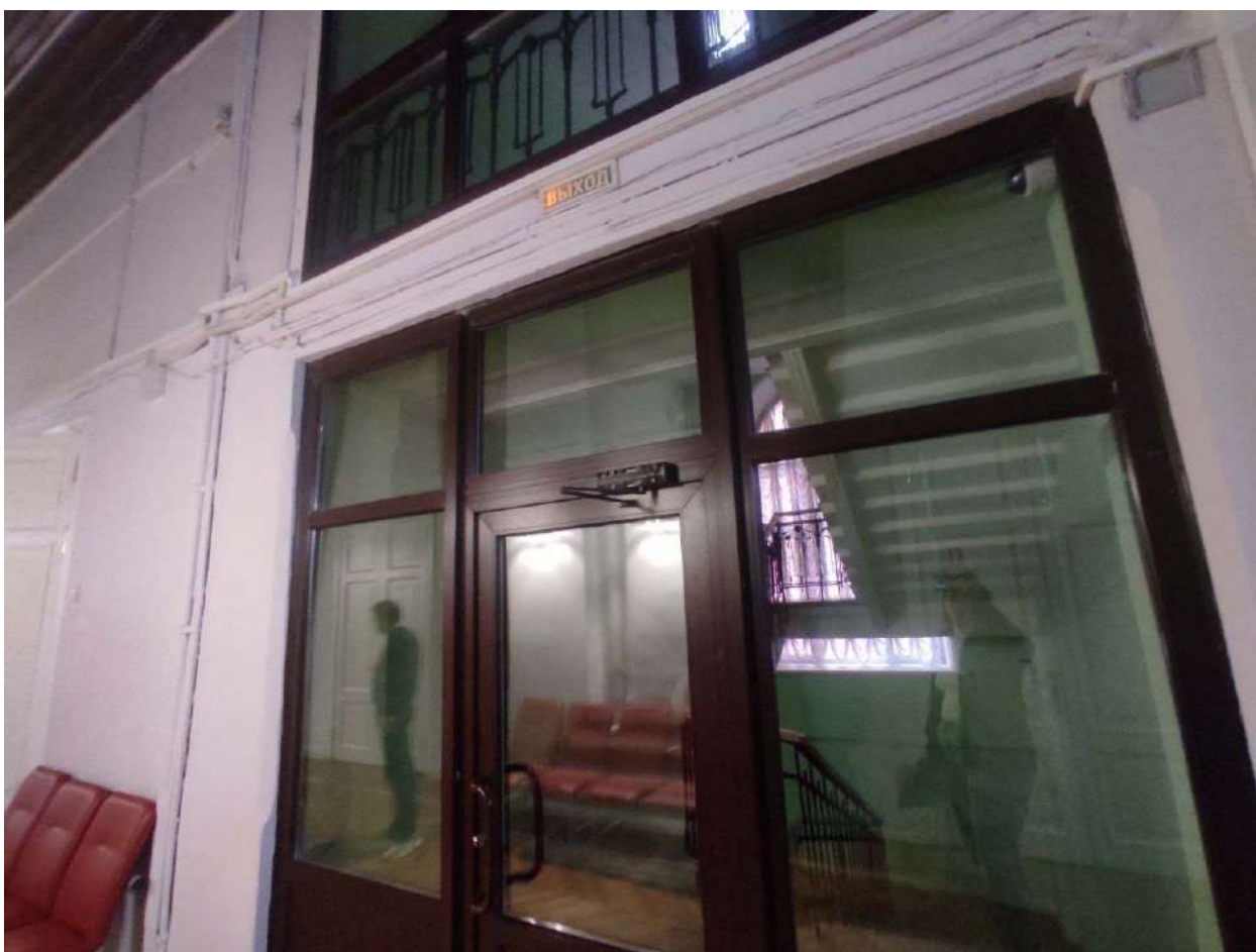
Фото 272. 2 этаж. Помещение №350, выход на лестницу.
