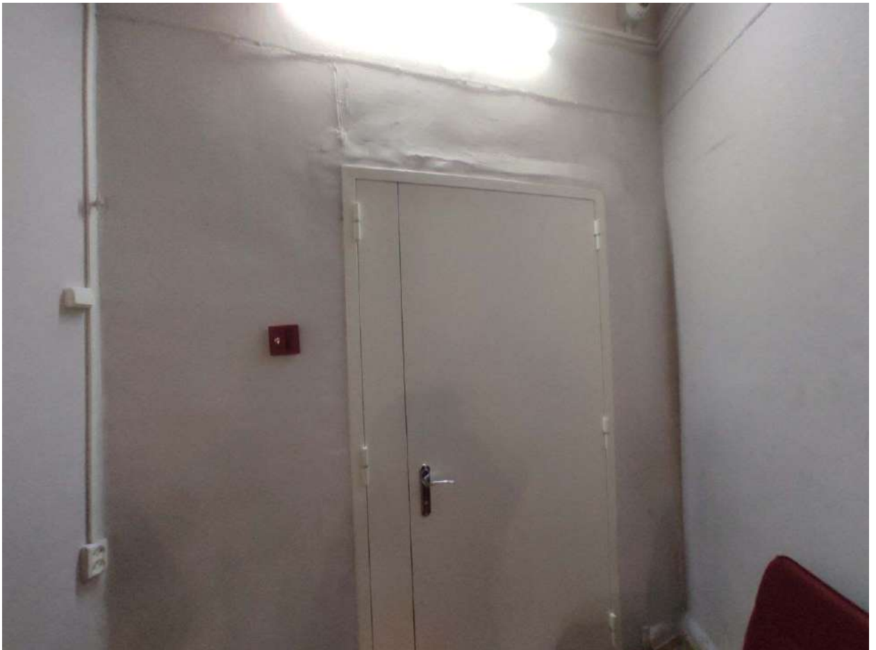
Фото 275. 2 этаж. Выход в помещение №109. Коридор.
