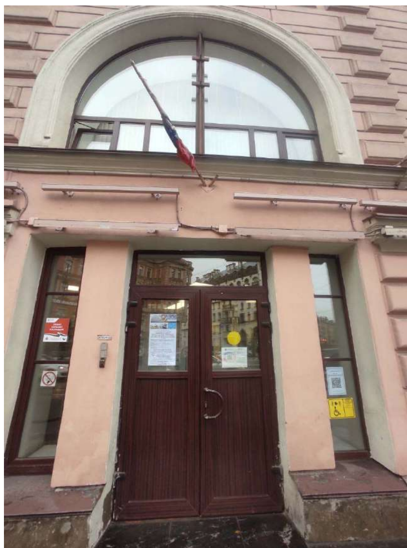
Фото 1. Северо-западный лицевой фасад флигеля по Каменноостровскому пр.
