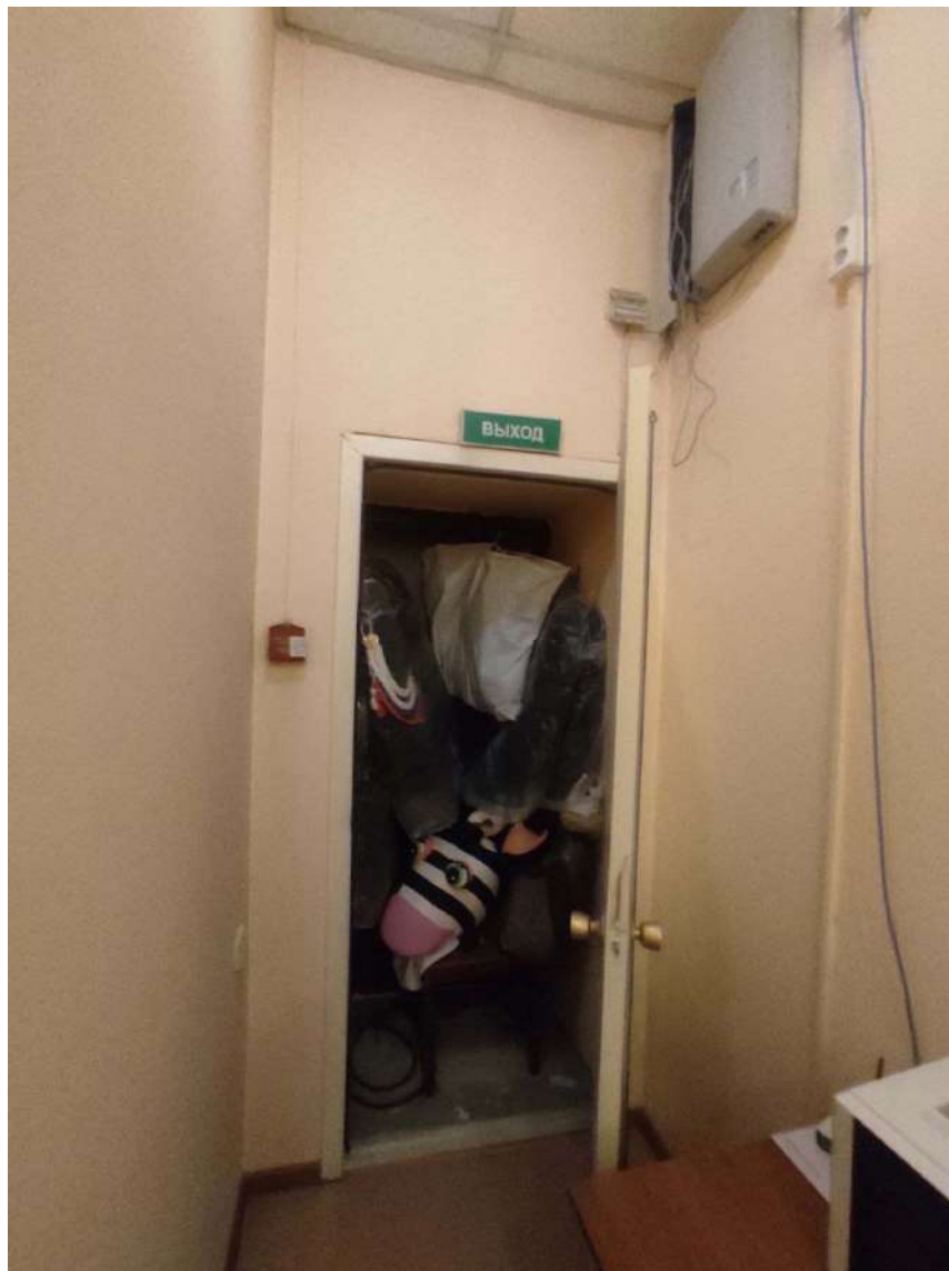
Фото 340. 2 этаж. Помещение № 122. Аварийный выход
