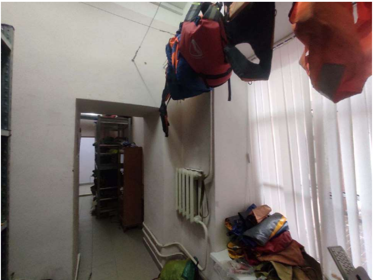
Фото 308. Цокольный – 1 этаж. Помещение №71
