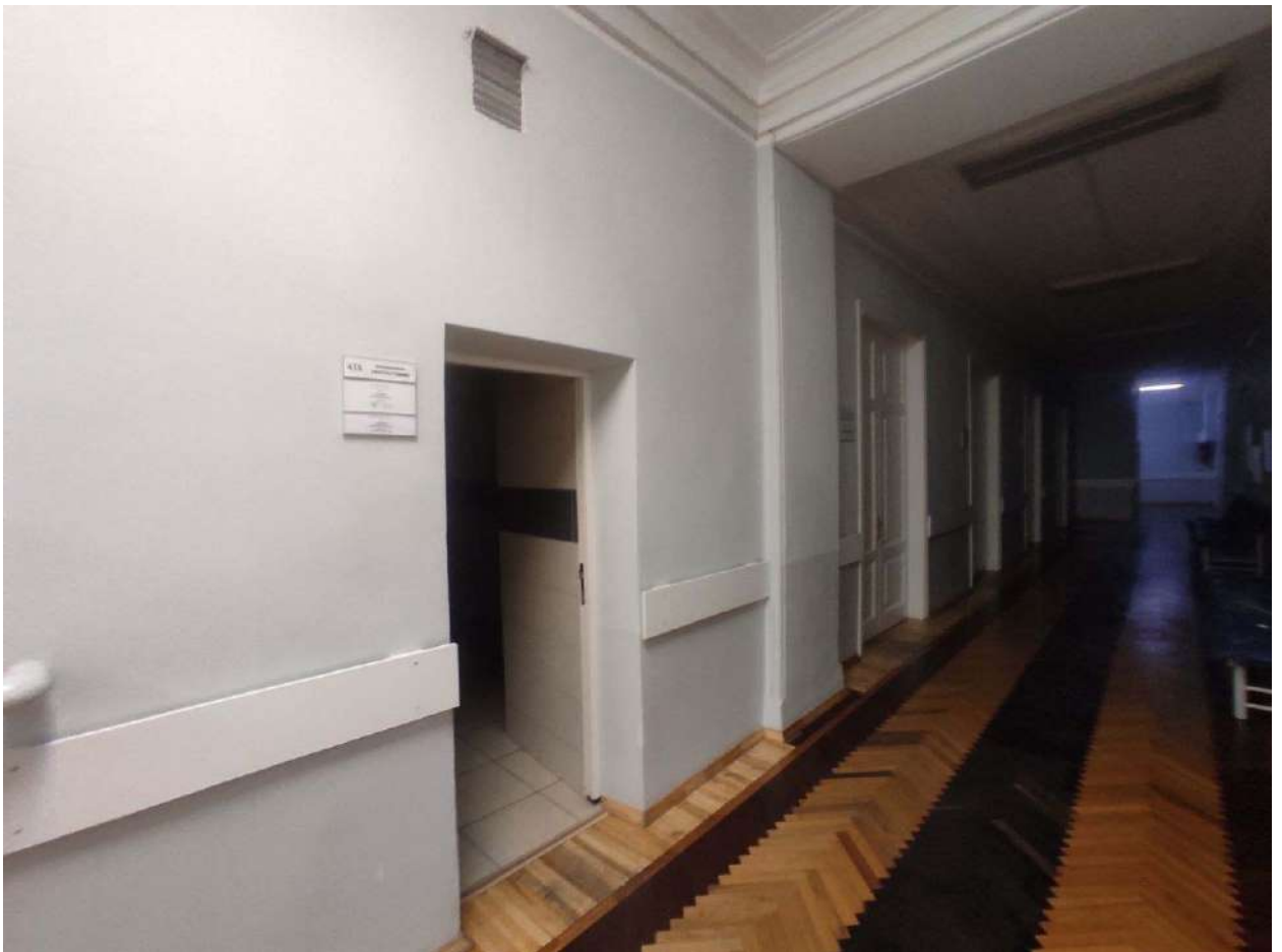
Фото 223. 4 этаж. Помещение №200-102.4. Коридор.
