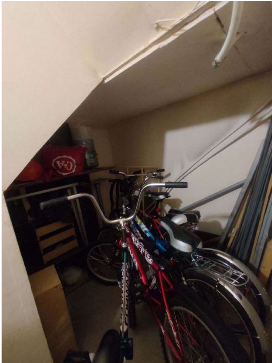
Фото 332. Цокольный – 1 этаж. Помещение № 2.10
