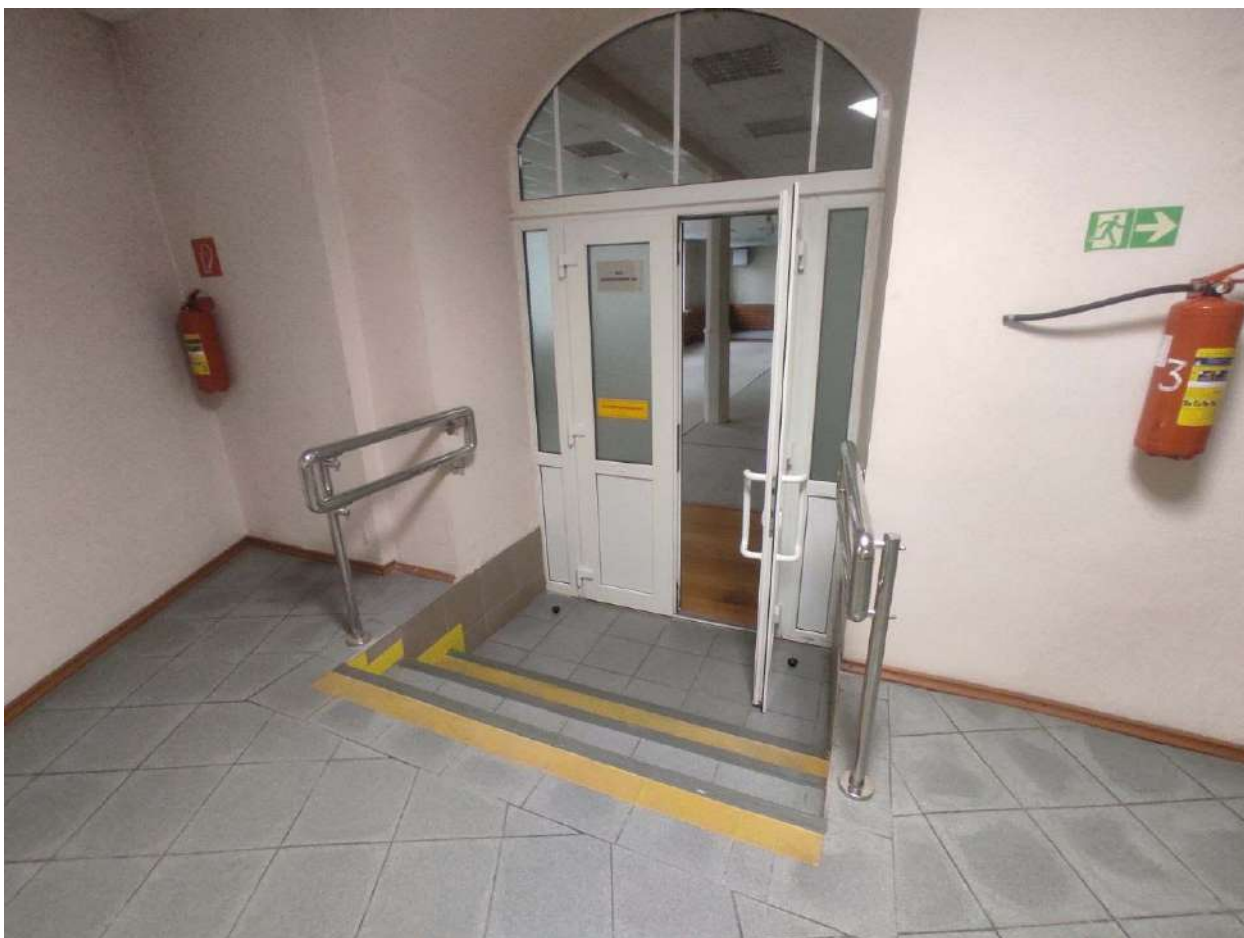
Фото 352. Цокольный – 1 этаж. Помещение №37
