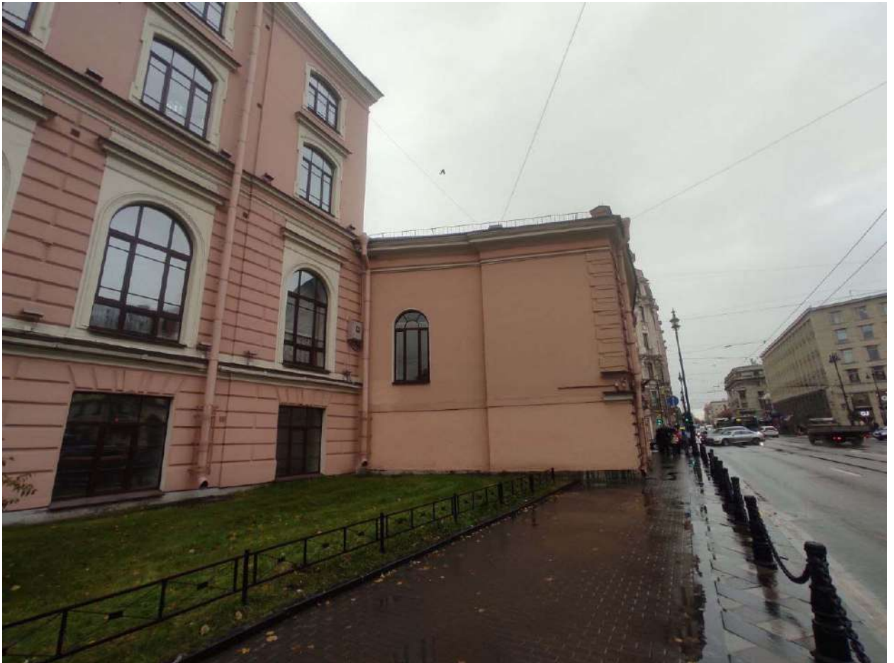
Фото 5. Северо-западный лицевой фасад флигеля по Каменноостровскому пр.
