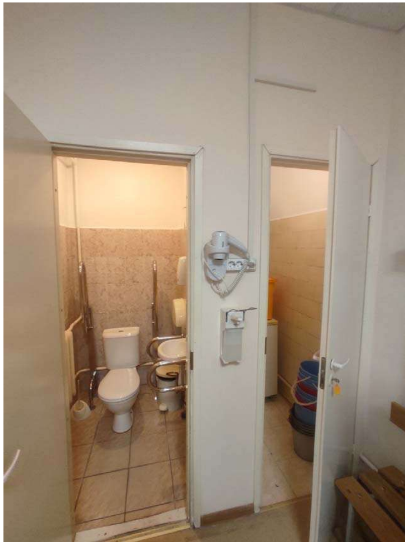
Фото 349. Цокольный – 1 этаж. Помещение №33,34
