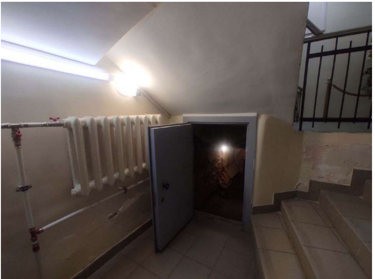
Фото 62. Цокольный – 1 этаж. Помещение №205
