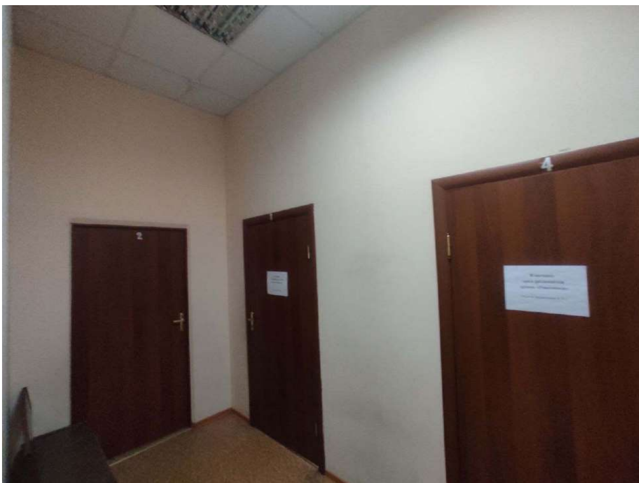
Фото 101. Цокольный – 1 этаж. Помещение №6-35.1
