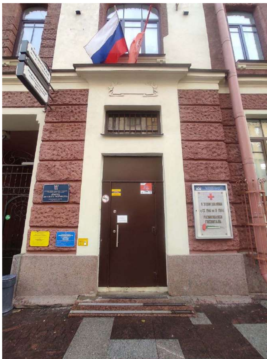
Фото 6. Северо-западный лицевой фасад вход во флигель по Большому пр. П.С.
