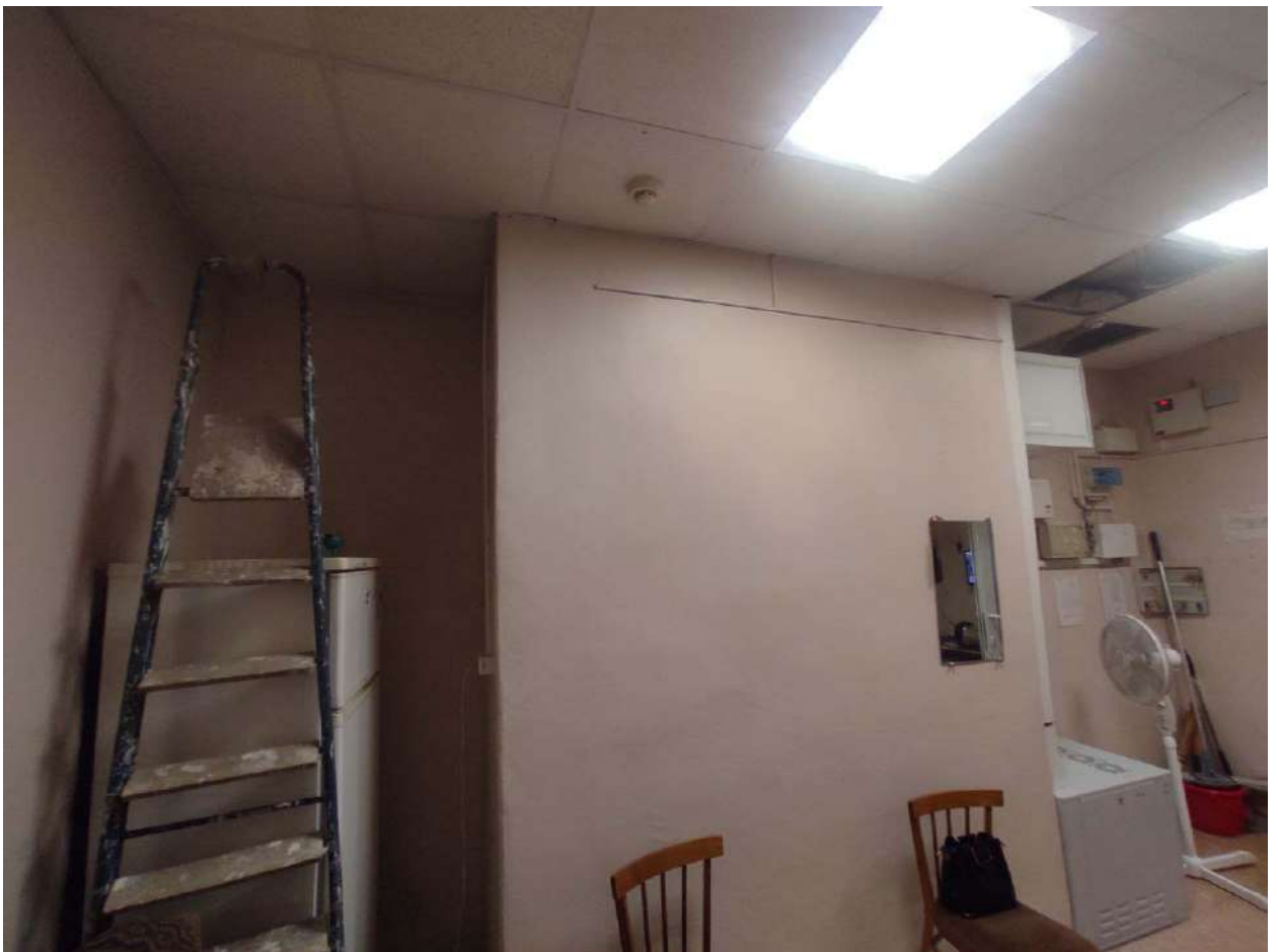
Фото 360. Цокольный – 1 этаж. Помещение №5.28
