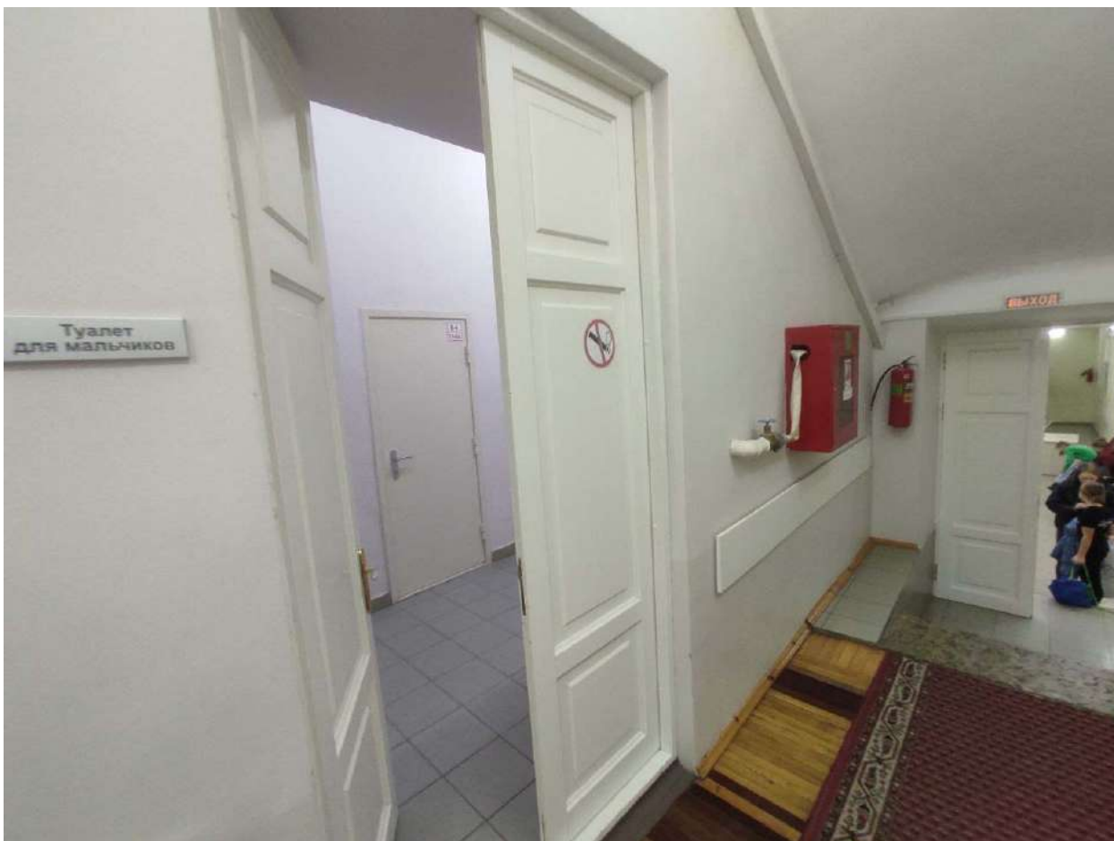
Фото 304. Цокольный – 1 этаж. Помещение №68
