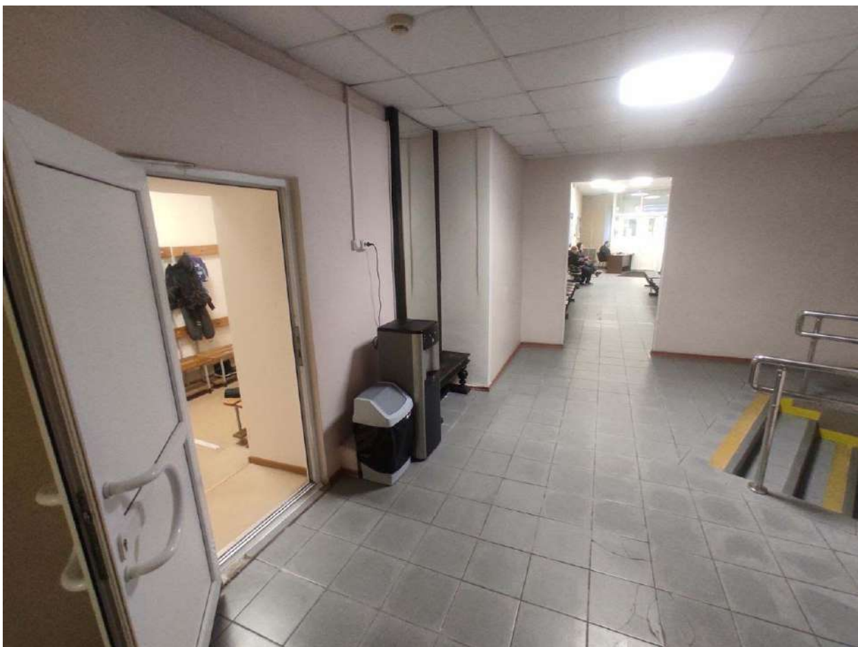
Фото 344. Цокольный – 1 этаж. Помещение №37
