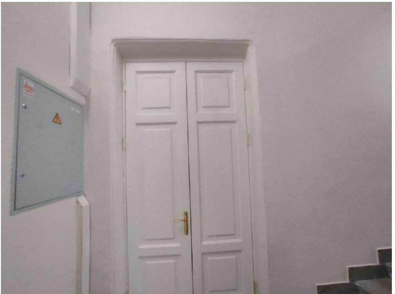
Фото 122. 2 этаж. Помещение №83. Коридор, вход в помещение №94
