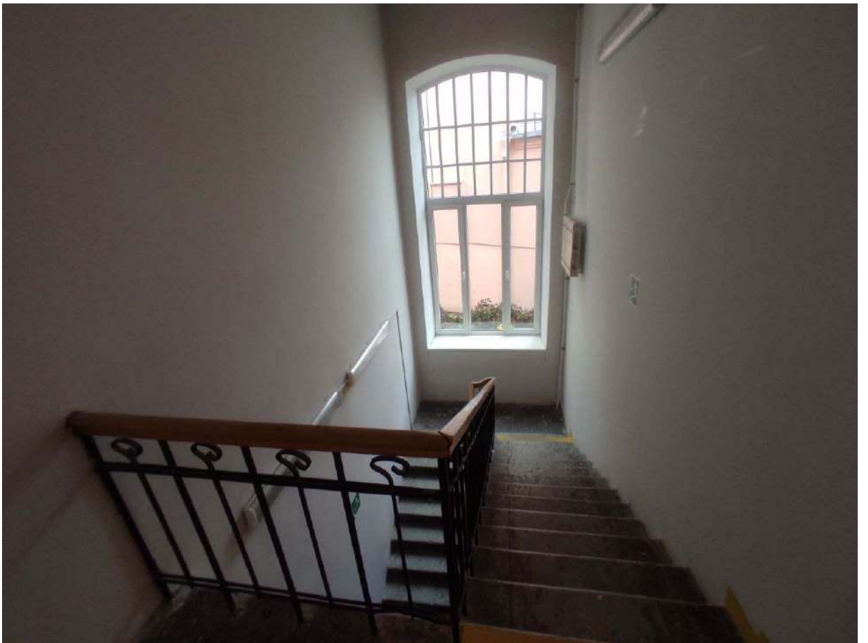
Фото 442. 2 этаж. Помещение №225, лестница на 1 этаж
