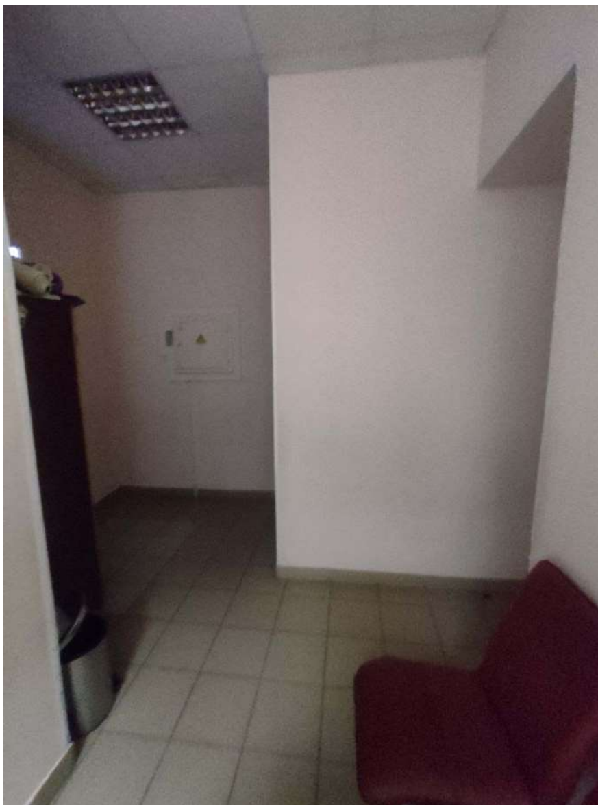
Фото 103. Цокольный – 1 этаж. Помещение №5-01. Коридор.
