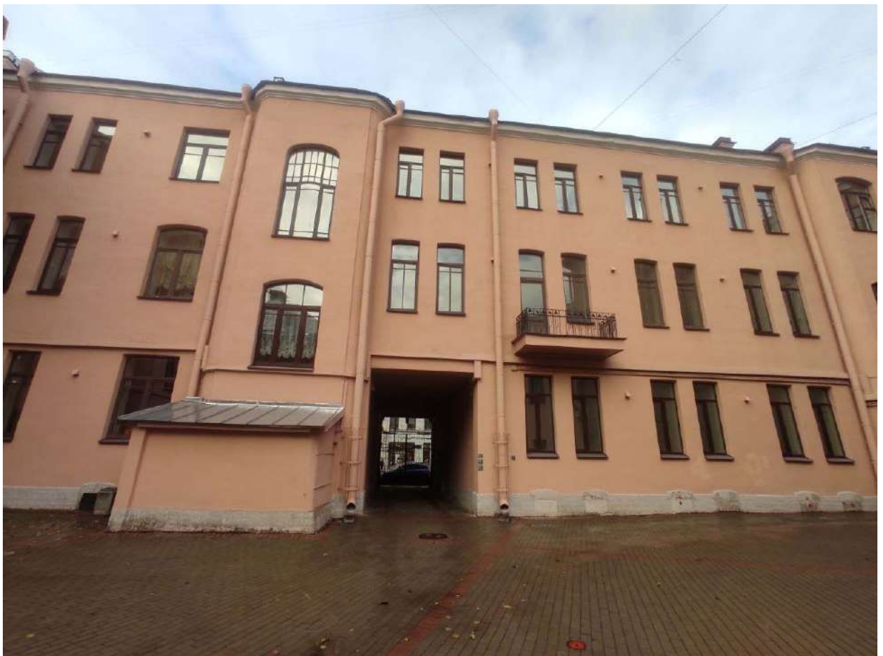
Фото 8. Юго-восточный дворовый фасад флигелей по Большому пр. П.С.
