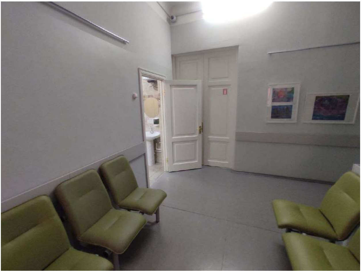
Фото 132. 3 этаж. Помещение №143. Коридор.
