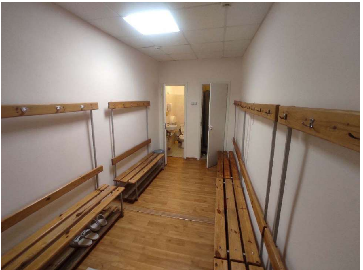
Фото 366. Цокольный – 1 этаж. Помещение №51
