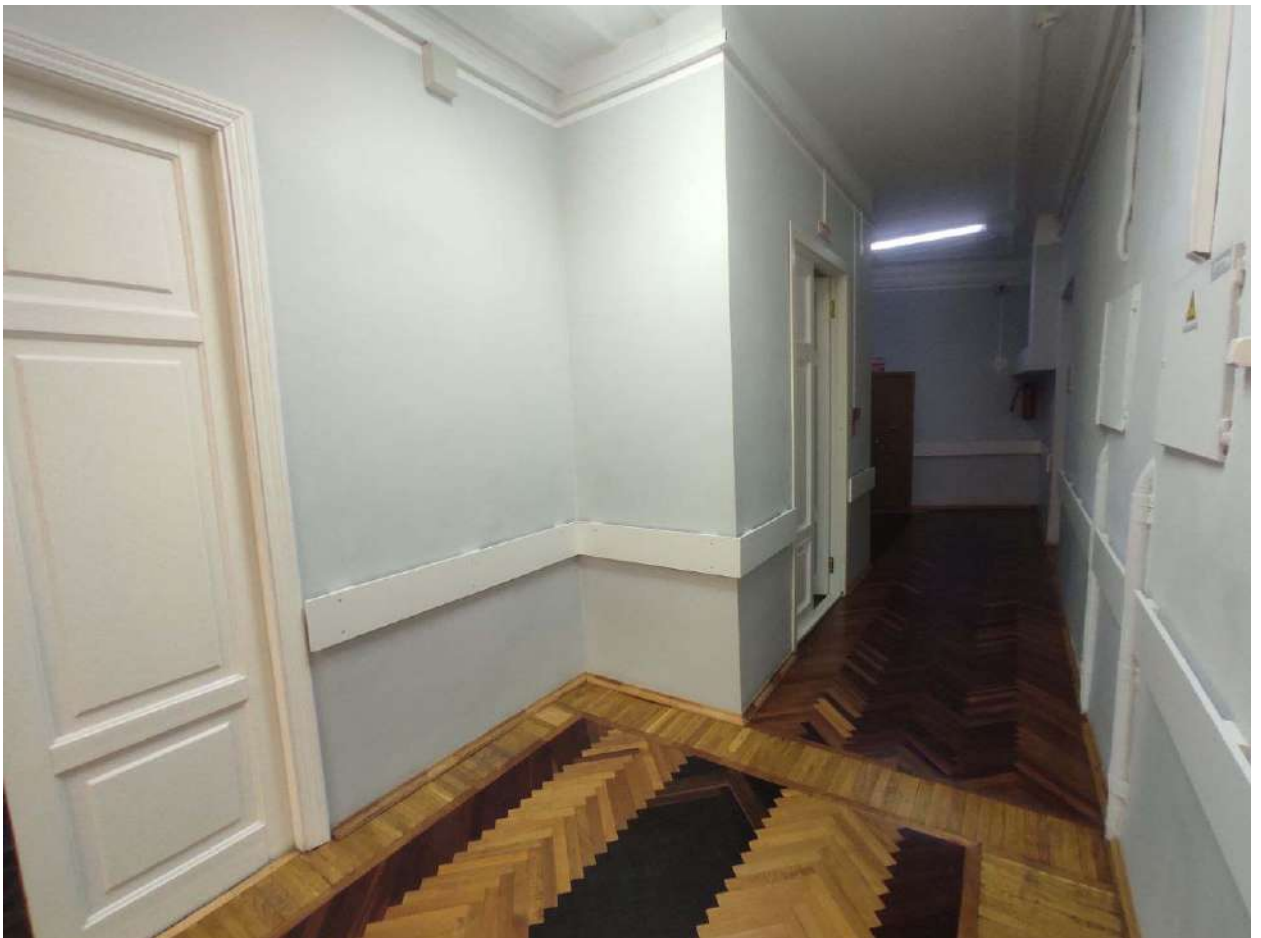
Фото 238. 4 этаж. Помещение №200-102.4. Коридор.
