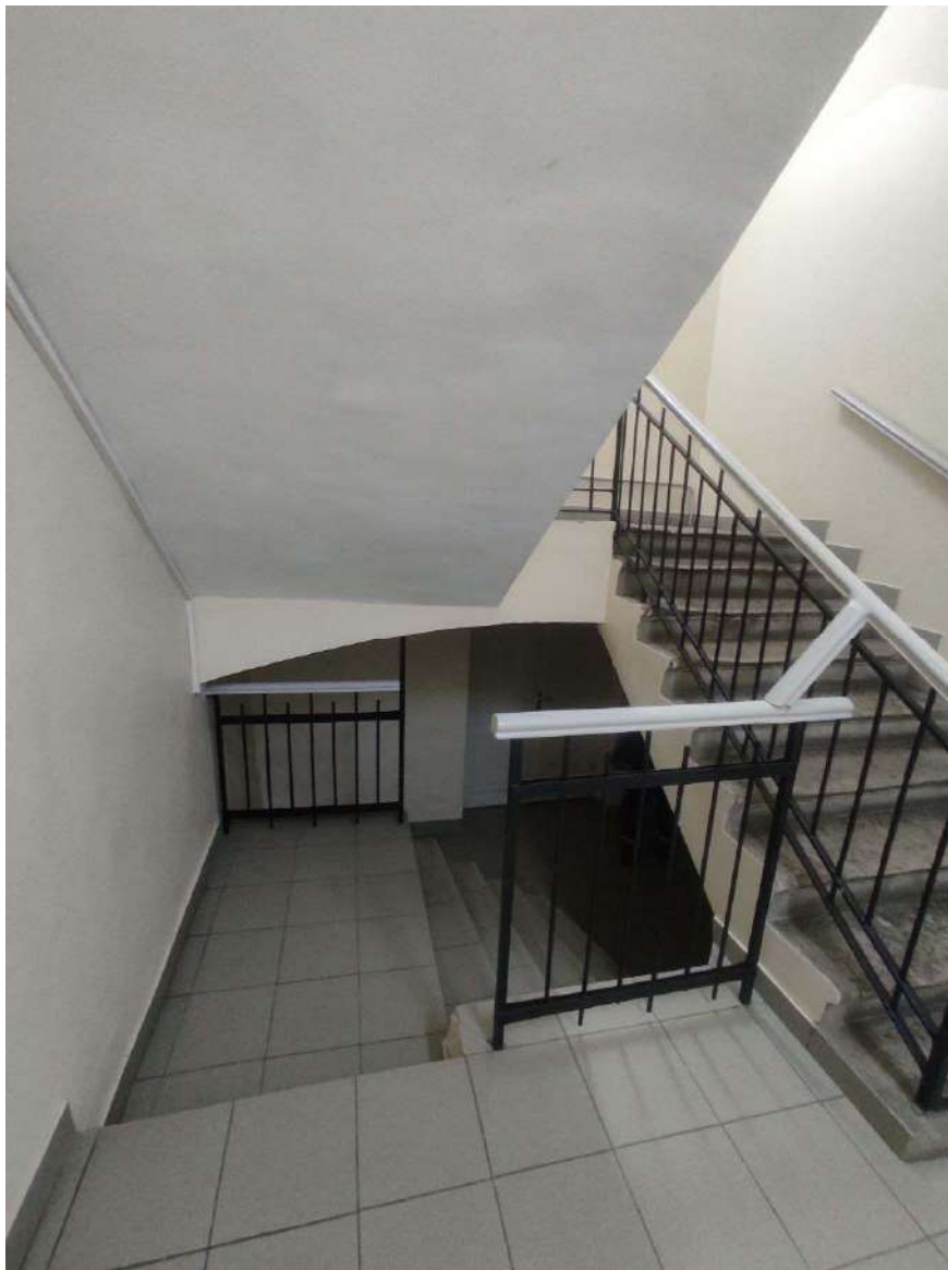
Фото 61. Цокольный – 1 этаж. Помещение №205
