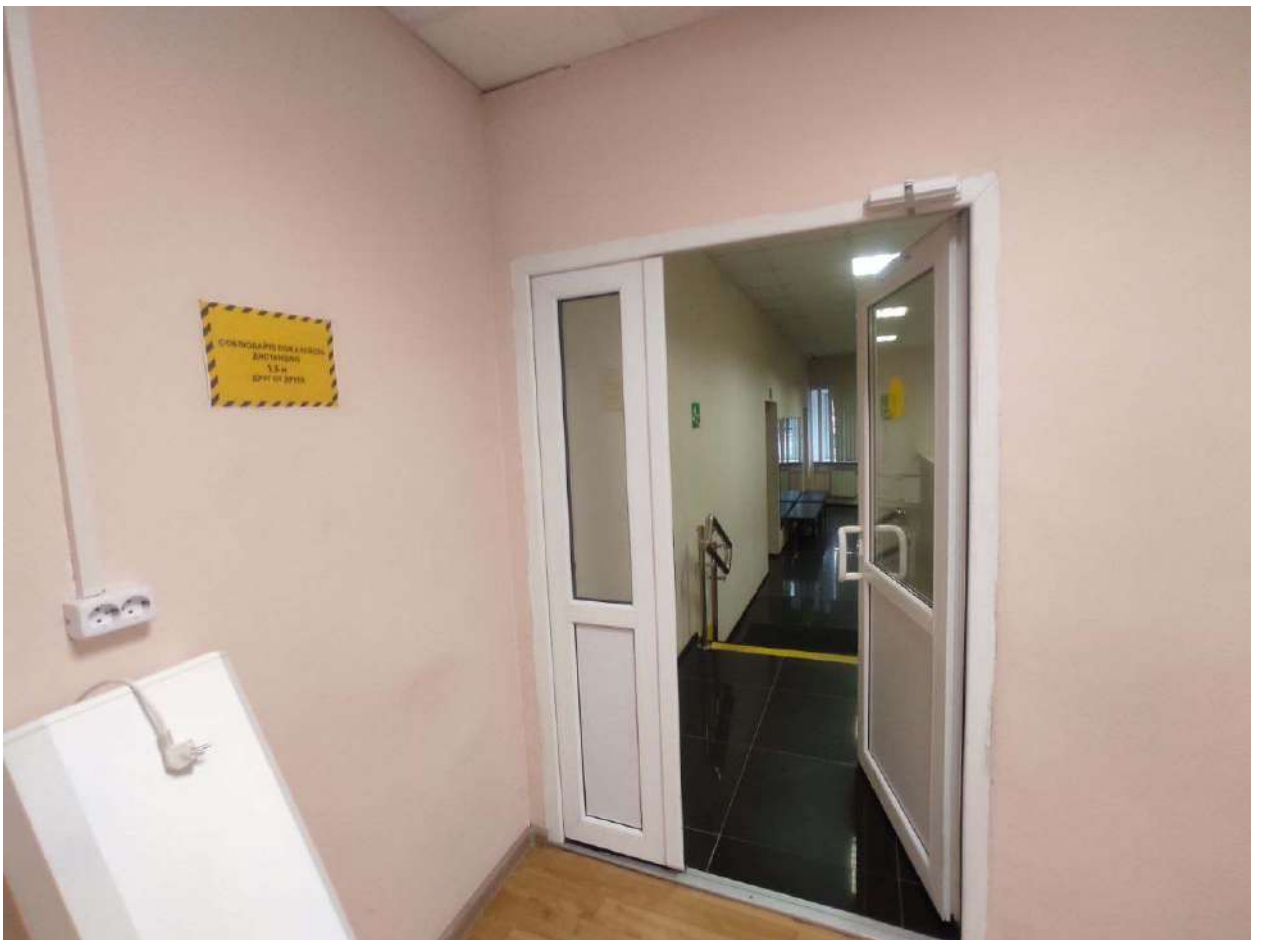
Фото 364. Цокольный – 1 этаж. Помещение №6.10
