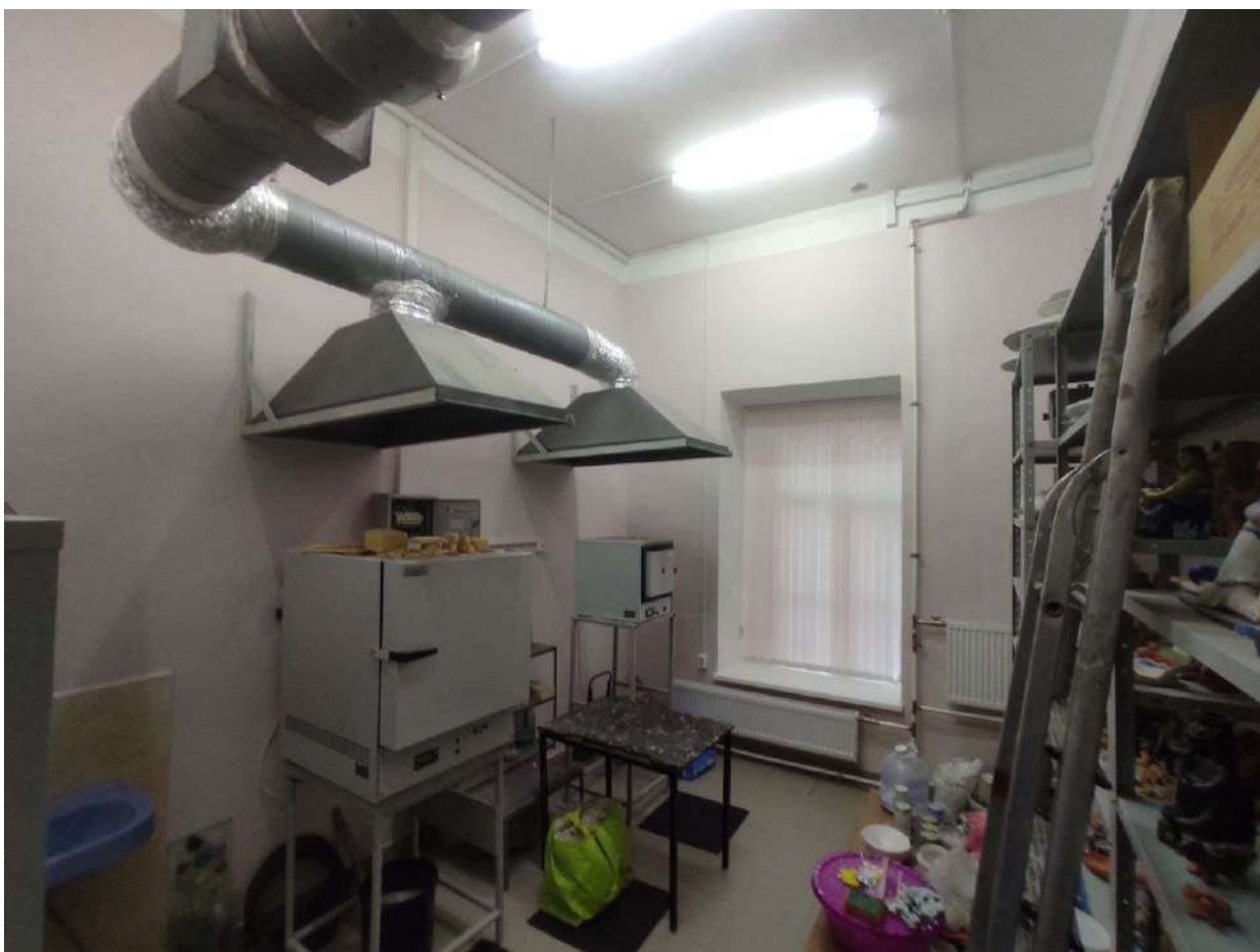
Фото 309. Цокольный – 1 этаж. Помещение №1-18.2
