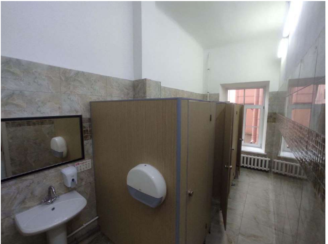
Фото 305. Цокольный – 1 этаж. Помещение №69
