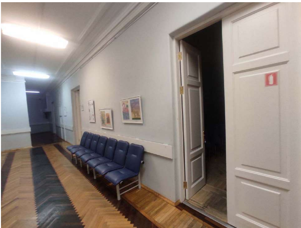
Фото 230. 4 этаж. Помещение №200-102.4. Коридор.
