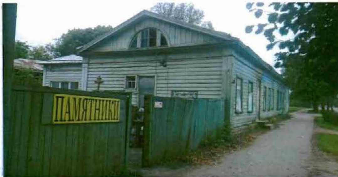
2. Фрагмент северного и западного фасадов здания (ул. Лермонтова, д. 30, лит. А).
