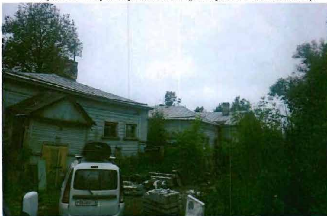
1. Фрагмент северного фасада здания (ул. Лермонтова, д. 30, лит. А).
