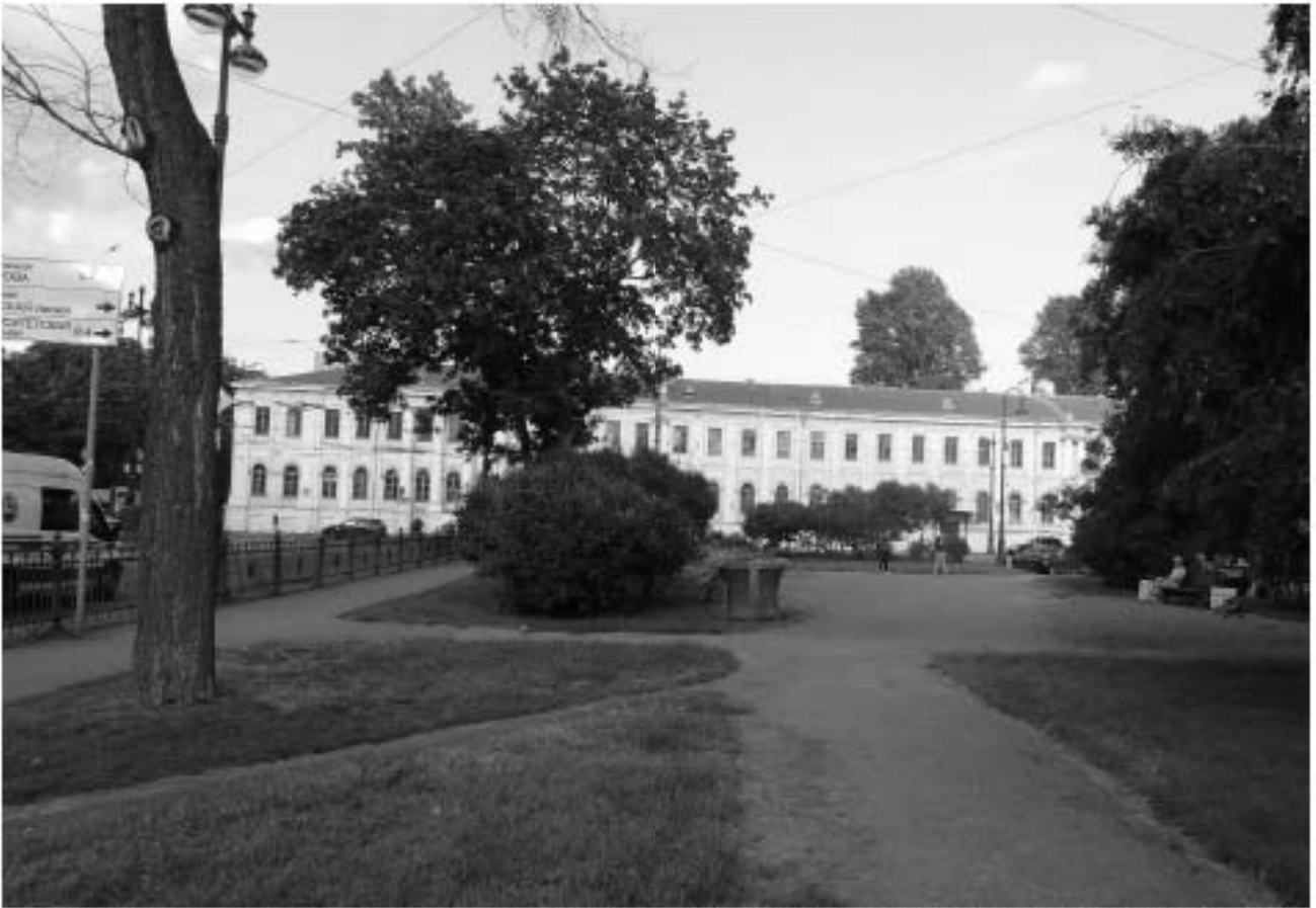
Фото 3. Система транзитных и щебёночно-набивных дорожек. Зона рекреации с щебёночно-набивным покрытием. Большой проспект В.О., напротив дома № 2. Левая сторона. Дата фотофиксации: 18.08.23
