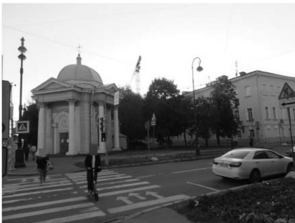
Фото 90. Вид лицевую часть фасада Спиридоньевской часовни со стороны пересечения 18-ой и 19-ой линий В.О. и Большого проспекта В.О. Правая сторона. Дата фотофиксации: 18.08.23
