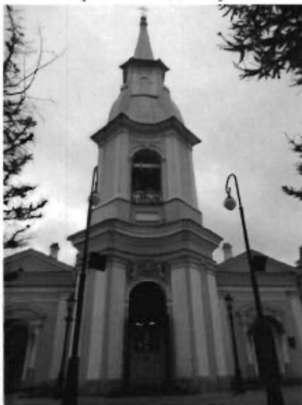
1. Фрагмент западного фасада
