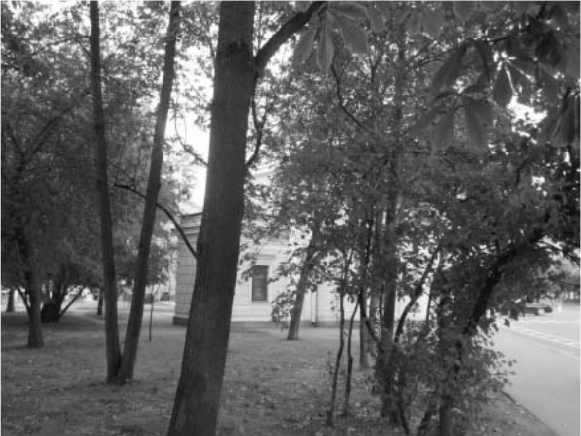
Фото 99. Фрагмент фасада Спиридоньевской часовни. Вид со стороны транзитной дорожки напротив дома 65 по Большому проспекту В.О. Правая сторона. Дата фотофиксации: 18.08.23
