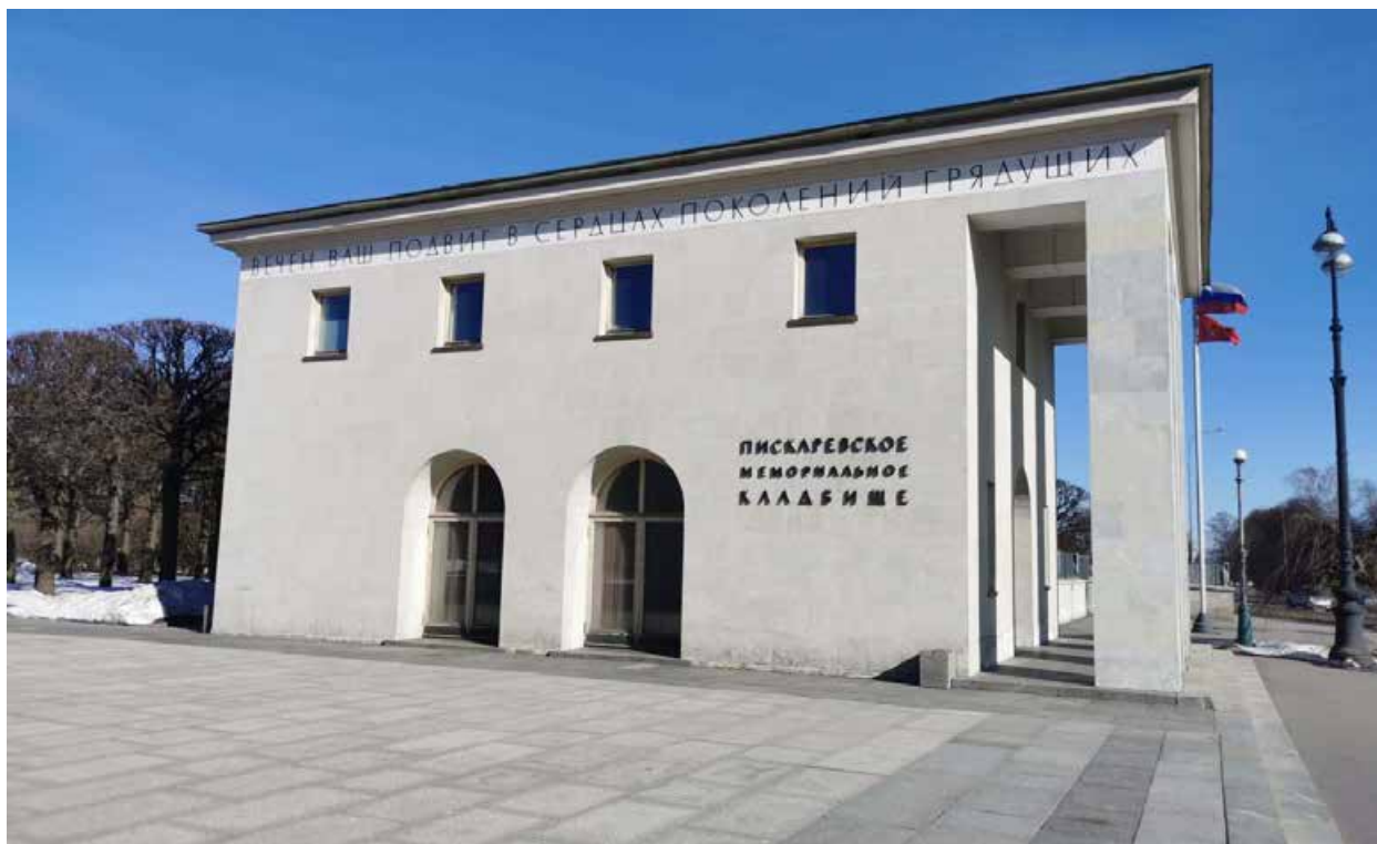
1. Объект культурного наследия федерального значения «Кладбище Пискаревское», расположенный по адресу: Санкт-Петербург, проспект Непокорённых, дом 72. Боковой фасад правого здания павильонов-пропилеев в южной (входной) части мемориала. Вид с запада. Дата съёмки: 05.04.2023.
