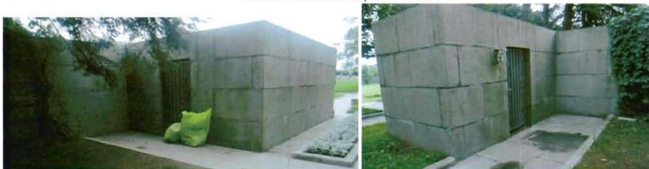
Задняя часть боковых стен главного мемориала. Вид с северо-востока. Съёмка 20.08.2012, К.С. Евтеев.
