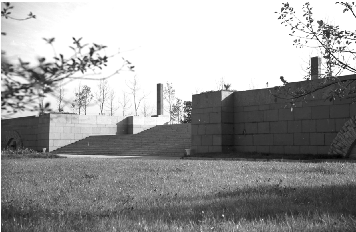
29. Главная лестница. Стенки с фонтанами «слезницы». 1960г. // Архив ОАО «ЛенНИИПроект».
