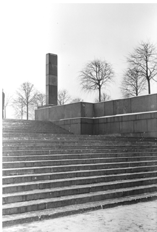
51. Подпорная стенка главной лестницы, завершающаяся обелиском. 1968г. // Архив ОАО «ЛенНИИПроект».
