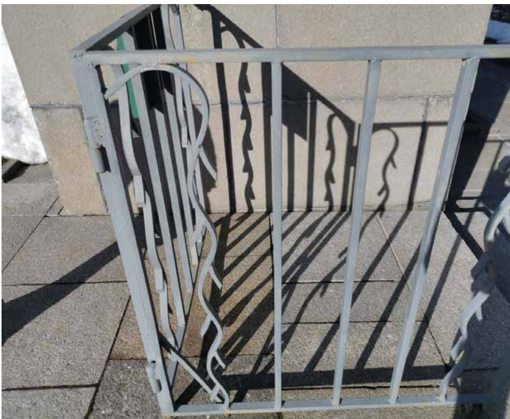
9. Объект культурного наследия федерального значения «Кладбище Пискаревское», расположенный по адресу: Санкт-Петербург, проспект Непокорённых, дом 72. Фрагмент ограды боковой стены с запада. Дата съёмки: 05.04.2023.
