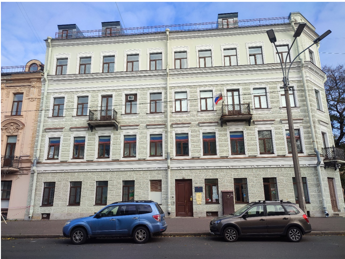
4. Объект культурного наследия регионального значения «Жилой дом», расположенный по адресу: Санкт-Петербург, город Кронштадт, улица Аммермана, дом 13, литера А. Общий вид южного лицевого фасада.
