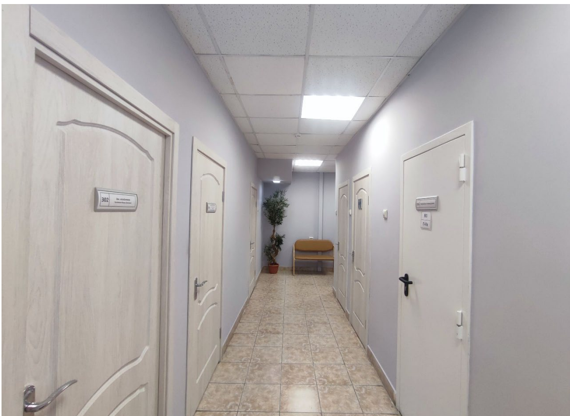
28. Объект культурного наследия регионального значения «Жилой дом», расположенный по адресу: Санкт-Петербург, город Кронштадт, улица Аммермана, дом 13, литера А. Общий вид пом. 1-С (75) в уровне 3-го этажа.
