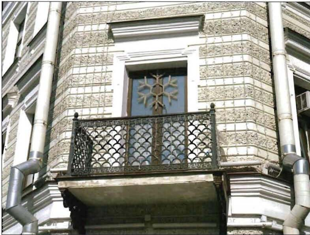
3. Балкон со стороны лицевого юго-восточного фасада.
