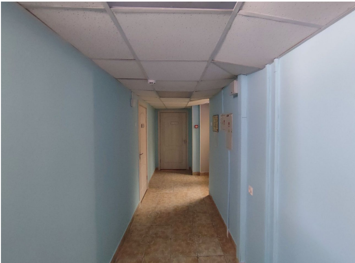
38. Объект культурного наследия регионального значения «Жилой дом», расположенный по адресу: Санкт-Петербург, город Кронштадт, улица Аммермана, дом 13, литера А. Общий вид пом. 1-С (134) в уровне 5-го этажа.
