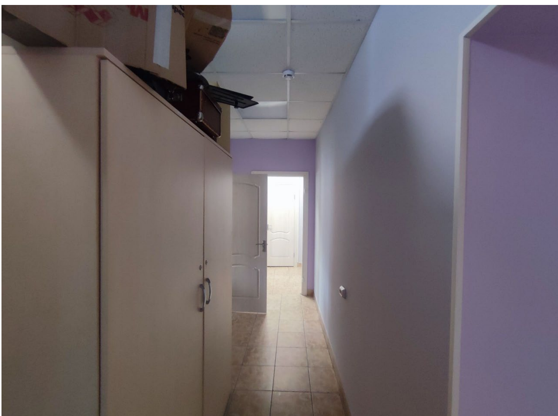
25. Объект культурного наследия регионального значения «Жилой дом», расположенный по адресу: Санкт-Петербург, город Кронштадт, улица Аммермана, дом 13, литера А. Общий вид пом. 1-С (83) в уровне 3-го этажа.
