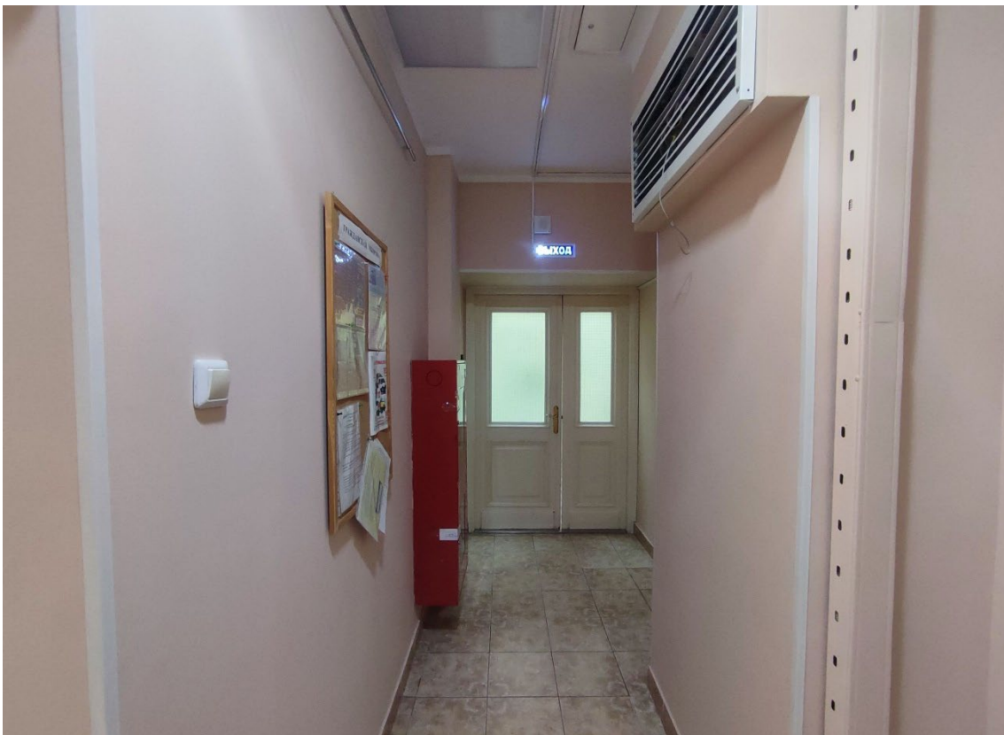
13. Объект культурного наследия регионального значения «Жилой дом», расположенный по адресу: Санкт-Петербург, город Кронштадт, улица Аммермана, дом 13, литера А. Общий вид пом. 1-С (27) в уровне 1-го этажа.
