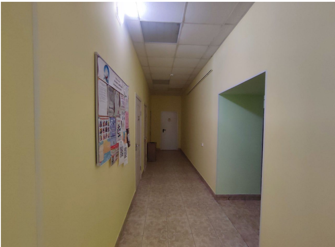
19. Объект культурного наследия регионального значения «Жилой дом», расположенный по адресу: Санкт-Петербург, город Кронштадт, улица Аммермана, дом 13, литера А. Общий вид пом. 1-С (50) в уровне 2-го этажа.
