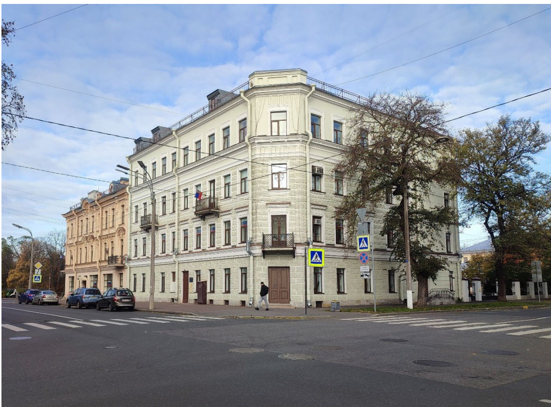
1. Объект культурного наследия регионального значения «Жилой дом», расположенный по адресу: Санкт-Петербург, город Кронштадт, улица Аммермана, дом 13, литера А. Общий вид с пересечения улицы Аммермана и Интернациональной улицы.
