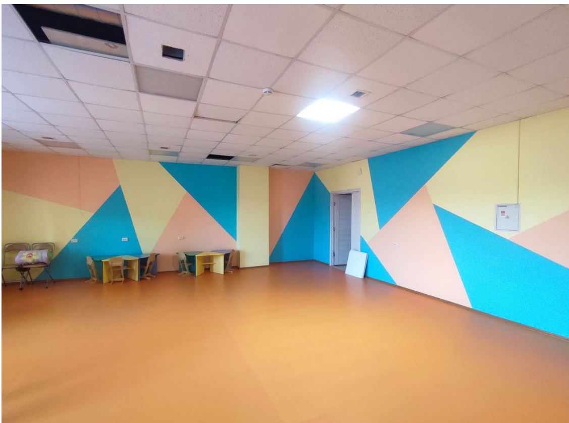
24. Объект культурного наследия регионального значения «Жилой дом», расположенный по адресу: Санкт-Петербург, город Кронштадт, улица Аммермана, дом 13, литера А. Общий вид пом. 1-С (84) в уровне 3-го этажа.
