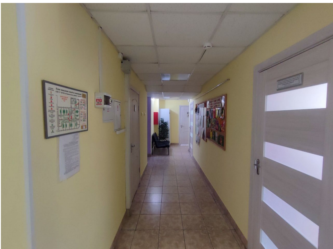
31. Объект культурного наследия регионального значения «Жилой дом», расположенный по адресу: Санкт-Петербург, город Кронштадт, улица Аммермана, дом 13, литера А. Фрагмент пом. 1-С (104) в уровне 4-го этажа.
