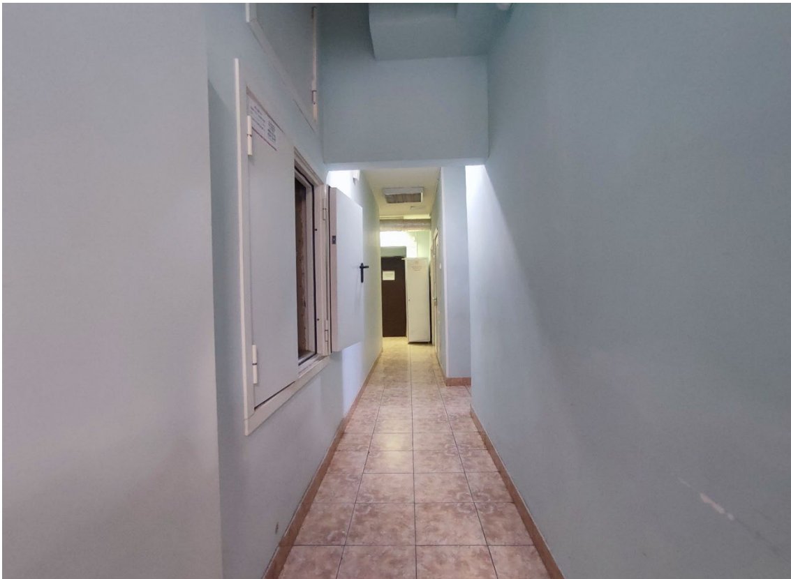
12. Объект культурного наследия регионального значения «Жилой дом», расположенный по адресу: Санкт-Петербург, город Кронштадт, улица Аммермана, дом 13, литера А. Общий вид пом. 1-С (18) в уровне 1-го этажа.
