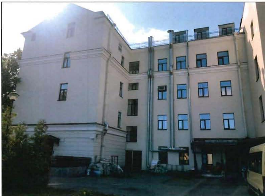
4. Вид на дворовый фасад с северо-западной стороны.
