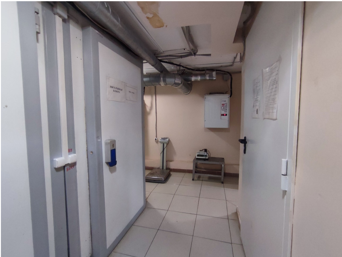
9. Объект культурного наследия регионального значения «Жилой дом», расположенный по адресу: Санкт-Петербург, город Кронштадт, улица Аммермана, дом 13, литера А. Фрагмент пом. 1-С (145) в уровне подвала.
