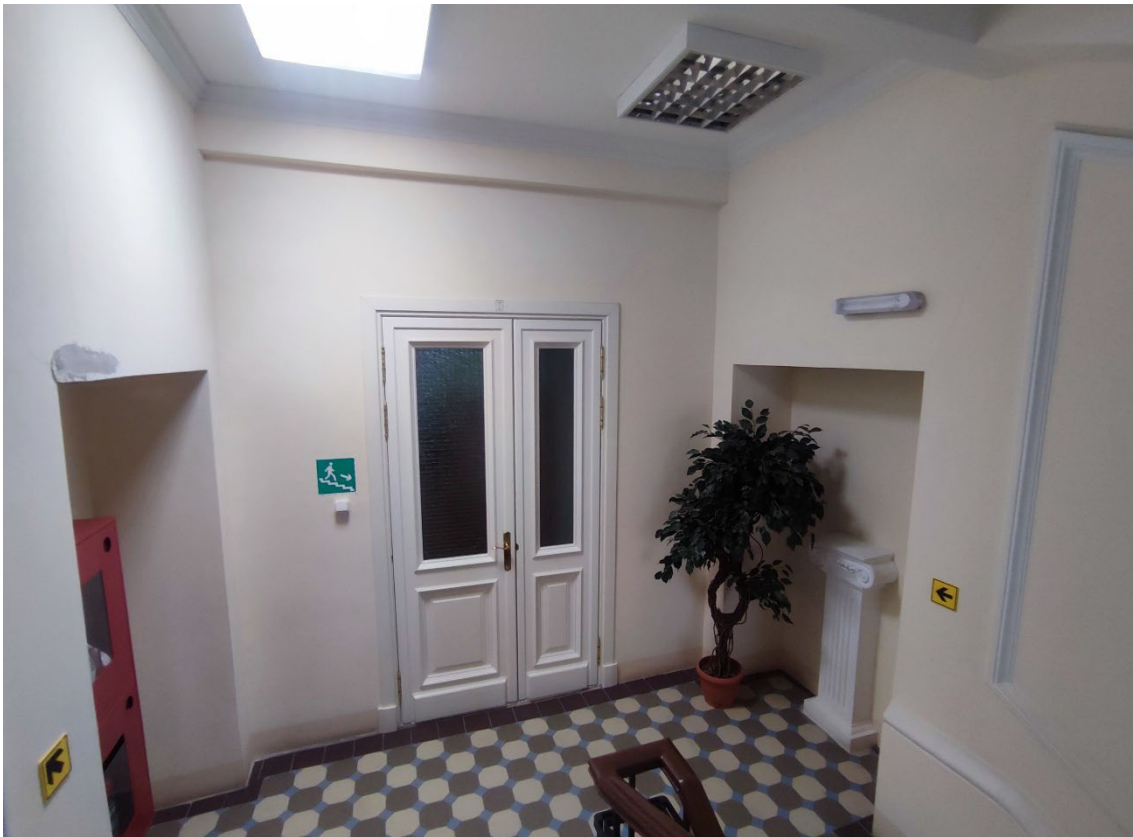
22. Объект культурного наследия регионального значения «Жилой дом», расположенный по адресу: Санкт-Петербург, город Кронштадт, улица Аммермана, дом 13, литера А. Общий вид площадки центральной лестницы (пом. 1-С (85)) в уровне 3-го этажа.
