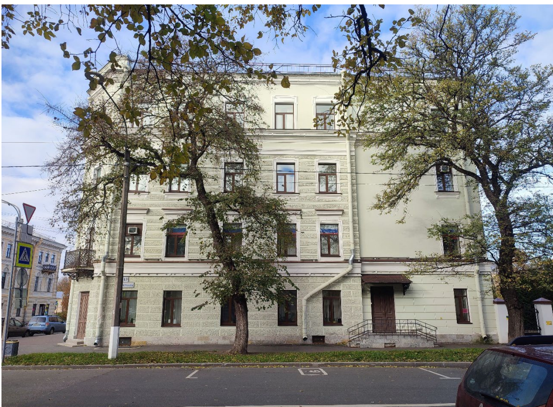
2. Объект культурного наследия регионального значения «Жилой дом», расположенный по адресу: Санкт-Петербург, город Кронштадт, улица Аммермана, дом 13, литера А. Общий вид восточного лицевого фасада.
