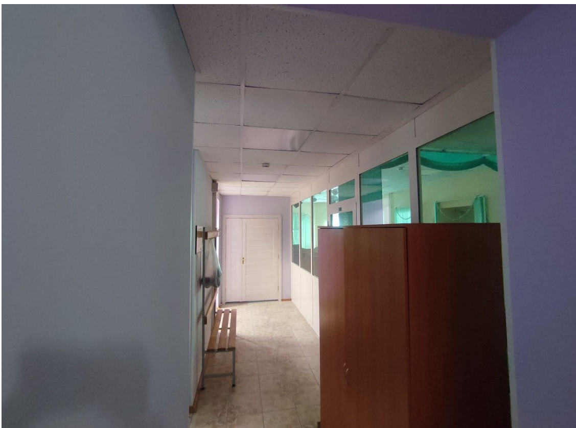
26. Объект культурного наследия регионального значения «Жилой дом», расположенный по адресу: Санкт-Петербург, город Кронштадт, улица Аммермана, дом 13, литера А. Общий вид пом. 1-С (76) в уровне 3-го этажа.
