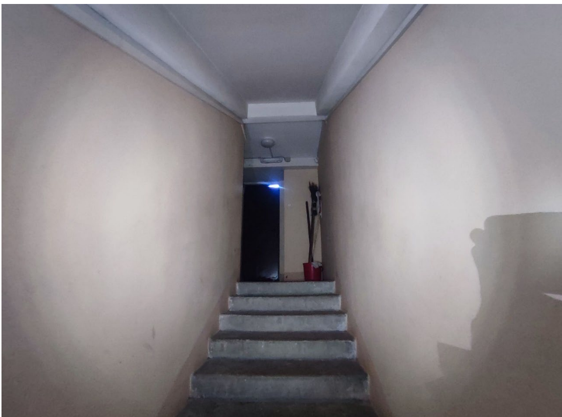
7. Объект культурного наследия регионального значения «Жилой дом», расположенный по адресу: Санкт-Петербург, город Кронштадт, улица Аммермана, дом 13, литера А. Общий вид одномаршевой лестницы в объеме пом. 1-С (151) в уровне подвала.
