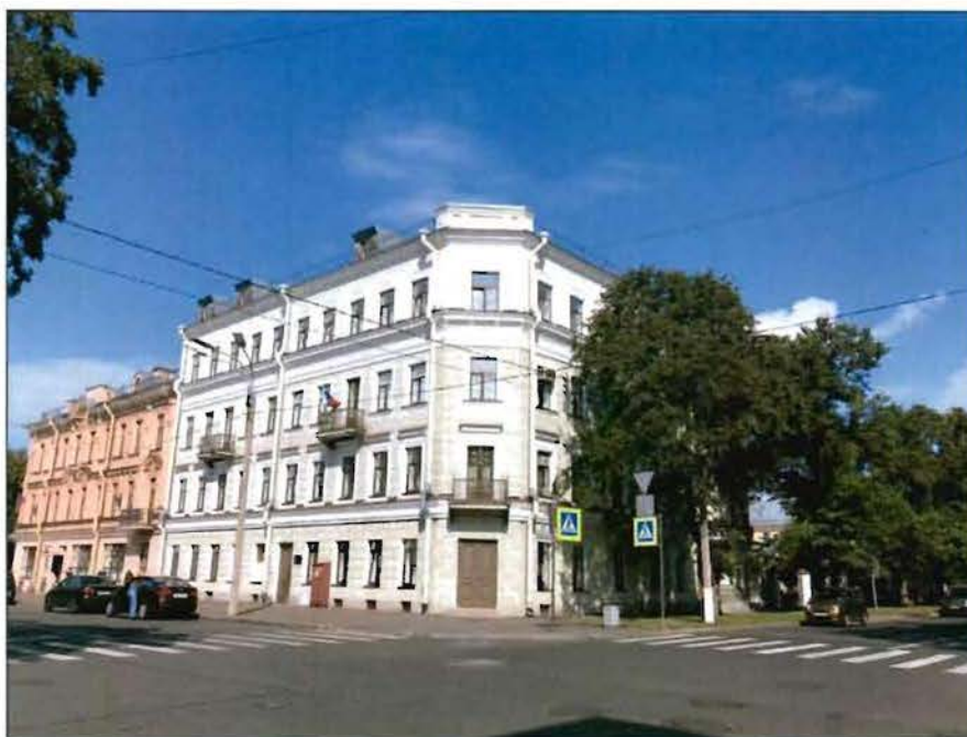
1. Общий вид на южный и юго-восточный лицевые фасады.
