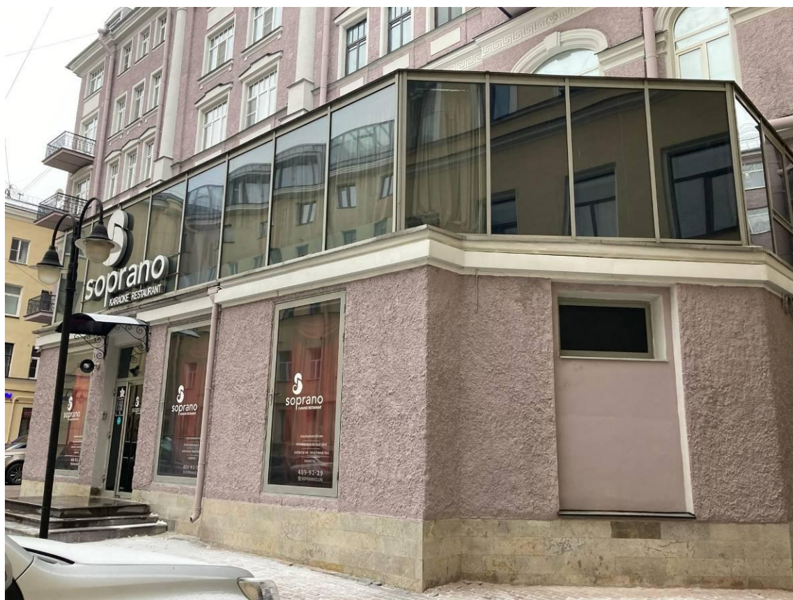
Фото 19. Фрагмент дворового фасада выявленного объекта культурного наследия «Дом О.П. Кушелевой»
