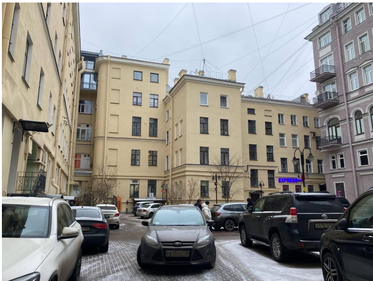
Фото 5. Фрагмент дворового фасада выявленного объекта культурного наследия «Дом О.П. Кушелевой»
