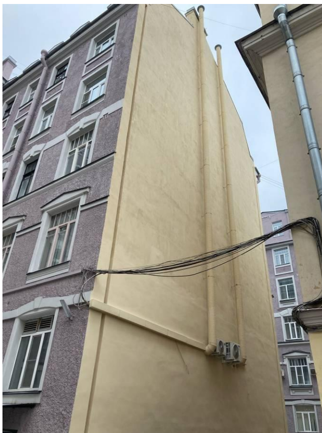
Фото 15. Фрагмент дворового фасада выявленного объекта культурного наследия «Дом О.П. Кушелевой»
