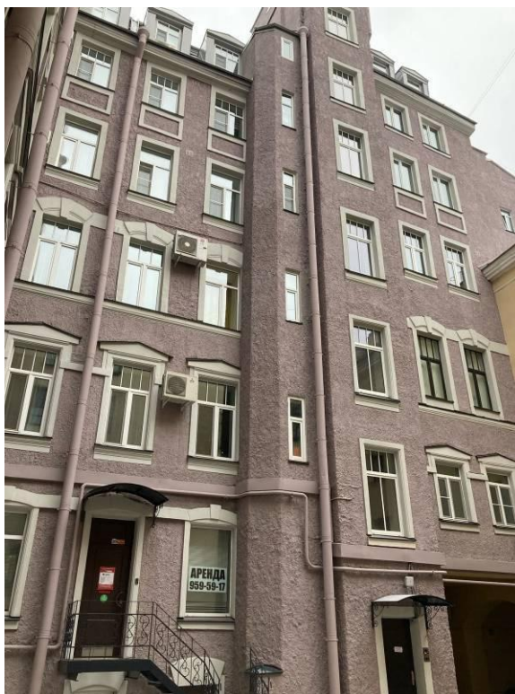
Фото 13. Фрагмент дворового фасада выявленного объекта культурного наследия «Дом О.П. Кушелевой»
