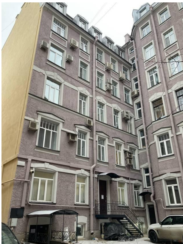
Фото 11. Фрагмент дворового фасада выявленного объекта культурного наследия «Дом О.П. Кушелевой»
