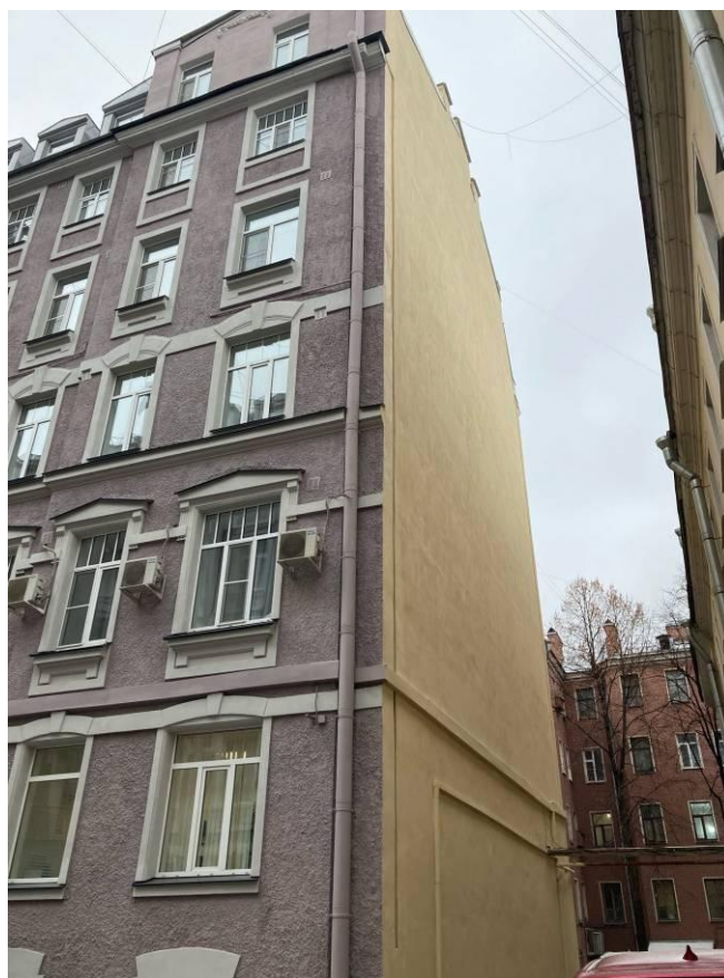
Фото 10. Фрагмент дворового фасада выявленного объекта культурного наследия «Дом О.П. Кушелевой»
