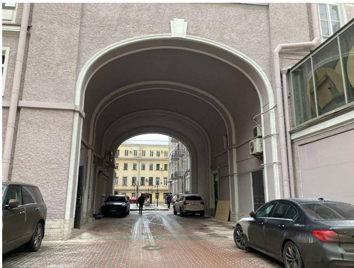
Фото 6. Фрагмент дворового фасада выявленного объекта культурного наследия «Дом О.П. Кушелевой»
