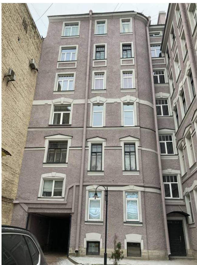
Фото 16. Фрагмент дворового фасада выявленного объекта культурного наследия «Дом О.П. Кушелевой»
