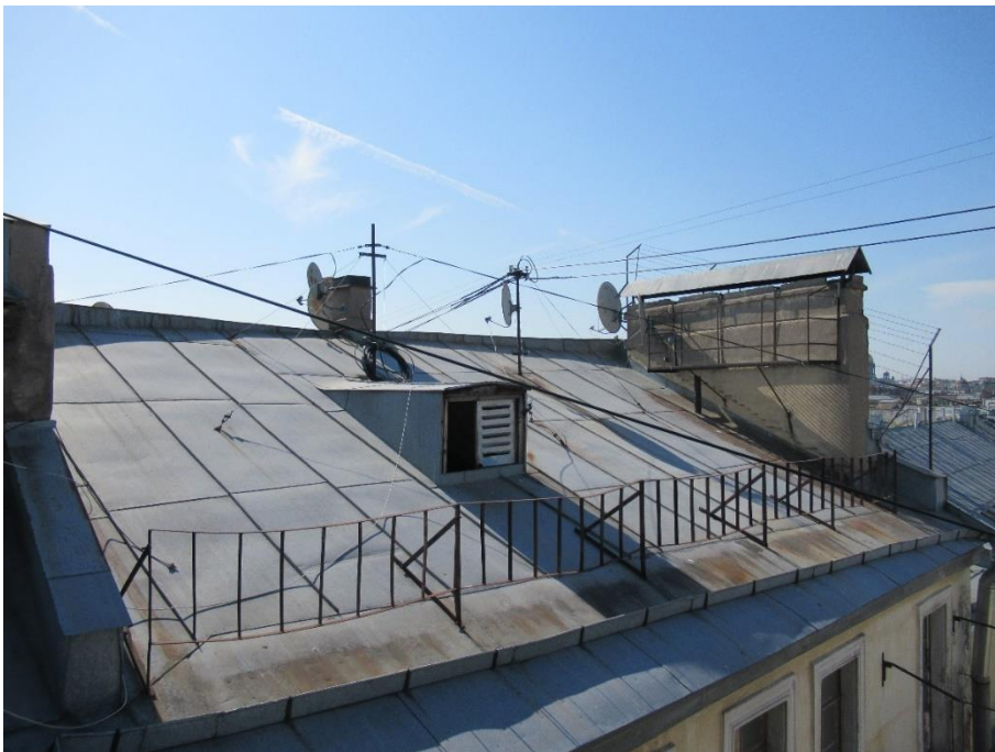
50. Объект культурного наследия регионального значения «Собственный дом архитектора Н.П. Басина», г. Санкт-Петербург, Крылова пер., 7/5, лит. А. Кровля. Фрагмент. Фото 28.08.2023г.
