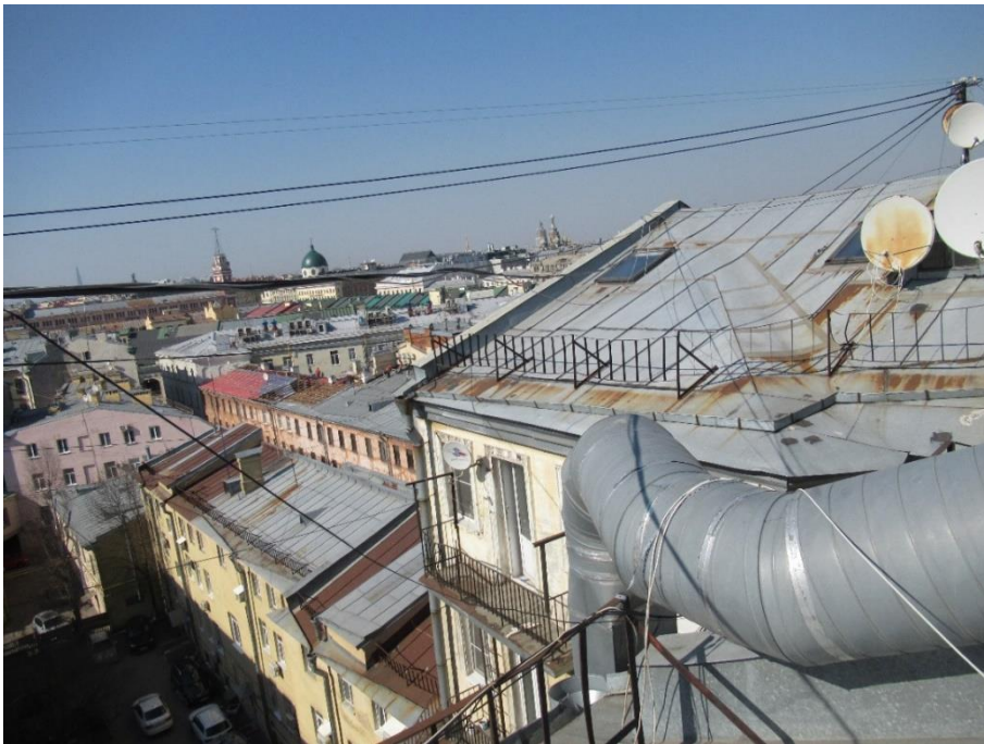
41. Объект культурного наследия регионального значения «Собственный дом архитектора Н.П. Басина», г. Санкт-Петербург, Крылова пер., 7/5, лит. А. Кровля. Общий вид. Фото 28.08.2023г.
