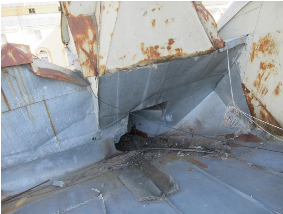
49. Объект культурного наследия регионального значения «Собственный дом архитектора Н.П. Басина», г. Санкт-Петербург, Крылова пер., 7/5, лит. А. Кровля. Фрагмент. Фото 28.08.2023г.
