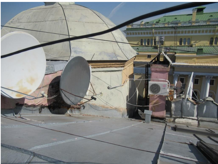
43. Объект культурного наследия регионального значения «Собственный дом архитектора Н.П. Басина», г. Санкт-Петербург, Крылова пер., 7/5, лит. А. Кровля. Фрагмент. Фото 28.08.2023г.
