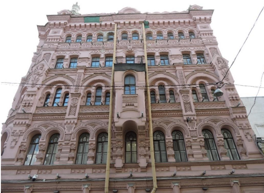
2. Объект культурного наследия регионального значения «Собственный дом архитектора Н.П. Басина», г. Санкт-Петербург, Крылова пер., 7/5, лит. А. Северный фасад. Общий вид. Фото 28.08.2023г.
