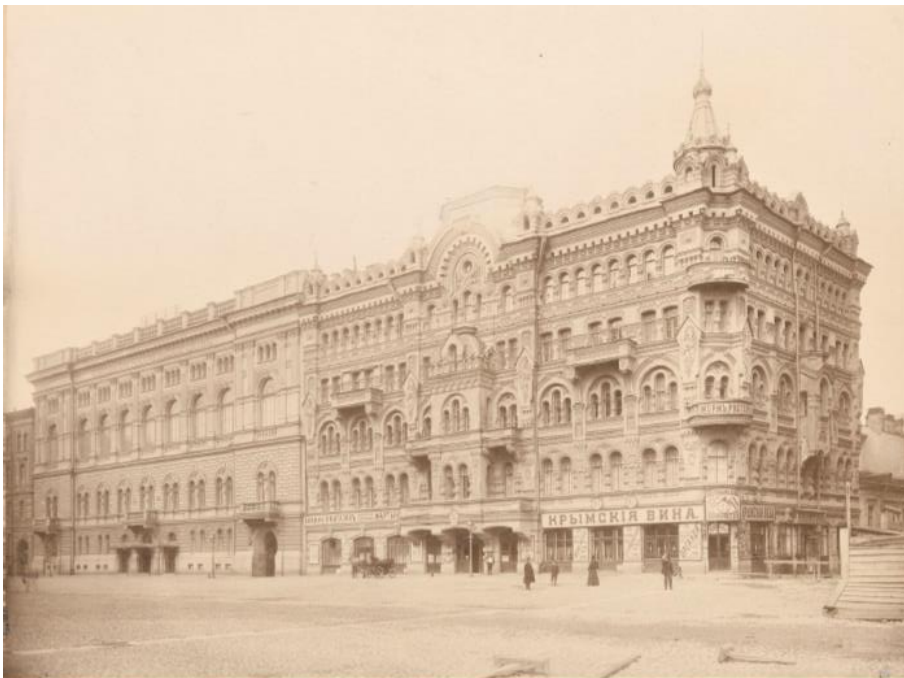
40. Общий вид дома Н.П. Басина. Фотография. 1880-е гг. ГМИ СПб (инв. № II-А-2416 ф).
