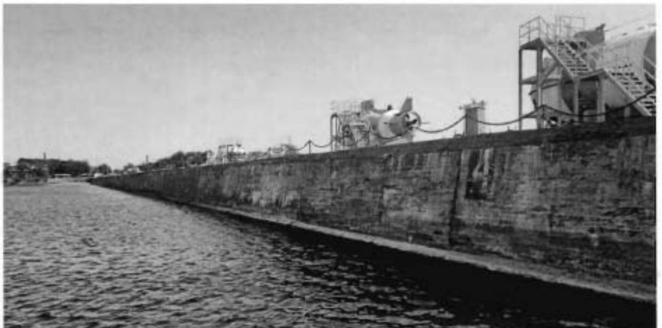
9. Вид на фрагмент внешней западной подпорной стены канала.
