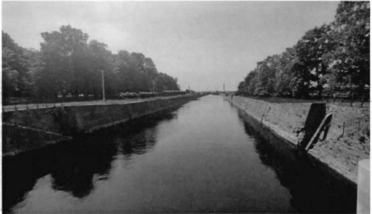
1. Общий вид на объект культурного наследия.
