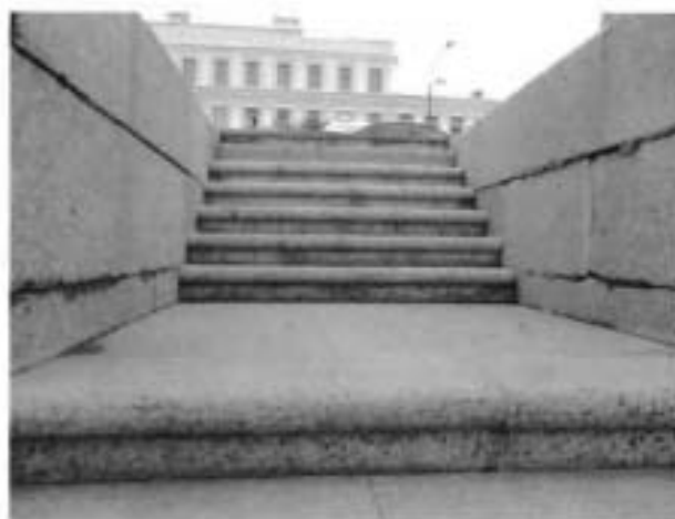
7. Лестницы (две). Вид снизу
