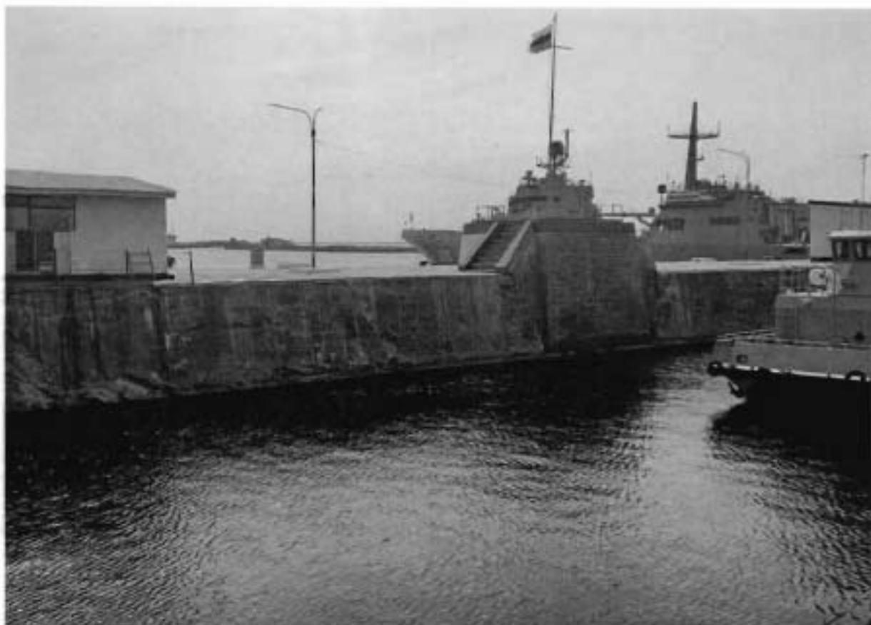
6. Вид на фрагмент внутренней восточной подпорной стены канала.
