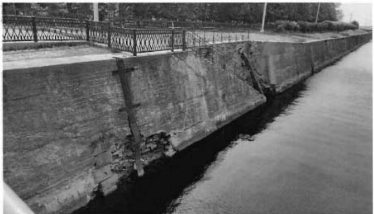
2. Фрагмент восточной подпорной стенки.
