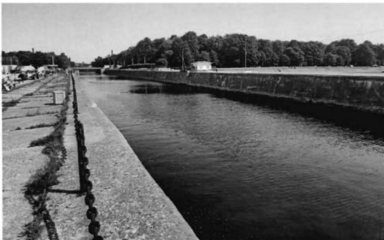
5. Вид на канал в сторону Докового моста.
