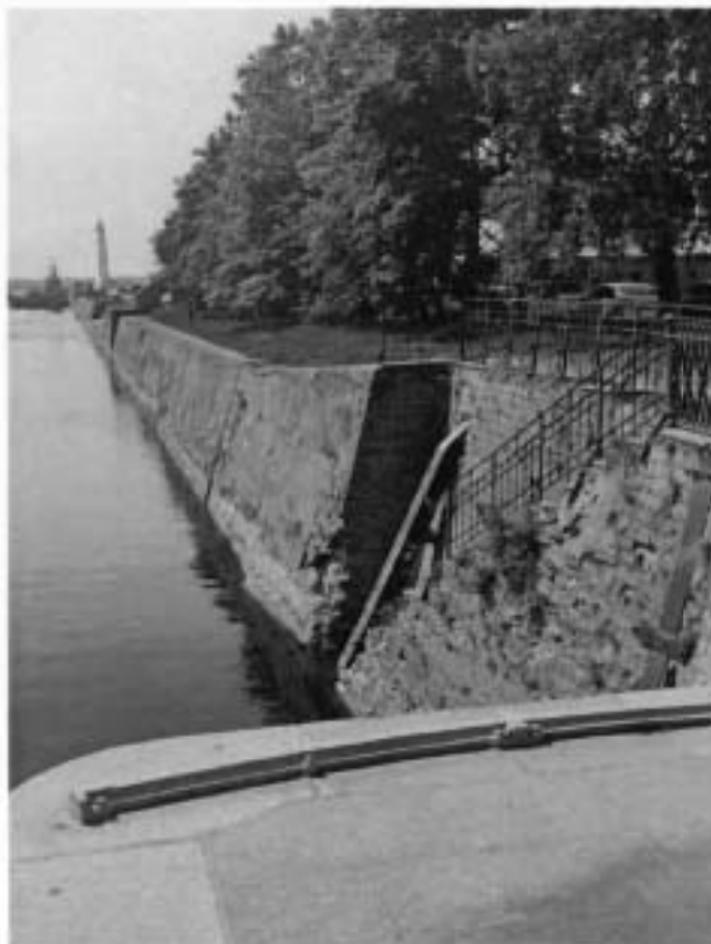
3. Фрагмент западной подпорной стенки.
