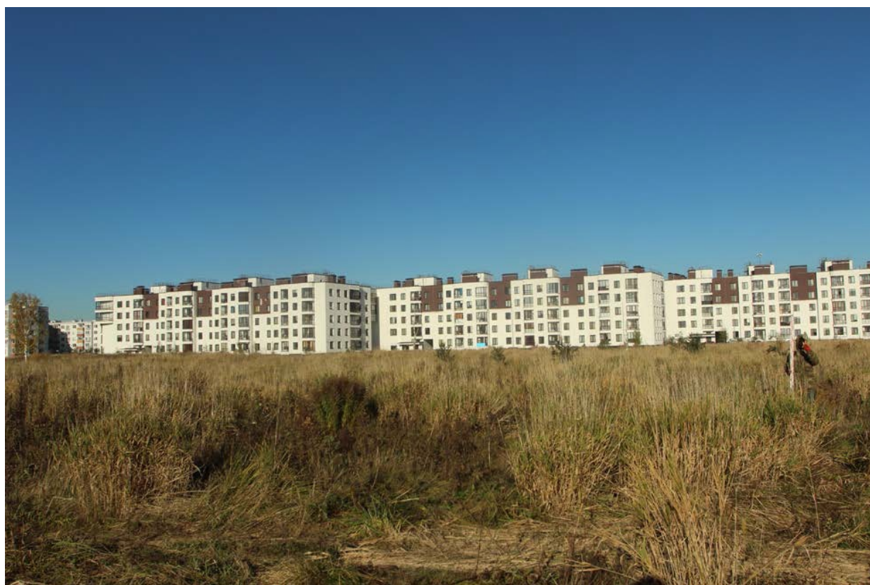
Рис. 20. СПб-2023. г. Петергоф, Ропшинское шоссе, участок 144. Точка фотофиксации 3, вид на северо-запад.
