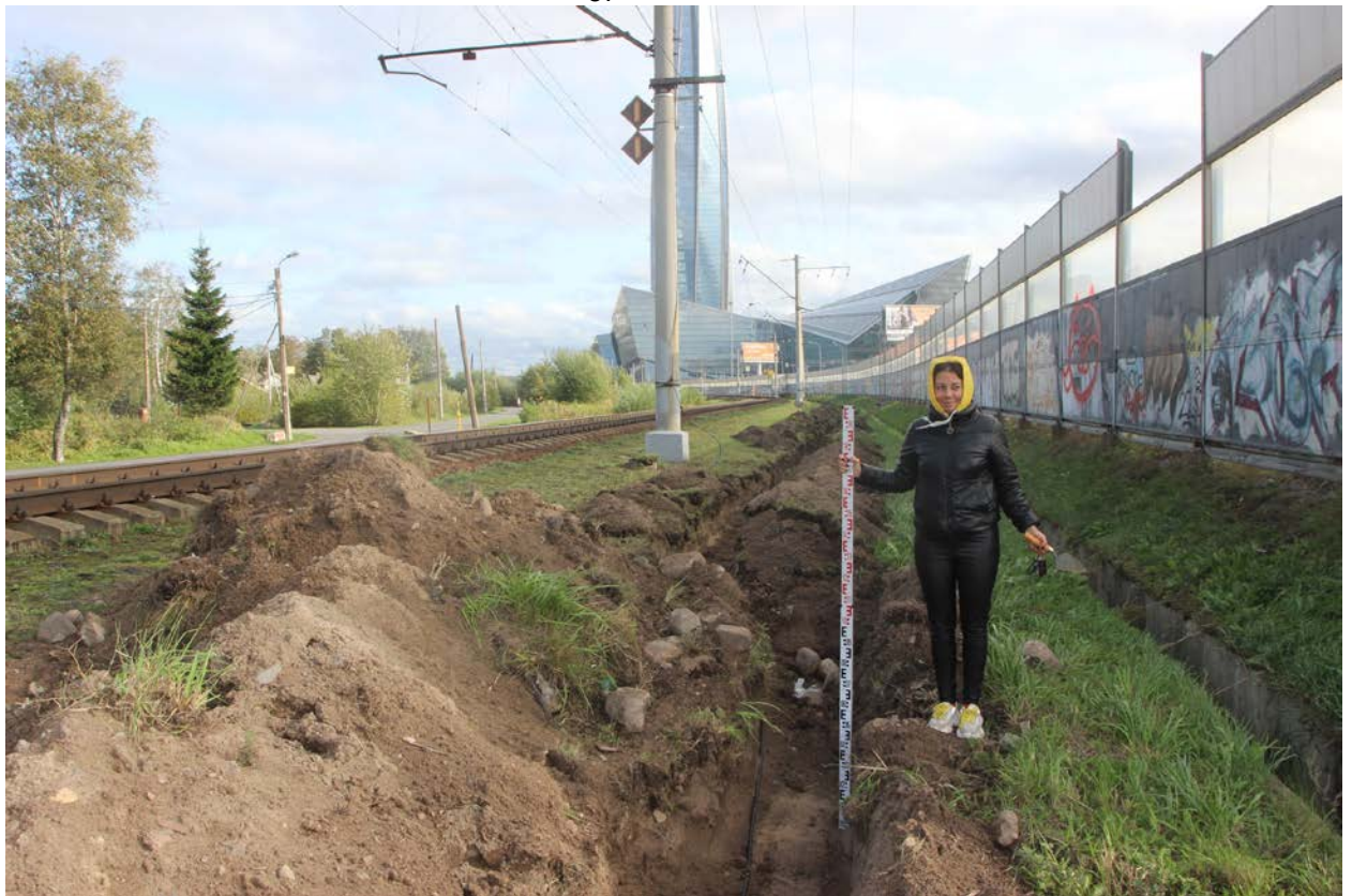
Рис. 25. Кл 330 кВ-Лахта-2023. Точка фотофиксации 5, вид на юг.
