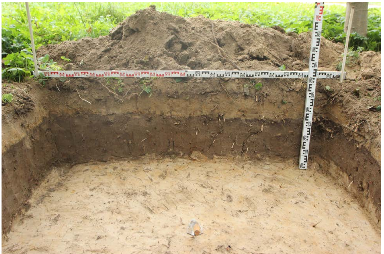
Рис. 54. Кл 330 кВ-Лахта-2023. Шурф 2, северная стенка.
