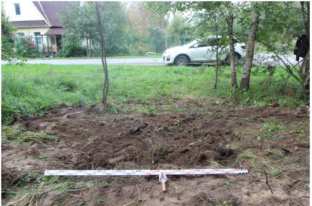
Рис. 48. Кл 330 кВ-Лахта-2023. Шурф 1 после рекультивации, вид на север.
