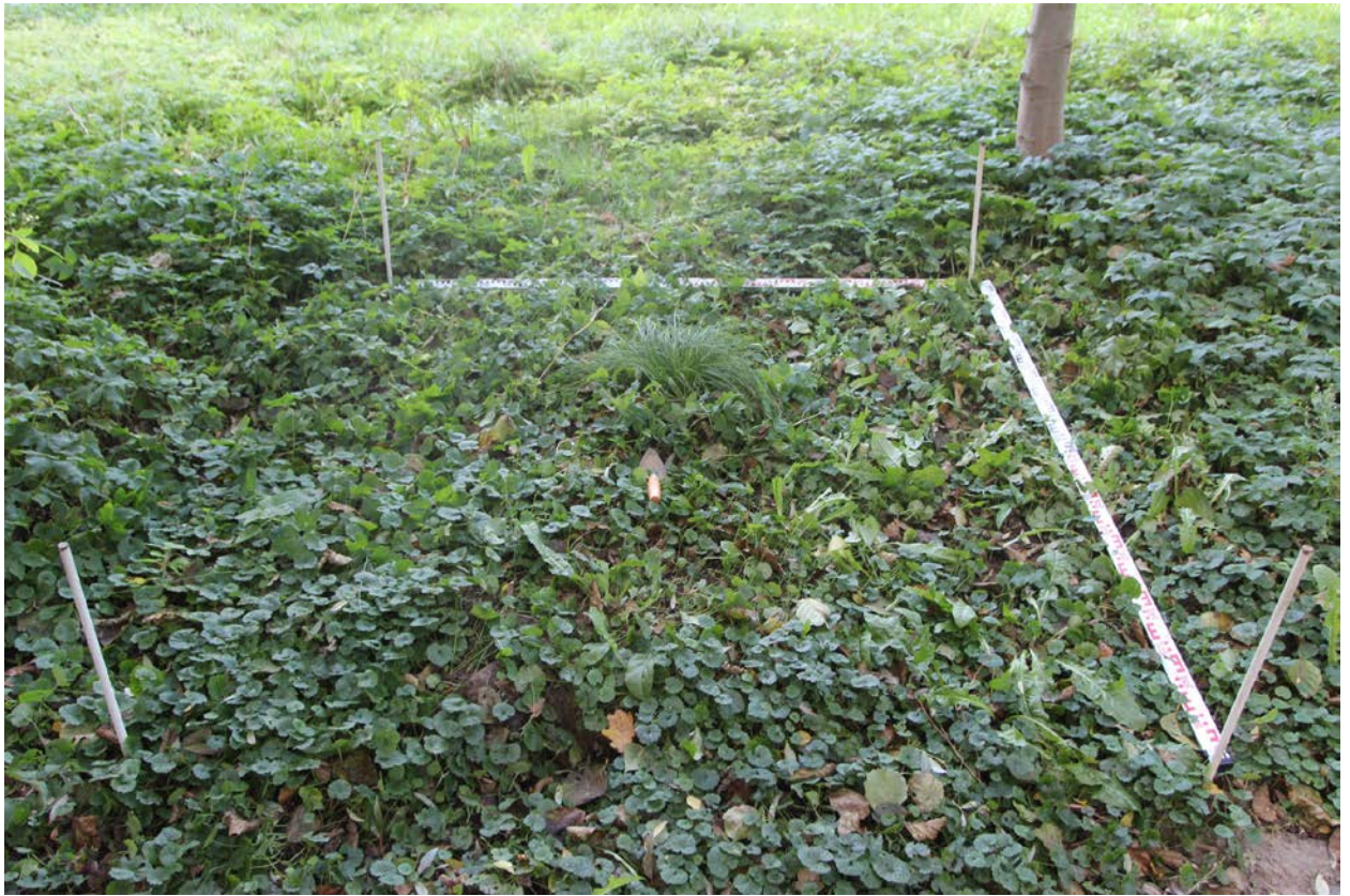
Рис. 51. Кл 330 кВ-Лахта-2023. Шурф 2, дневная поверхность, вид на север.
