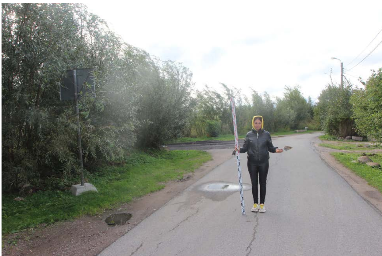
Рис. 18. Кл 330 кВ-Лахта-2023. Точка фотофиксации 3, вид на запад.
