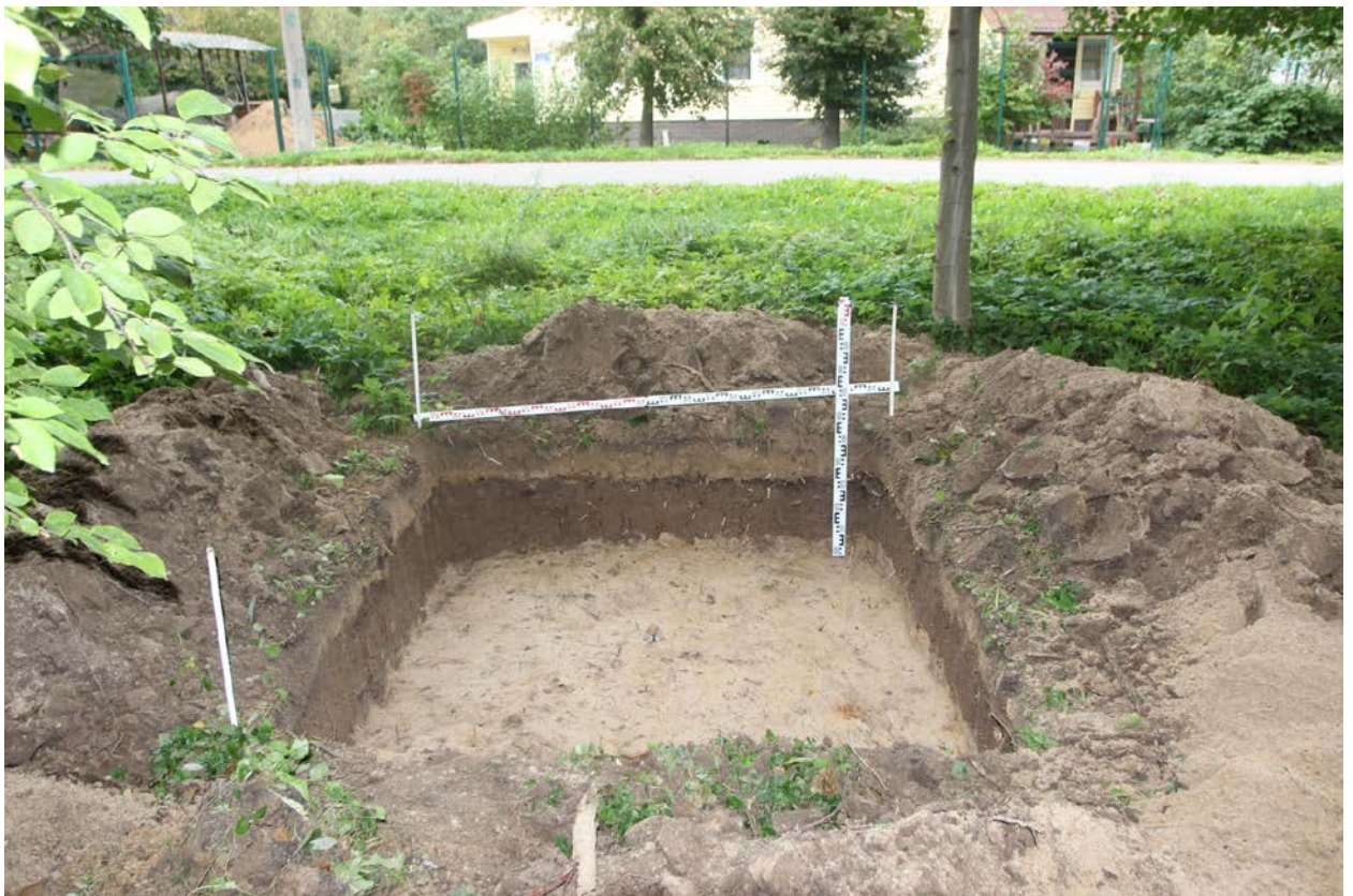
Рис. 52. Кл 330 кВ-Лахта-2023. Шурф 2, фиксация по уровню материковой поверхности, вид на север.
