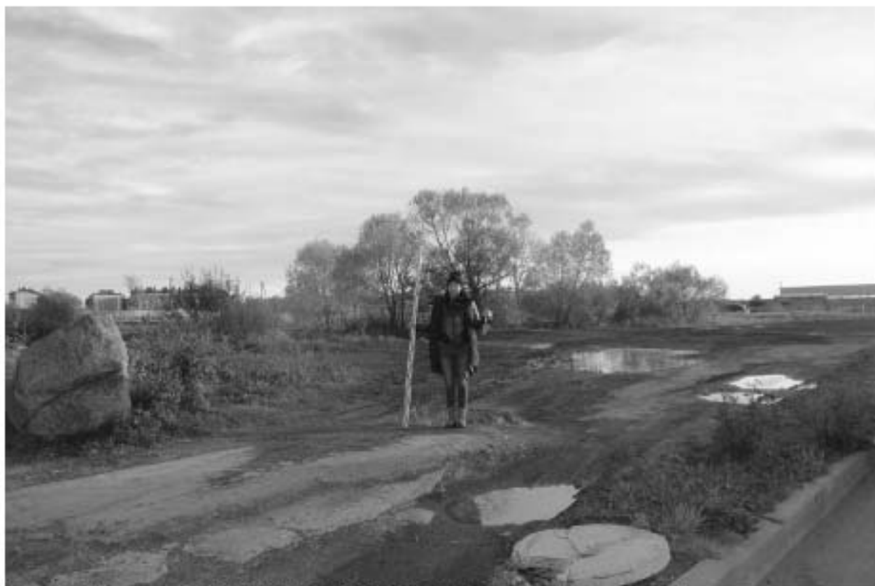
Рис. 23. Шушары-2023. КН: 78:42:1850206:611. Точка фотофиксации 4, вид на юго-восток.
