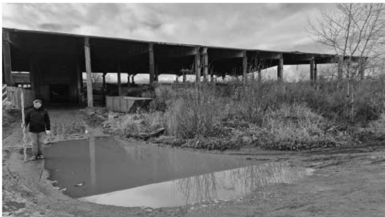
Рис.19. Санкт-Петербург, г. Пушкин, тер. Лесное. Точка съёмки №2. Вид на запад.
