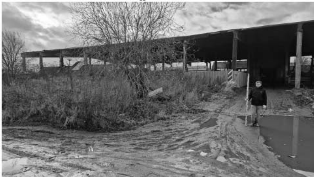
Рис.18. Санкт-Петербург, г. Пушкин, тер. Лесное. Точка съёмки №2. Вид на запад.
