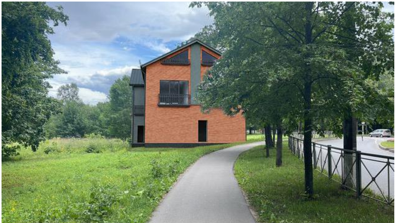
Илл. 4. Северный фасад.
