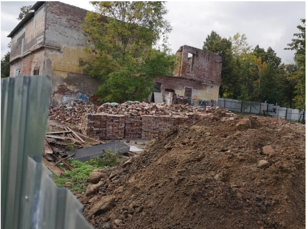
Фото 10. Территория проектирования. Участок №7 по адресу: Санкт-Петербург, Павловское шоссе, д.40 литера А. Вид с юго-востока.
