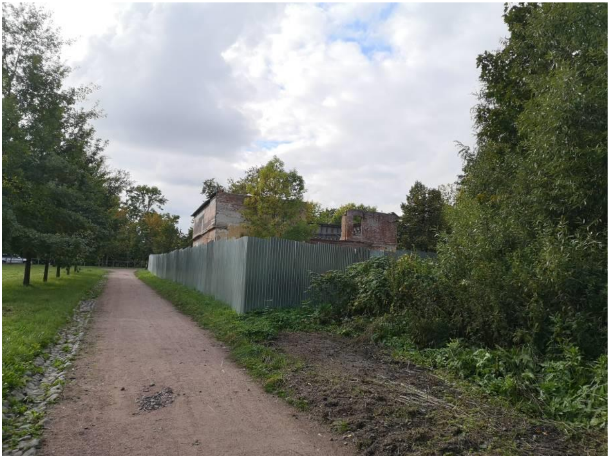
Фото 5. Вид на участок №7 по адресу: Санкт-Петербург, Павловское шоссе, д.40 литера А с северо-востока.
