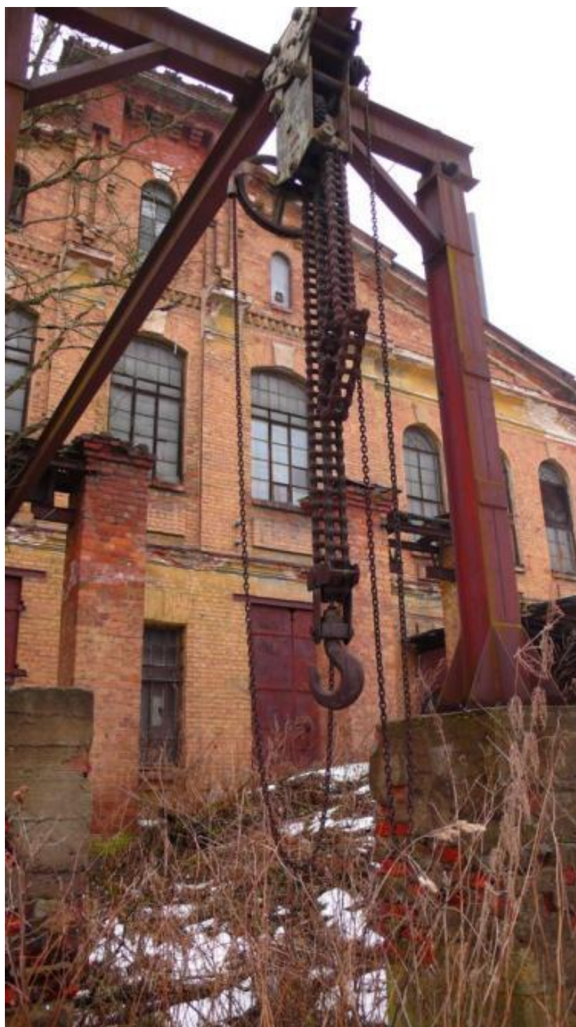
25. Здание пороховых погребов и лаборатории. 2008 г. https://www.citywalls.ru/house27512.html
