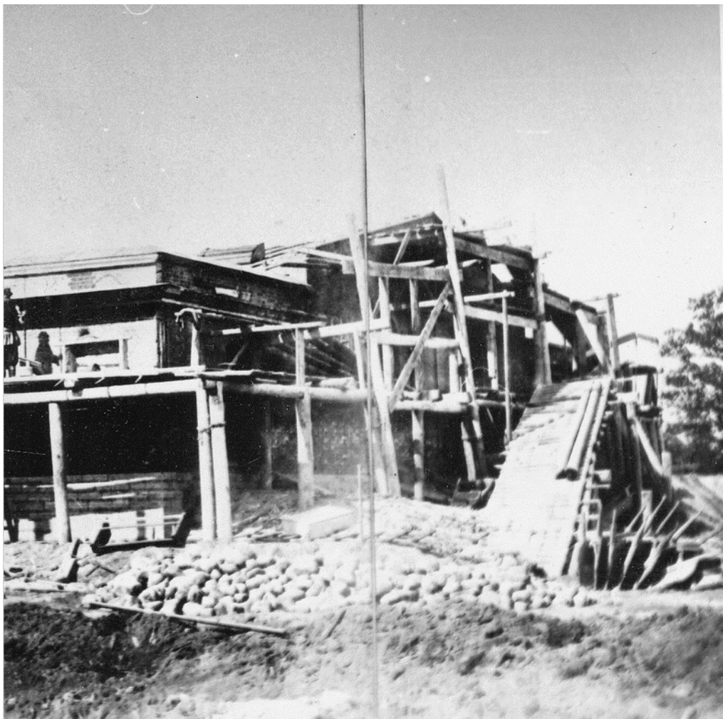
13. ЦГАКФФД СПб. А 9712. Общий вид работ по постройке порохового погреба в Лисьем Носу (панорама из 2-х снимков). 1865 г.
