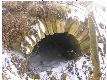
переход кирпичной галереи в канал
