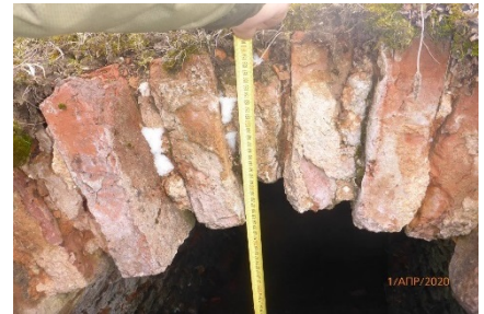
свод кирпичной галереи
