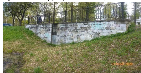
Водосливная плотина на пруду
