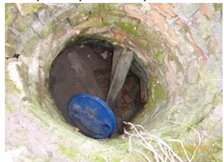
переход кирпичной галереи в канал
