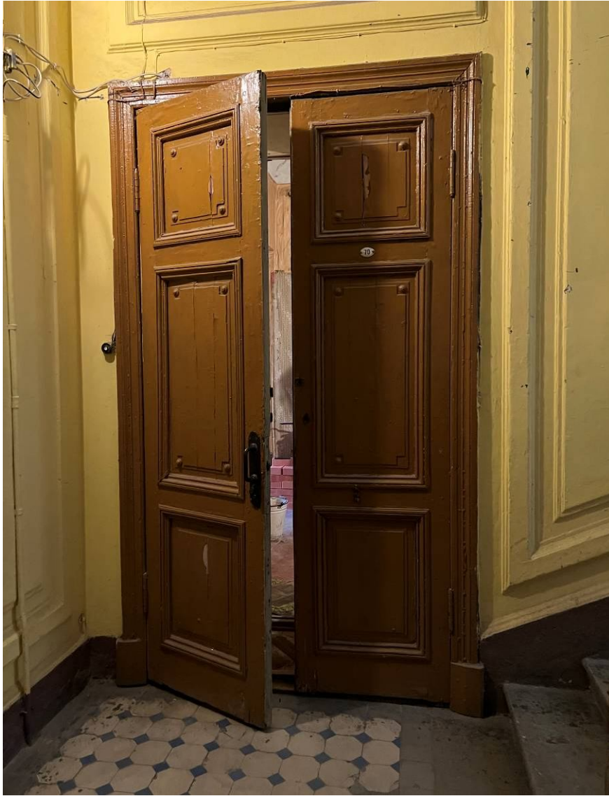
5. Вид на вход в квартиру №70 с лестничной клетки.
