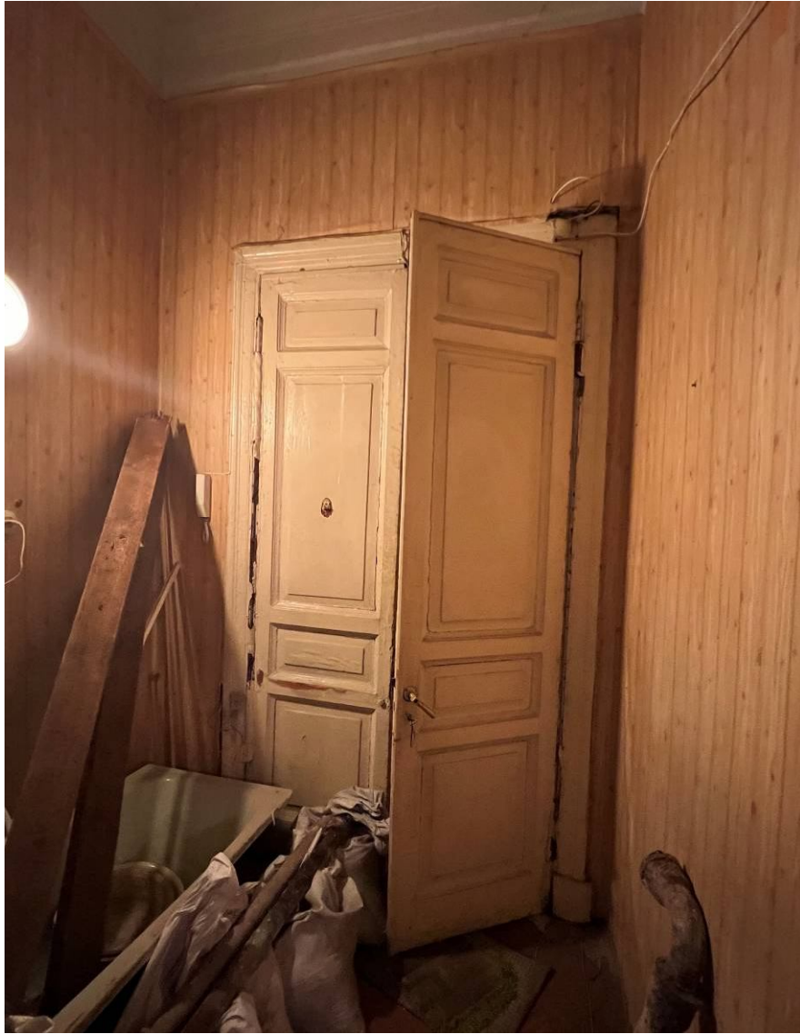
6. Вид на вход в квартиру №70 (пом.1).
