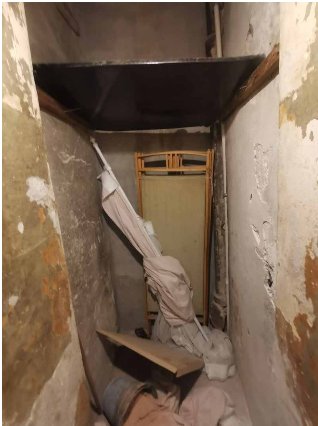
16. Фрагмент интерьера кладовой (помещение 5/0.9).
