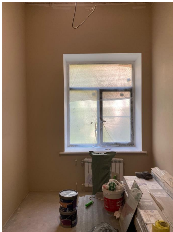
Фото 24. Фрагмент интерьера кв. № 33. Потолок жилой комнаты кв. № 33 (пом. № 2 после перепланировки).
