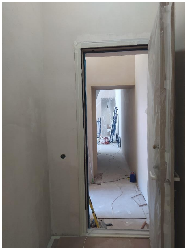
Фото 14. Вид на коридор кв. № 33 со стороны входа.
