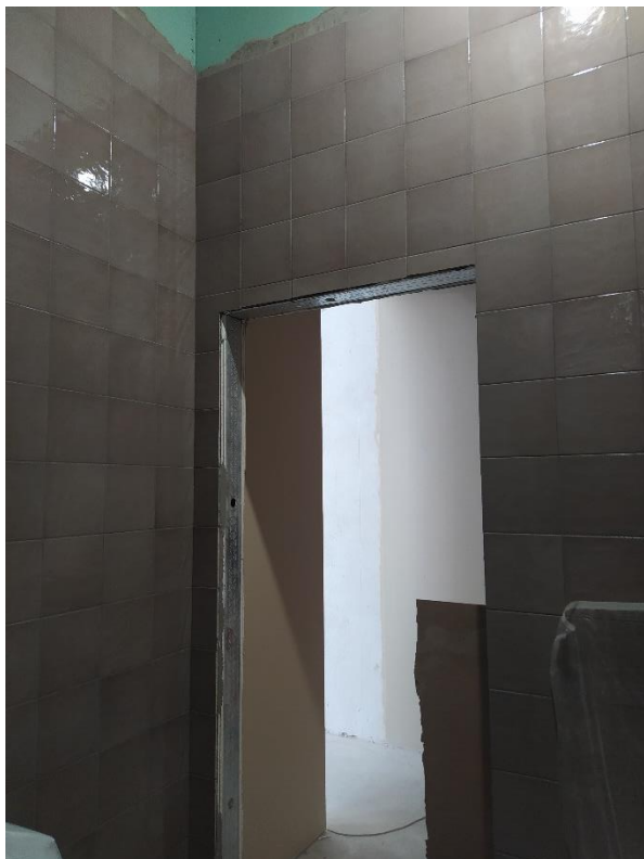
Фото 18. Вид на дверной проём санузла кв. № 33.
