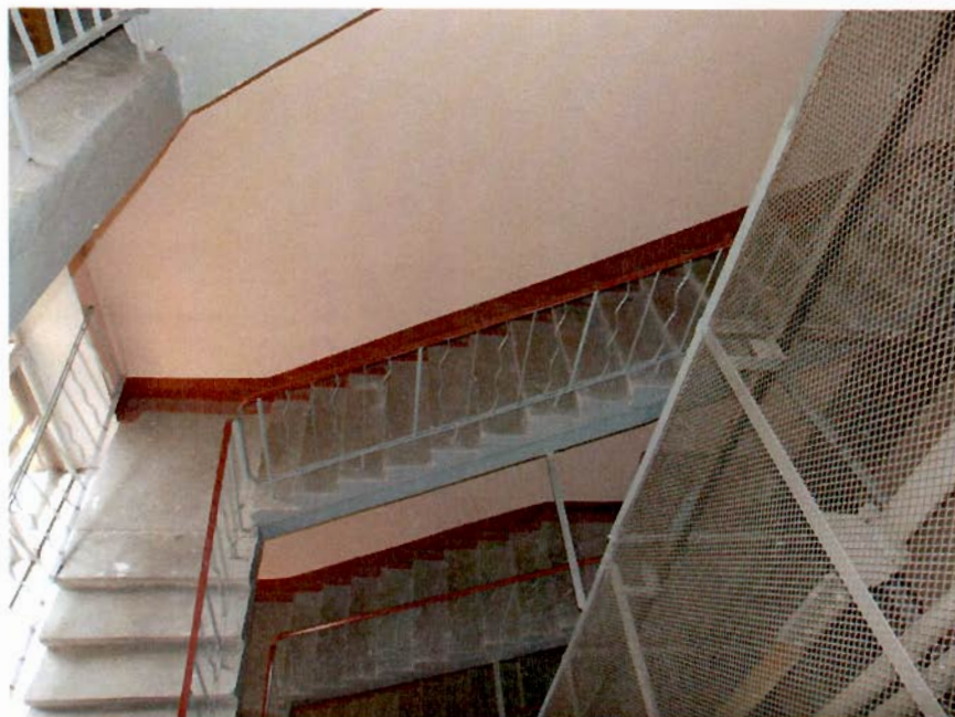
17. Лестница дворового флигеля.
