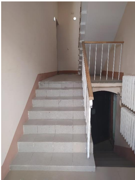
Фото 10. Лестница западного флигеля.
