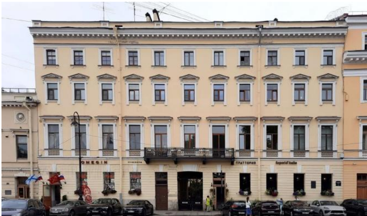
Фото 1. Объект культурного наследия регионального значения «Дом, в котором в 1888 – 1889 гг. жил художник Серов Валентин Александрович». Общий вид лицевого фасада здания по Итальянской улице в южном направлении.
