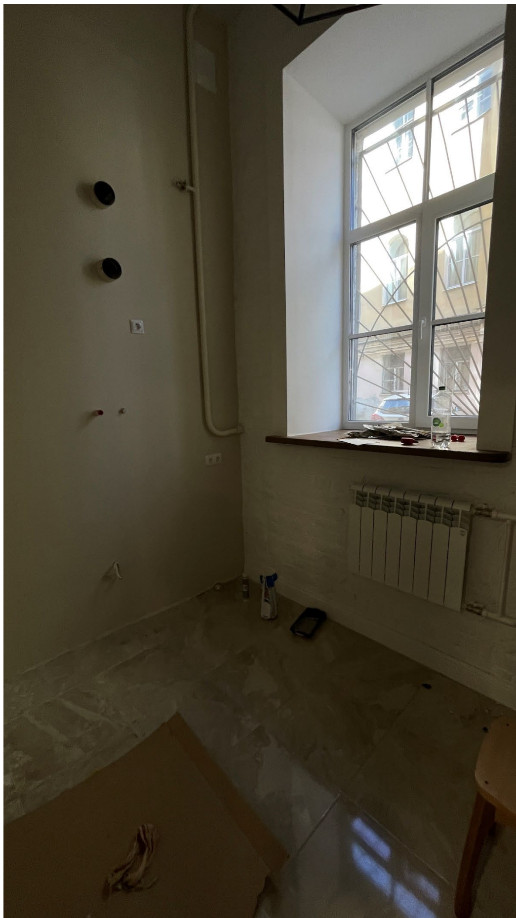
11. Фрагмент интерьера кухни (помещение №3/6.4);
