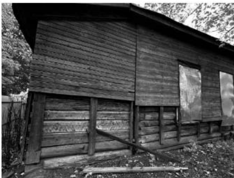
Фото №4. Фрагмент западного фасада здания.
