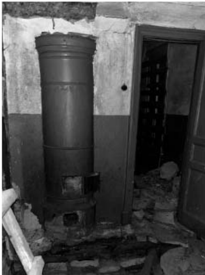
Фото №25. Внутреннее помещение здания.
