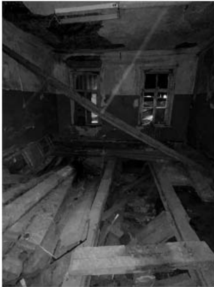
Фото №19. Внутреннее помещение здания.
