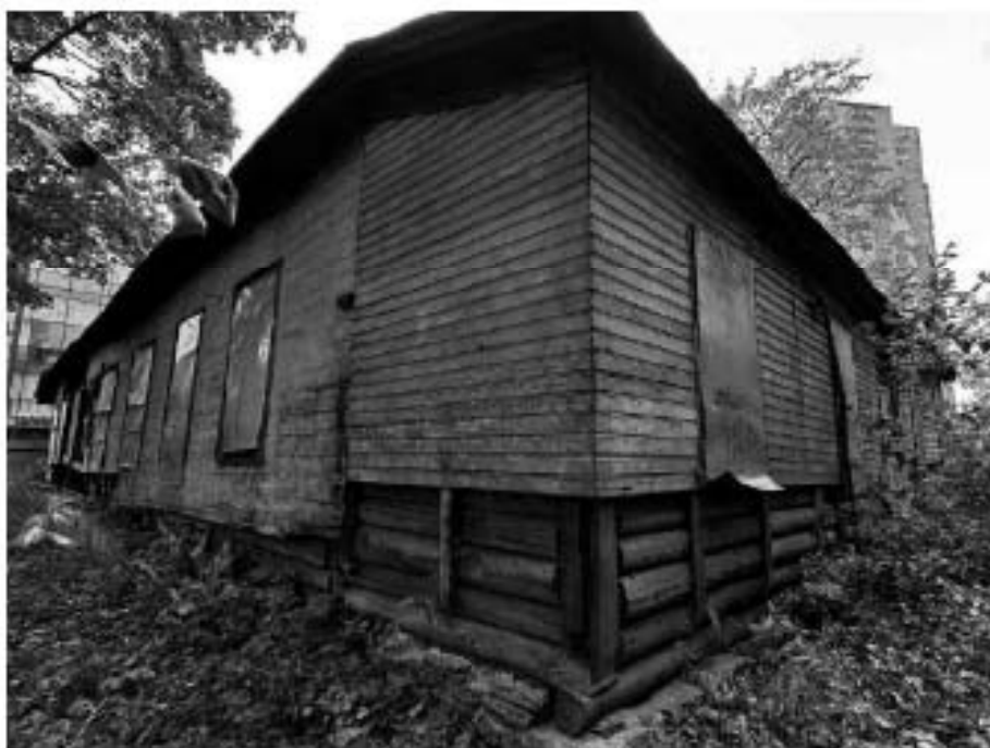
Фото №2. Вид на восточный и северный фасады здания, в направлении с северо-востока на юго-запад.
