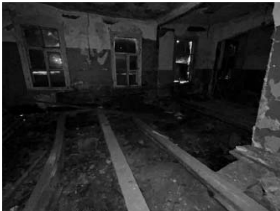
Фото №18. Внутреннее помещение здания.
