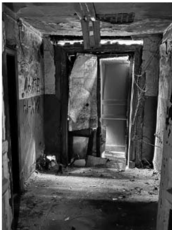
Фото №24. Внутреннее помещение здания, коридор, вход в здание с северного фасада.
