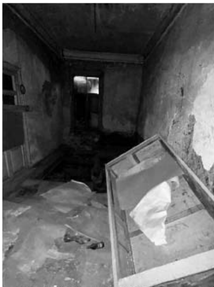
Фото №22. Внутреннее помещение здания.
