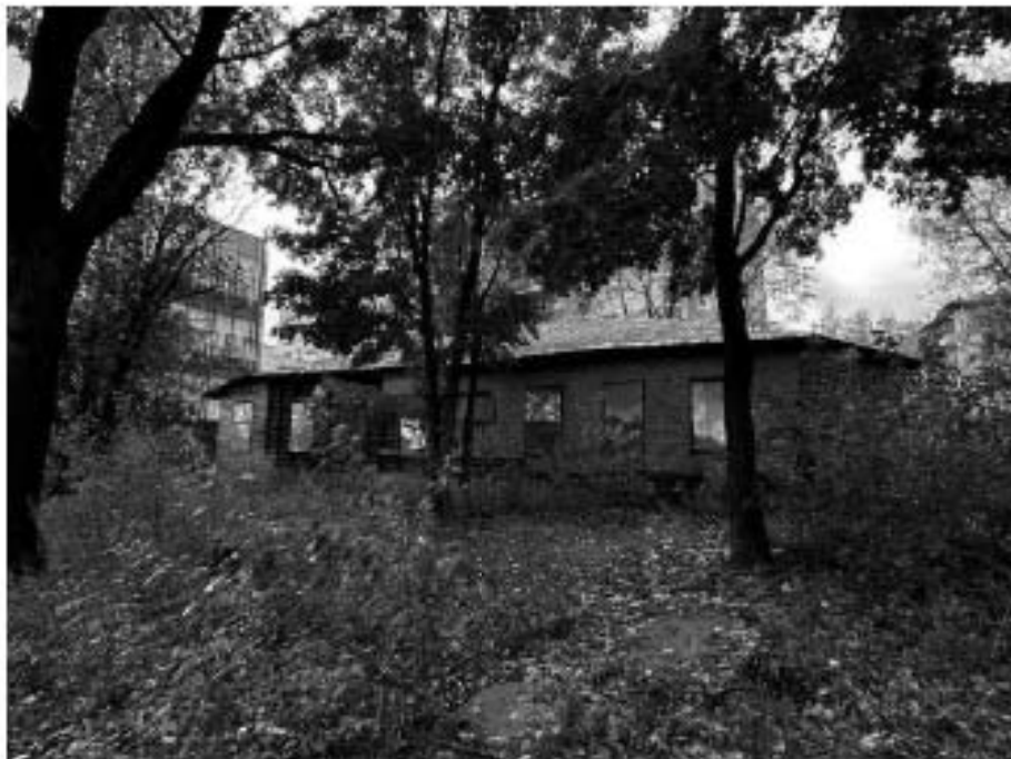
Фото №1. Вид на восточный фасад здания и территорию, в направлении с востока на запад.
