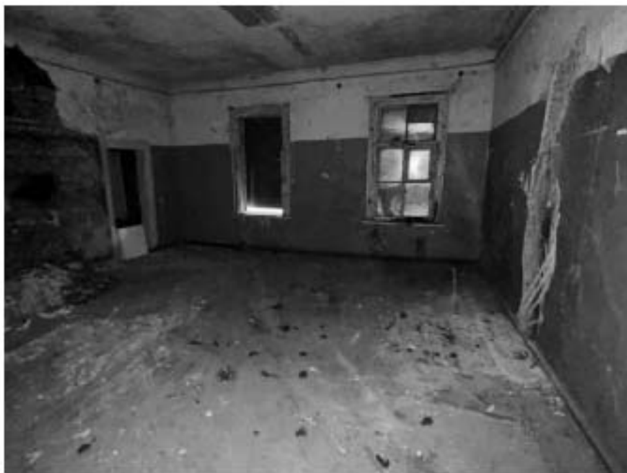
Фото №20. Внутреннее помещение здания.
