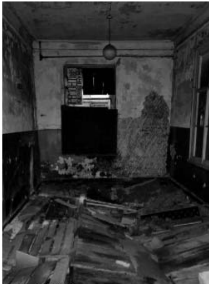
Фото №15. Внутреннее помещение здания.
