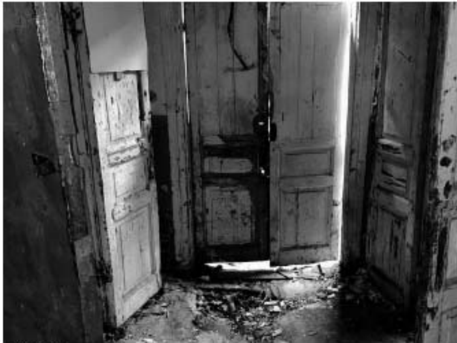
Фото №11. Внутреннее помещение здания, вход в здание с южного фасада.
