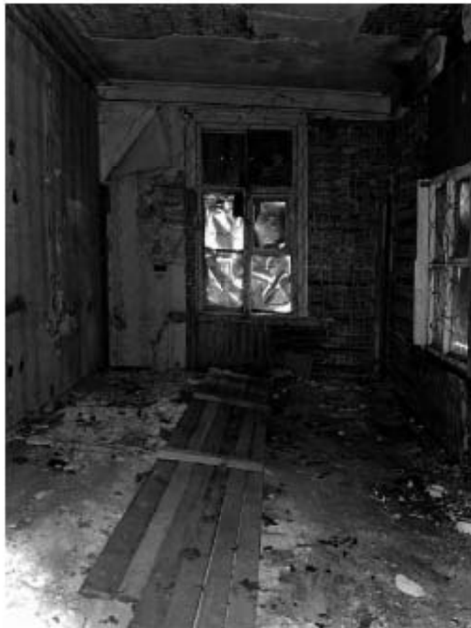
Фото №12. Внутреннее помещение здания.
