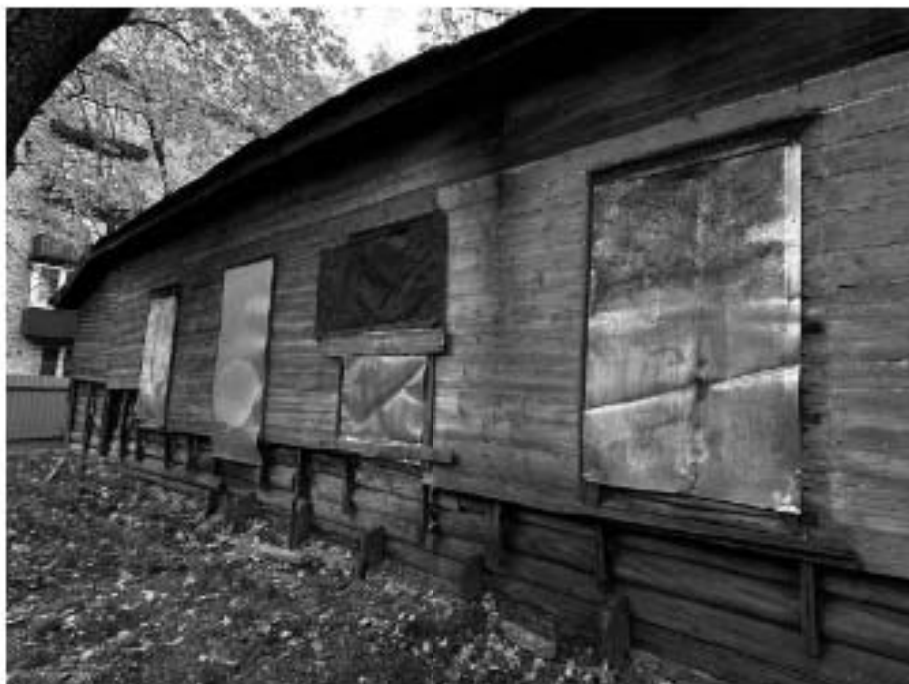
Фото №5. Фрагмент западного фасада здания, вид в направлении с юго-запада на север.
