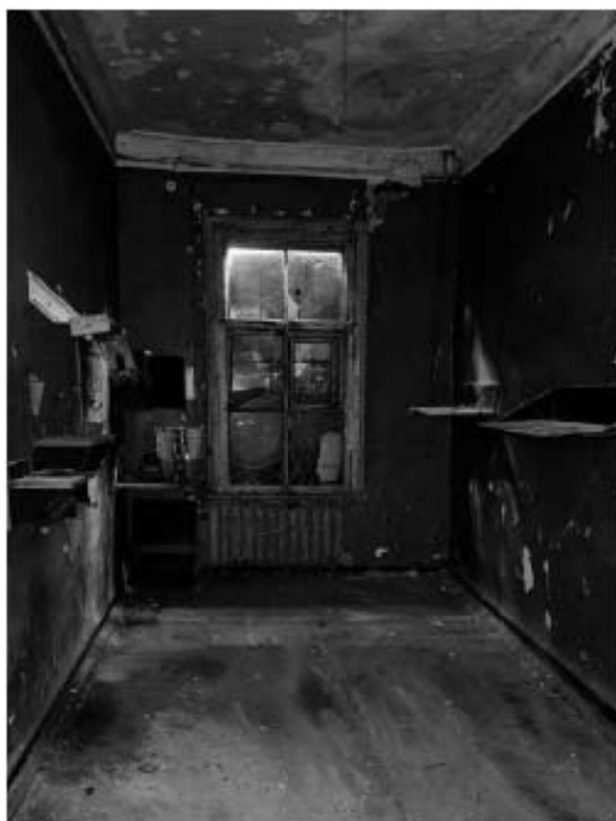
Фото №16. Внутреннее помещение здания.
