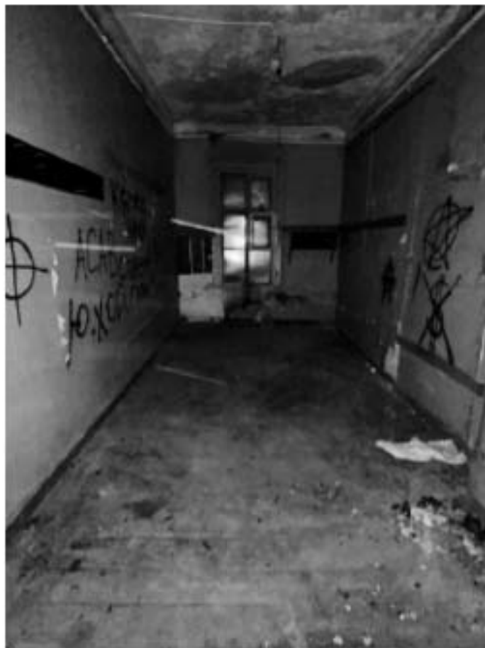
Фото №21. Внутреннее помещение здания.
