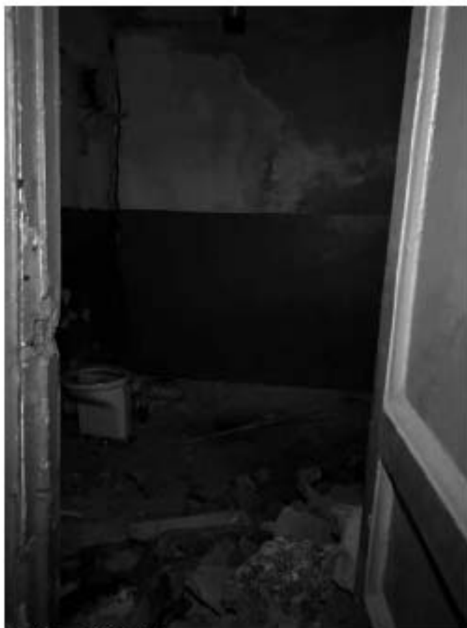
Фото №26. Внутреннее помещение здания.
