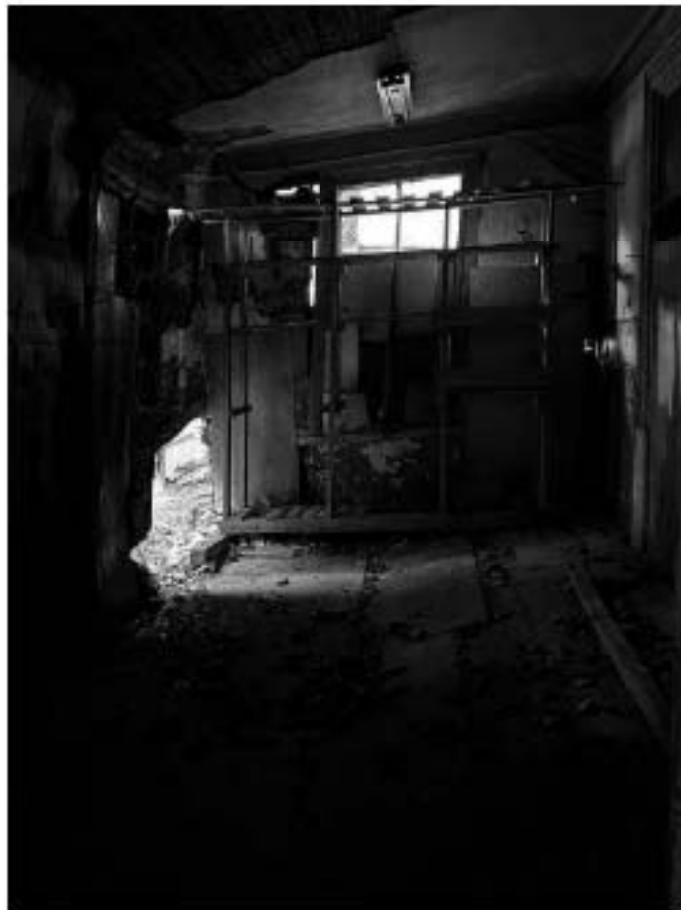
Фото №10. Внутреннее помещение здания.
