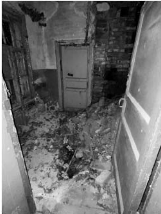
Фото №23. Внутреннее помещение здания.
