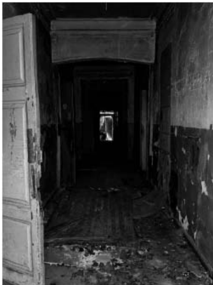
Фото №13. Внутреннее помещение здания, коридор.
