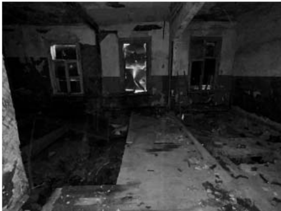
Фото №17. Внутреннее помещение здания.
