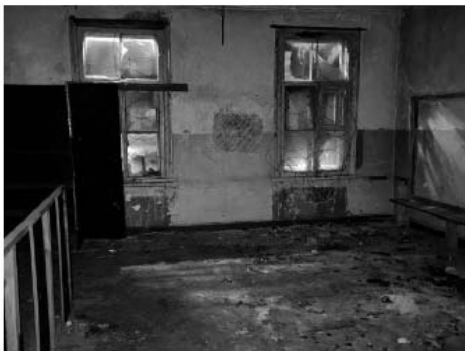
Фото №14. Внутреннее помещение здания.
