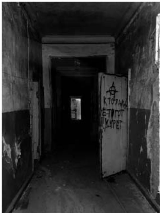
Фото №27. Внутреннее помещение здания, коридор.
