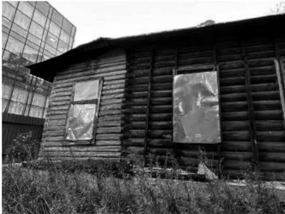
Фото №9. Фрагмент восточного фасада, вид в направлении с востока на юго-запад.
