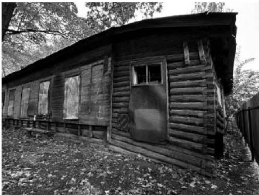
Фото №7. Фрагмент западного фасада здания, вид в направлении с юго-запада на северо-восток.
