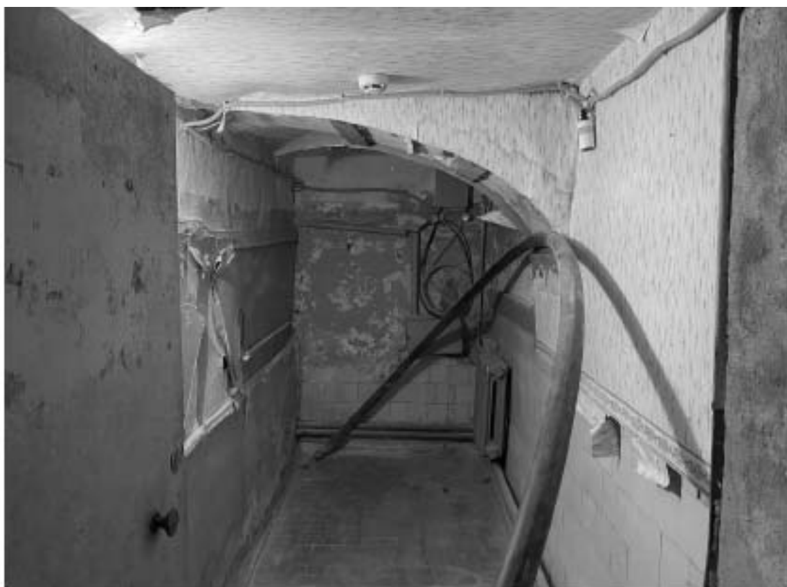
11. Объект культурного наследия регионального значения «Дом А. Гейрота с беседкой, садом и оградой», расположенный по адресу: Санкт-Петербург, город Петергоф, улица Бородачёва, дом 12, литера А. Общий вид пом. 1-Н (49) в уровне подвала.
