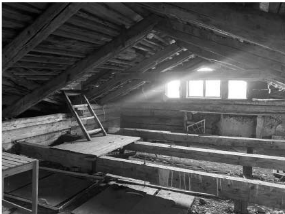
47. Объект культурного наследия регионального значения «Дом А. Гейрота с беседкой, садом и оградой», расположенный по адресу: Санкт-Петербург, город Петергоф, улица Бородачёва, дом 12, литера А. Общий вид стропильной системы.
