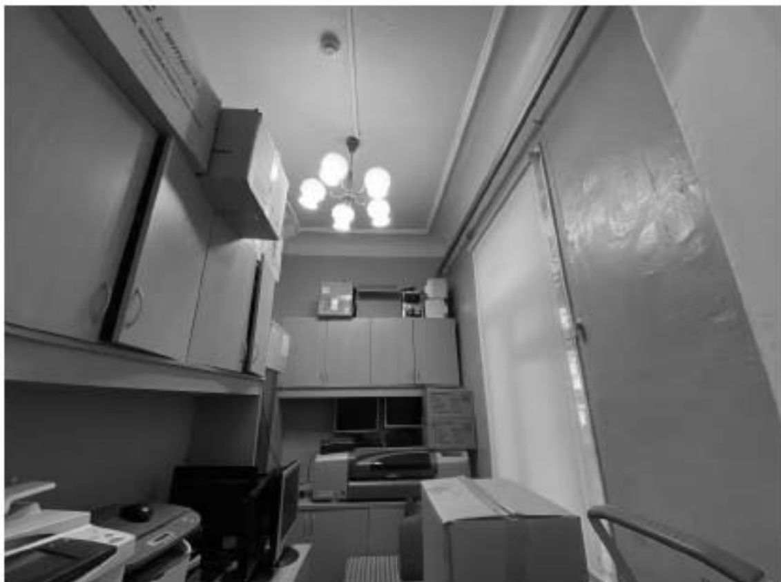
32. Объект культурного наследия регионального значения «Дом А. Гейрота с беседкой, садом и оградой», расположенный по адресу: Санкт-Петербург, город Петергоф, улица Бородачёва, дом 12, литера А. Общий вид пом. 1-Н (8) в уровне 1-го этажа.
