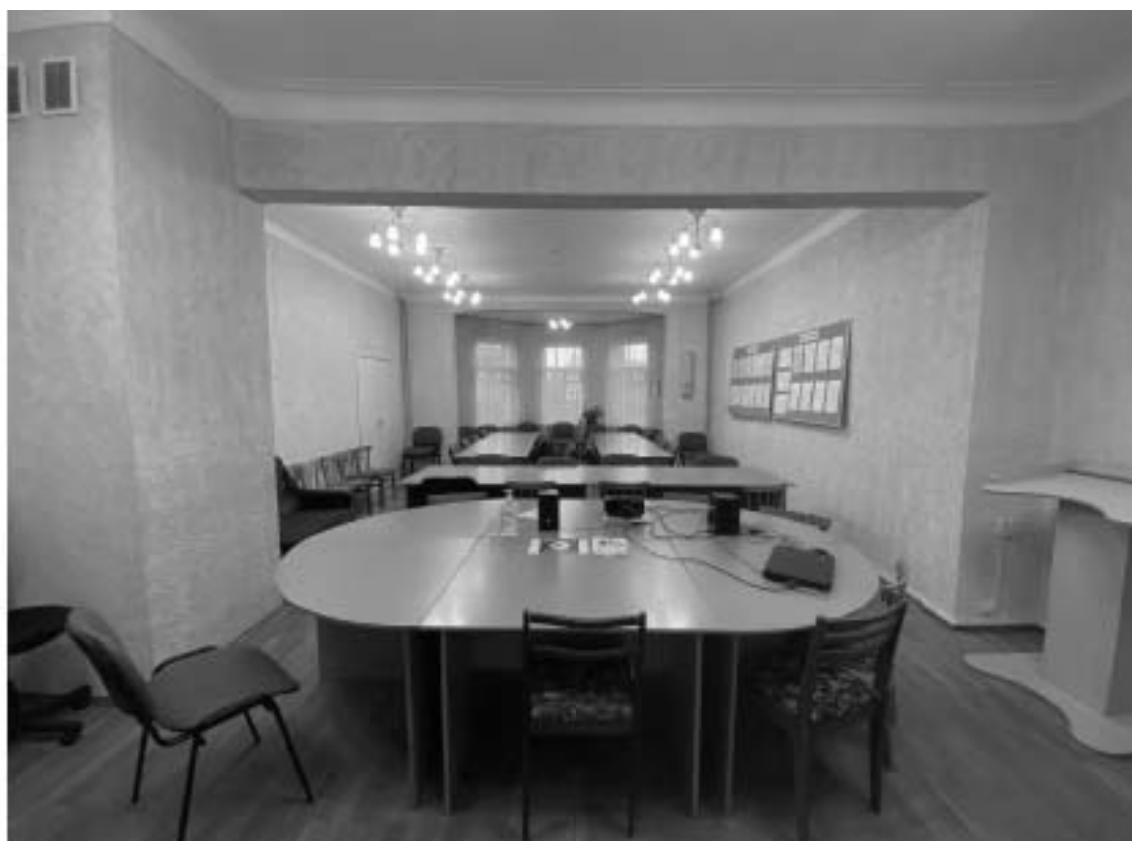
29. Объект культурного наследия регионального значения «Дом А. Гейрота с беседкой, садом и оградой», расположенный по адресу: Санкт-Петербург, город Петергоф, улица Бородачёва, дом 12, литера А. Общий вид пом. 1-Н (9) в уровне 1-го этажа.
