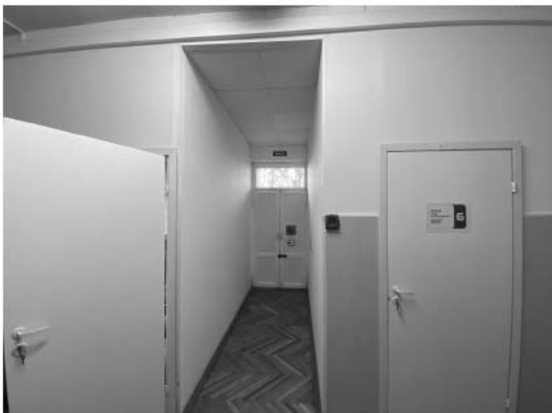
24. Объект культурного наследия регионального значения «Дом А. Гейрота с беседкой, садом и оградой», расположенный по адресу: Санкт-Петербург, город Петергоф, улица Бородачёва, дом 12, литера А. Фрагмент пом. 1-Н (4) в уровне 1-го этажа.
