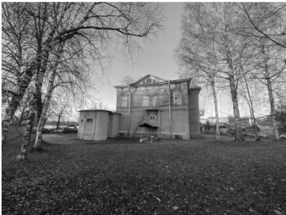
5. Объект культурного наследия регионального значения «Дом А. Гейрота с беседкой, садом и оградой», расположенный по адресу: Санкт-Петербург, город Петергоф, улица Бородачёва, дом 12, литера А. Общий вид южного фасада.
