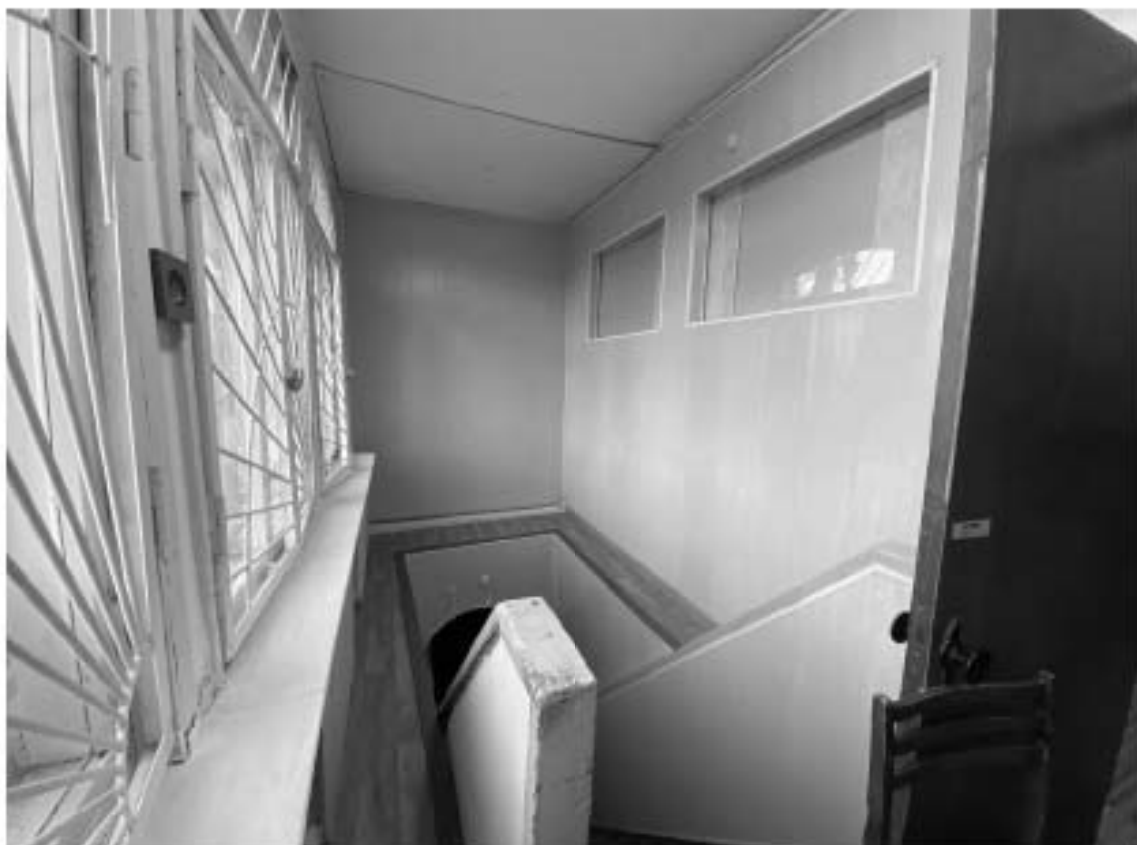
20. Объект культурного наследия регионального значения «Дом А. Гейрота с беседкой, садом и оградой», расположенный по адресу: Санкт-Петербург, город Петергоф, улица Бородачёва, дом 12, литера А. Общий вид пом. 1-Н (2) в уровне 1-го этажа.
