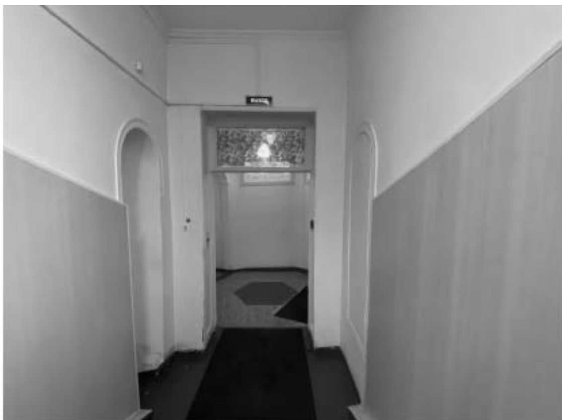
19. Объект культурного наследия регионального значения «Дом А. Гейрота с беседкой, садом и оградой», расположенный по адресу: Санкт-Петербург, город Петергоф, улица Бородачёва, дом 12, литера А. Общий вид пом. 1-Н (2) в уровне 1-го этажа.
