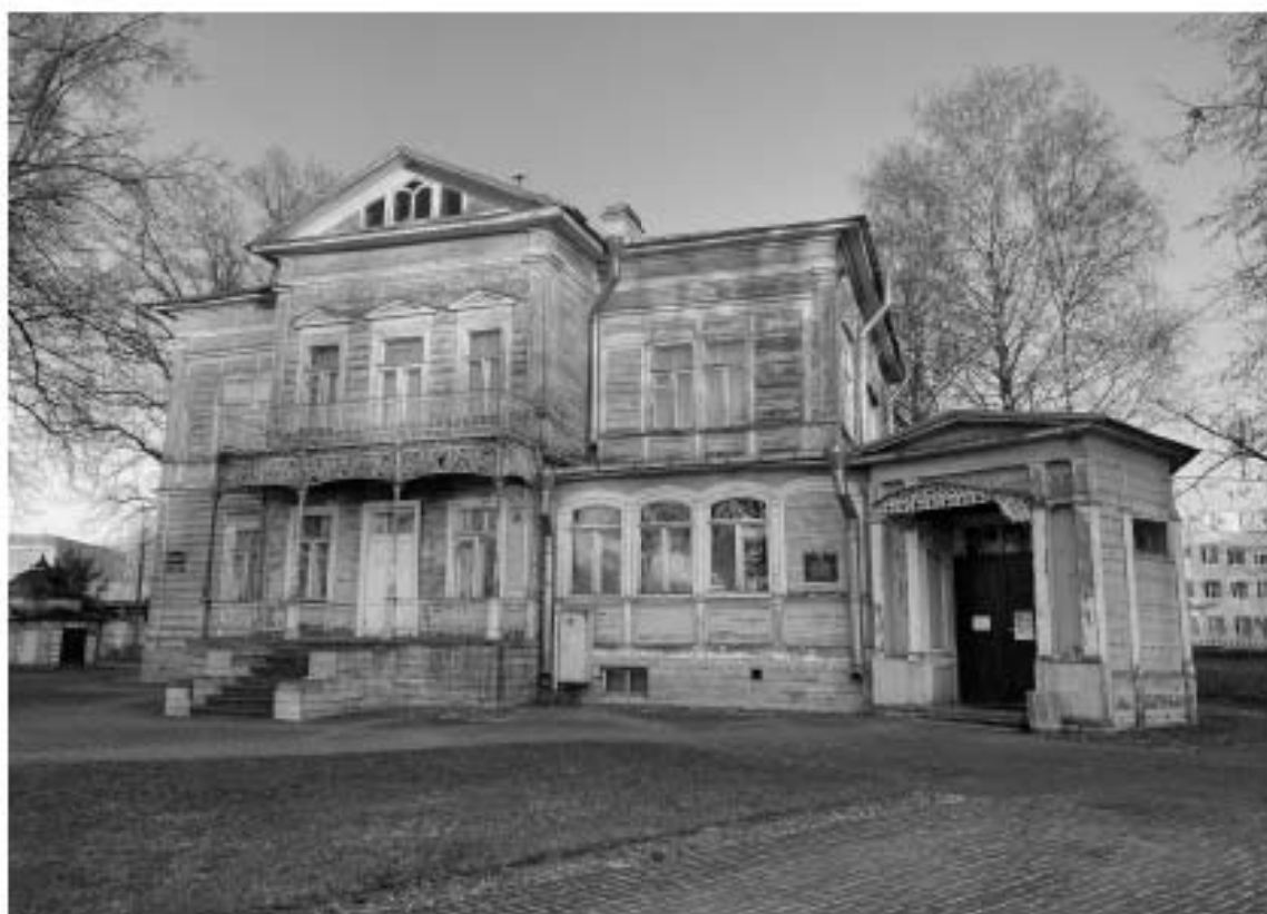
1. Объект культурного наследия регионального значения «Дом А. Гейрота с беседкой, садом и оградой», расположенный по адресу: Санкт-Петербург, город Петергоф, улица Бородачёва, дом 12, литера А. Общий вид западного лицевого фасада.
