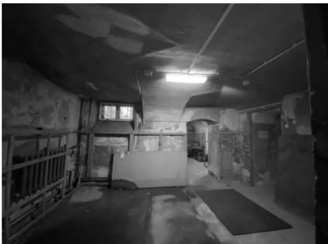
7. Объект культурного наследия регионального значения «Дом А. Гейрота с беседкой, садом и оградой», расположенный по адресу: Санкт-Петербург, город Петергоф, улица Бородачёва, дом 12, литера А. Общий вид пом. 1-Н (38) в уровне подвала.
