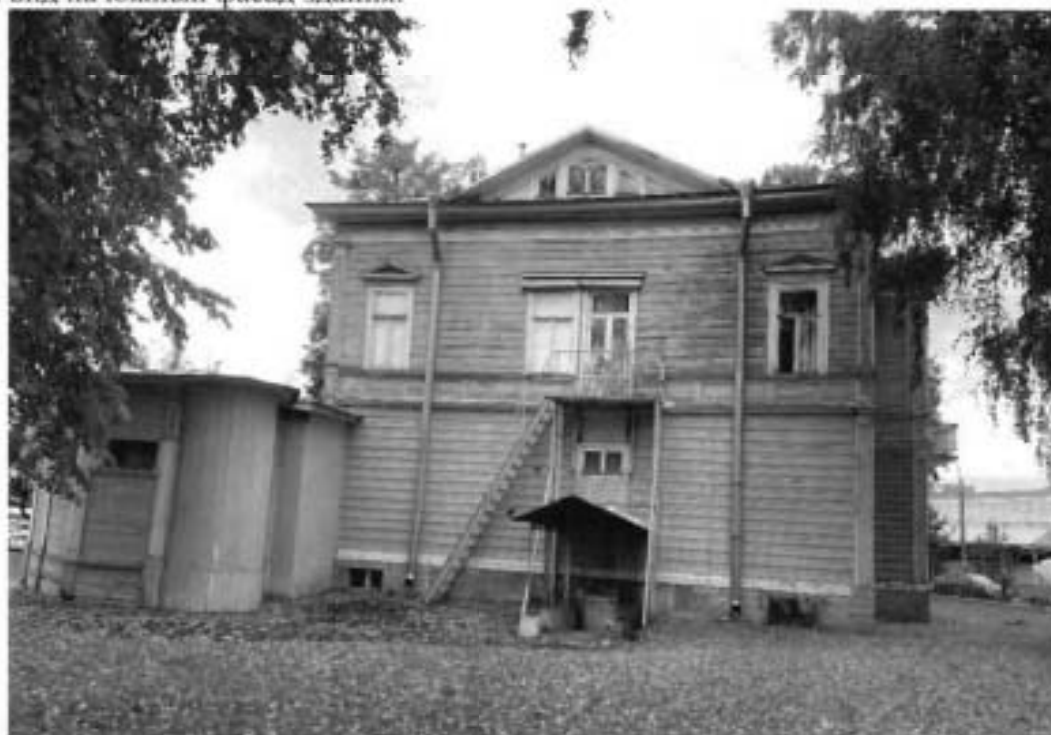
4. Общий вид на южный фасад здания.
