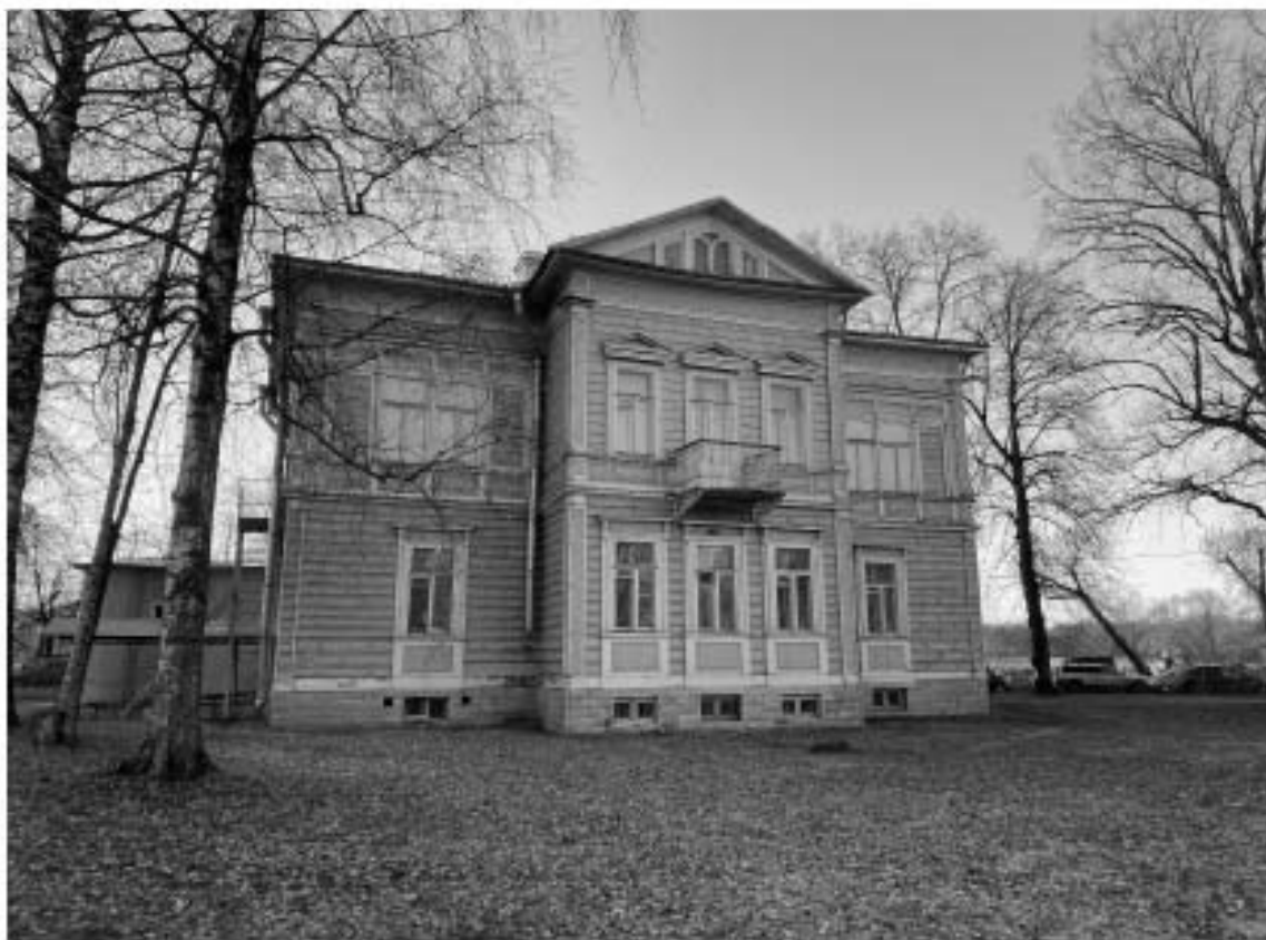
4. Объект культурного наследия регионального значения «Дом А. Гейрота с беседкой, садом и оградой», расположенный по адресу: Санкт-Петербург, город Петергоф, улица Бородачёва, дом 12, литера А. Общий вид восточного фасада.
