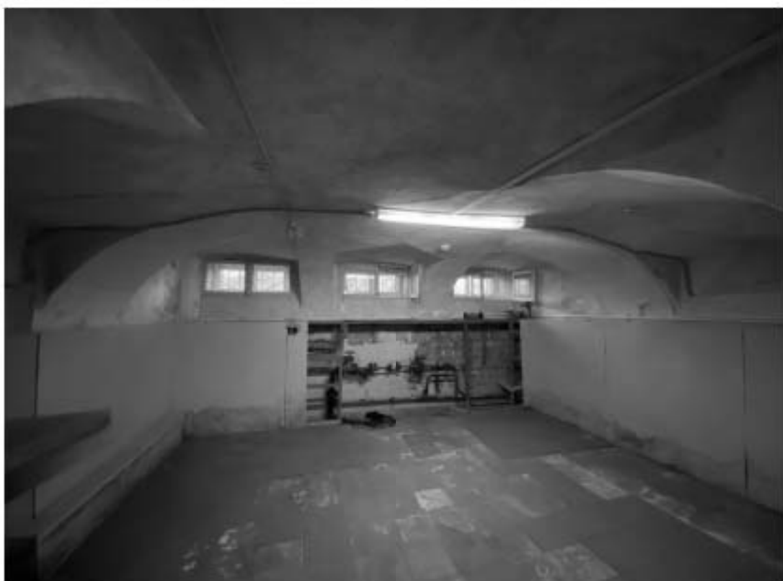
13. Объект культурного наследия регионального значения «Дом А. Гейрота с беседкой, садом и оградой», расположенный по адресу: Санкт-Петербург, город Петергоф, улица Бородачёва, дом 12, литера А. Общий вид пом. 1-Н (49) в уровне подвала.
