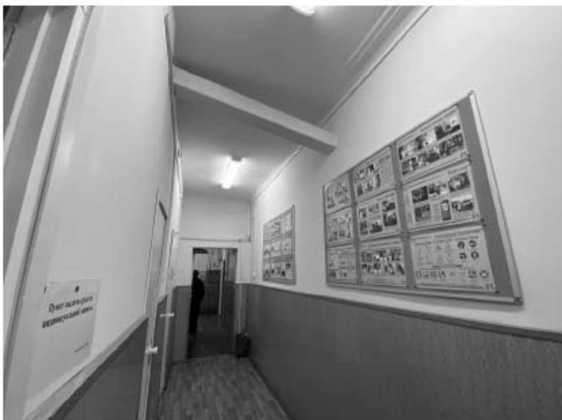
33. Объект культурного наследия регионального значения «Дом А. Гейрота с беседкой, садом и оградой», расположенный по адресу: Санкт-Петербург, город Петергоф, улица Бородачёва, дом 12, литера А. Общий вид пом. 1-Н (12) в уровне 1-го этажа.
