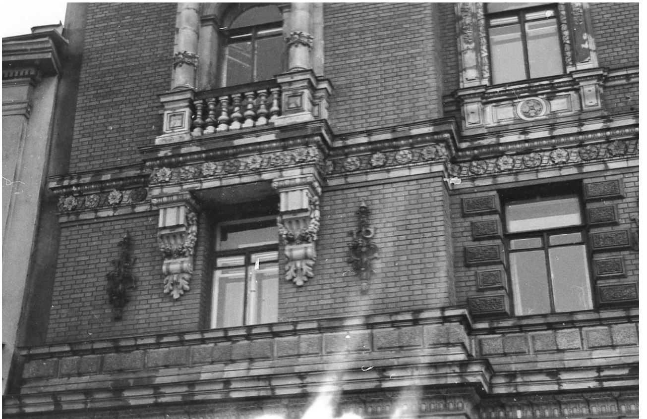
Илл.27. Фрагмент фасада дома по набережной реки Фонтанки, 64. Фотография 1975 г. Источник – сайт pastvu.com .
