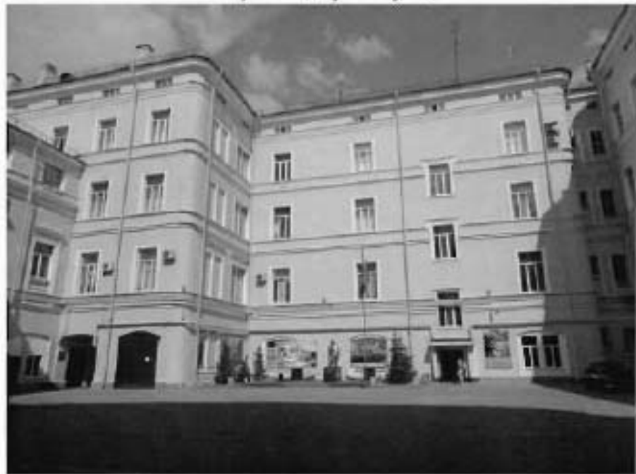
3. Фрагмент дворового фасада
