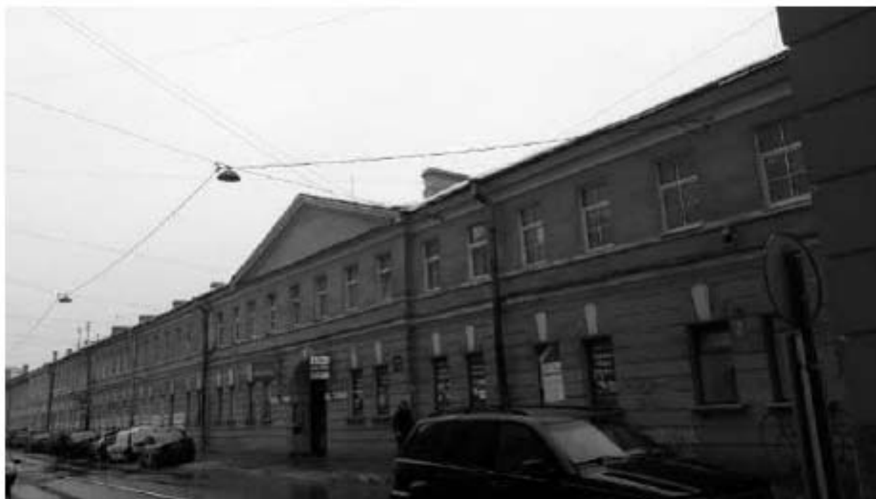
45. Службы (три корпуса). Дворец Воронцова М.И. (Пажеский корпус). Садовая улица, дом 26, литера А. Лицевой фасад. Фото мест установки оборудования и кабельных трасс. Штиглиц М.С. 10.01.2022.
