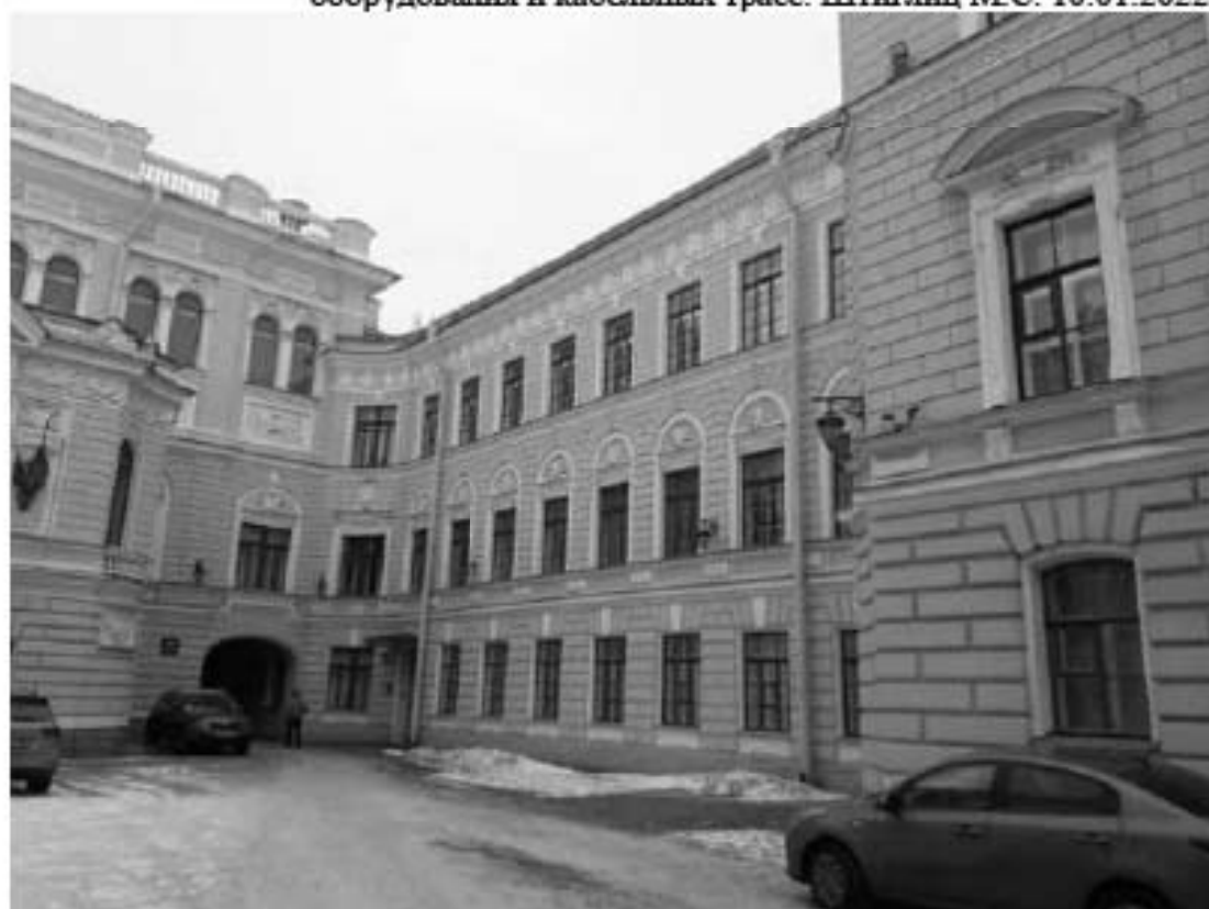
38. Главное здание (концертный зал с учебными флигелями) (в составе «Капелла Придворная певческая»). Набережная реки Мойки, дом 20, литера А. Лицевой фасад. Фото мест установки оборудования и кабельных трасс. Штиглиц М.С. 10.01.2022.
