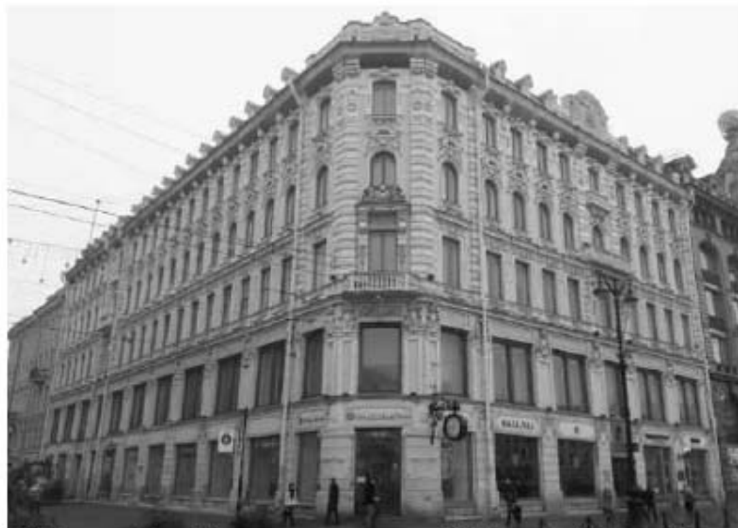
19. Дом Г.И. Гансена. Малая Конюшенная улица, дом 16/26, литера А. Лицевой фасад. Фото мест установки оборудования и кабельных трасс. Штиглиц М.С. 10.01.2022.
