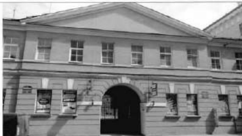
19. Фрагмент лицевого фасада
