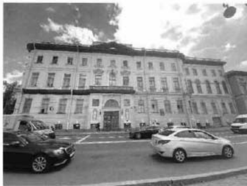
2. Северный лицевой фасад объекта культурного наследия.
