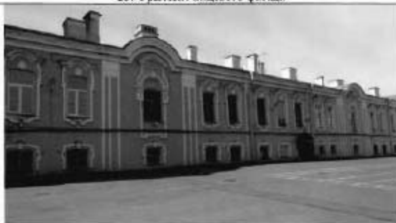
24. Фрагмент дворового фасада
