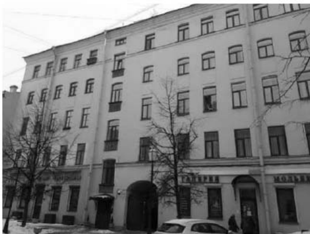
15. Корпус квартирный с флигелями (в составе «Капелла Придворная певческая»). Большая Конюшенная улица, дом 11, литера Б. Западный фасад. Фото мест установки оборудования и кабельных трасс. Штиглиц М.С.
