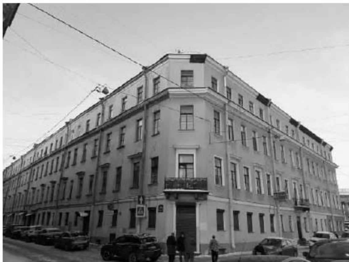
7. Дом Лесниковых. Сергея Тюленина ул., д. 4/23. Лицевой фасад. Штиглиц М.С. 10.01.2022.
