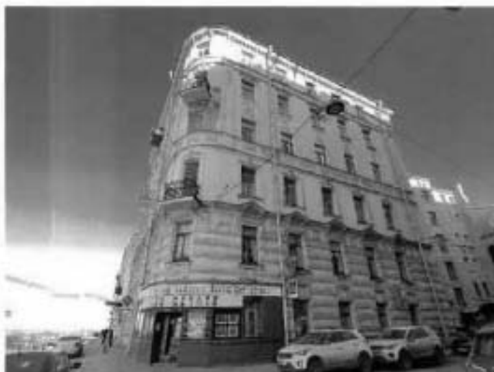
1. Общий вид на объект культурного наследия.
