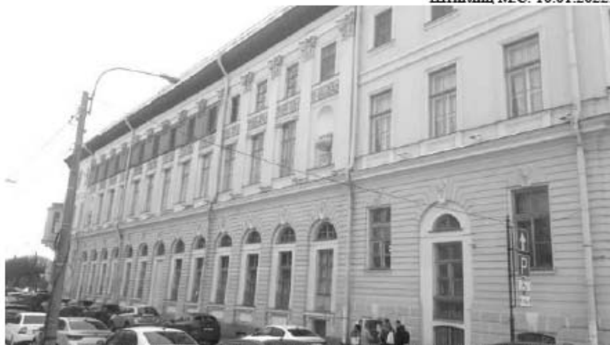
25. Дом Бежкого И.И. (принца Ольденбургского П.Г.). Миллионная улица, дом 1, литера А. Лицевой фасад. Фото мест установки оборудования и кабельных трасс. Штиглиц М.С. 10.01.2022.
