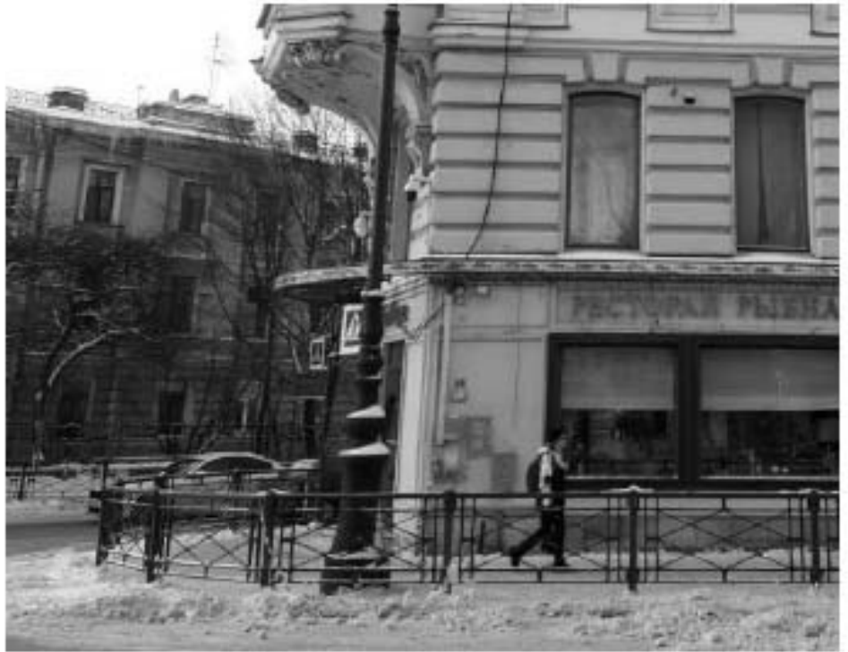
10. Дом А.В. Кашенко. Суворовский пр., д. 34, лит. А. Лицевой фасад. Фото мест установки оборудования и кабельных трасс. Штиглиц М.С. 10.01.2022.
