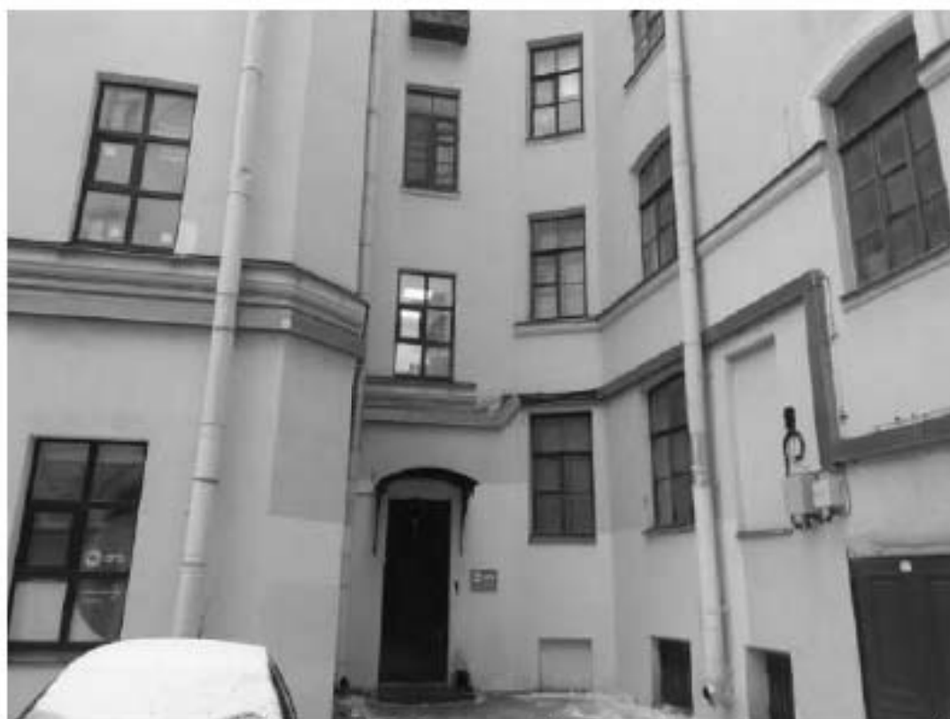
14. Корпус квартирный с флигелями (в составе «Капелла Придворная певческая»). Большая Конюшенная улица, дом 11, литера А. Дворовые фасады. Фото мест установки оборудования и кабельных трасс. Штиглиц М.С. 10.01.2022.
