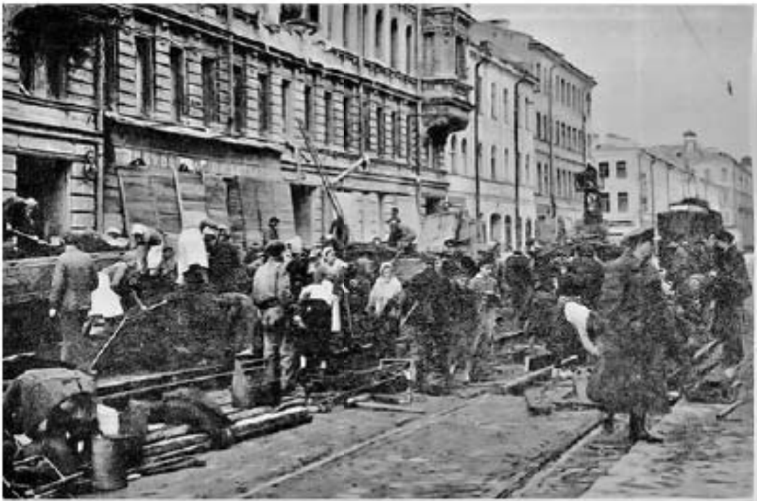
Первый вагон финишного строительства на Ленинград. Восстановительные работы на частном пр. 25-го Октября изранены Волга (2), куда пришла свобода. 7 сентября 1941 г.
