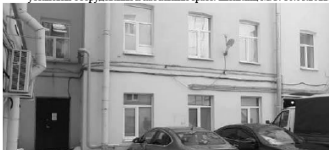
34. Дом жилой с дворовыми флигелями (в составе «Дом Пашковой Е.П. (посольство Франции)»). Набережная Кутузова, дом 10, литера А. Дворовые фасады. Фото мест установки оборудования и кабельных трасс. Штиглиц М.С. 10.01.2022.
