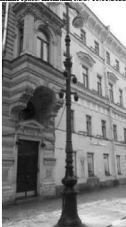
48. Дом Котомина К.Б. Большая Морская улица, дом 6, литера А, опора освещения (Санкт-Петербург, Невский проспект, дом 18, литера А, опора освещения). Фото мест установки оборудования и кабельных трасс. Штиглиц М.С. 10.01.2022.
