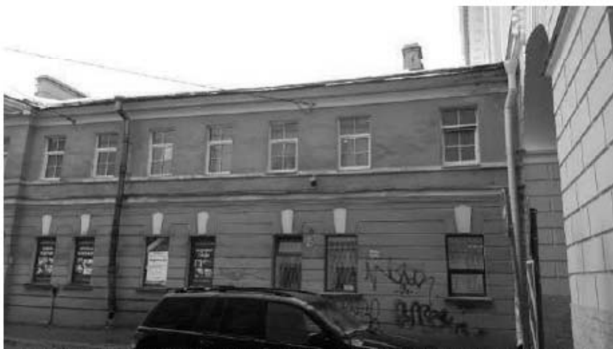
46. Службы (три корпуса) (в составе «Дворец Воронцова М.И. (Пажеский корпус)»). Садовая улица, дом 26, литера А. Лицевой фасад. Фото мест установки оборудования и кабельных трасс. Штиглиц М.С. 10.01.2022.
