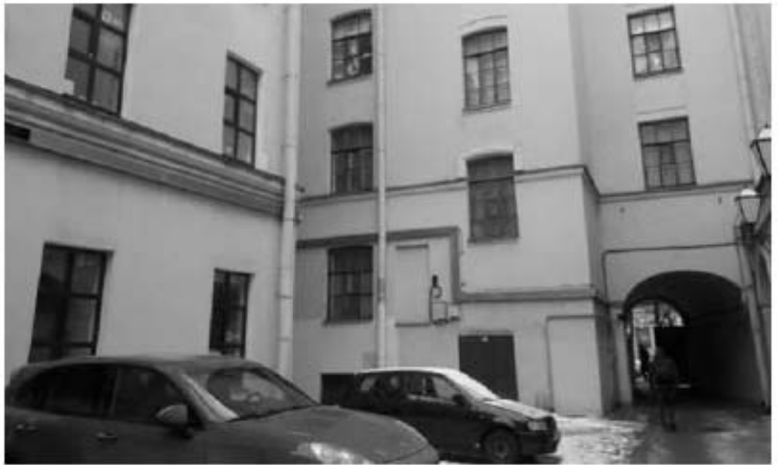
12. Корпус квартирный с флигелями (в составе «Капелла Придворная певческая»). Большая Конюшенная улица, дом 11, литера А. Дворовые фасады. Фото мест установки оборудования и кабельных трасс. Штиглиц М.С. 10.01.2022.
