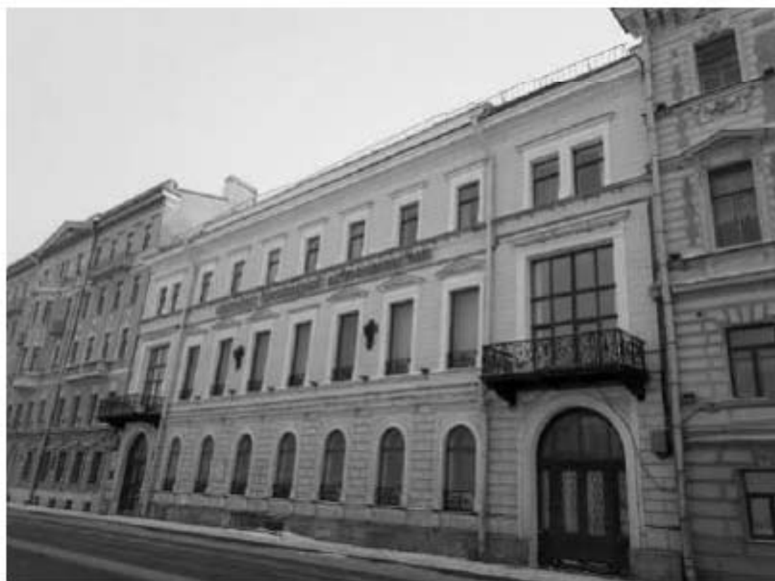
31. Дом жилой с дворовыми флигелями (в составе «Дом Папковой Е.П. (посольство Франции)»). Набережная Кутузова, дом 10, литера А. Лицевой фасад. Фото мест установки оборудования и кабельных трасс. Штиглиц М.С. 10.01.2022.
