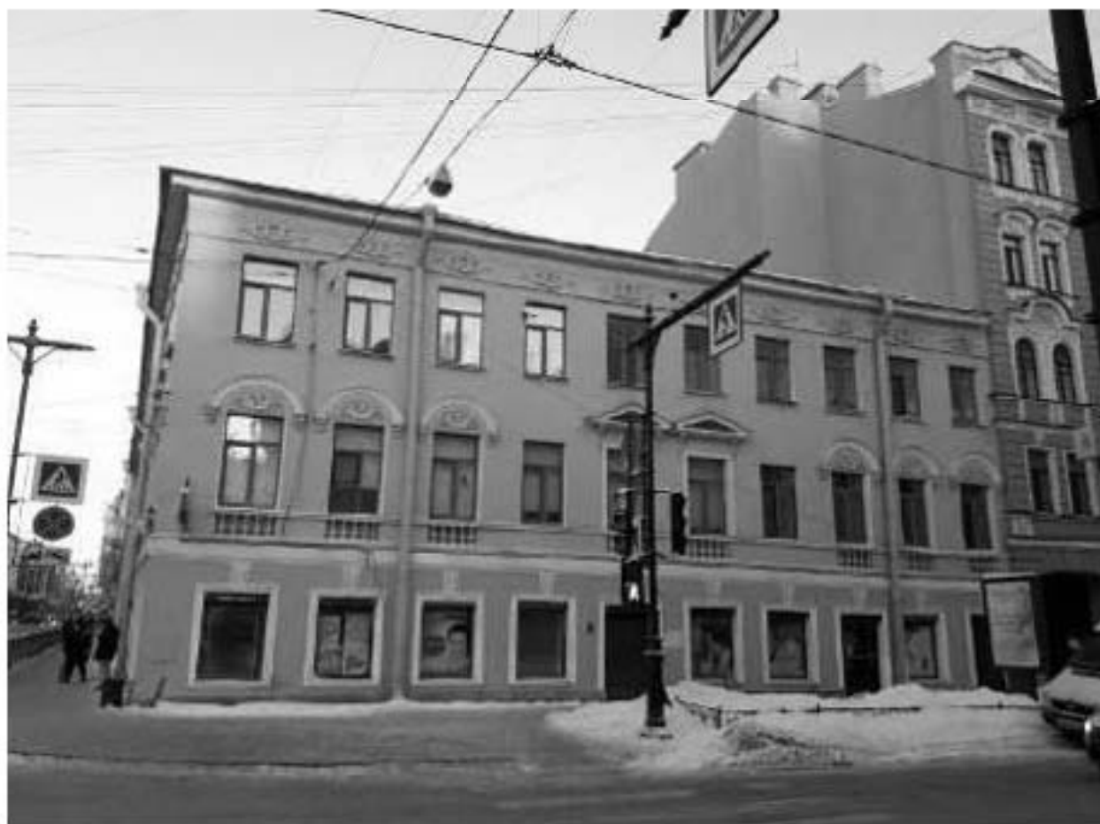
1. Дом А. Александровой. 3-я Советская ул., д. 20/5, лит. А. Лицевой фасад. Фото мест установки оборудования и кабельных трасс. Штиглиц М.С. 10.01.2022.
