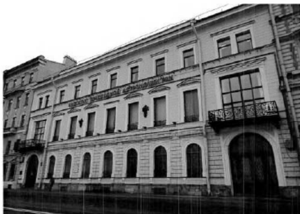
1. Общий вид на лицевой фасад с набережной Кутузова.
