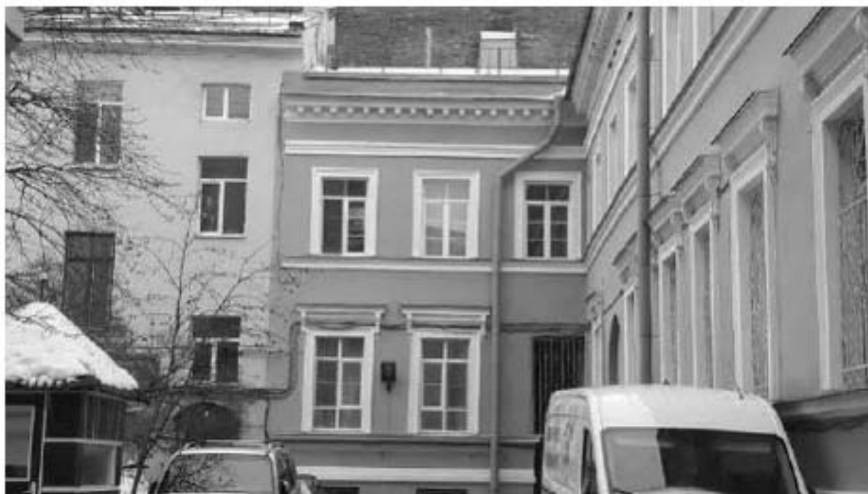
30. Главная аптека. Миллионная улица, дом 4/1, литера А. Дворовые фасады. Фото мест установки оборудования и кабельных трасс. Штиглиц М.С. 10.01.2022.
