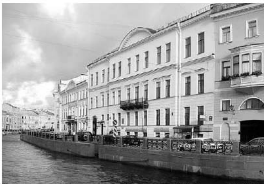
52. Особняк (в составе «Особняк и дом Жалдмировских (Н.Е. Демидовой)»). Наб. р. Мойки, д. 16, лит. А. Фото нач. 2000-х гг. (25)
