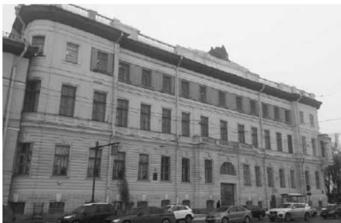
23. Дом Безухого И.И. (принца Ольденбургского П.Г.). Миллионная улица, дом 1, литера А. Лицевой фасад. Фото мест установки оборудования и кабельных трасс. Штиглиц М.С. 10.01.2022.
