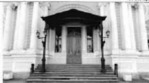
2. Фрагмент лицевого фасада
