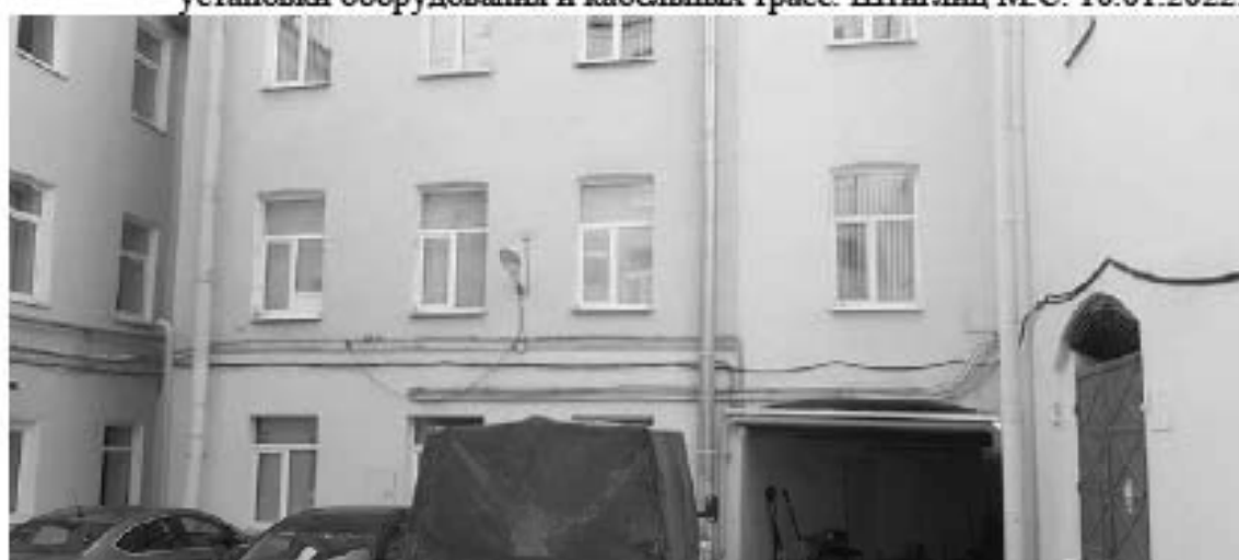
33. Дом жилой с дворовыми флигелями (в составе «Дом Пашковой Е.П. (посольство Франции)»). Набережная Кутузова, дом 10, литера А. Дворовые фасады. Фото мест установки оборудования и кабельных трасс. Штиглиц М.С. 10.01.2022.
