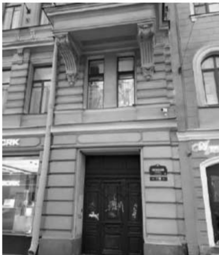
4. Дом Д.И. Тырлова. Невский пр., д. 119, литера А. Лицевой фасад. Фото мест установки оборудования и кабельных трасс. Штиглиц М.С. 10.01.2022.
