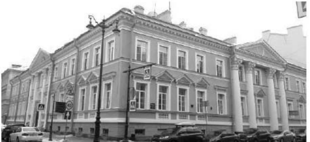
28. Главная аптека. Миллионная улица, дом 4/1, литера А. Лицевой фасад. Фото мест установки оборудования и кабельных трасс. Штиглиц М.С. 10.01.2022.
