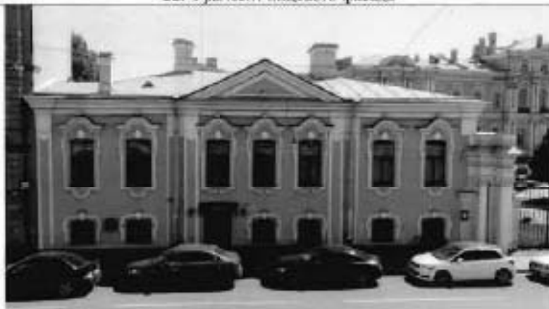
23. Фрагмент лицевого фасада
