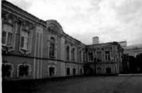
36. Фрагмент дворового фасада западного флигеля.
