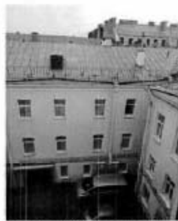
5. Фасады дворовых флигелей.
