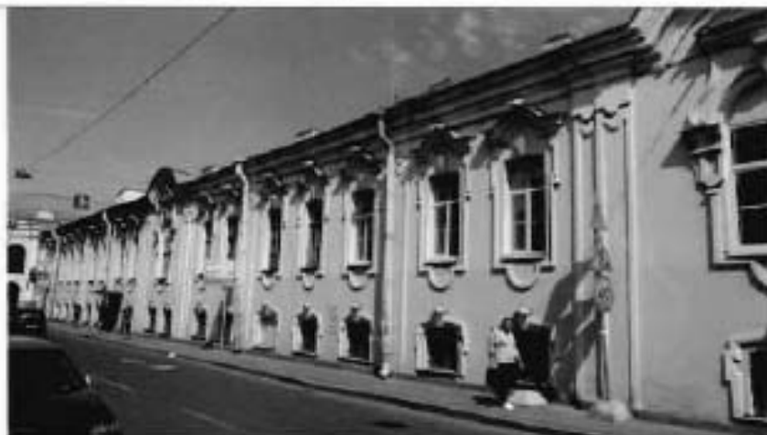
22. Фрагмент лицевого фасада
