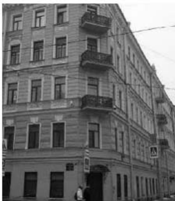
50. Дом, где жили: в декабре 1905 г. - Ленин В.И. и Крупская Н.К., в 1919-1936 гг. - писатель Тынянов Ю.Н. Греческий проспект, дом 15, литера А. Лицевой фасад. Фото мест установки оборудования и кабельных трасс. Штиглиц М.С. 10.01.2022.
