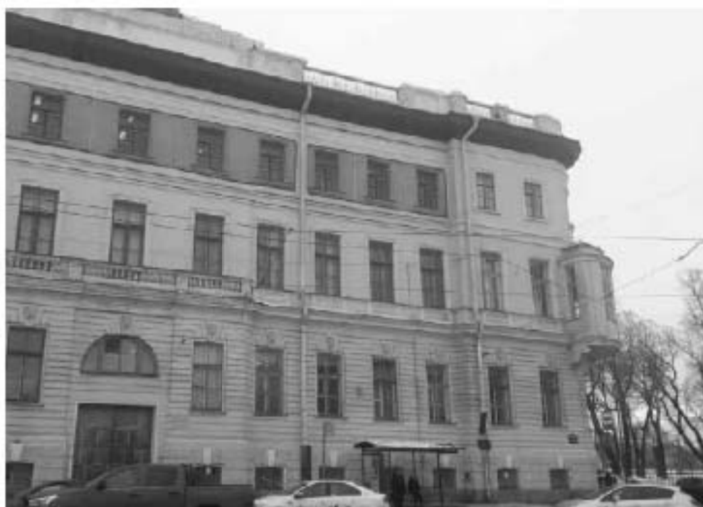
24. Дом Бежкого И.И. (принца Ольденбургского П.Г.). Миллионная улица, дом 1, литера А. Лицевой фасад. Фото мест установки оборудования и кабельных трасс. Штиглиц М.С. 10.01.2022.
