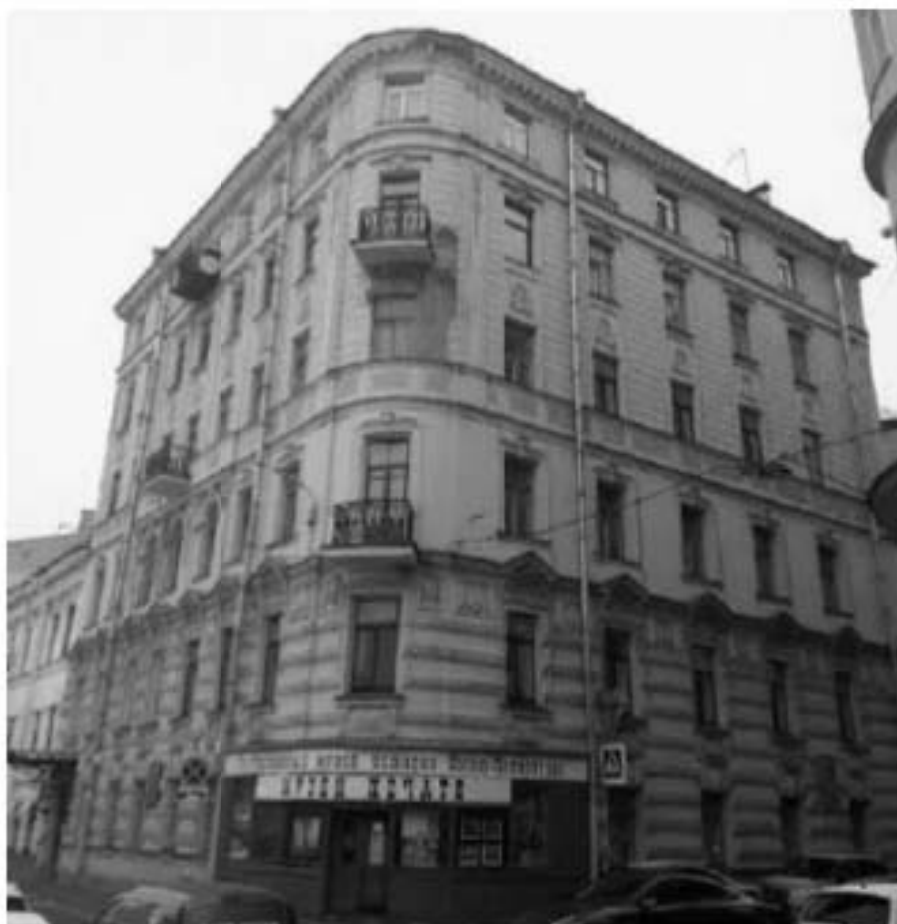
43. Типография Министерства внутренних дел. Набережная реки Мойки, дом 32, литера А. Лицевой фасад. Фото мест установки оборудования и кабельных трасс. Штиглиц М.С. 10.01.2022.
