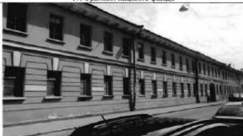
20. Фрагмент лицевого фасада
