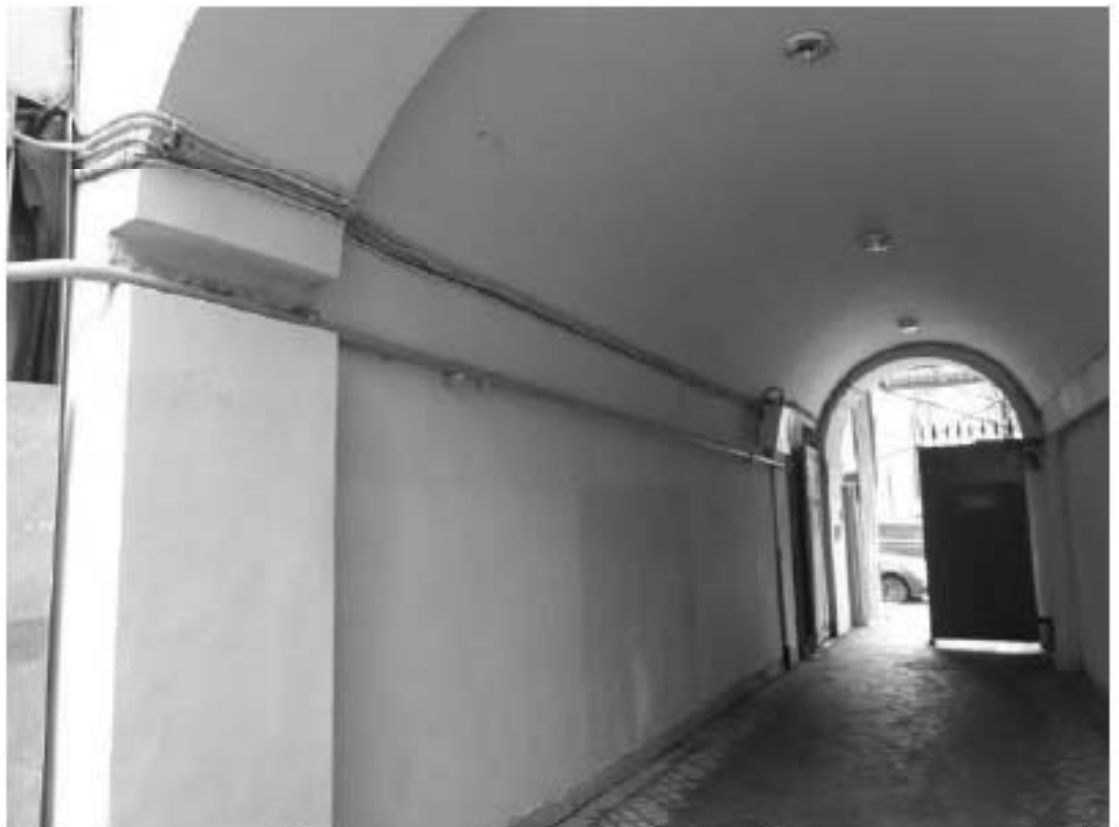
13. Корпус квартирный с флигелями (в составе «Капелла Придворная певческая»). Большая Конюшенная улица, дом 11, литера А. Арочный проезд. Фото мест установки оборудования и кабельных трасс. Штиглиц М.С. 10.01.2022.
