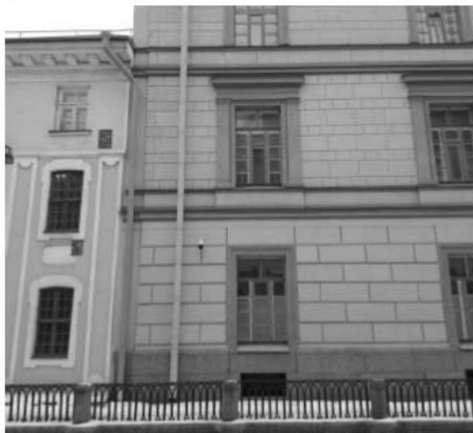
27. Здание казарм Первого батальона лейб-гвардии Преображенского полка. Миллионная улица, дом 33, литера А. Лицевой фасад. Фото мест установки оборудования и кабельных трасс. Штиглиц М.С. 10.01.2022.
