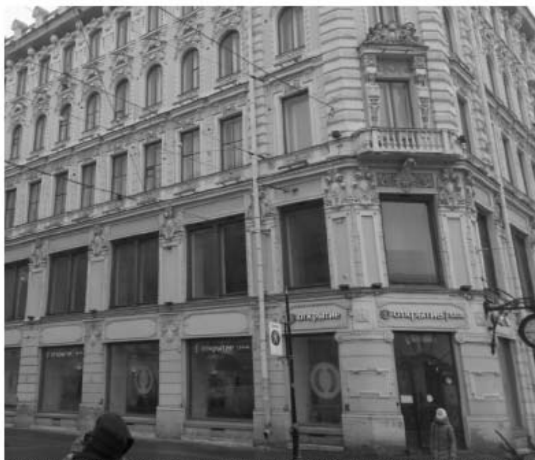
20. Дом Г.И. Гансена. Малая Конюшенная улица, дом 16/26, литера А. Лицевой фасад. Фото мест установки оборудования и кабельных трасс. Штиглиц М.С. 10.01.2022.
