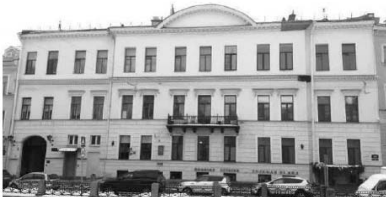
36. Особняк (в составе «Особняк и дом Жадмировских (Н.Е. Демидовой)»). Набережная реки Мойки, дом 16, литера А. Лицевой фасад. Фото мест установки оборудования и кабельных трасс. Штиглиц М.С. 10.01.2022.
