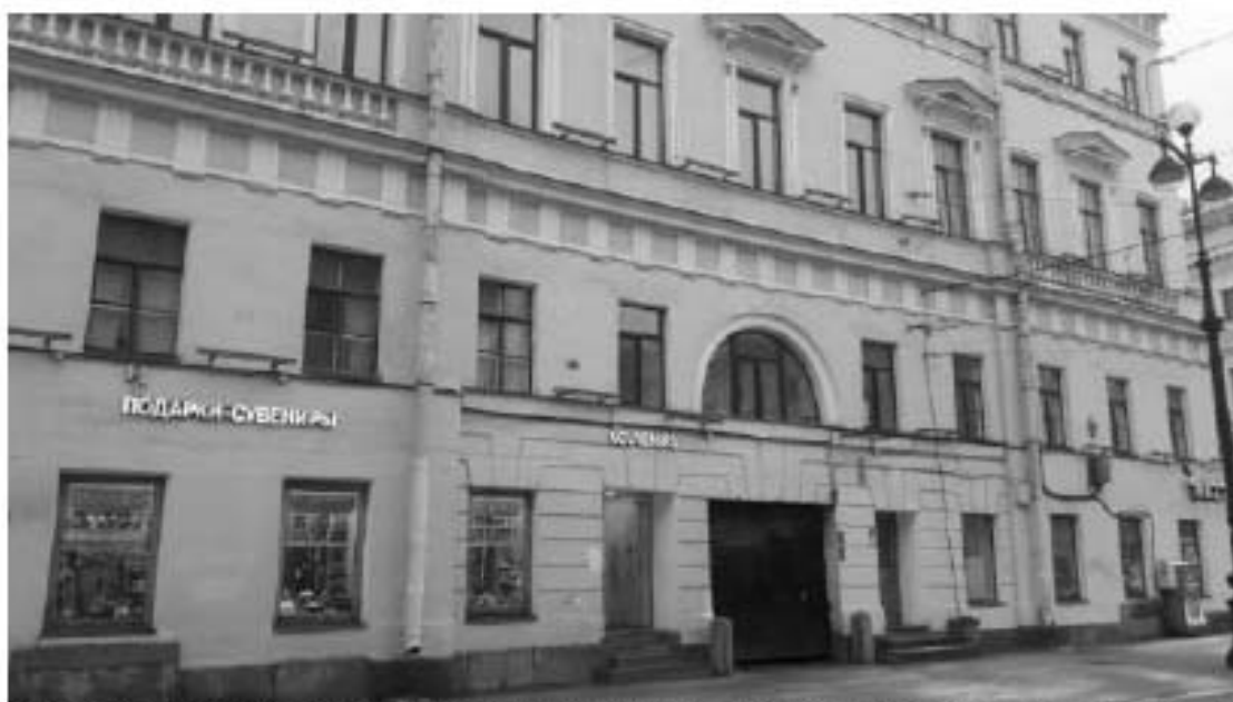
47. Дом Котомина К.Б. Большая Морская улица, дом 6, литера А, опора освещения (Санкт-Петербург, Невский проспект, дом 18, литера А, опора освещения). Фото мест установки оборудования и кабельных трасс. Штиглиц М.С. 10.01.2022.
