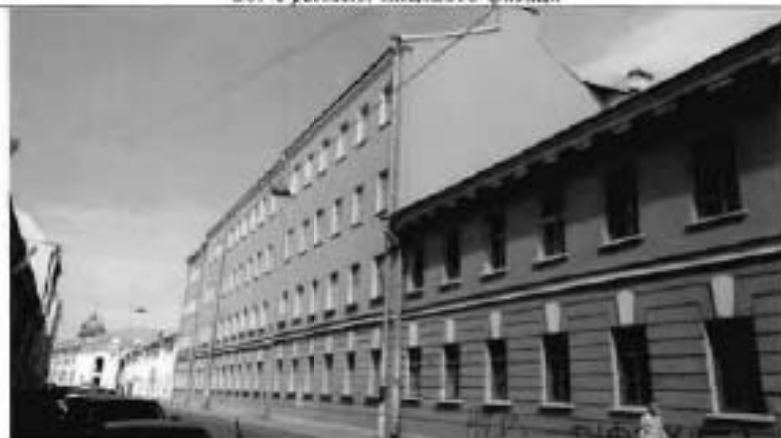
21. Фрагмент лицевого фасада
