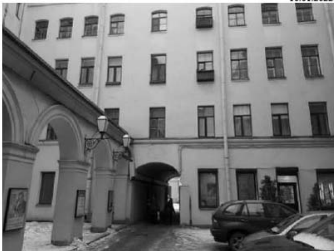
16. Корпус квартирный с флигелями (в составе «Капелла Придворная певческая»). Большая Конюшенная улица, дом 11, литера Б. Дворовые фасады. Фото мест установки оборудования и кабельных трасс. Штиглиц М.С. 10.01.2022.
