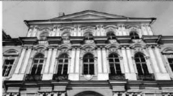
4. Фрагмент дворового фасада
