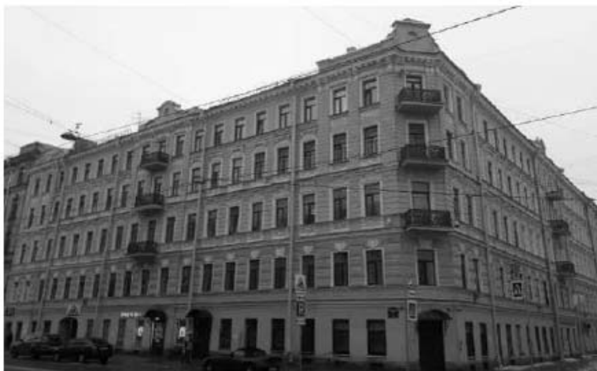
49. Дом, где жили: в декабре 1905 г. - Ленин В.И. и Крупская Н.К., в 1919-1936 гг. - писатель Тынянов Ю.Н. Греческий проспект, дом 15, литера А. Лицевой фасад. Штиглиц М.С. 10.01.2022.
