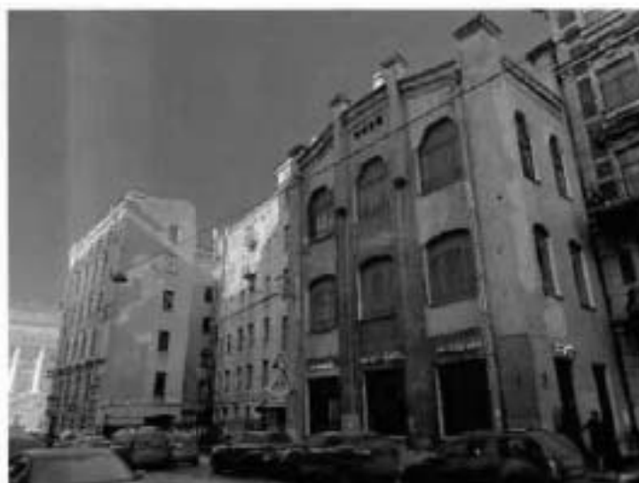
2. Общий вид на объект культурного наследия.
