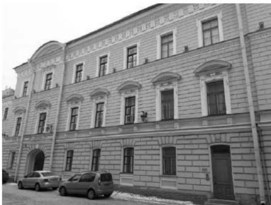
39. Главное здание (концертный зал с учебными флигелями) (в составе «Капелла Придворная певческая»). Набережная реки Мойки, дом 20, литера А. Лицевой фасад. Фото мест установки оборудования и кабельных трасс. Штиглиц М.С. 10.01.2022.
