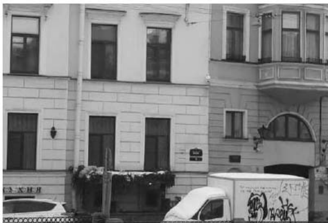
37. Особняк (в составе «Особняк и дом Жадимировских (Н.Е. Демидовой)»). Набережная реки Мойки, дом 16, литера А. Лицевой фасад. Фото мест установки оборудования и кабельных трасс. Штиглиц М.С. 10.01.2022.
