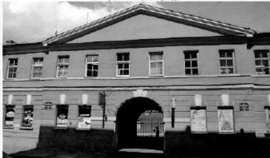
30. Фрагмент лицевого фасада.
