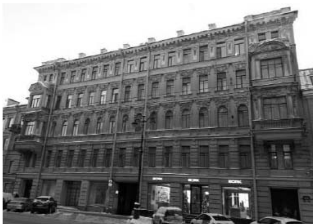
3. Дом Д.И. Тырлова. Невский пр., д. 119, литера А. Лицевой фасад. Фото мест установки оборудования и кабельных трасс. Штиглиц М.С. 10.01.2022.
