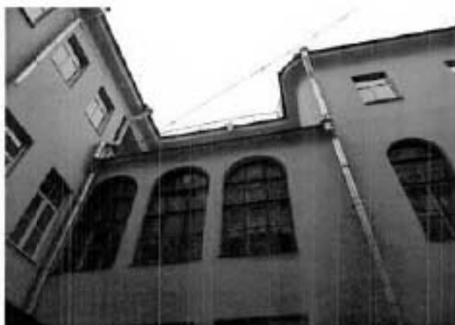
3. Фасады дворовых флигелей.
