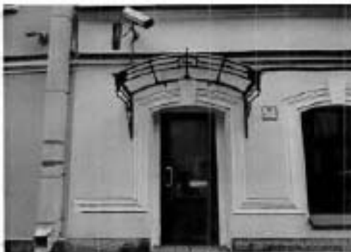
6. Вход. Вид с улицы Шпалерная.
