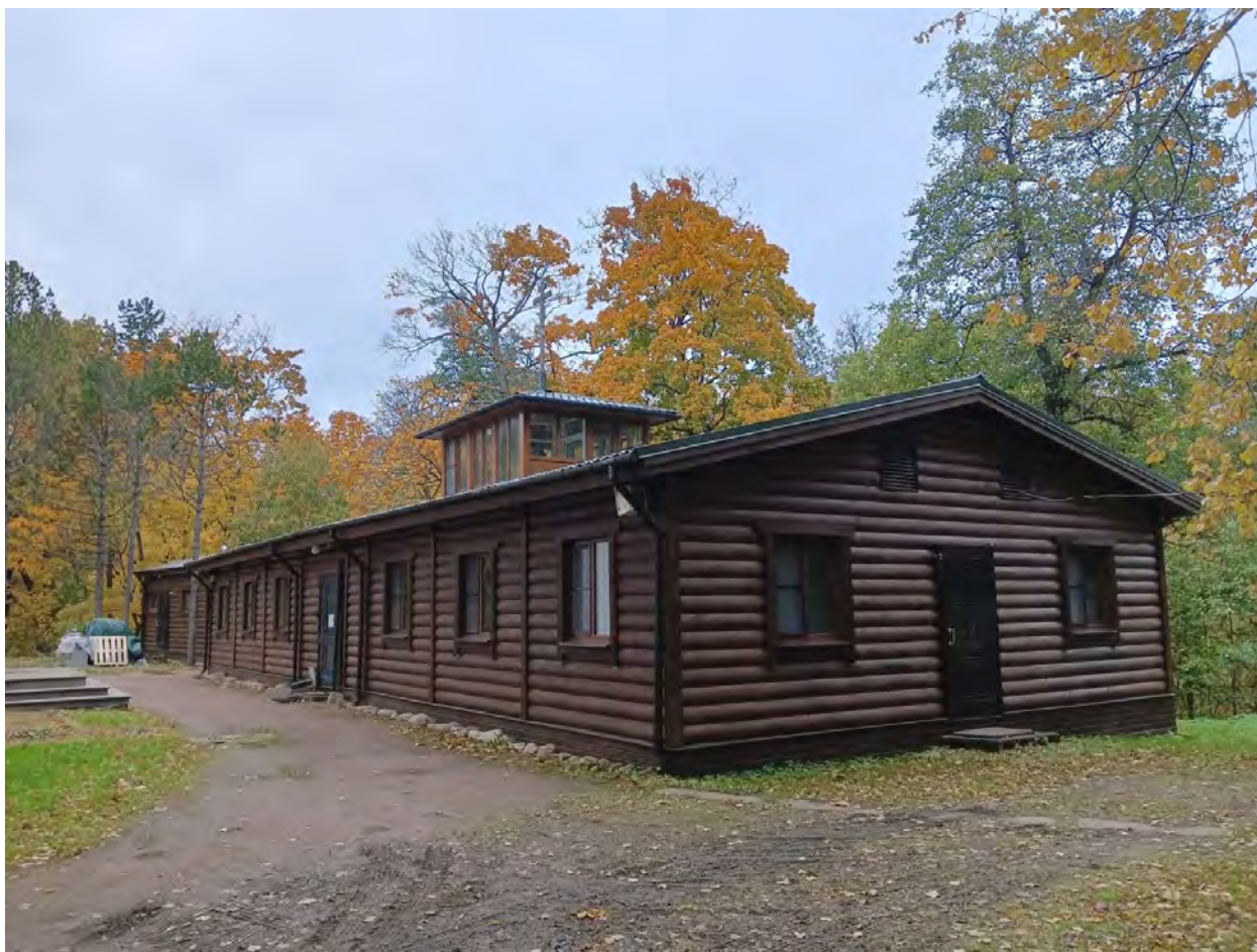
Фото 5. Объект культурного наследия федерального значения "Дворцово-парковый ансамбль Знаменской дачи (Знаменка)", расположенный по адресу: г.Санкт-Петербург, город Петергоф, Санкт-Петербургское шоссе, дом 115. Вспомогательное временное сооружение трапезной Церкви Святых Апостолов Петра и Павла.
