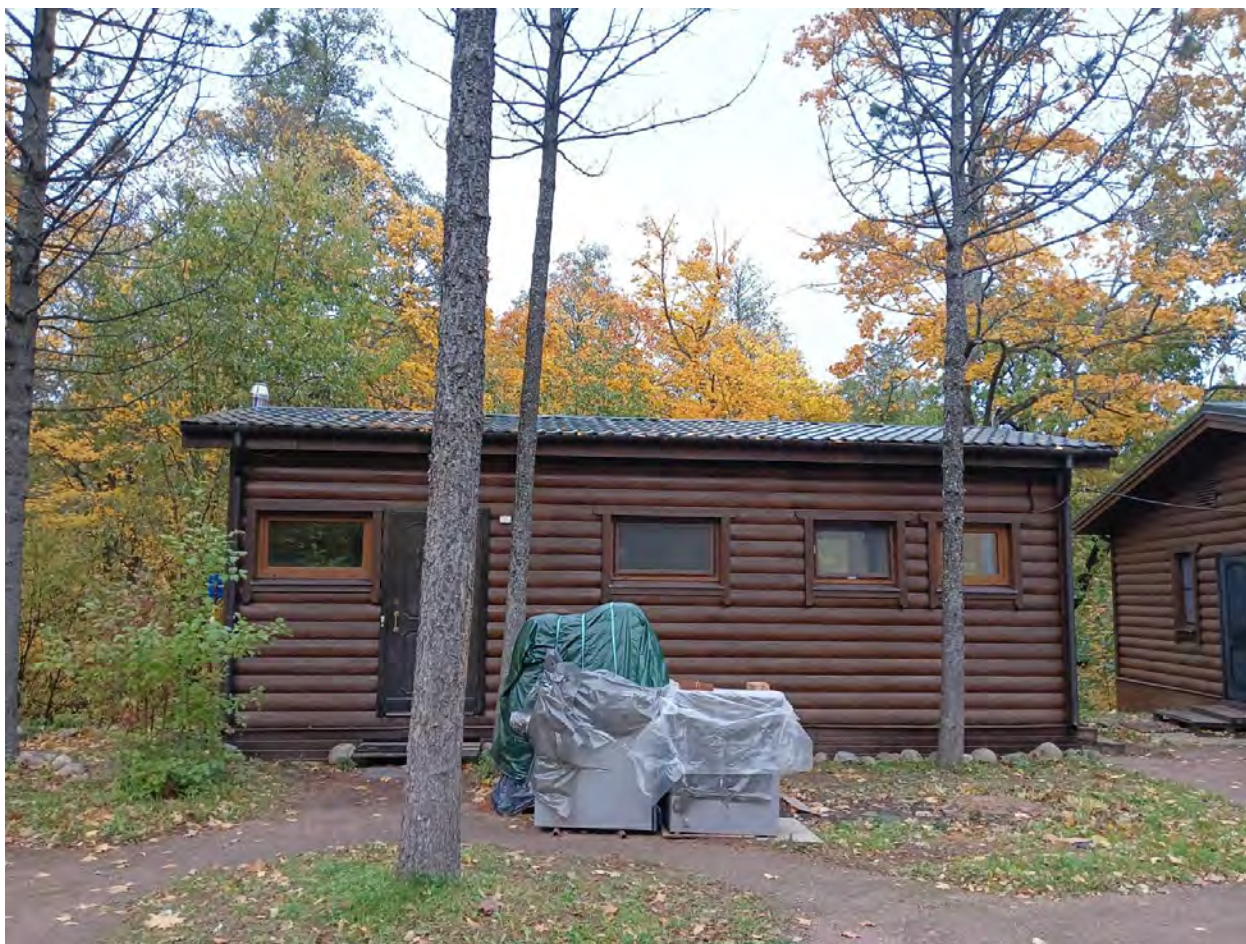
Фото 6. Объект культурного наследия федерального значения "Дворцово-парковый ансамбль Знаменской дачи (Знаменка)", расположенный по адресу: г.Санкт-Петербург, город Петергоф, Санкт-Петербургское шоссе, дом 115. Вспомогательное временное сооружение котельной Церкви Святых Апостолов Петра и Павла.
