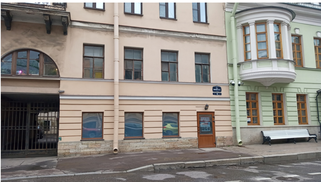
Фото 2. Выявленный объект культурного наследия «Дом И. М. Барышева». Общий вид правой части лицевого фасада в границах помещения 3-Н с 8-ой линии В. О.
