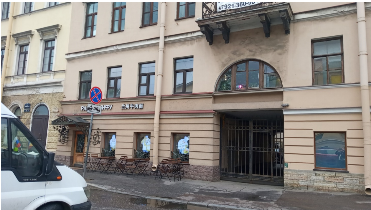
Фото 1. Выявленный объект культурного наследия «Дом И. М. Барышева». Общий вид левой части лицевого фасада в границах помещения 1-Н с 8-ой линии В. О.
