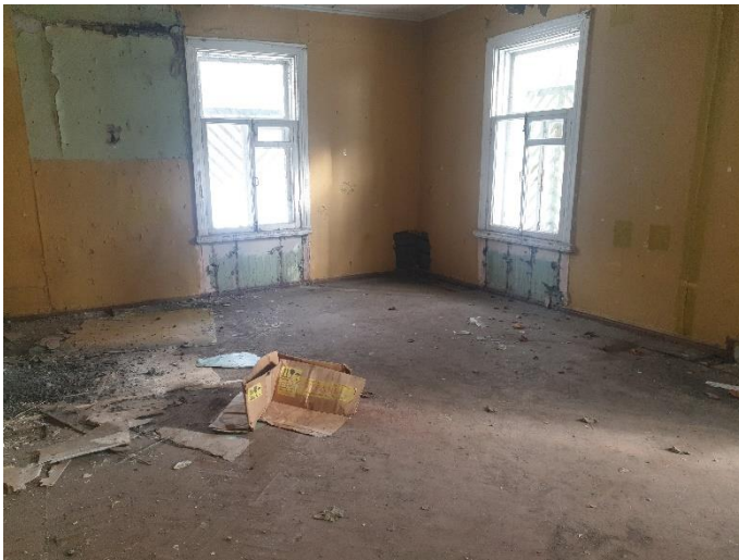
18. «Финская усадьба Заеца», Санкт-Петербург, город Зеленогорск, Приморское шоссе, дом 597, литера К. Помещение первого этажа. Общий вид. Фото 27.02.2023г.
