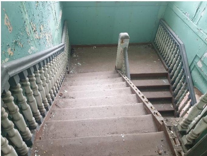
23. «Финская усадьба Заеца», Санкт-Петербург, город Зеленогорск, Приморское шоссе, дом 597, литера К. Помещение второго этажа. Общий вид. Фото 27.02.2023г.
