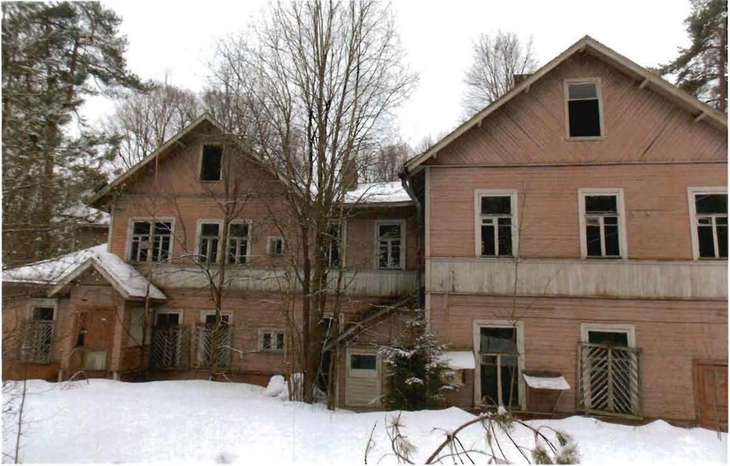
2. Северный фасад здания.
