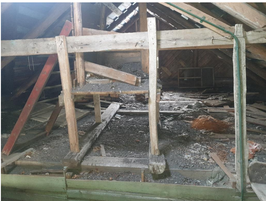
31. «Финская усадьба Заеца», Санкт-Петербург, город Зеленогорск, Приморское шоссе, дом 597, литера К. Чердак. Общий вид. Фото 27.02.2023г.
