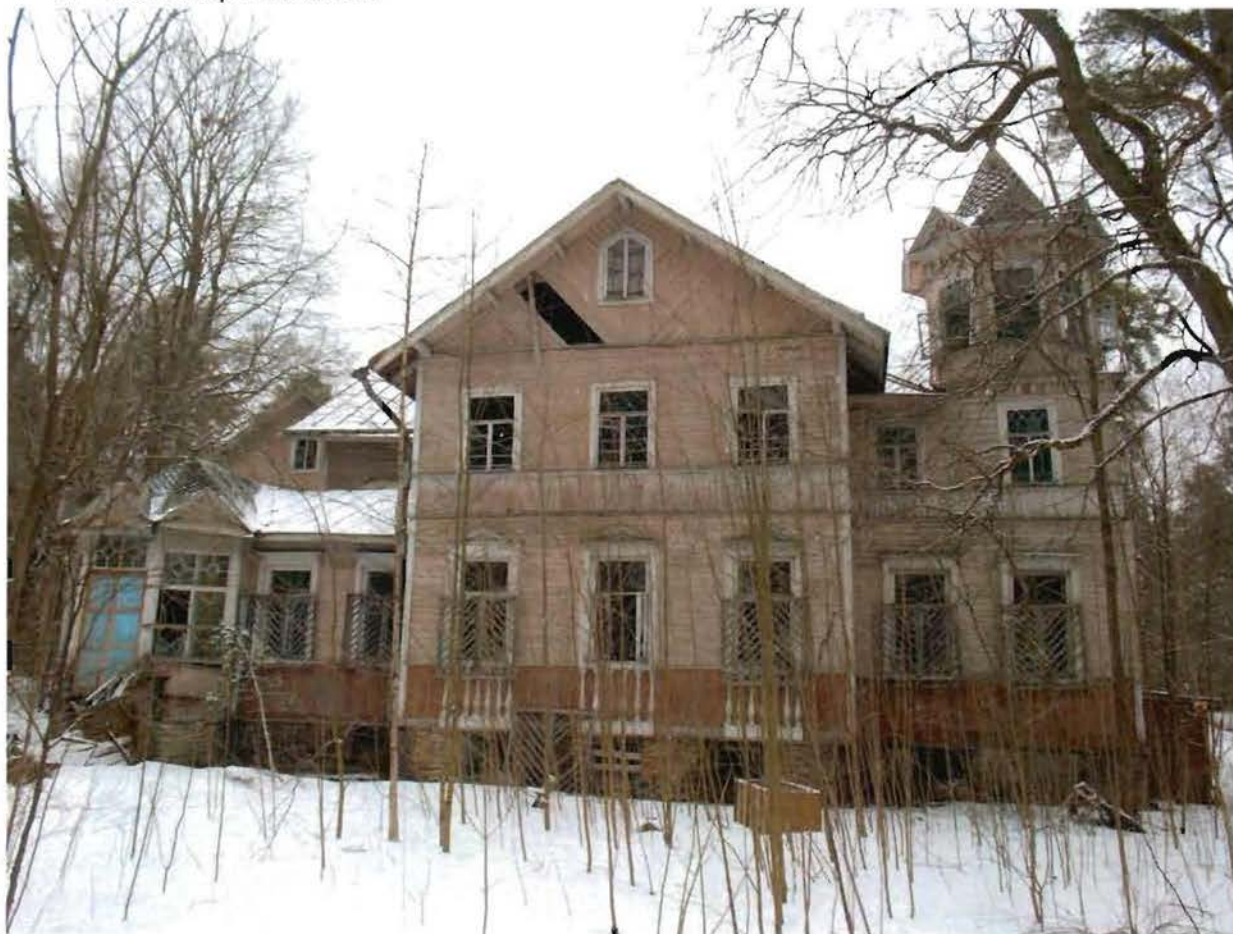
1. Южный фасад здания.
