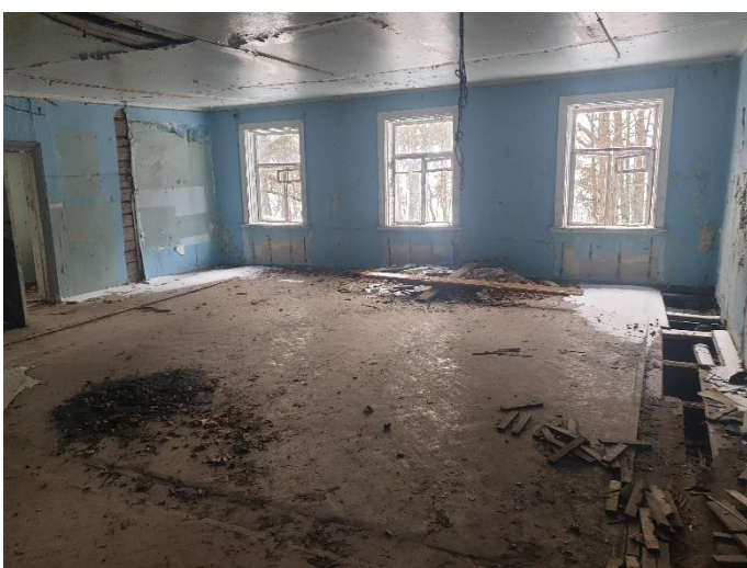
28. «Финская усадьба Заеца», Санкт-Петербург, город Зеленогорск, Приморское шоссе, дом 597, литера К. Помещение второго этажа. Общий вид. Фото 27.02.2023г.
