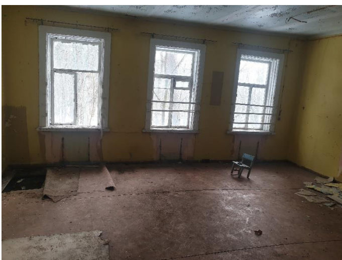
27. «Финская усадьба Заеца», Санкт-Петербург, город Зеленогорск, Приморское шоссе, дом 597, литера К. Помещение второго этажа. Общий вид. Фото 27.02.2023г.
