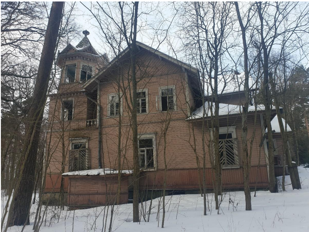
2. «Финская усадьба Заеца», Санкт-Петербург, город Зеленогорск, Приморское шоссе, дом 597, литера К. Восточный фасад. Общий вид. Фото 27.02.2023г.
