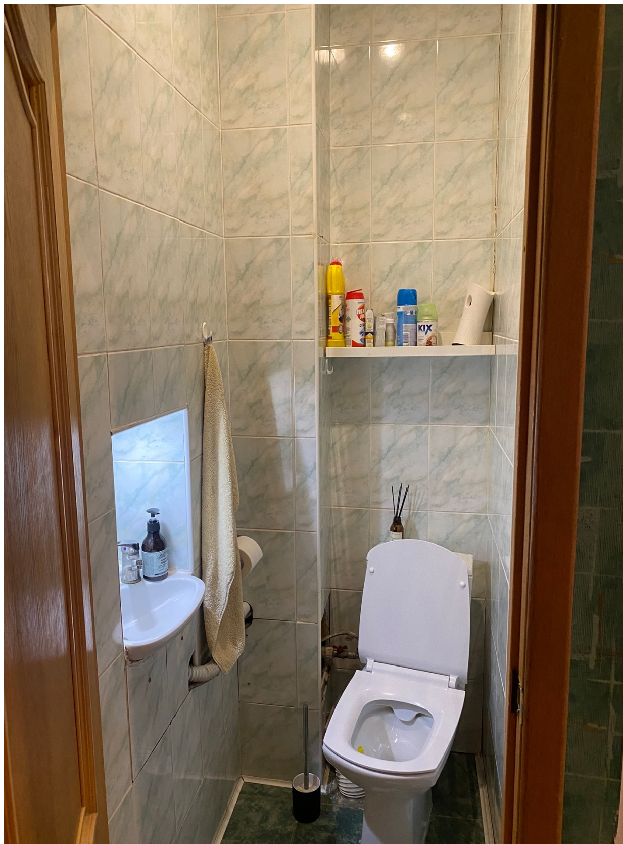
9. Фрагмент интеръера санузла (помещение 2);
