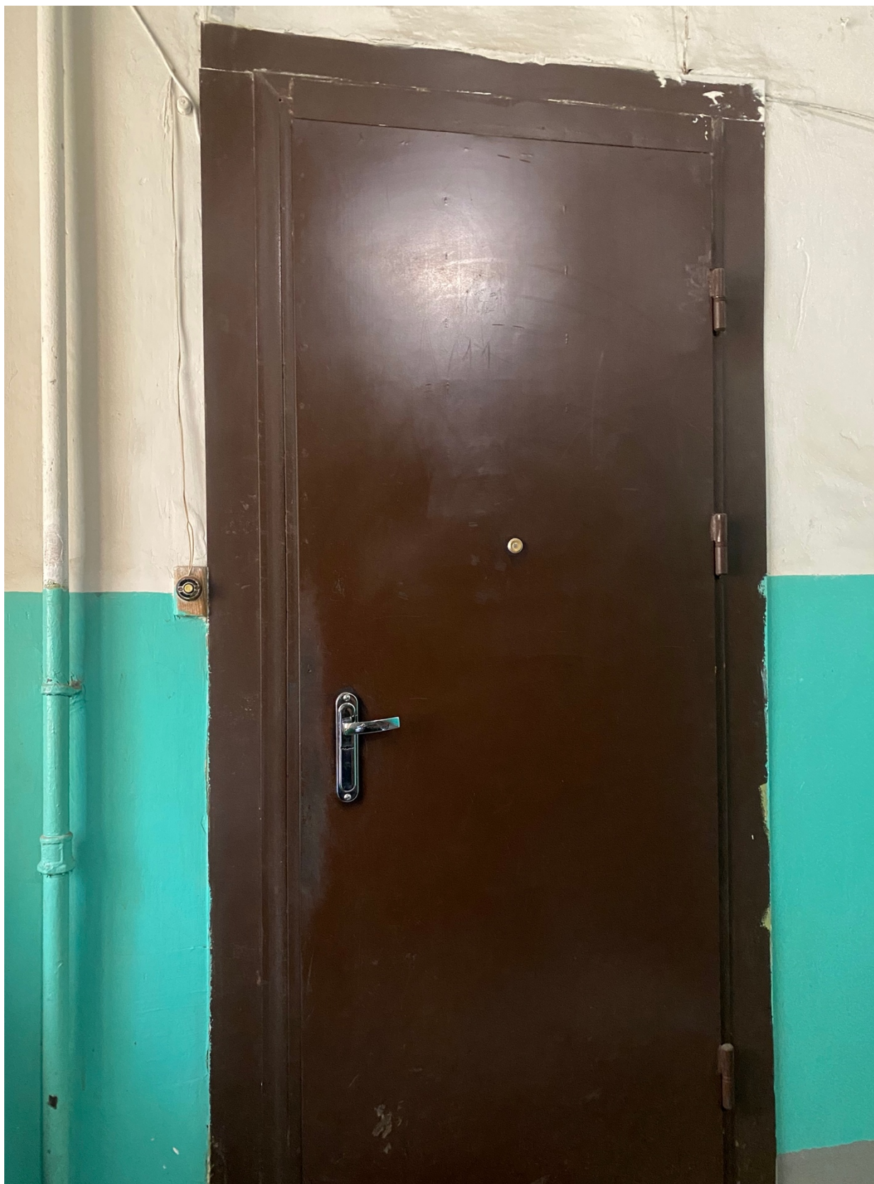
2. Вид на входную дверь в квартиру;
