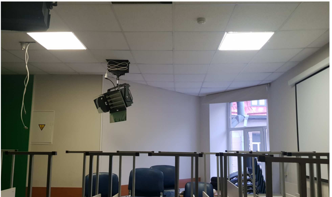
5. 6-й этаж. Помещение северного крыла.
