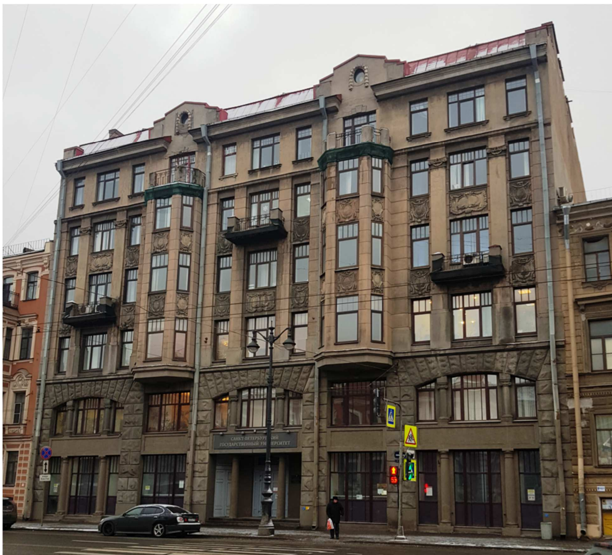
1. Общий вид лицевого фасада по 1-й линии ВО.
