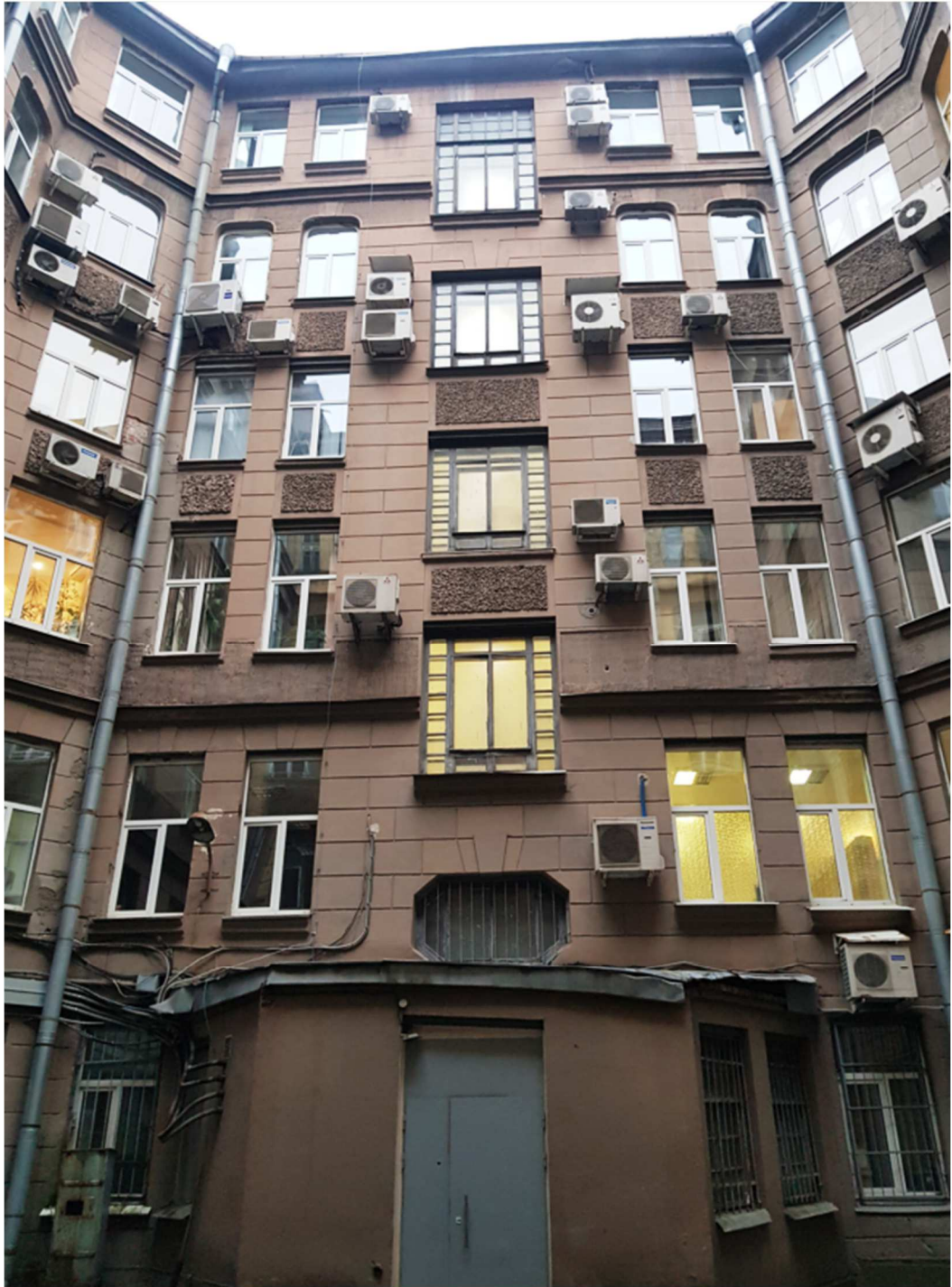
2. Вид дворового фасада.
