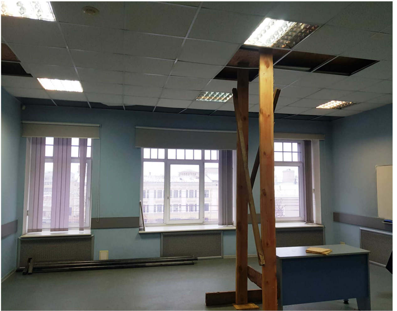
10. 6-й этаж. Аудитория в южном крыле.
