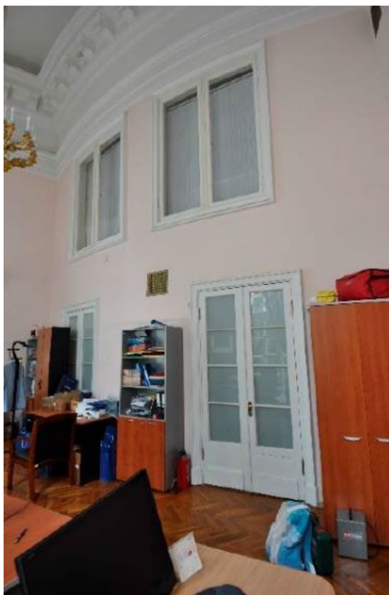
21. Помещение № 541 в уровне 2-го этажа объекта культурного наследия федерального значения «Дворец Таврический. Дворец», расположенного по адресу: г. Санкт-Петербург, ул. Шпалерная, д. 47, лит. А. 01.11.2023
