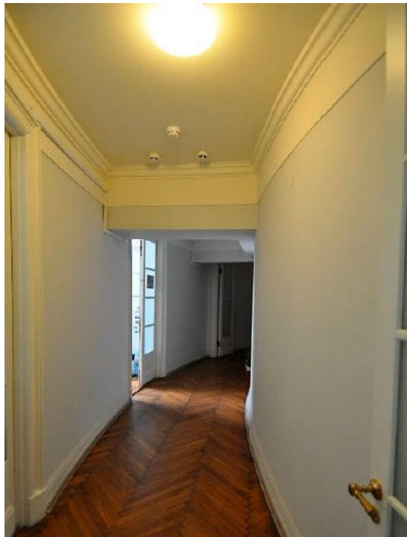
1. Помещение № 537 в уровне 2-го этажа объекта культурного наследия федерального значения «Дворец Таврический. Дворец», расположенного по адресу: г. Санкт-Петербург, ул. Шпалерная, д. 47, лит. А. 01.11.2023
