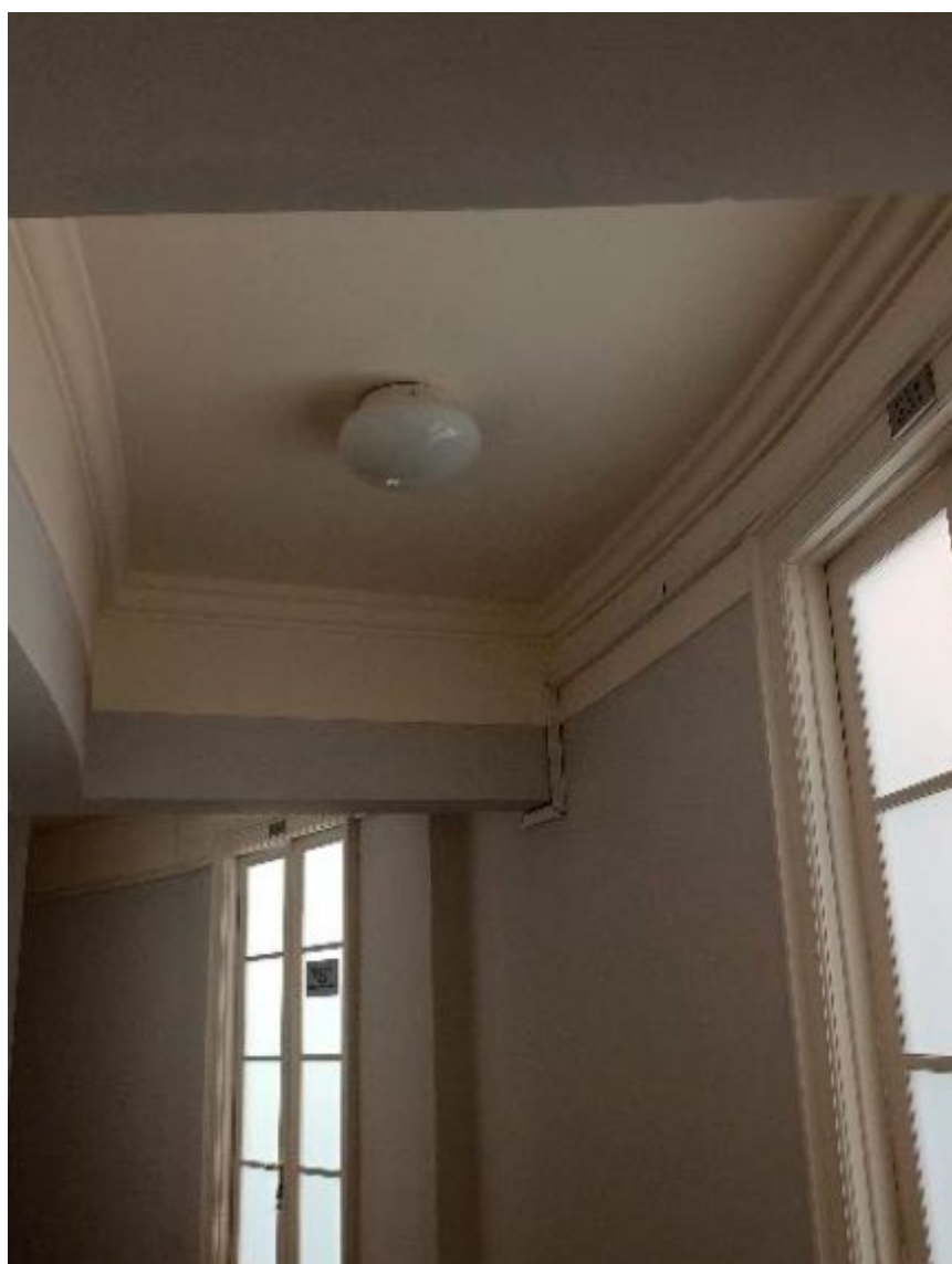
13. Помещение № 9 в уровне 2-го этажа объекта культурного наследия федерального значения «Дворец Таврический. Дворец», расположенного по адресу: г. Санкт-Петербург, ул. Шпалерная, д. 47, лит. А. 01.11.2023
