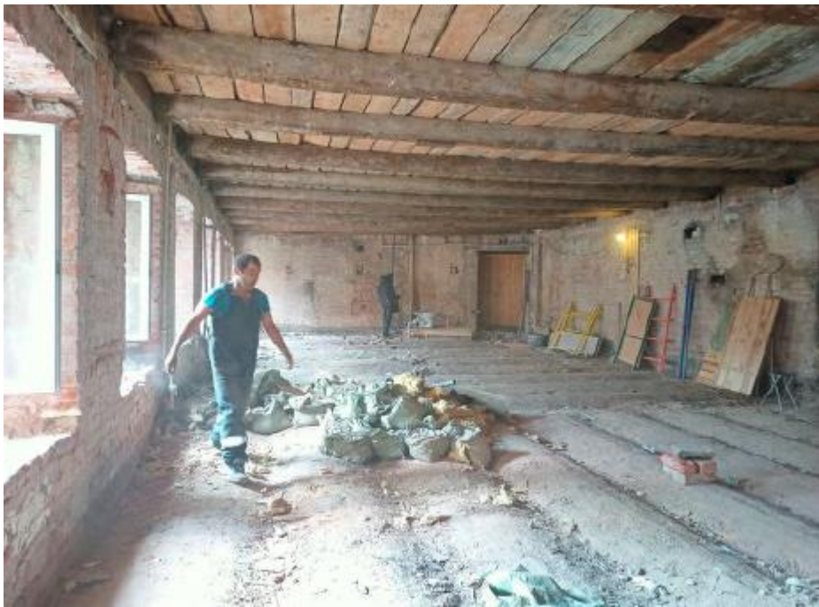
5. Помещения №1-5 кв. №48-49 объекта культурного наследия регионального значения «Дом по 2-ой Советской ул. с дворовым флигелем», расположенного по адресу: г. Санкт-Петербург, 2-ая Советская ул., 27/2, литера А. 04.05.2022
