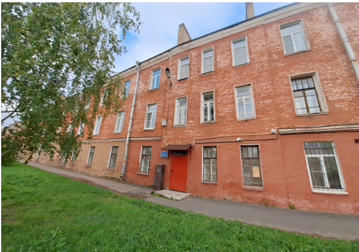
1. Общий вид восточного фасада.
