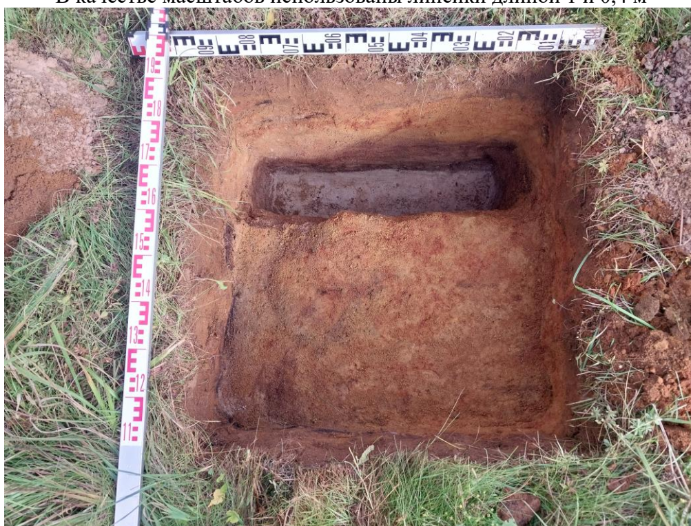
Рис. 13. г. Санкт-Петербург, Приморский район Участок обследования с кадастровым номером 78:34:0004281:74520 Шурф 1. Общий вид после проведения земляных работ Вид сверху с юга
