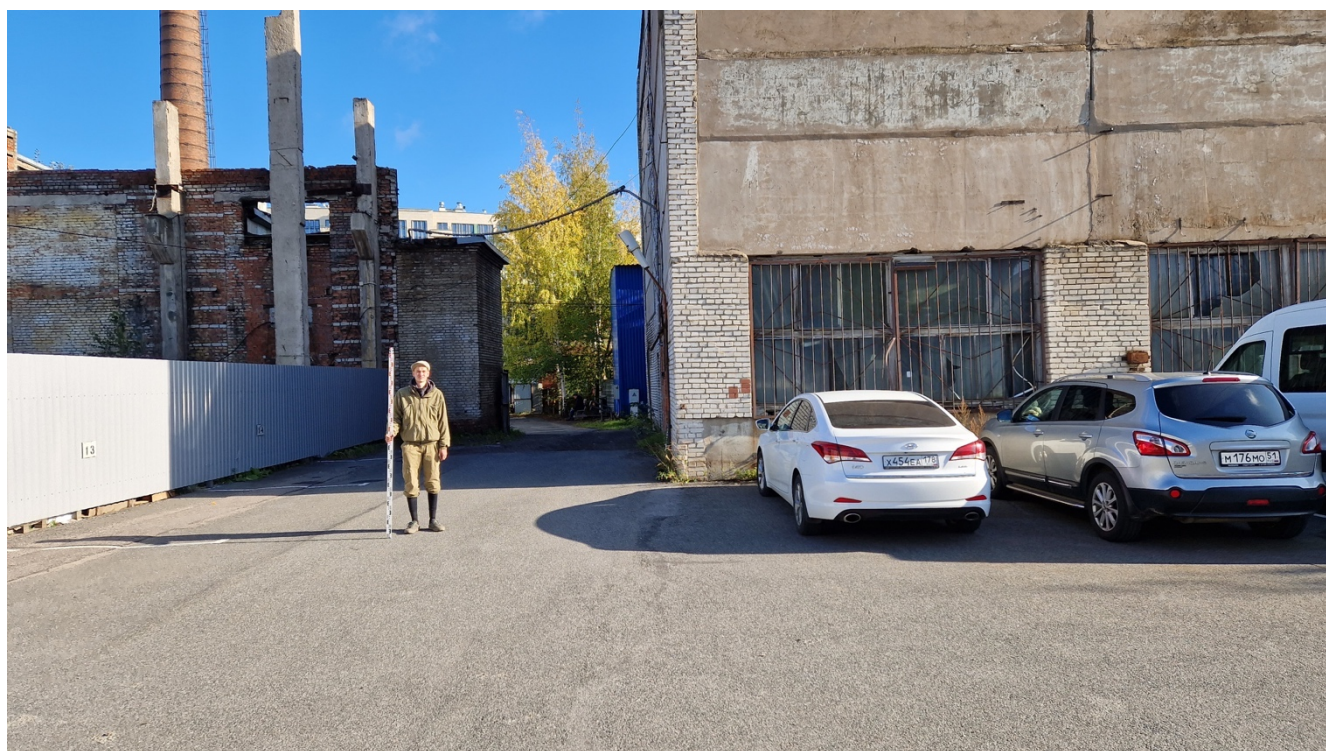
Рис.21. Санкт-Петербург, Адмиралтейский район, набережная Обводного канала, дом 118а. Точка съёмки №2. Вид на восток.
