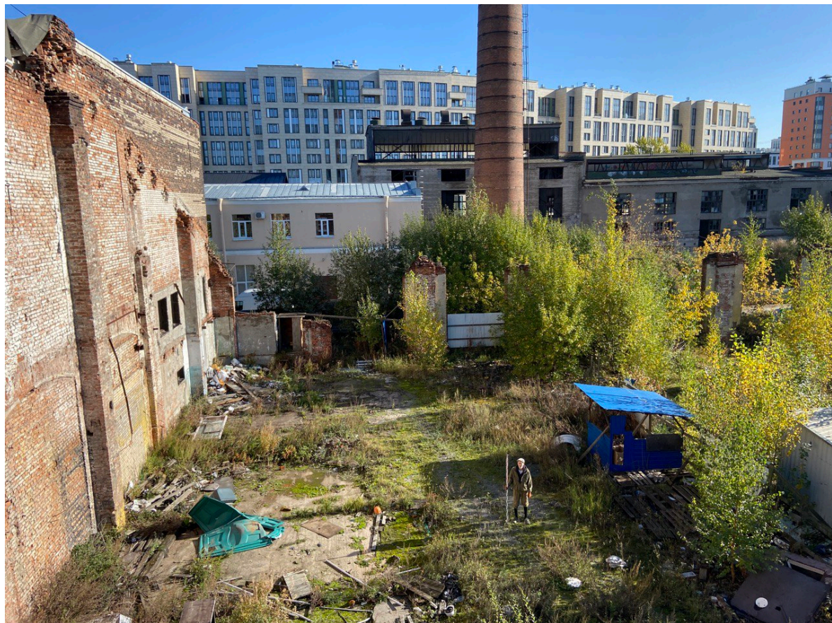
Рис.18. Санкт-Петербург, Адмиралтейский район, набережная Обводного канала, дом 118а. Точка съёмки №1. Вид на восток.
