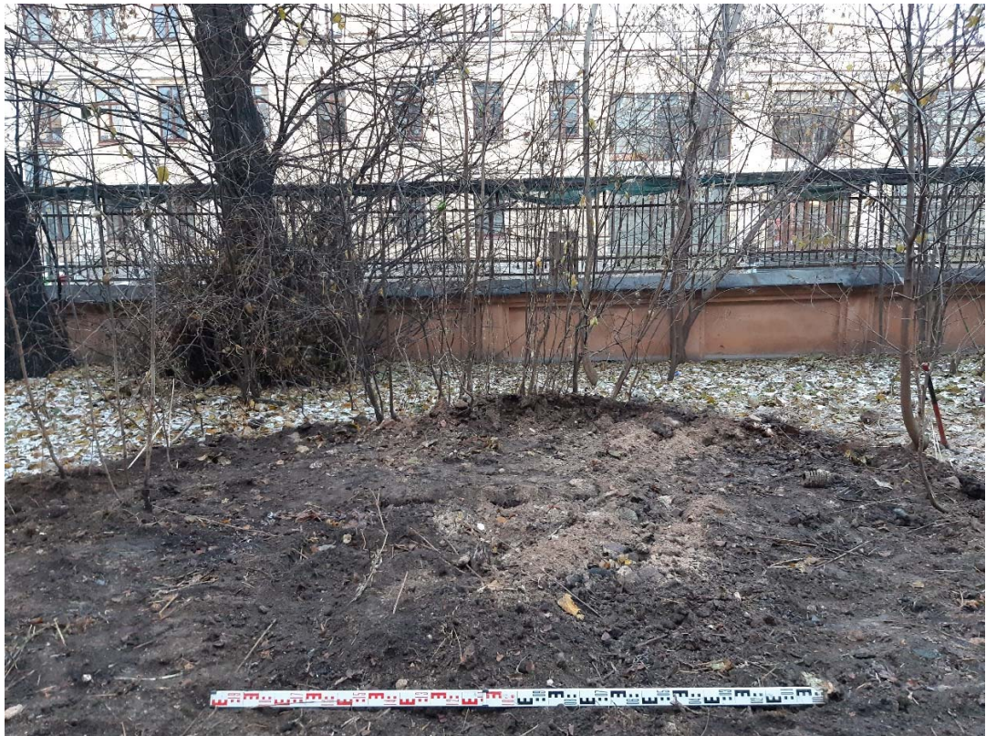
Рис. 65. Санкт-Петербург, Виленский пер. д. 19, Лит. А. Шурф 1. Фотофиксация после рекультивации. Вид на север.
