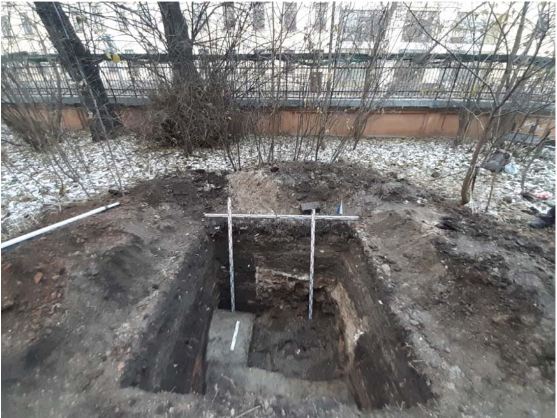
Рис. 64. Санкт-Петербург, Виленский пер. д. 19, Лит. А. Шурф 1. Общий вид шурфа, уровень остановки работ. Вид на север.
