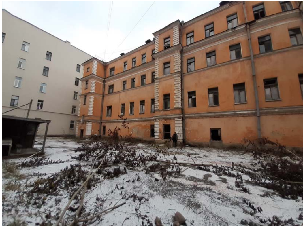
Рис. 34. Санкт-Петербург, Виленский пер. д. 19, лит. А. Общий вид участка. Точка съёмки 8. Вид на северо-запад.
