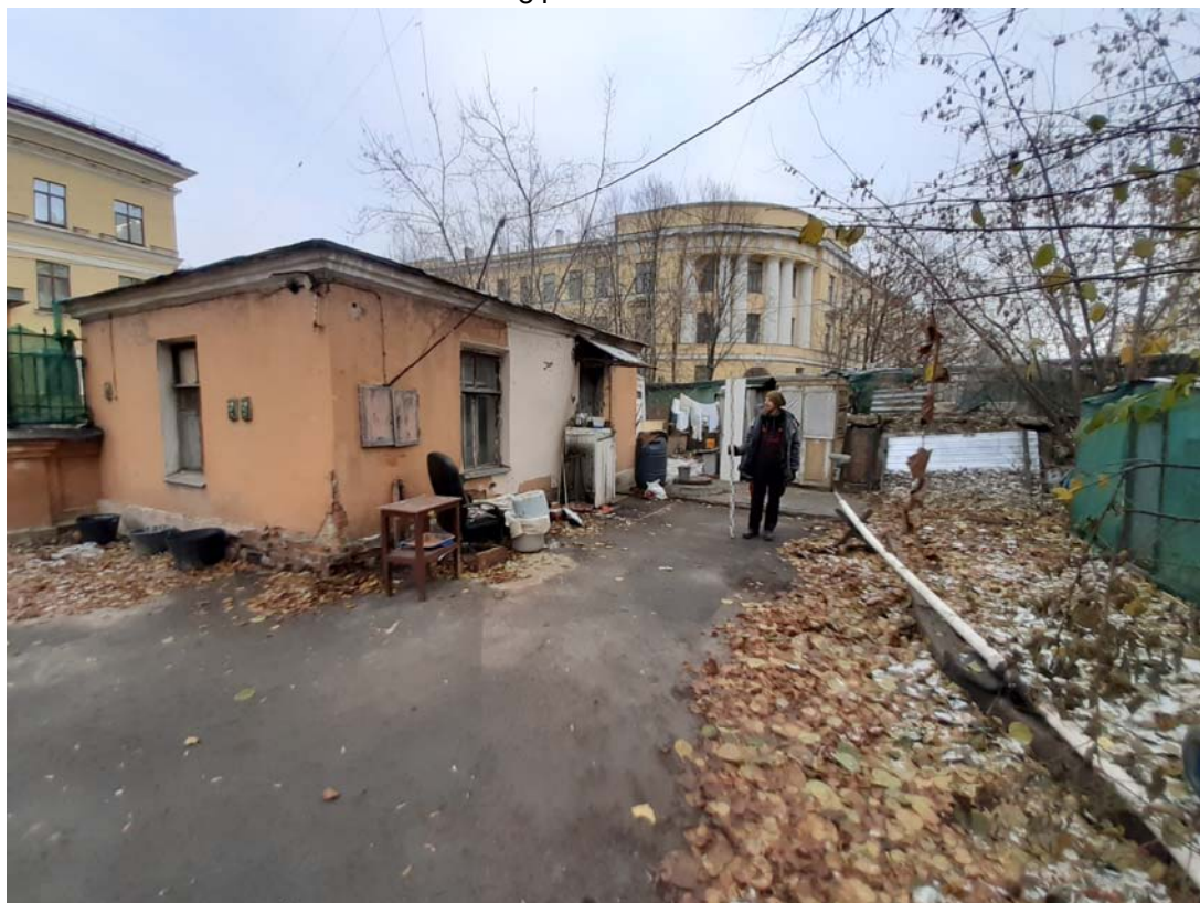
Рис. 25. Санкт-Петербург, Виленский пер. д. 19, Лит. А. Общий вид участка. Точка съемки 3. Вид на северо-восток.
