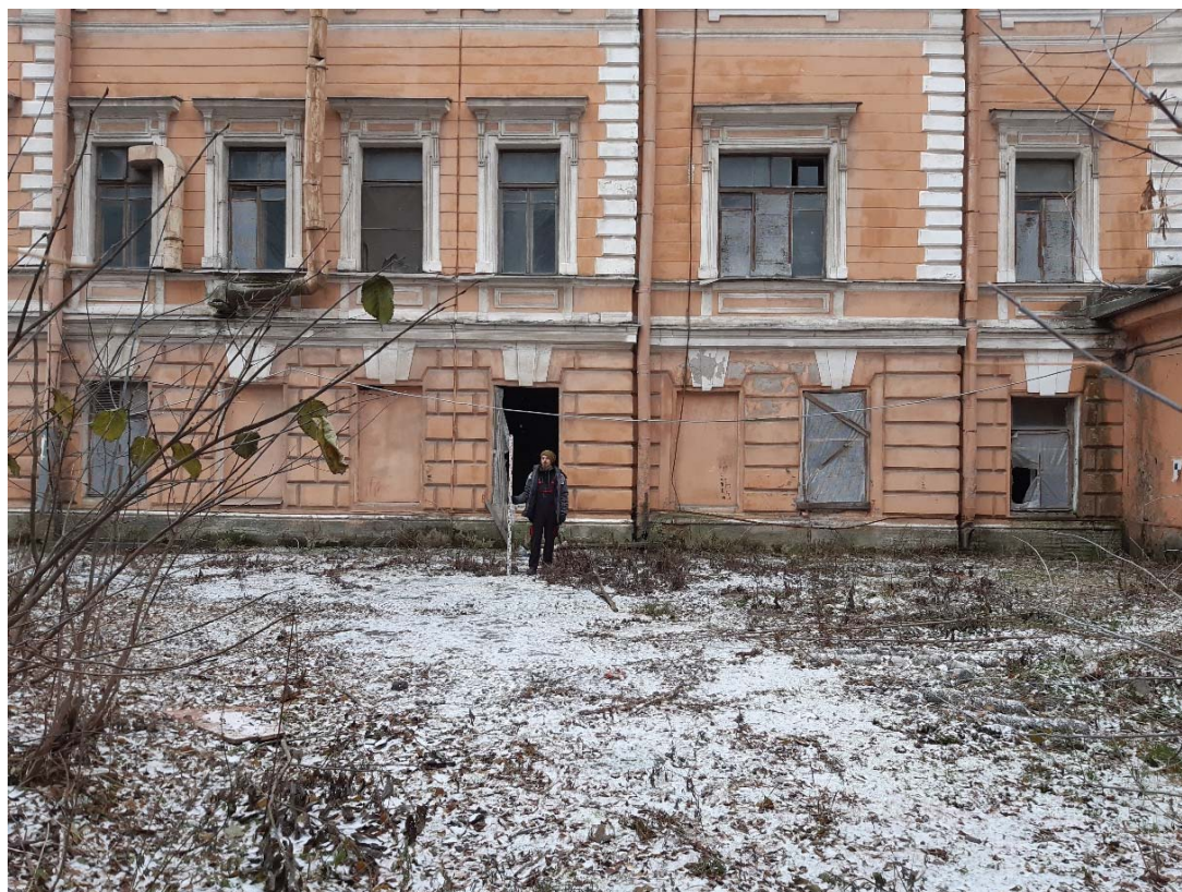
Рис. 20. Санкт-Петербург, Виленский пер. д. 19, Лит. А. Общий вид участка. Точка съемки.1. Вид на юг.
