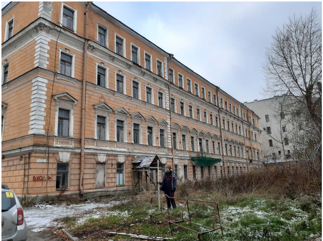
Рис. 24. Санкт-Петербург, Виленский пер. д. 19, Лит. А. Общий вид участка. Точка съемки 3. Вид на северо-восток.
