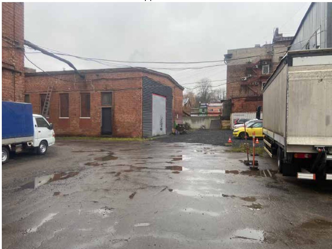
Рис. 16. Санкт-Петербург, Василеостровский р-н, Наб. реки Смоленки 5-7. Точка фотофиксации местности №2. Вид на запад.
