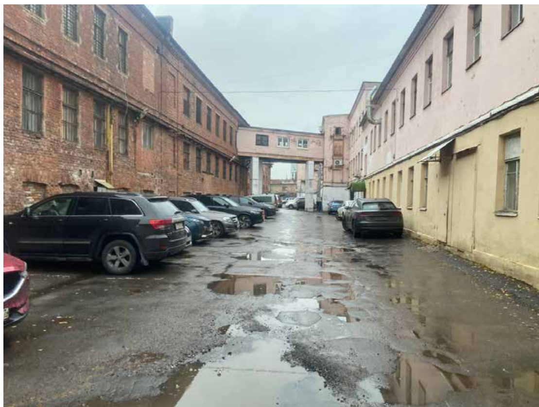
Рис. 19. Санкт-Петербург, Василеостровский р-н, Наб. реки Смоленки 5-7. Точка фотофиксации местности №3. Вид на север.
